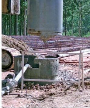
Pilotes in situ con lodos bentoníticos (CPI-6).
