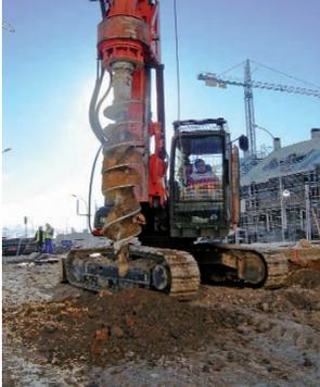
Pilotes in situ con rotación en seco (CPI-7).
