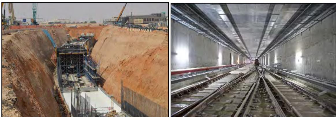
*Figura 10. Tramo de túnel excavado a cielo abierto y con cajón en la Línea 4.*
