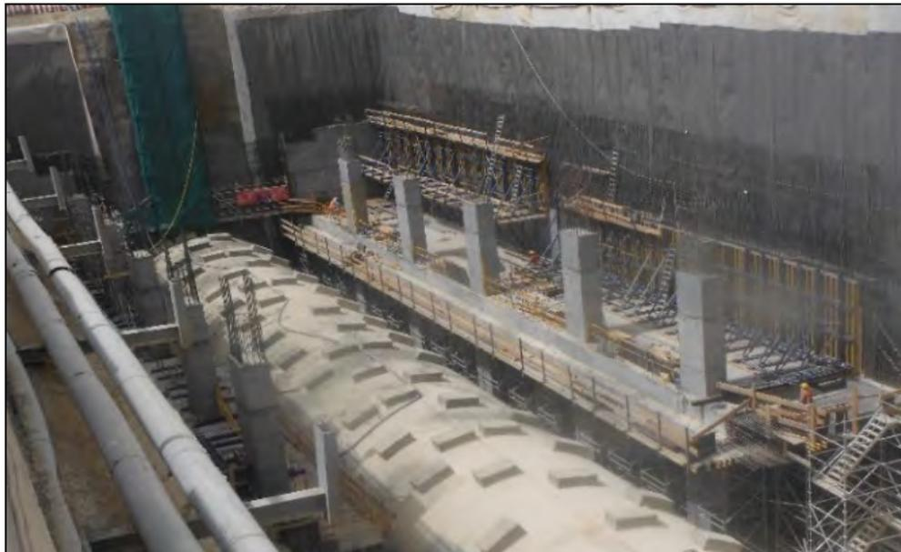
*Figura 54. Con el túnel en el eje de la estación, se ejecuta los dos laterales de la contrabóveda y se levantan los muros, los pilares y forjados de las dos franjas exteriores..*
