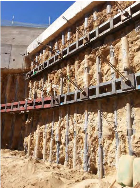
Fotografía 20. Detalle Pantalla anclada micropilotes.
