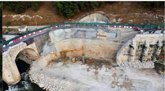
**Figura 1.9. Rotura de muros de contención. Solución empleo de varias técnicas conjuntas, soil nailing provisional, micropilotes y anclajes.**
