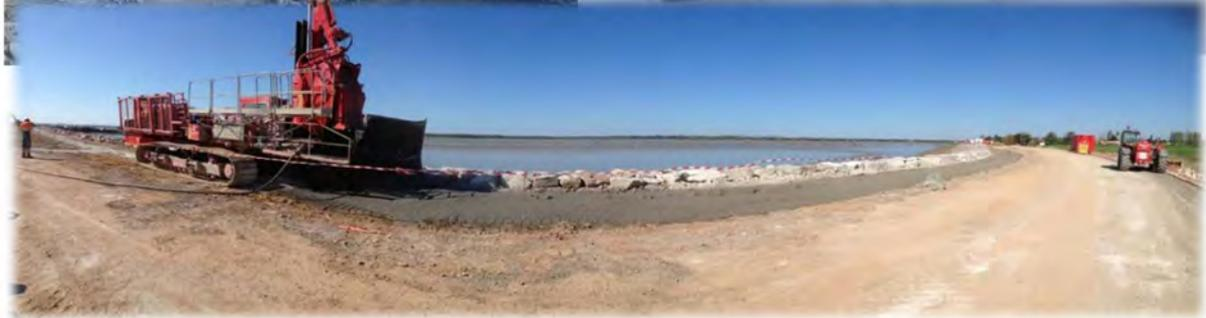
Trenchmix®: Técnica para la creación de pantallas de soil-mixing mediante un equipo de “corte mecánico y mezcla suelo-cemento.”
