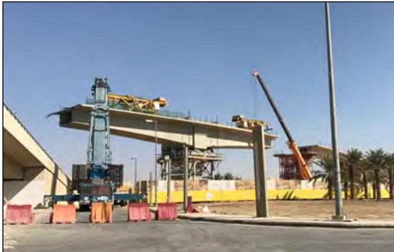
*Figura 9. Tramo de viaducto en curva y luces elevadas ejecutado con el Método de Dovelas Prefabricadas en Voladizo, Línea 4.*
