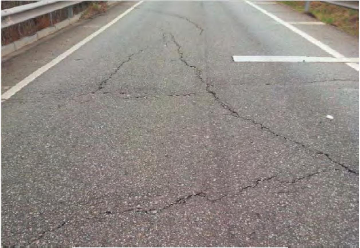
Fotografía nº 1. Grietas en la calzada sobre la vertical de la O.D
