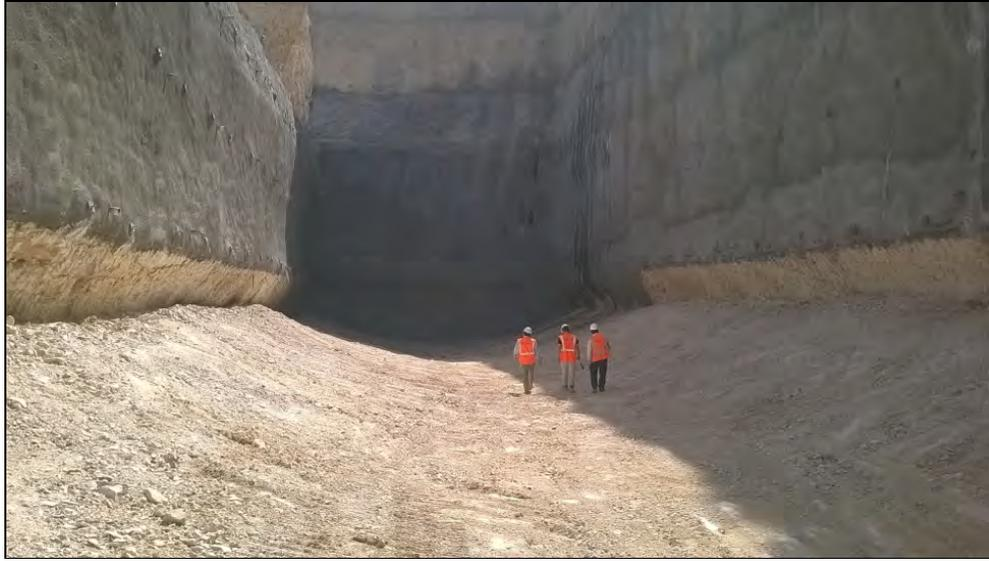
*Figura 29. Fondo de excavación preparado para ejecutar la contrabóveda en el pozo de ataque norte.*
