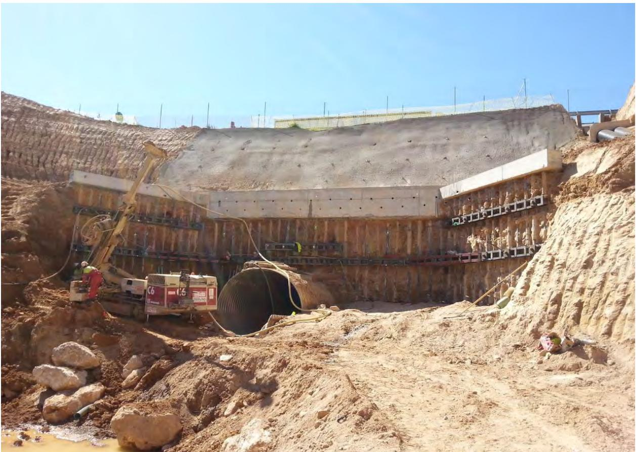
Fotografía 18. Ejecución pantalla anclada de micropilotes.
