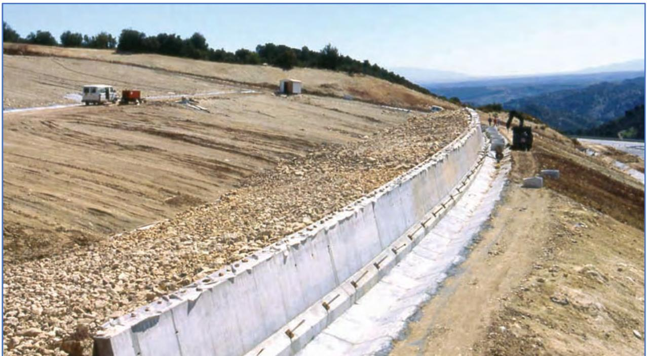
Figura 22. Muro-viga de coronación (Fuente: Memoria de Gestión 2000-2004, Consejería de OO.PP. y Transportes de la Junta de Andalucía)
