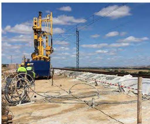
**Figura 2.13. Inyección simultanea de varios taladros**
