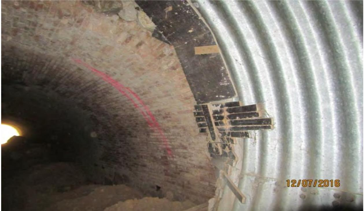
Fotografía nº 6. Tapes en cambio de tipología para evitar la pérdida de material de trasdós
