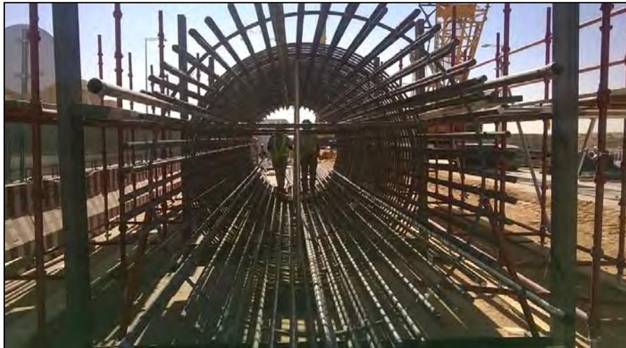
Figura 39. Disposición de la armadura de un pilote de 2500 mm de diámetro.
