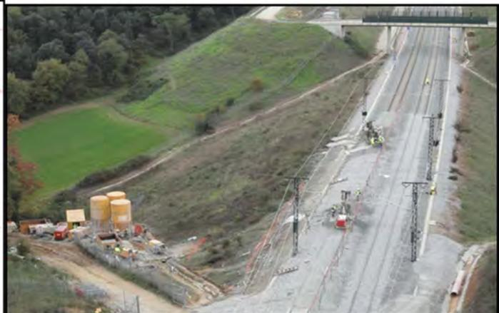
**Figura 1.8. Asientos en el terraplén: solución inyecciones de compactación.**
