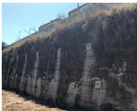
**Figura 4.11. Refuerzo de bulones en el muro**
