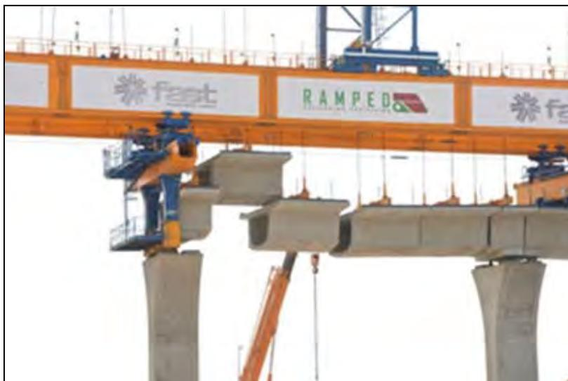
*Figura 8. Tramo de viaducto ejecutado con el Método de Dovelas con Pórtico.*
