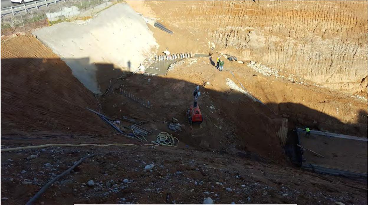
Fotografía 17. Vista lateral durante la perforación de la pantalla.
