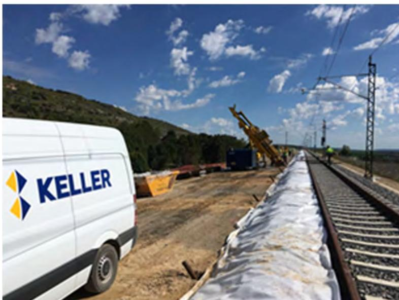
**Figura 2.5. Inyecciones armadas ya ejecutadas en la obra.**
