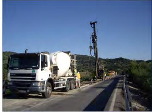
**Figura 1.7. Asientos en terraplén. Solución, columnas de grava.**
