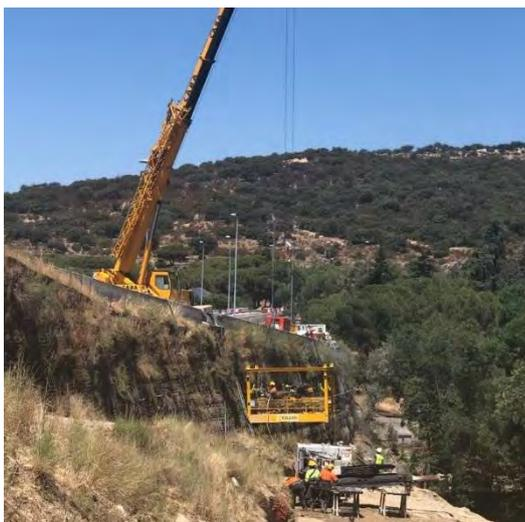
**Figura 4.10. Trabajos en cesta y en plataforma simultáneamente**
