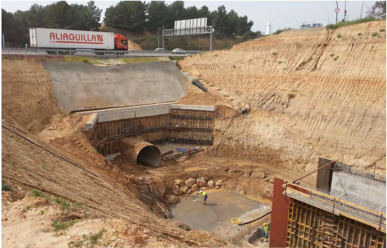
Fotografía 19. Ejecución pantalla anclada de micropilotes.
