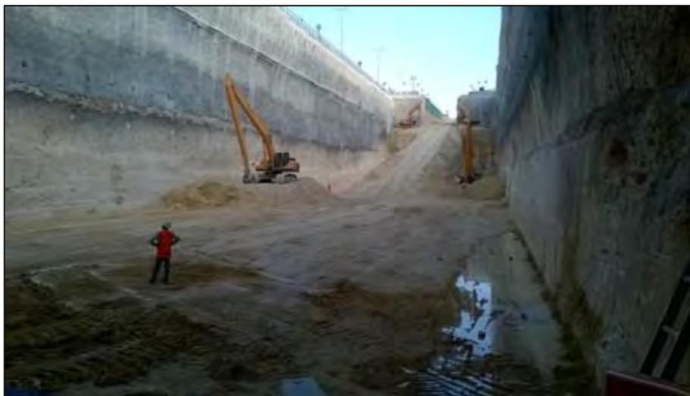
Figura 27. Excavación con taludes verticales en la estación 5B4 de la Línea 5.
