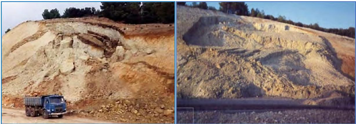
Figura 3. A-92, deslizamiento talud norte en fase de construcción (Fuente: Ref. 8 [izq.], Ref. 12 [dch.])
