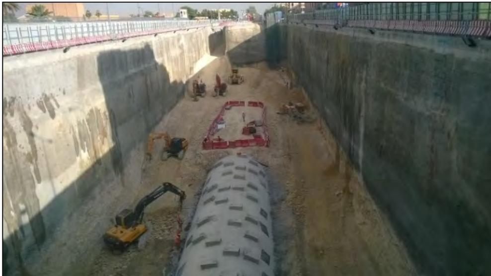
Figura 52. Excavación alrededor del túnel, dejando al descubierto la parte superior del anillo y se van ejecutando los refuerzos de las juntas del tercio superior de la sección con vigas de hormigón.
