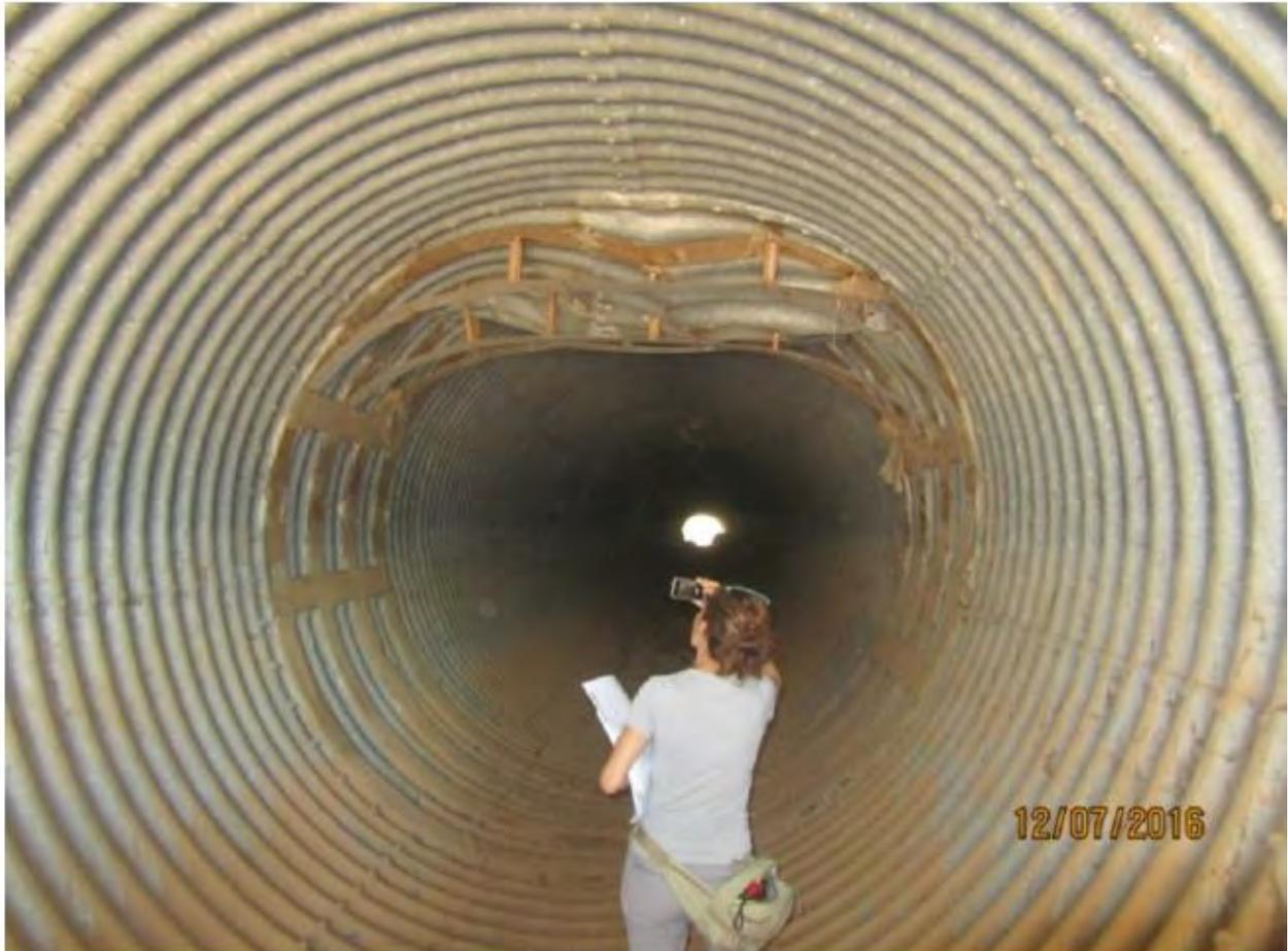
Fotografía nº 4. Zona de abolladura den clave/hombro izquierdo (fotografía hacia aguas arriba)
