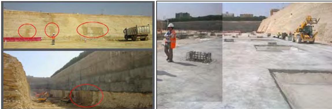
Figura 32. Excavación en el Depot de Línea 5 en septiembre de 2014 con presencia de niveles de agua colgados (izquierda), y preparación de la superficie con hormigón de limpieza para ejecutar las zapatas de los pilares y la losa de la nave en diciembre de 2015 (derecha).
