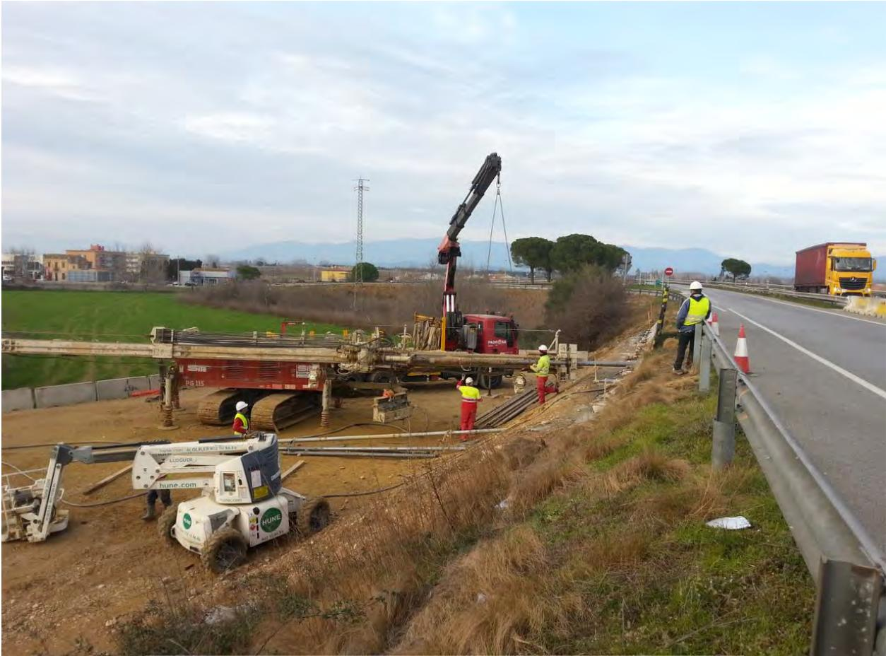
Fotografía 13. Perforaciones para parguas IRS en C260 en Figueres. (1)
