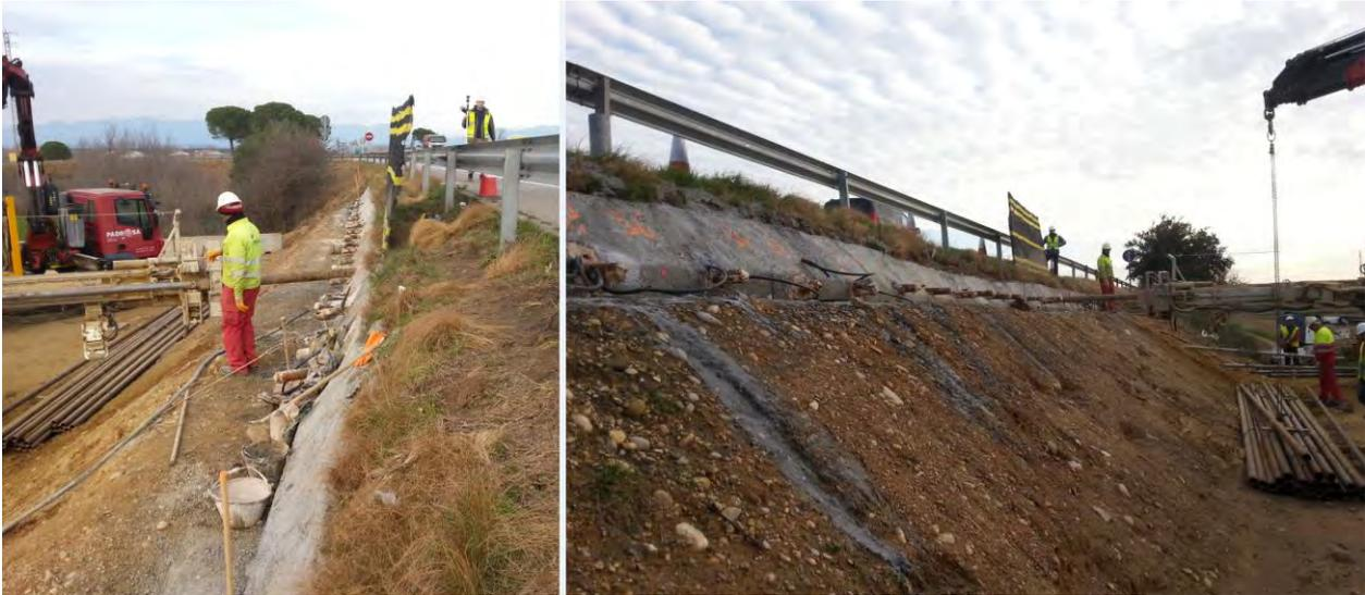
Fotografía 14. Perforaciones para parguas IRS en C260 en Figueres. (2)
