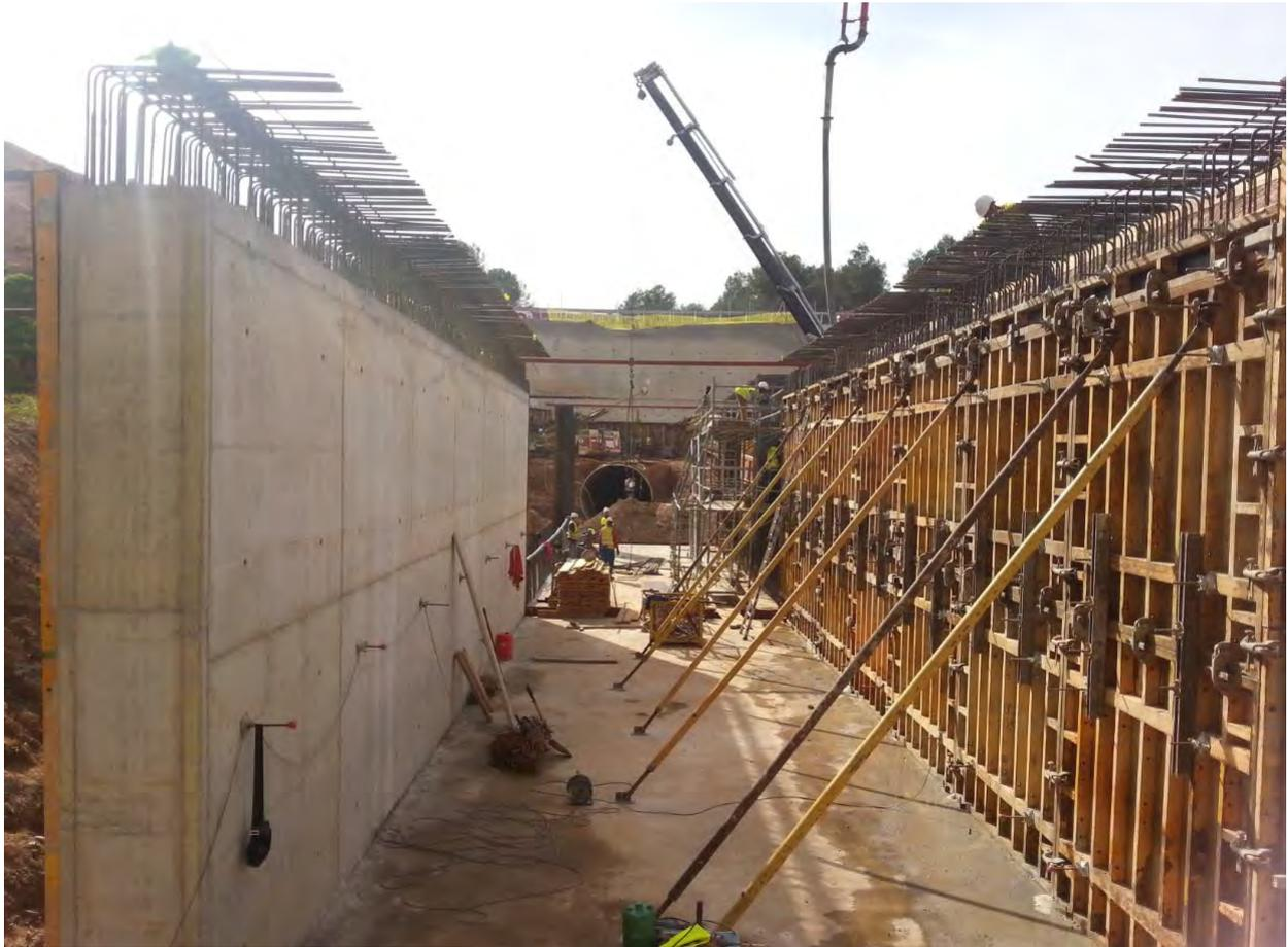
Fotografía 21. Construcción del cajón.
