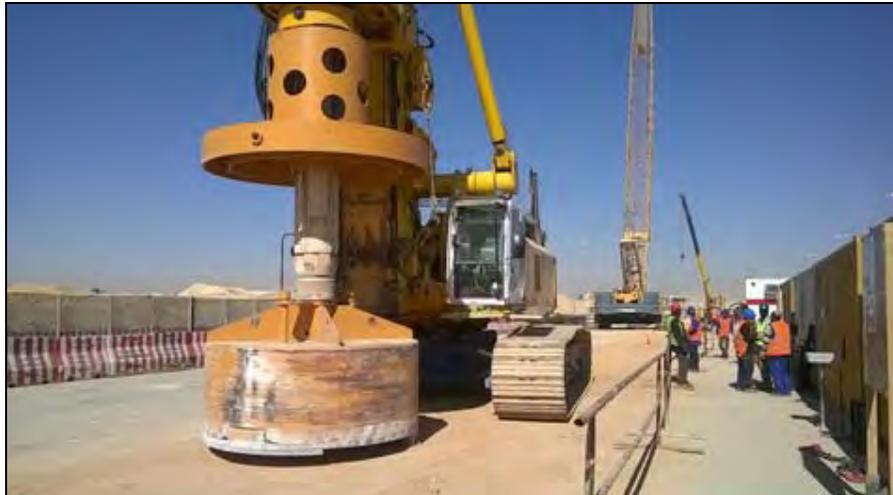
Figura 38. Útil de perforación para el pilote de 2500 mm de diámetro.
