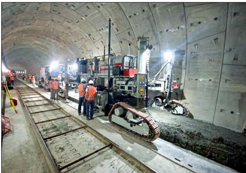
*Figura 15. Sistema Appitrack para ejecución de la losa de vía y colocación de las placas de fijación de carril.*
