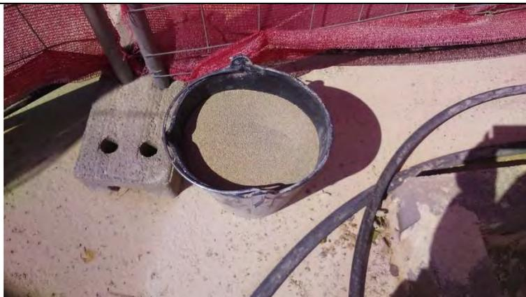
Apoyo de material absorbente para recogida de hidrocarburos en derrames en suelos
