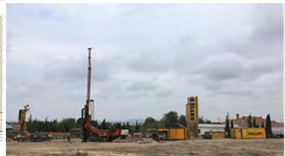
**Figura 1.10. Consolidación de cemento. Solución empleando la técnica de Jet Grouting**
