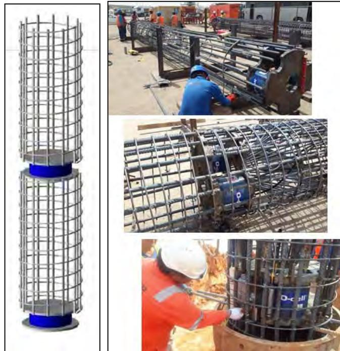
Figura 41. Preparación de un ensayo de carga estático con doble célula Osterberg para un pilote de diámetro 1200 mm.
