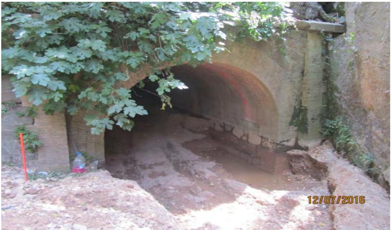
Fotografía nº 7. Zona de embocadura con aterramiento hasta zona de hastiales
