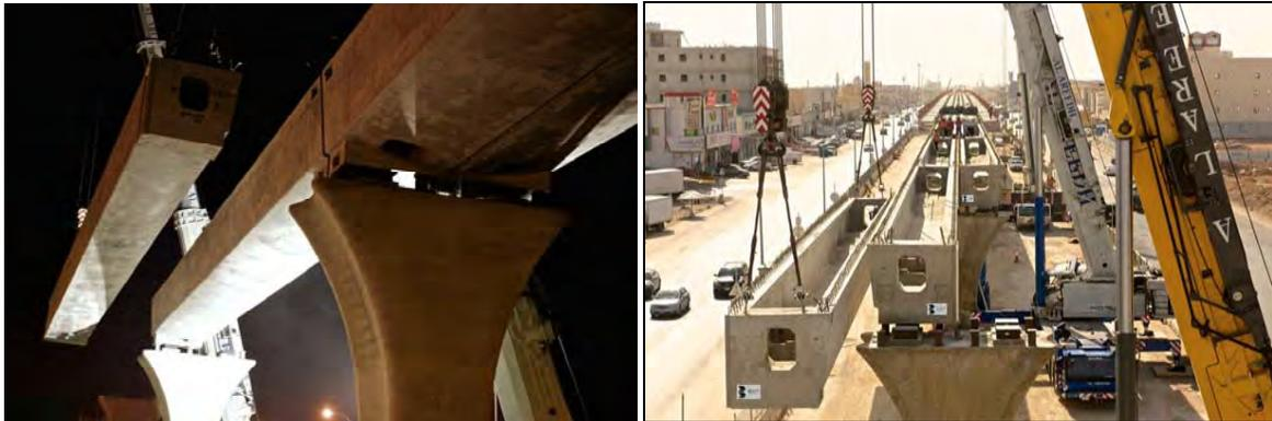
*Figura 7. Colocación de una de las dos vigas prefabricadas que configuran la viga cajón por el método PCB en uno de los viaductos de la Línea 6.*
