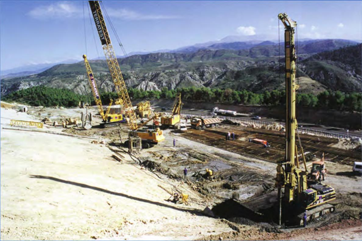
Figura 18. Panorámica de los equipos de preforos, pantallas y auxiliares durante los trabajos
