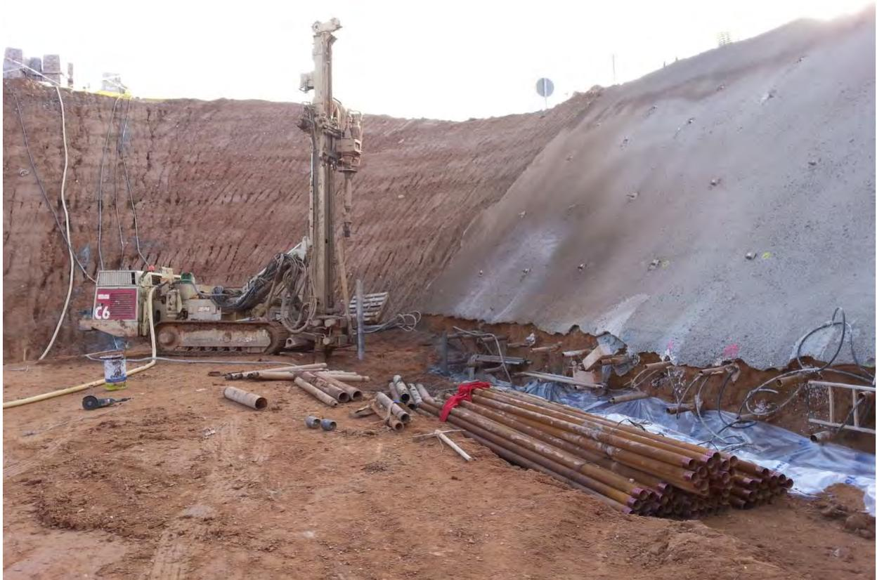
Fotografía 16. Inyección IRS y comienzo de la pantalla de micropilotes vertical.
