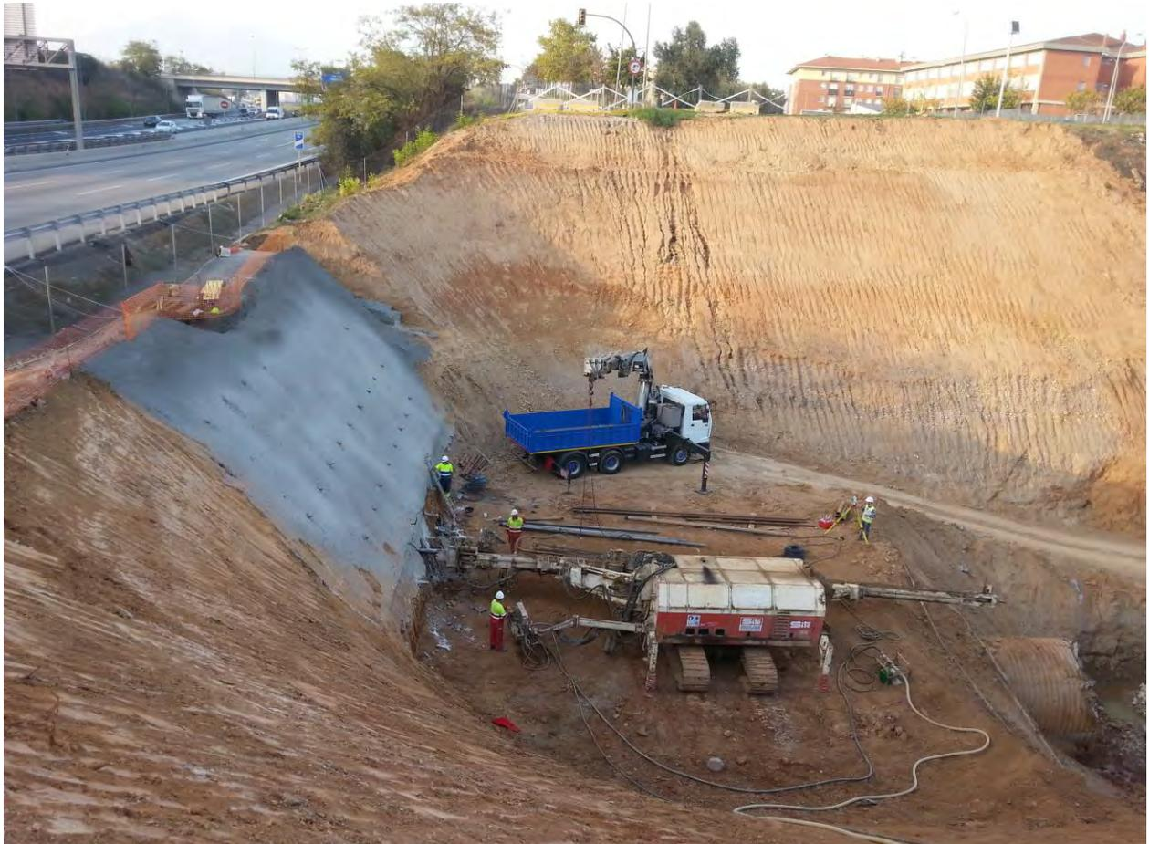
Fotografía 11. Ejecución de la perforación del paraguas de micropilotes IRS.
