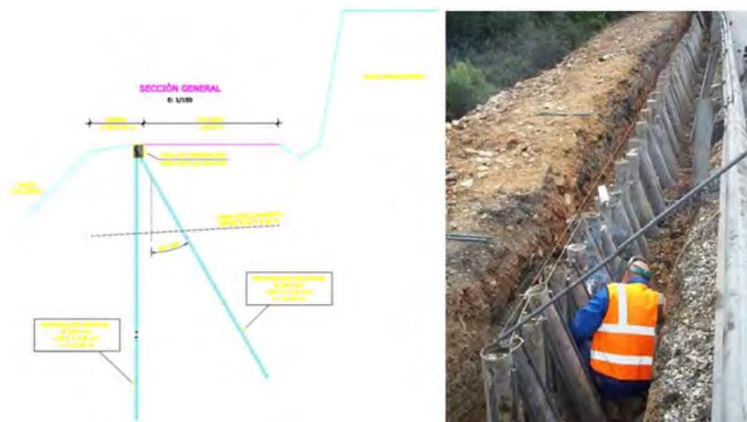
**Figura 1.2. Rotura de la plataforma. Solución contención mediante micros**
