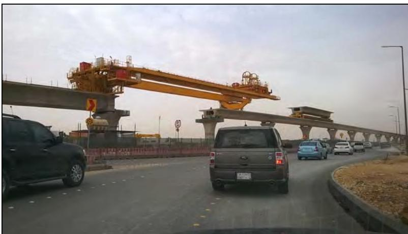
*Figura 6. Pórtico para colocación de las vigas prefabricadas con el sistema “Full Span” en un tramo de viaducto de la Línea 4.*
