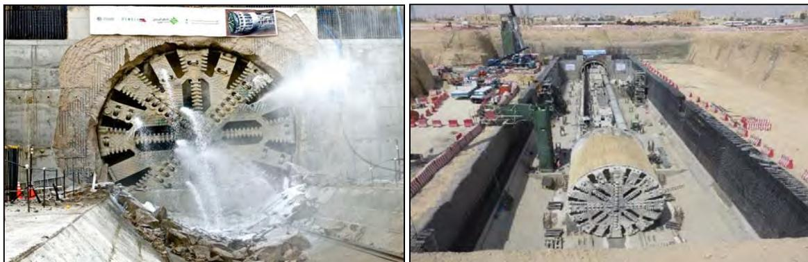
Figura 12. Cale de la TBM-2 en la estación 5C2 (imagen de la izquierda) y arrastre por el interior de la citada estación
