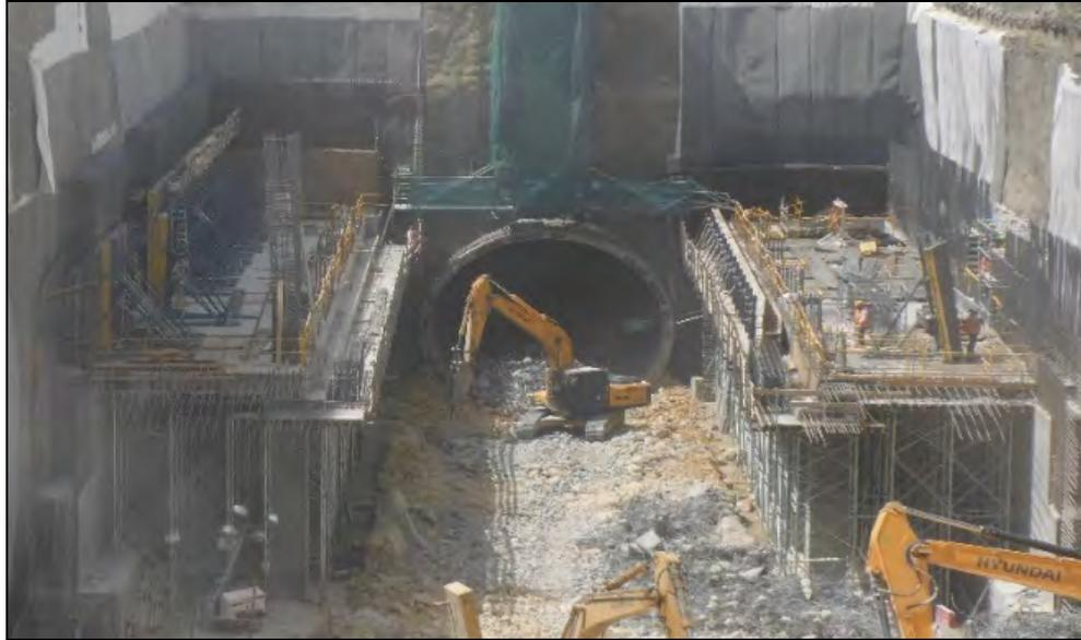
*Figura 55. Cuando la TBM termina la excavación con el cale final en el Pozo Sur, se desmantelan las instalaciones en el interior del túnel y se inicia la demolición de los anillos situados en las estaciones. A partir de entonces se completa la parte central de la contrabóveda y se ejecutan los forjados de la franja central de la estación.*
