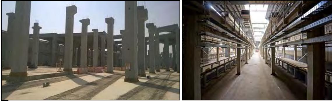
*Figura 33. Pilares prefabricados y losa de la nave terminado y ejecución de la cubierta en febrero de 2017 (izquierda), y edificio en fase de montaje de instalaciones en noviembre de 2018 (derecha).*
