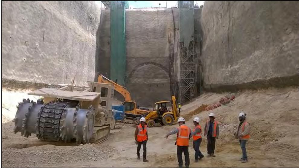
Figura 31. Rozadora/zanjadora gigante para acelerar la excavación de la roca caliza en la estación 5B4.
