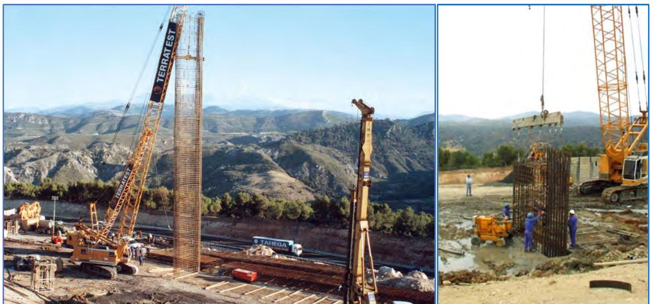
Figura 20. Grúa auxiliar en proceso de colocación de la armadura
