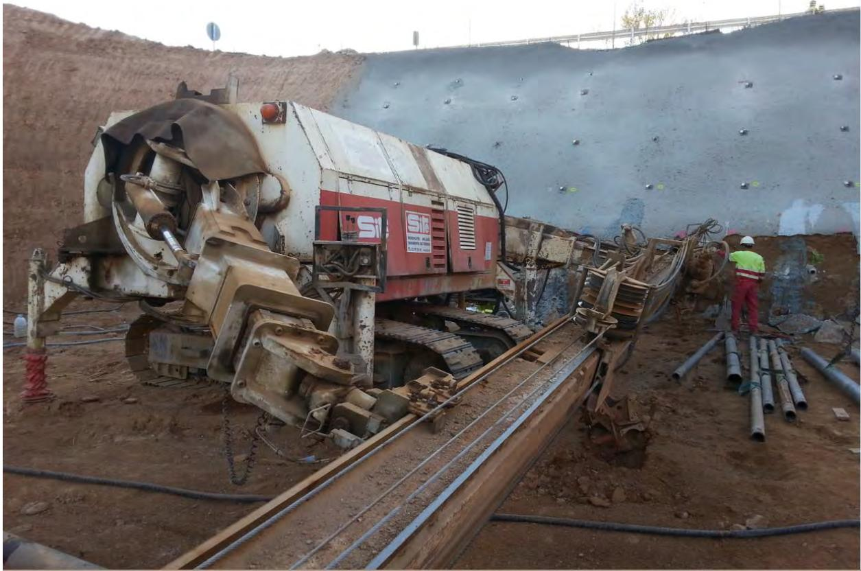
Fotografía 12. Ejecución de la perforación del paraguas de micropilotes IRS.(2)
