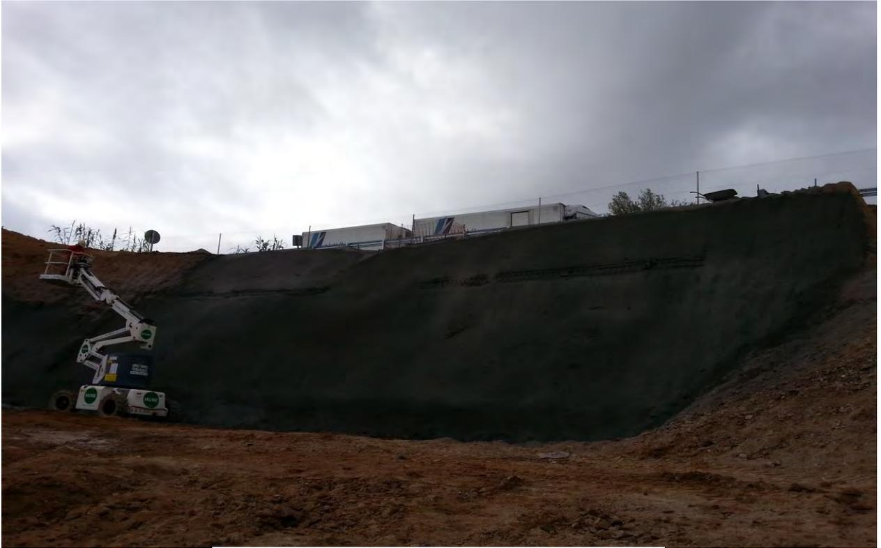
Fotografía 9. Ejecución de los trabajos de Soil Nailing.
