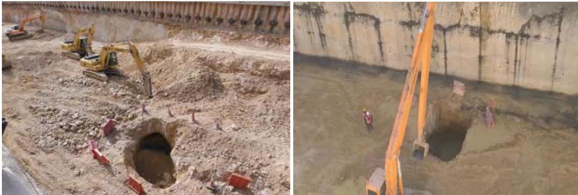
Figura 18. Cavidades cársticas encontradas durante los trabajos de excavación de la estación 5B1 (izquierda) y en el fondo de excavación de la estación 5C1 (derecha), ambas de la Línea 5.
