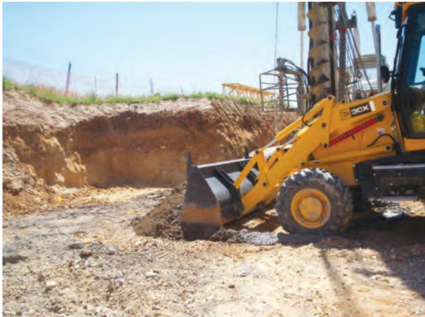
**Figura 144.** Limpieza de tierras con pala. La pilotadora permanece detenida mientras duran estos trabajos
