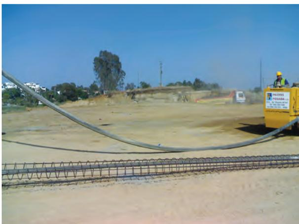
**Figuras 141.** Manguera estirada sin quedar bien apoyada (mal) y manguera sin tensar con una gran superficie apoyada en el suelo (bien)
