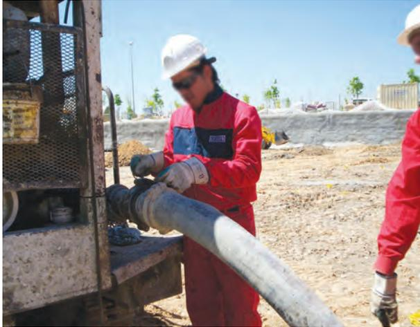
**Figura 140.** Operarios acoplando la manguera de hormigonar a la bomba, comprobando el buen estado de los cierres y collares de la manguera
