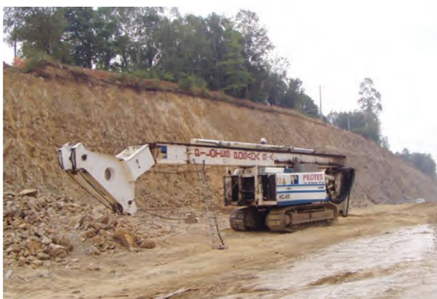
**Figura 100.** *Montaje de la pilotadora en una plataforma de trabajo estable y horizontal. Hay que utilizar escaleras de mano para acceder a la torre*
