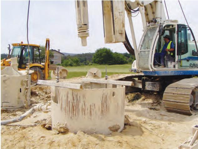
**Figura 118.** Utilización de una camisa de emboquillamiento en pilotes perforados con lodos
