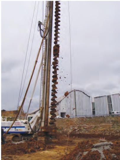
**Figura 139.** Durante la sacudida de la barrena todos los trabajadores permanecen fuera del radio de acción del equipo y del alcance de las tierras desprendidas
