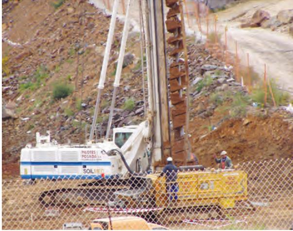
**Figura 138.** La barrena asciende cargada de tierras, con lo que existe riesgo de desprendimiento de las mismas sobre los operarios que se encuentran en el radio de acción
