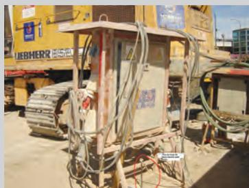
**Figura 86.** Cuadro eléctrico con pica de tierra mal clavada
