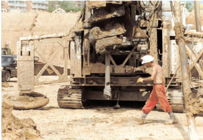
*Detalle del tubo de hormigonado*
