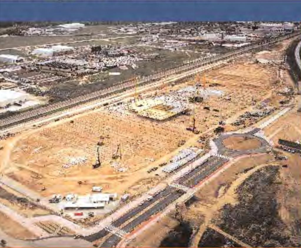
Obra de construcción de Centro Comercial WESCOM mediante pilotes prefabricados. Zona en Ronda de Huelva (Murcia)
