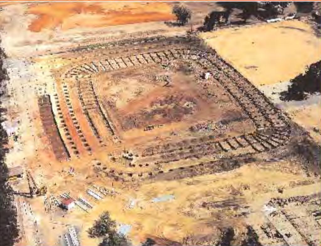
Obra de construcción de Nuevo Estadio Deportivo mediante pilotes prefabricados. Zona en Huelva
