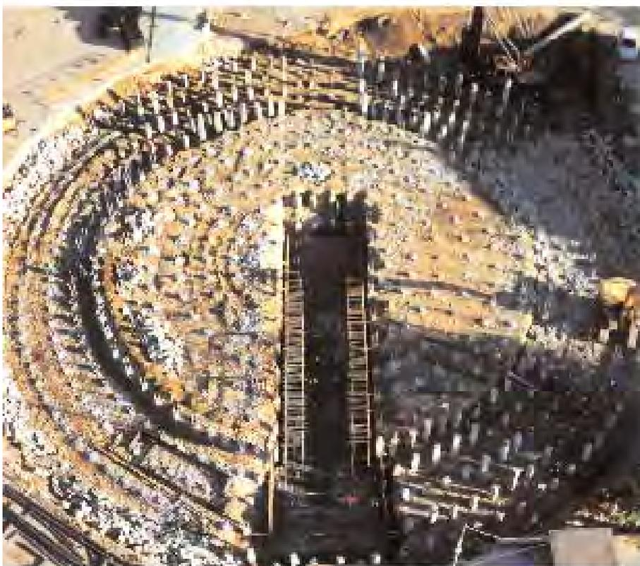
Cimentación mediante pilotes prefabricados Terra del nuevo silo de azúcar de 75.000 Tn de carga útil en la Fábrica de Benavente (Zamora)
