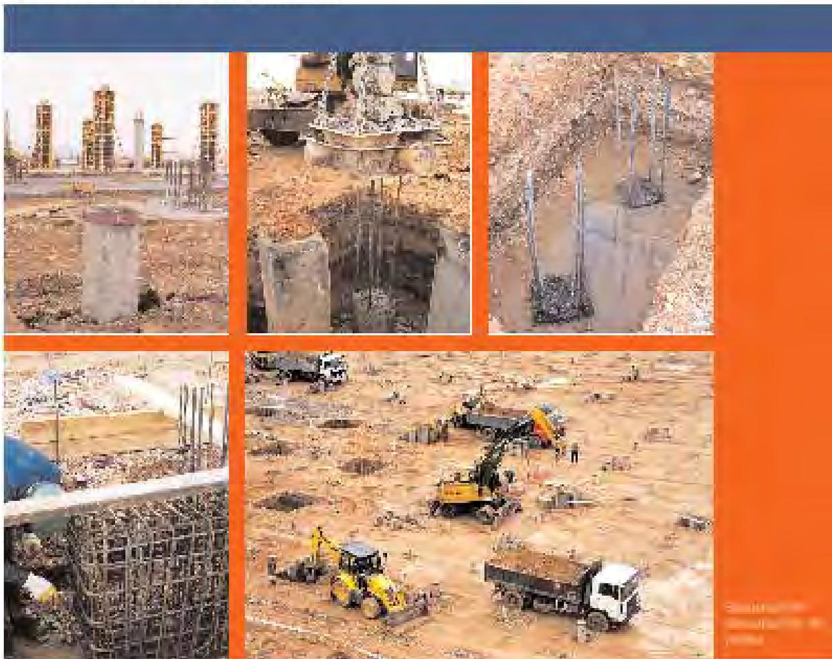
Para facilitar las labores posteriores a la hinca de los pilotes prefabricados TIPO **TERRA**, se dispone de descabezadores hidráulicos de pilotes, que de forma **sencilla, rápida y económica**, agilizan los trabajos de demolición de la longitud de pilote necesaria *para la conexión de los mismos con los encepados*, **completando así la solución de cimentación**.
