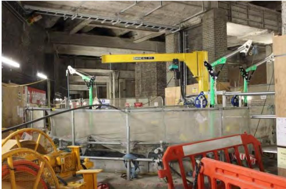
Figura 43. Pozo de compensación en interior de túneles
