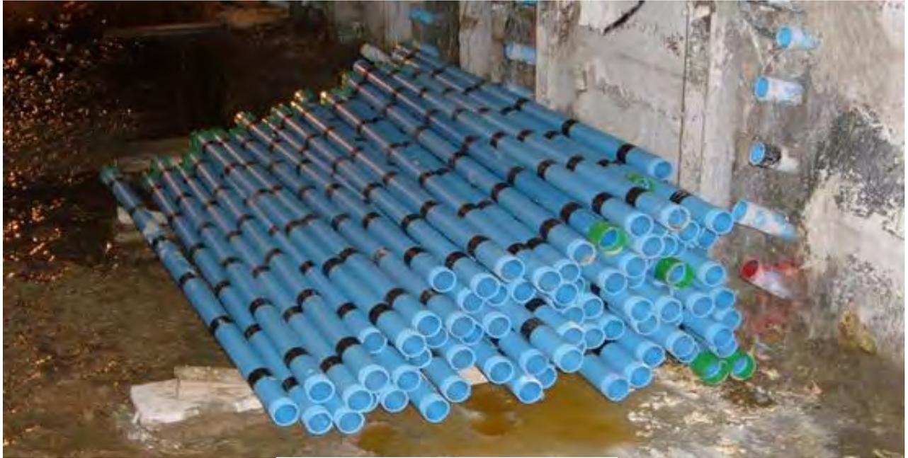
Fig.10 Perforaciones con tubo manguito.
