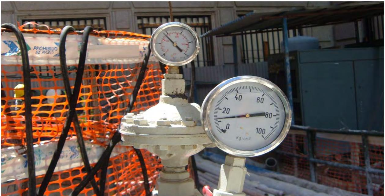
Fig.13 Instrumentación redundante.
