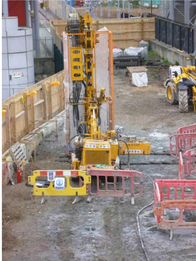
Figura 30. Trabajos de instalación de la barrera de micropilotes autopercorantes
