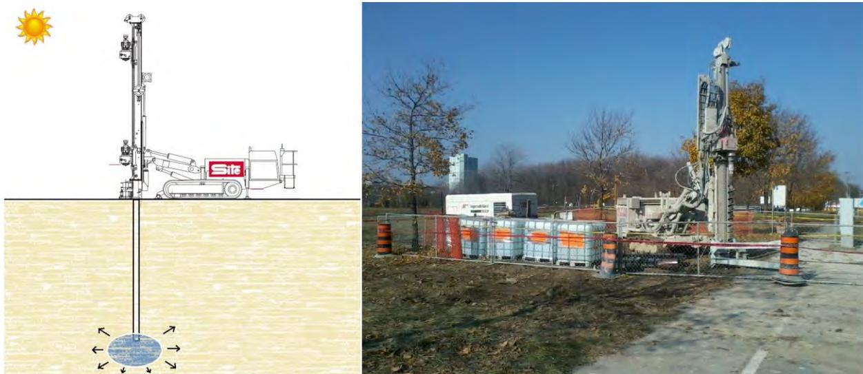
Fig.3 inyecciones de compactación.
