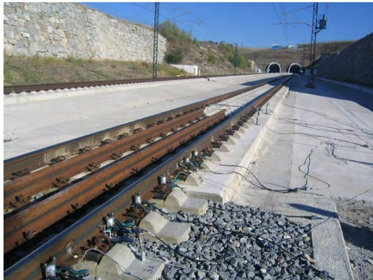
**Foto 6. Instrumentación de transición vía en placa - vía sobre balasto**
