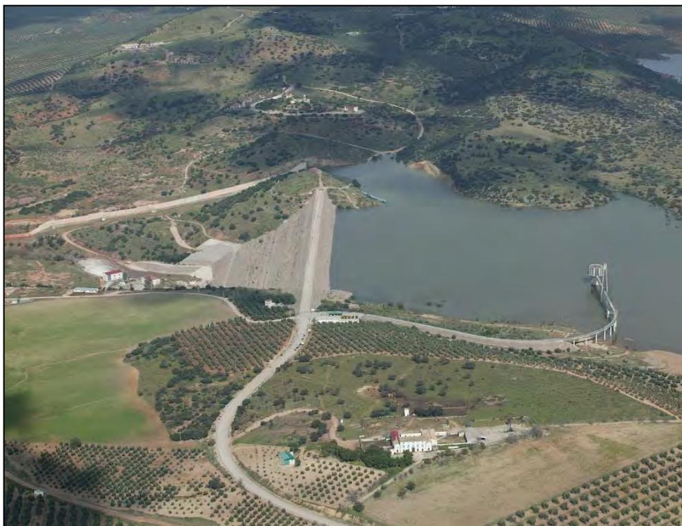
La auscultación de movimientos internos (células hidráulicas) y de presiones intersticiales, indicó, por dos vías separadas y compatibles, que se estaba produciendo un deslizamiento del espaldón de aguas arriba durante construcción.
