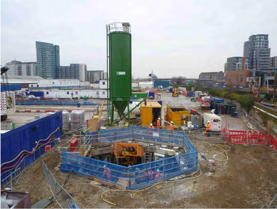
Figura 21. Pozo hexagonal desde el que se ejecutaron los taladros sub horizontales
