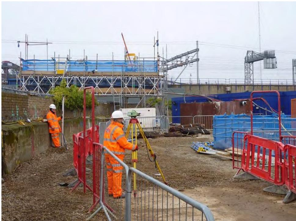
Figura 36. Control de movimientos en el área tratada de Pudding Mill Lane
