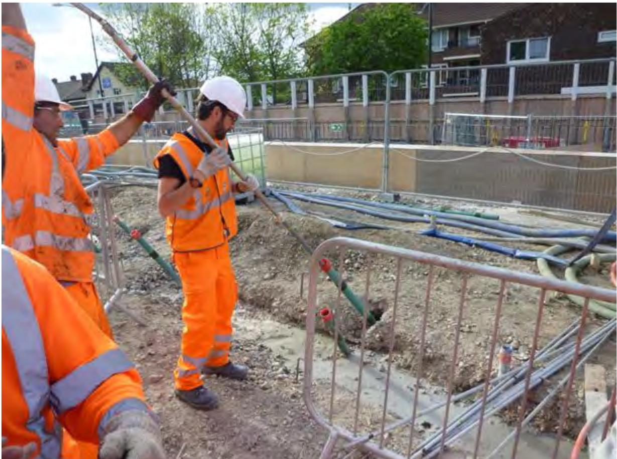
Figura 5. Introducción del HDAD1 en un taladro sub horizontal
