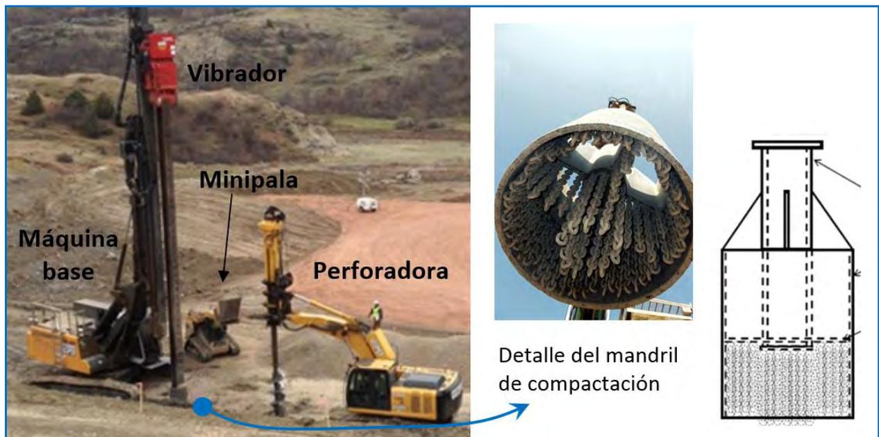
Figura 10. Equipos necesarios para la ejecución de columnas X1. Detalle del mandril de compactación
