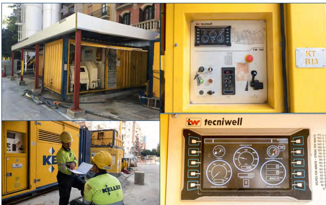
Figura 9. Instalaciones de las bombas y plantas en estructuras tipo contenedor.
