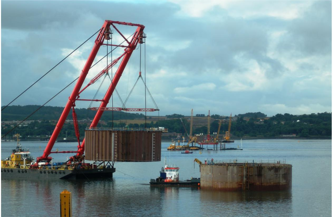
*Figura 5. Instalación del cajón provisional.*
