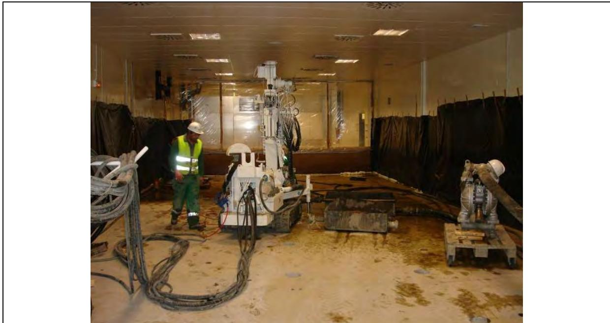
Figura 19. Actuación con Springsol® bajo solera con asientos en una nave industrial.
