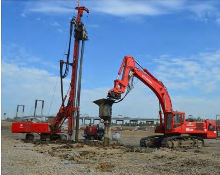
Figura 3: maquinaria durante la ejecución de Columnas Bi-Módulo.
