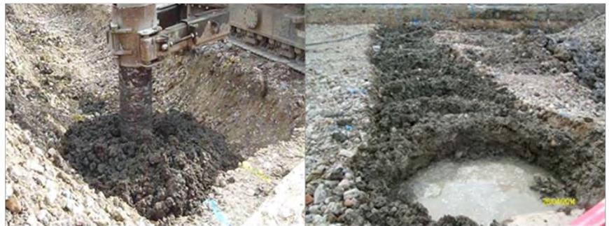
Figura 27. Detalles de la ejecución del deep soil mixing
