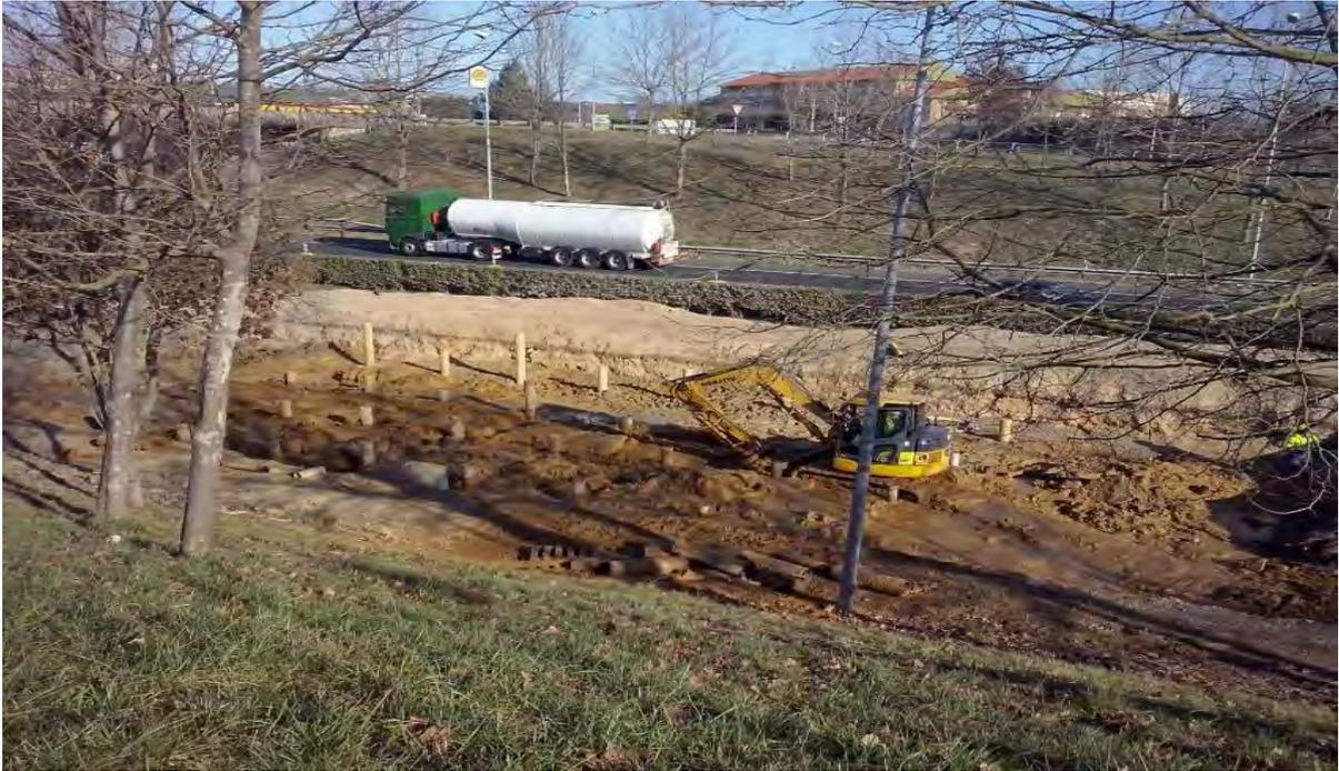
Figura 19 – Preparación superficie de losa tras ejecución de micropilotes.
