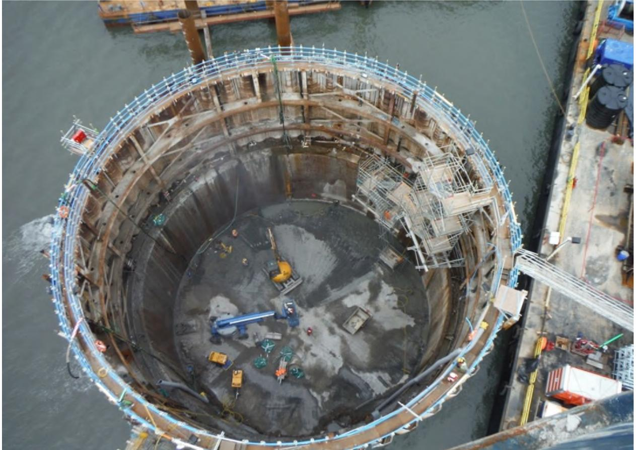
*Figura 8. Cajón de la Torre Norte con el tapón de hormigón sumergido ejecutado y tras el vaciado de agua en el interior.*
