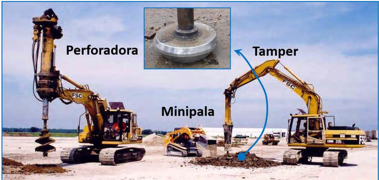
Figura 4. Equipos necesarios para la ejecución de columnas GP3
