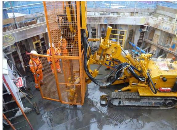
Figura 12. Perforación e instalación de los tubos manguito desde pozo para evitar los obstáculos (escombros) existentes en superficie
