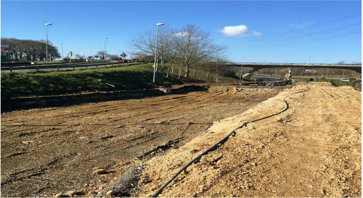
Figura 14 – Excavación de la zona de losa
