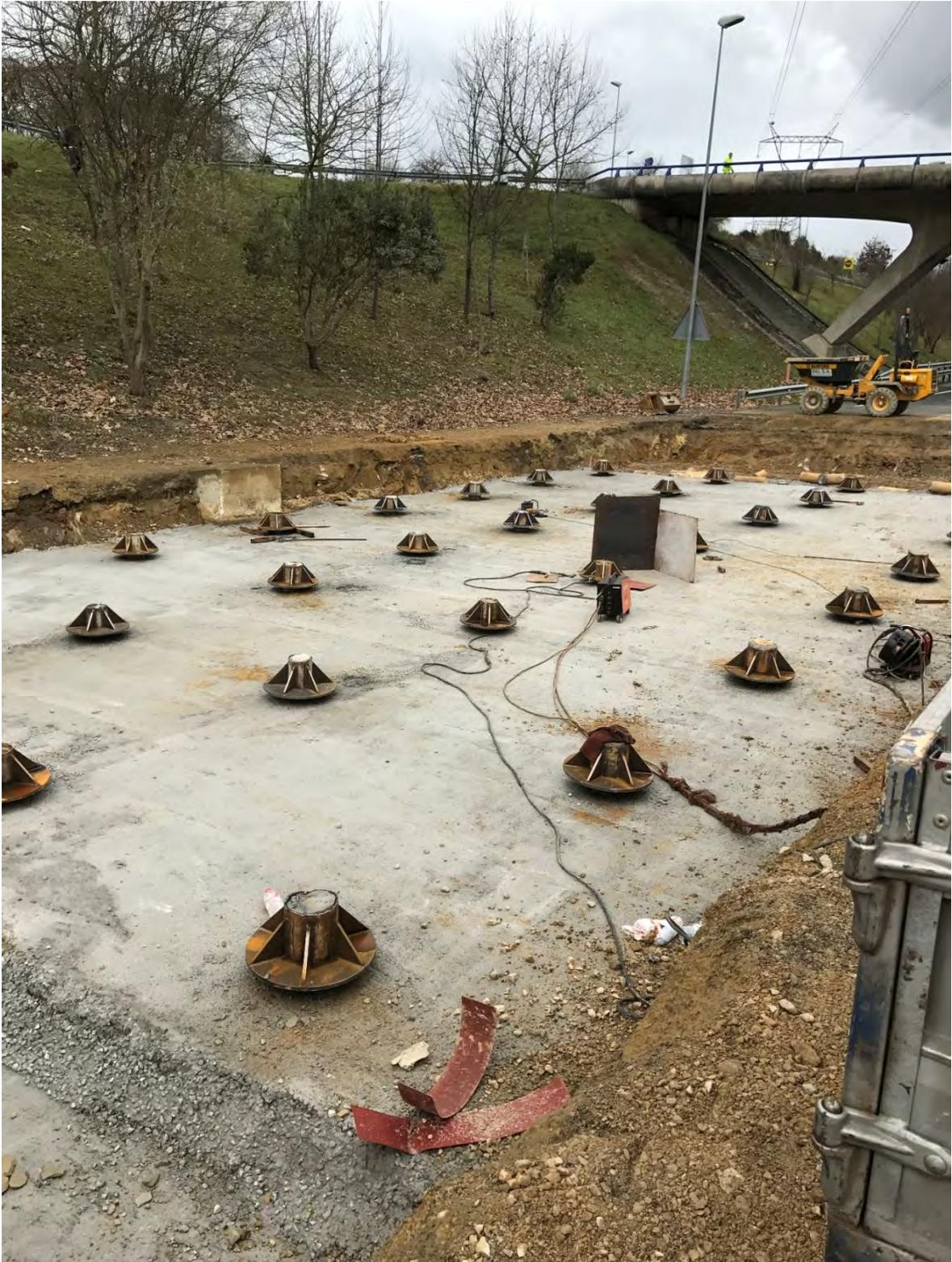
Figura 21 – Superficie con hormigón de limpieza previa a la losa 1 de hormigón armado.
