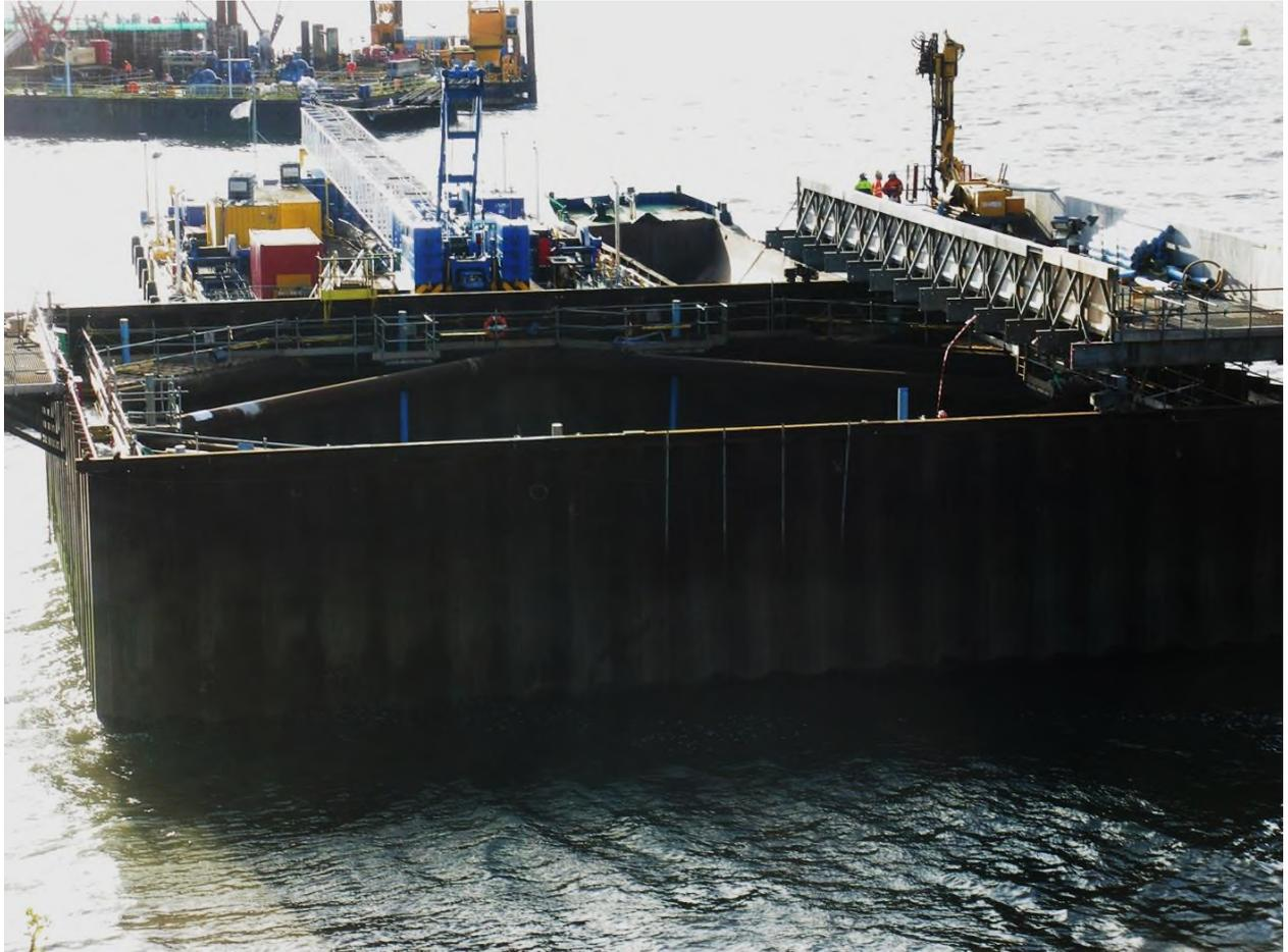
*Figura 15. Vista de la Pila N1 con plataforma para ejecutar los pozos.*
