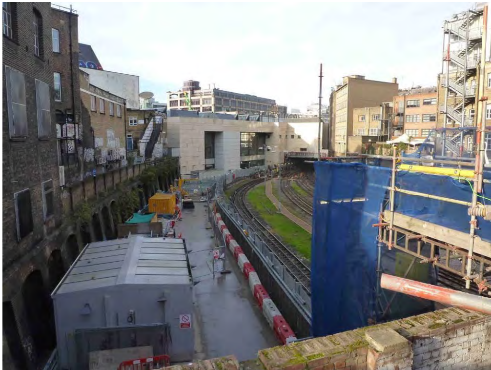
Figura 15. Vista de la entrada a la actual estación de Farringdon de Network Rail
