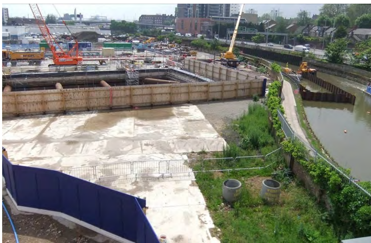
Figura 4. Detalles de la obra con el portal y el río Lea
