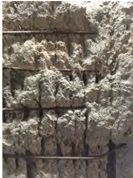
Esquema mostrando distintos grados de acolchado y fotografía con defecto por acolchado.
