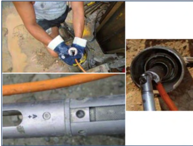
Figura 5. Colocación del sistema Inclijet para el control de desviación.
