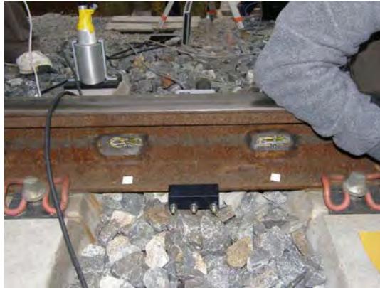
Foto 1.- Colocación de bandas extensométricas en Cantoblanco
