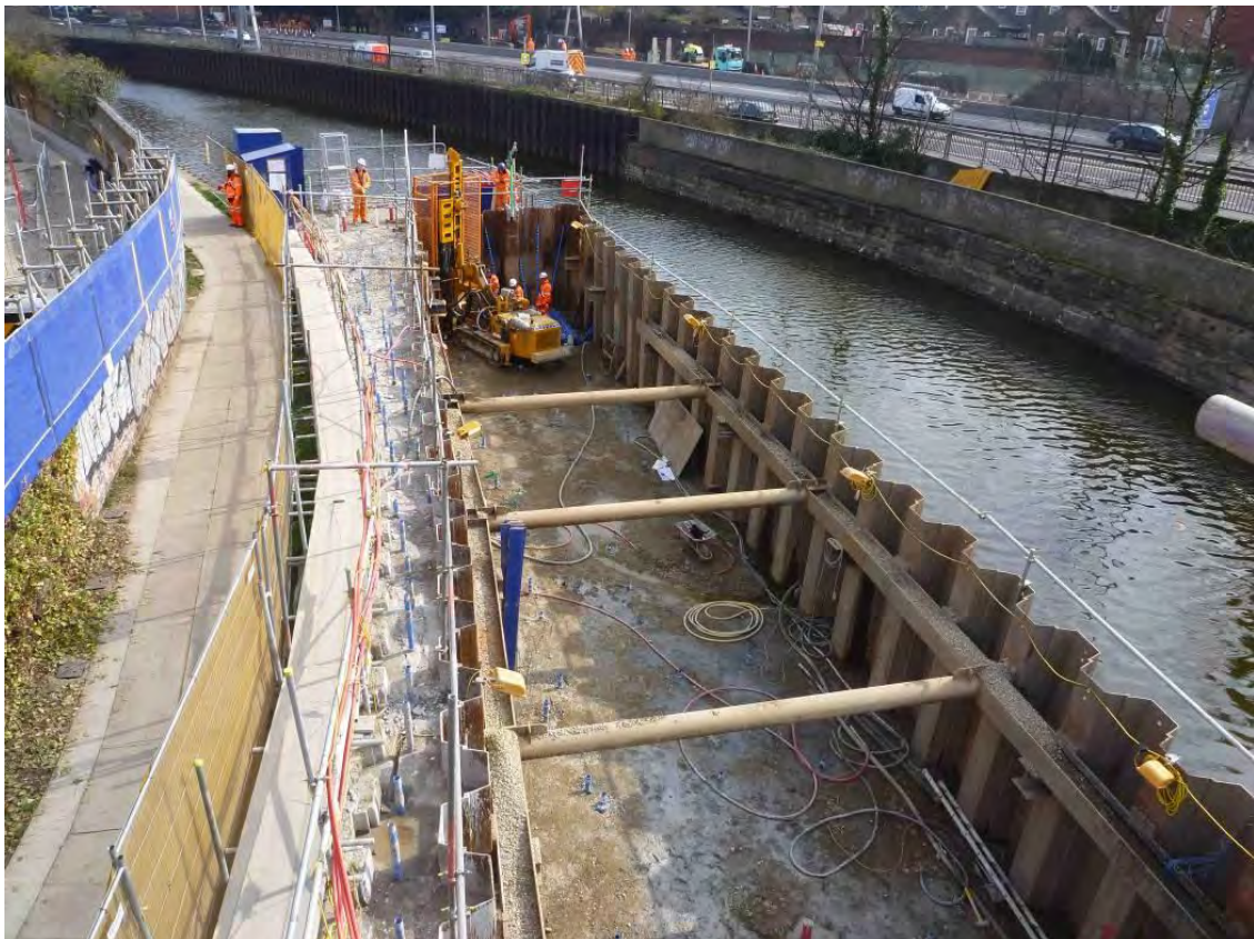
Figura 22. Cofferdam para ejecutar los taladros en la zona del río Lea
