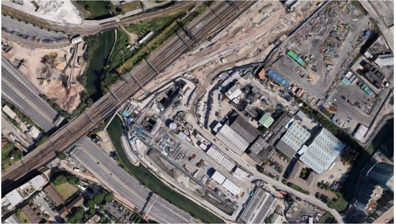
Figura 1. Vista aérea del portal de Pudding Mill Lane
