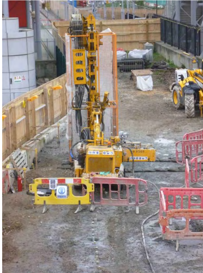
Figura 30. Trabajos de instalación de la barrera de micropilotes autoperforantes
