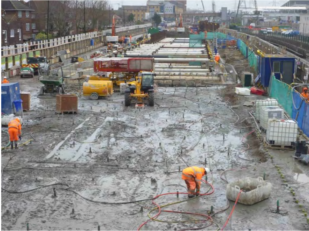
Figura 28. Malla de TAM verticales instalados en la zona a tratar al norte de la barrera de micropilotes autoperforantes de protección del DLR.
