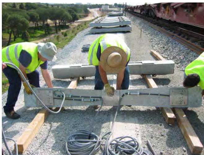
Foto 4. Instalación de células de presión bajo las traviesas
