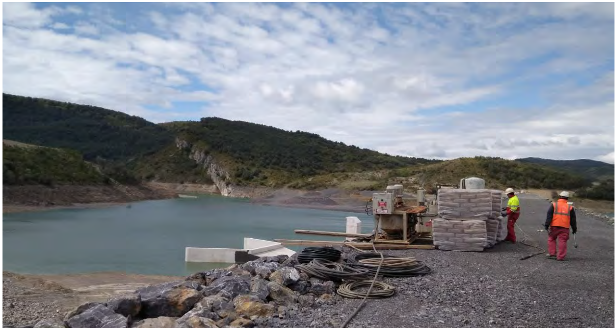
Fig.4 Inyecciones de impermeabilización
