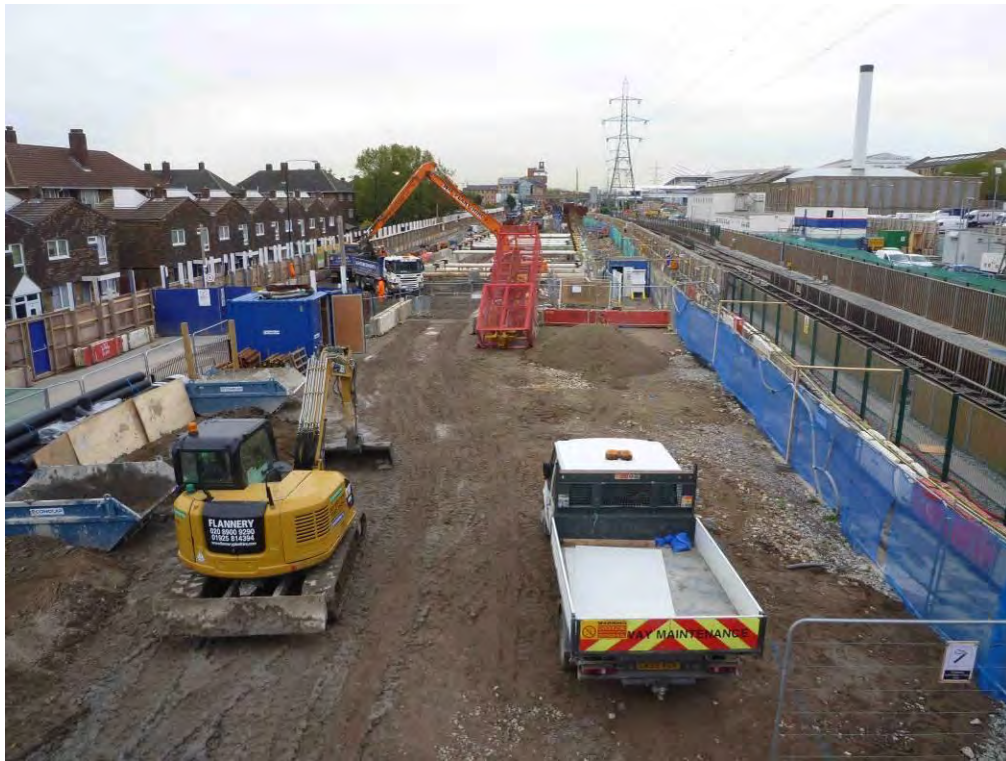
Figura 10. Vista de la obra con el portal de fondo
