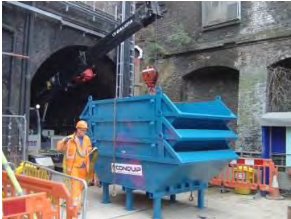
Figura 46. Traslado y montaje de equipos dentro de túneles
