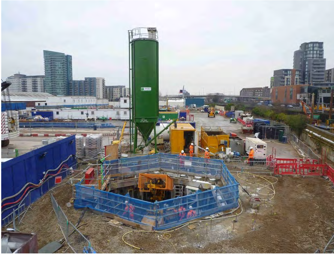
Figura 21. Pozo hexagonal desde el que se ejecutaron los taladros sub horizontales
