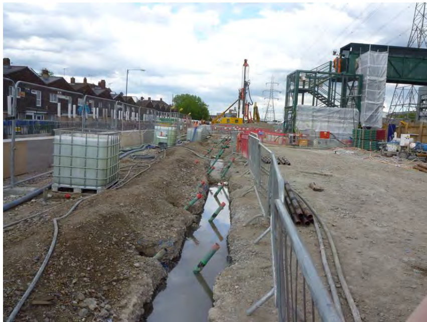
Figura 29. Malla de TAM inclinados instalados bajo la barrera de micropilotes de protección de los servicios de la calle Victoria Dock Road.
