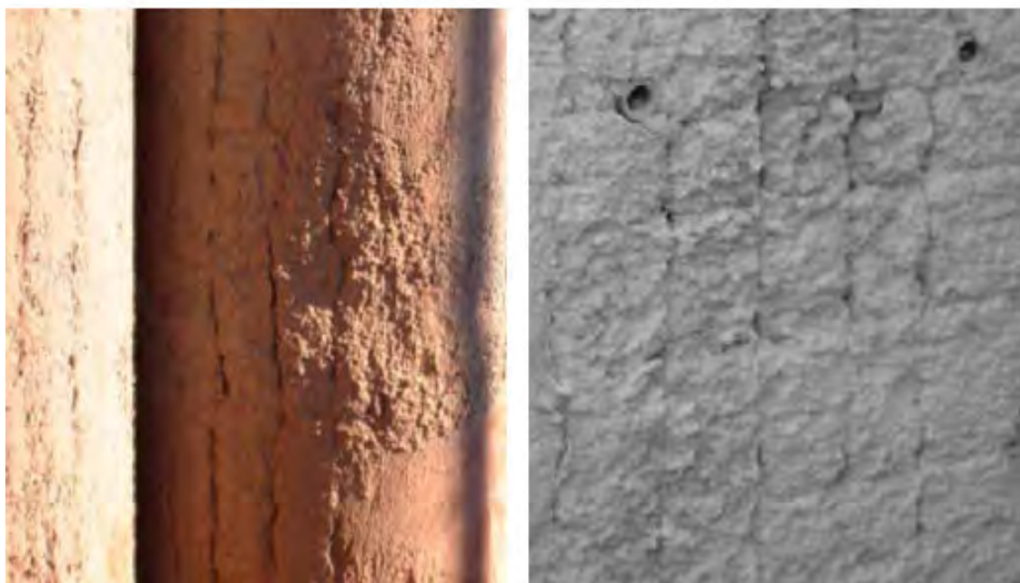
Sombras en un pilote (izquierda). Acolchado en un panel de pantalla (derecha).
