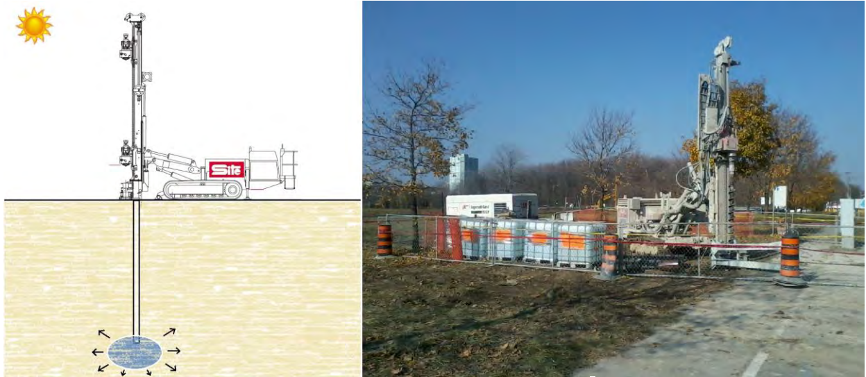
Fig.3 inyecciones de compactación.
