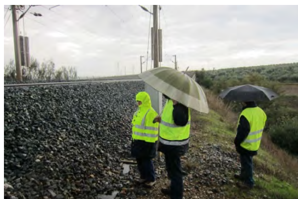
Foto 8. Sección instrumentada con espesor importante de balasto
