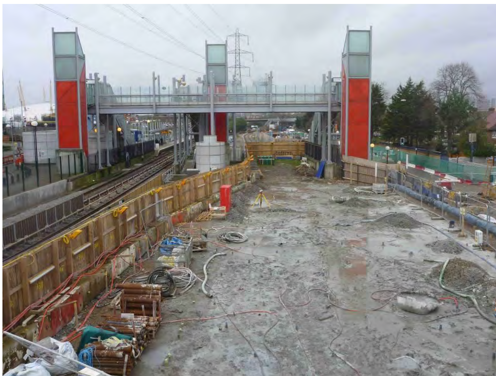
Figura 9. Vista de la obra con la estación del DLR Royal Victoria de fondo
