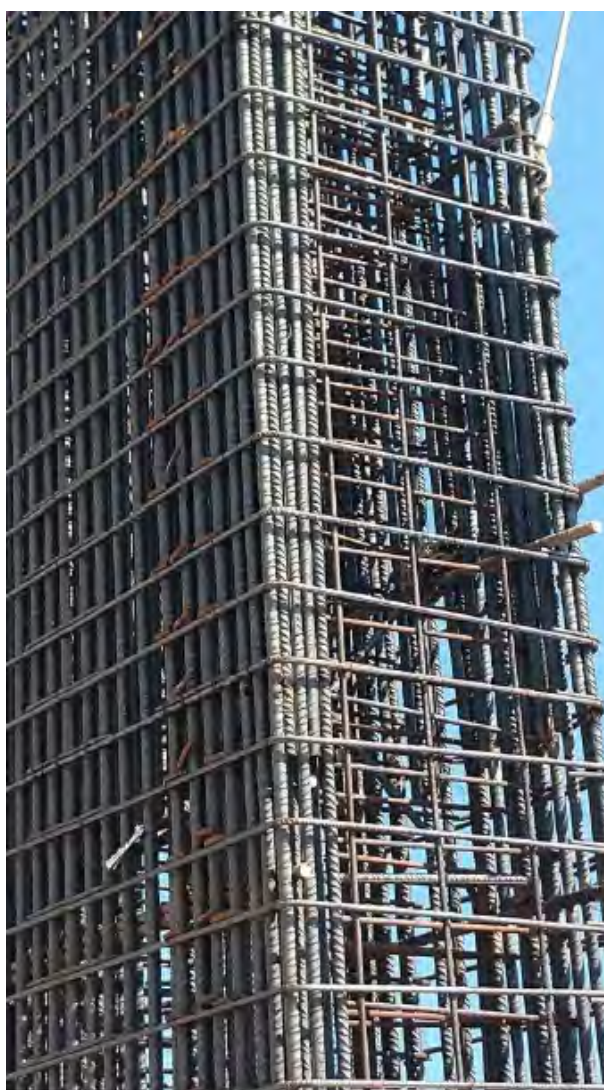
Alta densidad de armadura en las jaulas de elementos de cimentación.
