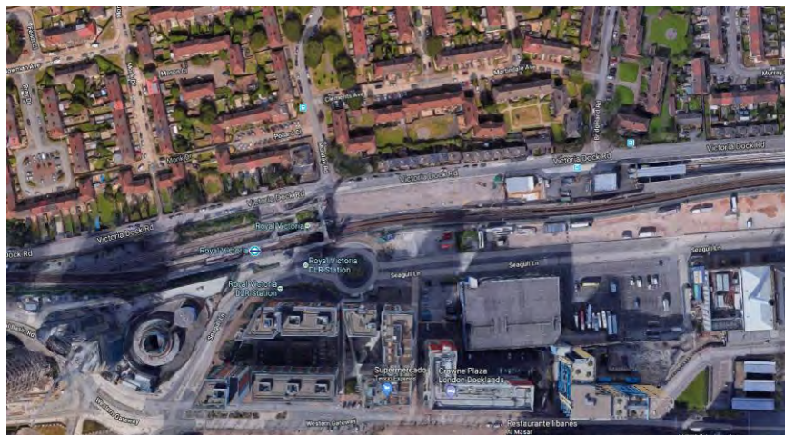
Figura 6. Vista aérea de la zona de la obra
