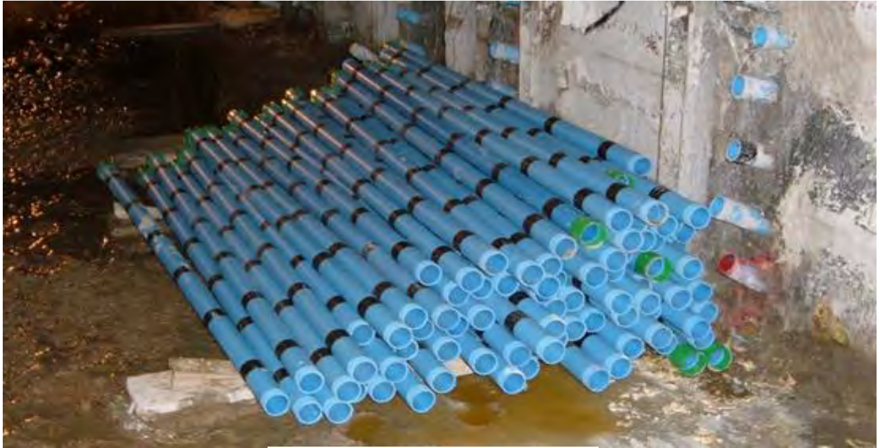
Fig.10 Perforaciones con tubo manguito.
