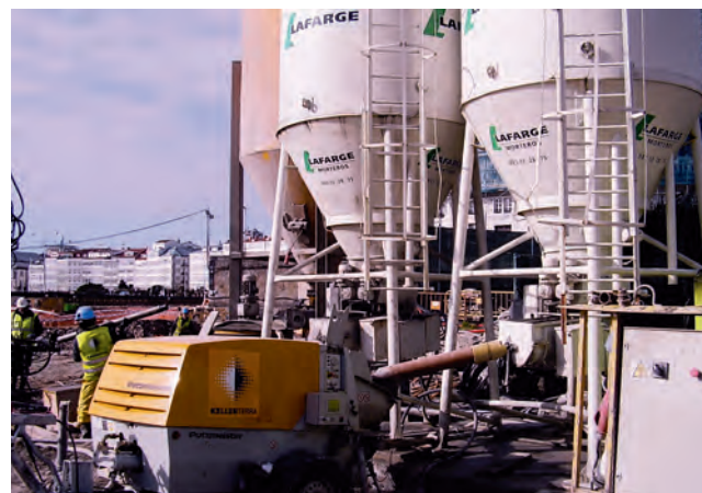
Figuras 19 y 20. EQUIPO KLEMM 806 EJECUTANDO INYECCIÓN DE MORTERO. BOMBA PUTZMEISTER INFORMATIZADA, MEZCLADORA DE TORNILLO Y SILOS DE MORTERO PREDOSIFICADO.
