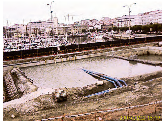
Figuras 8 y 9. SISTEMA DE BOMBEO Y BALSAS DE DECANTACIÓN PARA COMPARTIMENTACIÓN DEL FRENTE DE EXCAVACIÓN.
