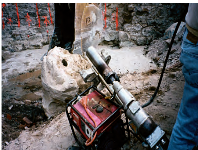
Figura 9. EXTRACCIÓN DE TESTIGOS DE UNA COLUMNA DE PRUEBA.
