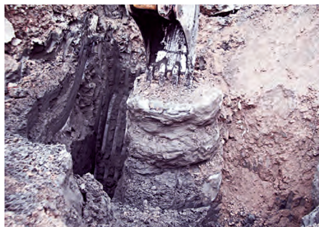
Figura 35. COLUMNA DE MÁS DE 1,3 m DE DIÁMETRO.
