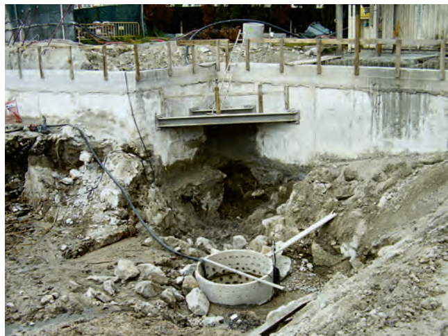
Figuras 10 y 11. PANELES CORTOS E INTRUSIÓN DE BOLOS EN PIE DE PANEL.
