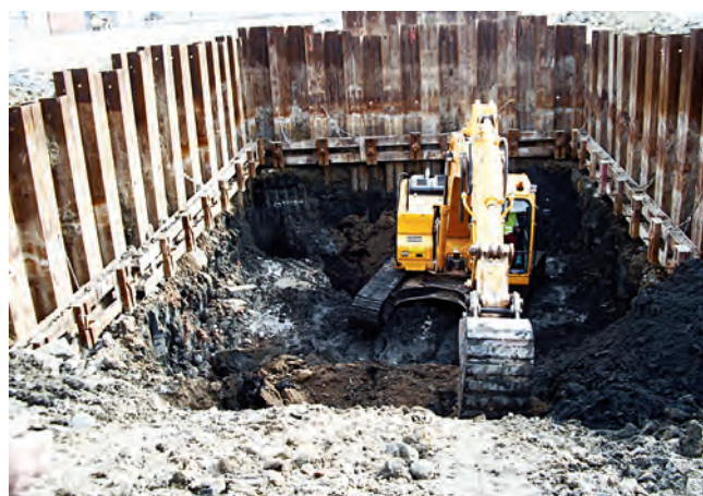
Figura 34. ZONA DE PRUEBAS: EXCAVACIÓN.
