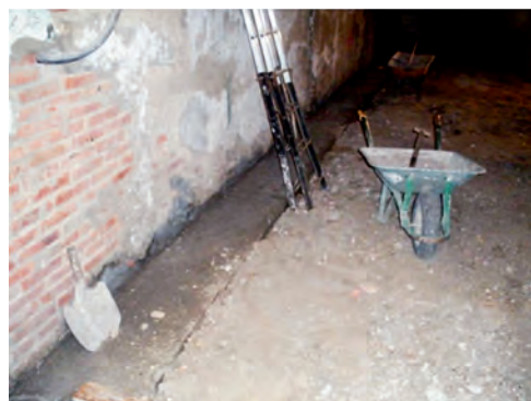
Figura 31. ELEMENTOS DE MICROPILOTE A COLOCAR.
