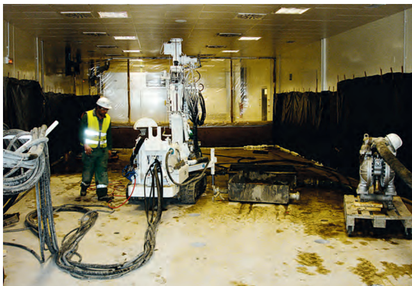
Figura 8. TRABAJOS EN EL INTERIOR DE LAS SALAS CON SISTEMA DE CAPTACIÓN Y RETIRADA DE DETRITOS.
