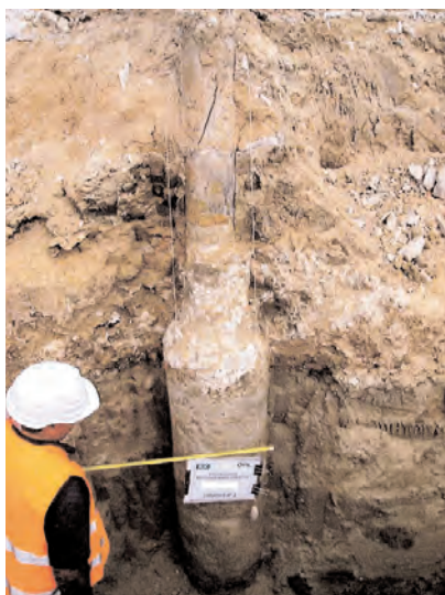
Figura 6. COLUMNA DE SPRING-SOIL (gentileza de Rodio-Kronsa).
