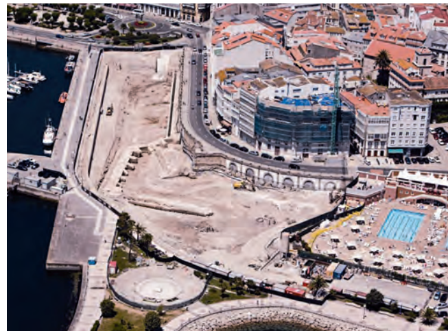
Figura 2. DETALLE DEL EMPLAZAMIENTO CON PARTE DE LA EXCAVACIÓN REALIZADA.
