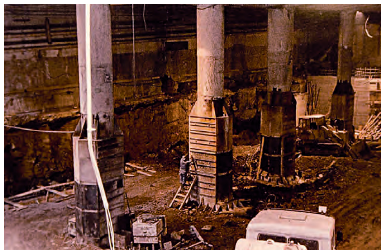
Figura 33. VISTA DEL RECALCE.
