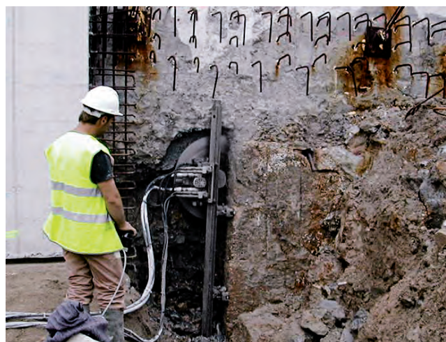
Figuras 23 y 24. COLOCACIÓN DE CONECTORES, ESCAMA DE MURO EJECUTADA Y SANEAMIENTO EN PIE DE PANEL (después de los tratamientos del terreno).
