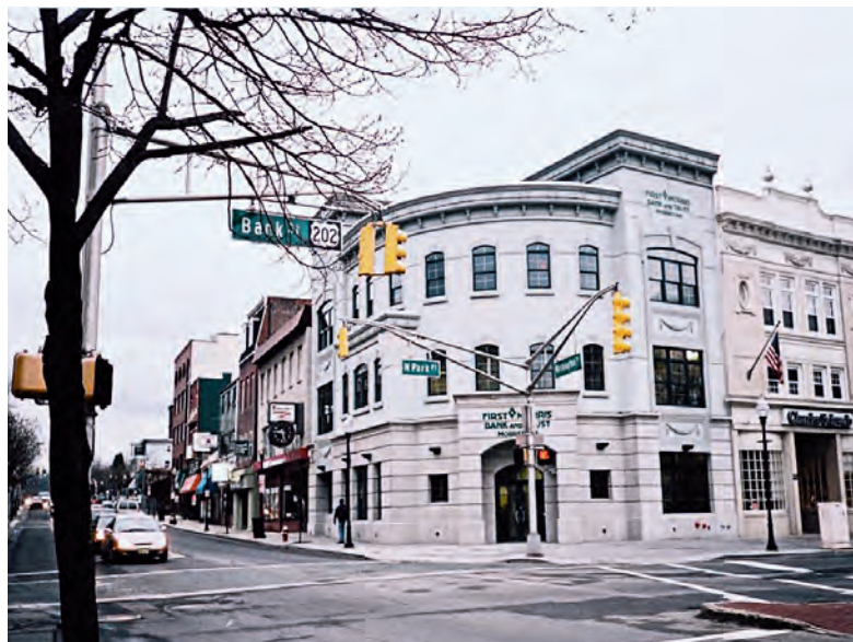
Figura 1. VISTA GENERAL DEL NUEVO EDIFICIO.
