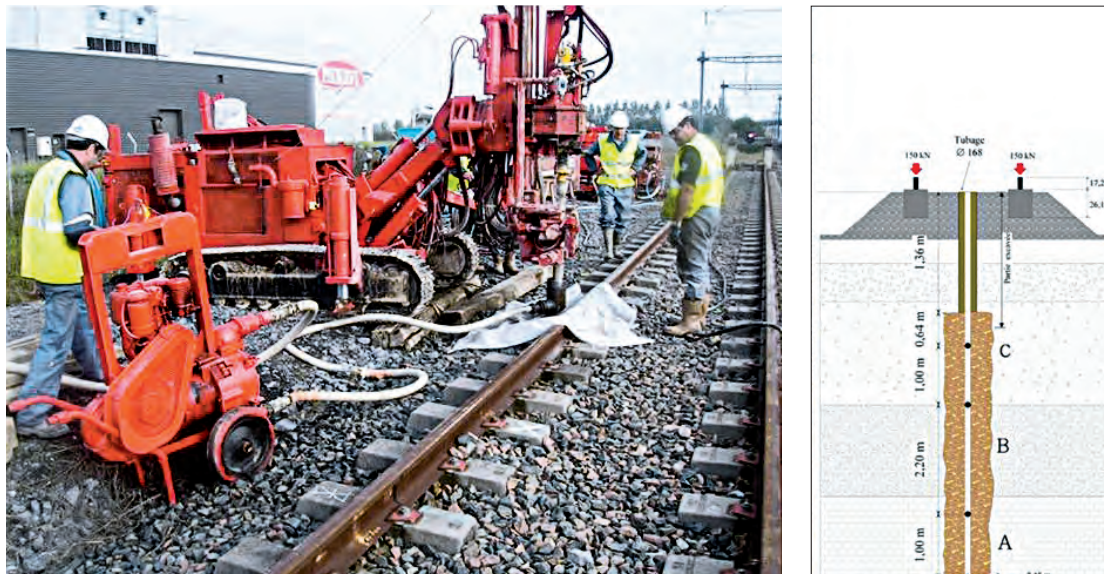
Figura 13. SPRINGSOL EN TRATAMIENTO DE TERRAPLÉN FERROVIARIO
