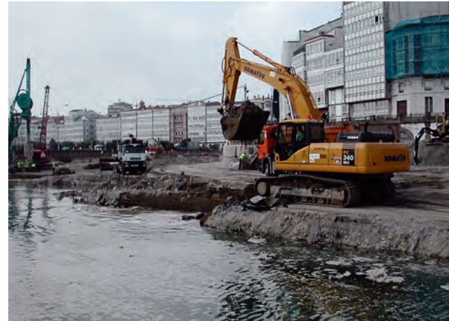
Figuras 6 y 7. FILTRACIÓN DE AGUA A TRAVÉS DE LA PANTALLA E INUNDACIÓN GENERALIZADA DEL RECINTO EXCAVADO.
