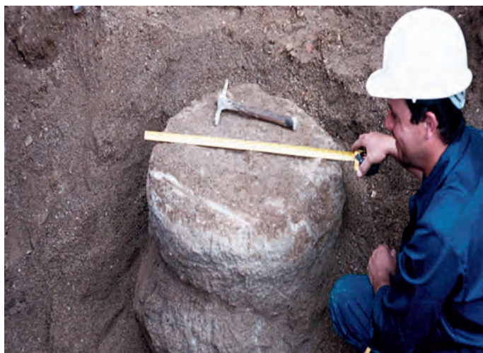
Figura 8. INSPECCIÓN VISUAL DE UNA COLUMNA DE PRUEBA.
