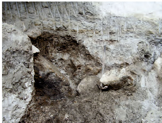
Figuras 10 y 11. PANELES CORTOS E INTRUSIÓN DE BOLOS EN PIE DE PANEL.
