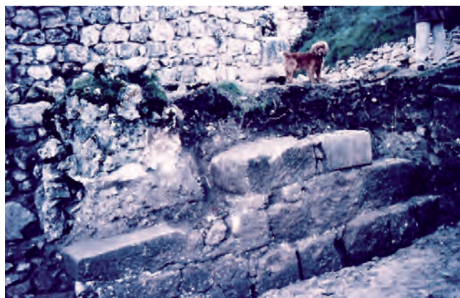
Figura 6. CIMENTACIÓN ROMANA DE SILLERÍA DE LAS MURALLAS DE SEPÚLVEDA (obra y fotografía del autor, año 1986).
