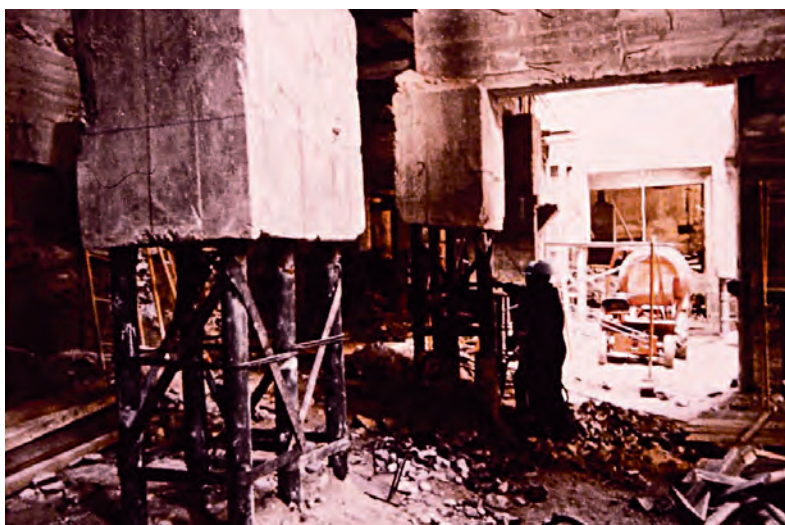
Figura 50. PILARES DESCENDENTES ENGLOBANDO LOS MICROPILOTES DE PROLONGACIÓN DE LA ESTRUCTURA (cortesía de A. Javier Corazón).
