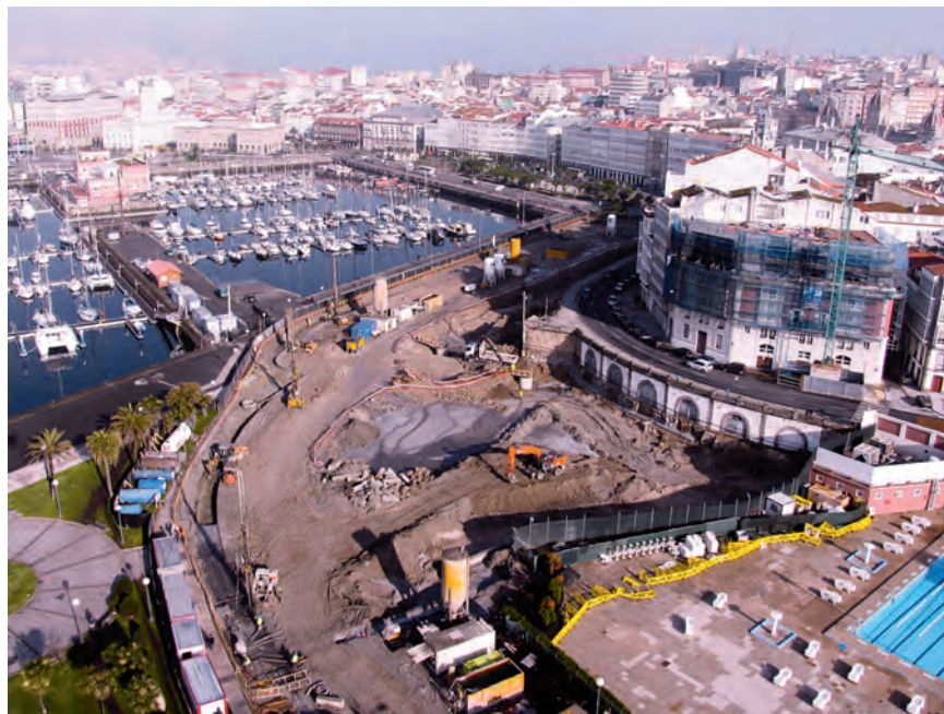
Figura 22. VISTA GENERAL DEL DESARROLLO DE LOS TRABAJOS (6 equipos trabajando simultáneamente).
