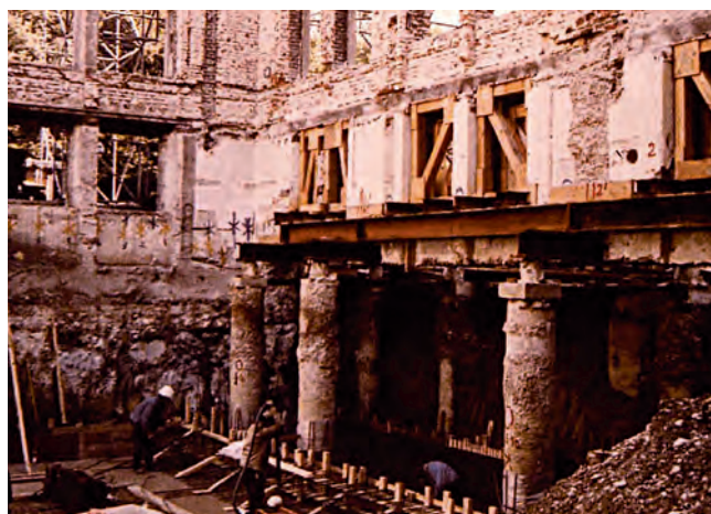
Figura 47. PROLONGACIÓN DE MURO MEDIANTE APEO CON PILOTES Y VIGAS-AGUJA PASANTES.
