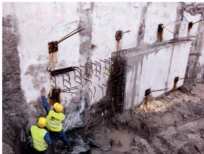
Figuras 23 y 24. COLOCACIÓN DE CONECTORES, ESCAMA DE MURO EJECUTADA Y SANEAMIENTO EN PIE DE PANEL (después de los tratamientos del terreno).
