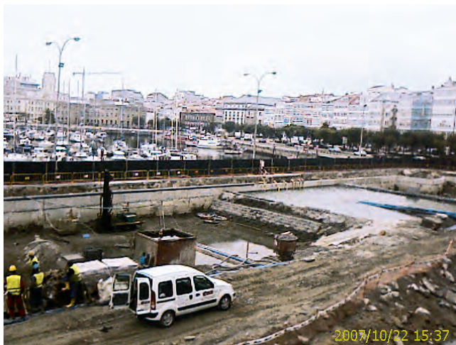
Figuras 8 y 9. SISTEMA DE BOMBEO Y BALSAS DE DECANTACIÓN PARA COMPARTIMENTACIÓN DEL FRENTE DE EXCAVACIÓN.
