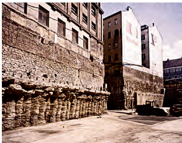
Figura 23. HOTEL PENTA EN PRAGA (cortesía de Zakládání staveb, a.s.).
