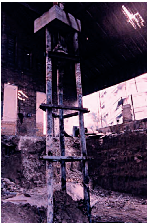
Figura 49. MICROPILOTES QUE PUEDEN QUEDAR FORMANDO PARTE DEL PILAR DEFINITIVO.
