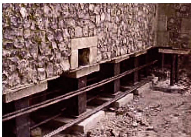
Figura 10. APEOS PUNTUALES PYNFORD PARA ENCAJAR UNA VIGA DE REPARTO BAJO MAMPOSTERÍA.
