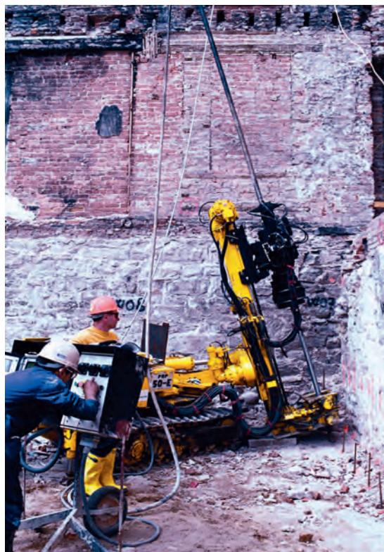
Figura 12. AJUSTE DE LOS PARÁMETROS DE EJECUCIÓN DEL JET-GROUTING.
