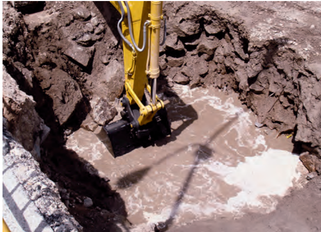
Figuras 6 y 7. FILTRACIÓN DE AGUA A TRAVÉS DE LA PANTALLA E INUNDACIÓN GENERALIZADA DEL RECINTO EXCAVADO.
