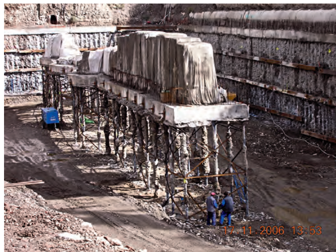
Figura 46. RECALCE PROVISIONAL DE UN ELEMENTO HISTÓRICO EN EL APARCAMIENTO DEL VIOLÓN, EN GRANADA (gentileza de SITE).
