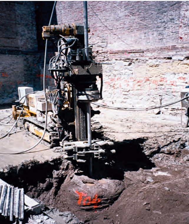
Figura 15. REPERFORACIÓN DE UNA COLUMNA DE PRUEBA.
