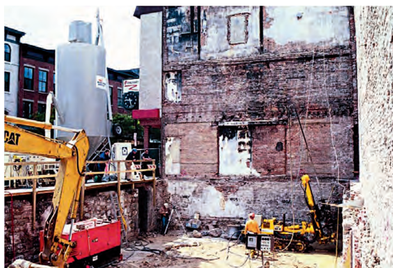
Figura 6. VISTA GENERAL DE LA EJECUCIÓN DEL JET-GROUTING .
