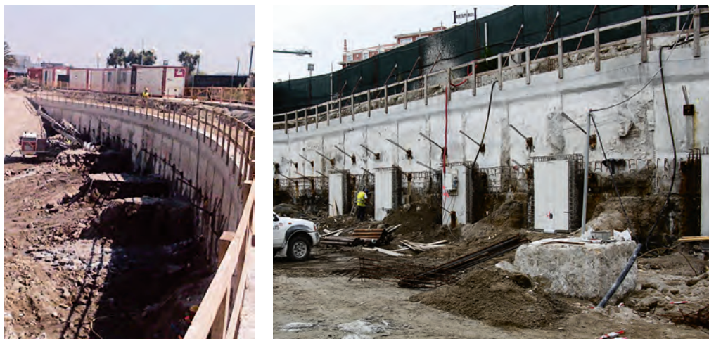
Figuras 28 y 29. COMACCHIO 800 EJECUTANDO ANCLAJES ENTRE BATACHES: EXCAVACIÓN EN SECO Y DETALLE DE CONSTRUCCIÓN DE MURO EN ESCAMAS.
