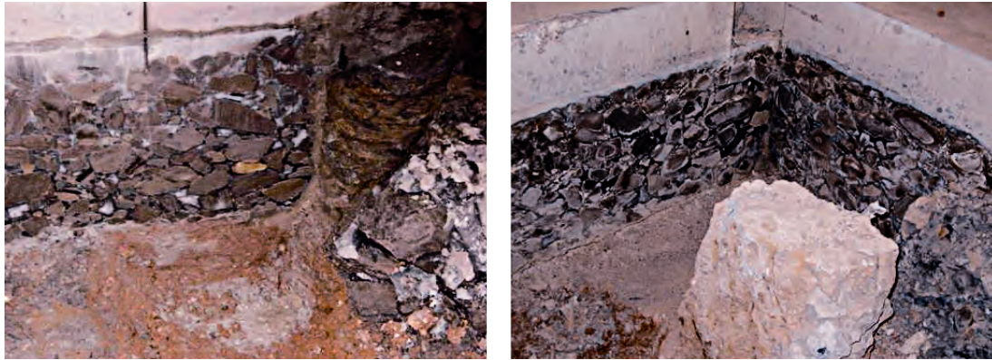
Figura 6. RELLENO DE HUECOS EN CONTACTO SOLERA-ENCACHADO.
