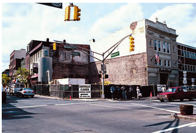
Figura 2. VISTA DEL SITIO DE LA OBRA DESPUÉS DE LA DEMOLICIÓN DEL EDIFICIO EXISTENTE.
