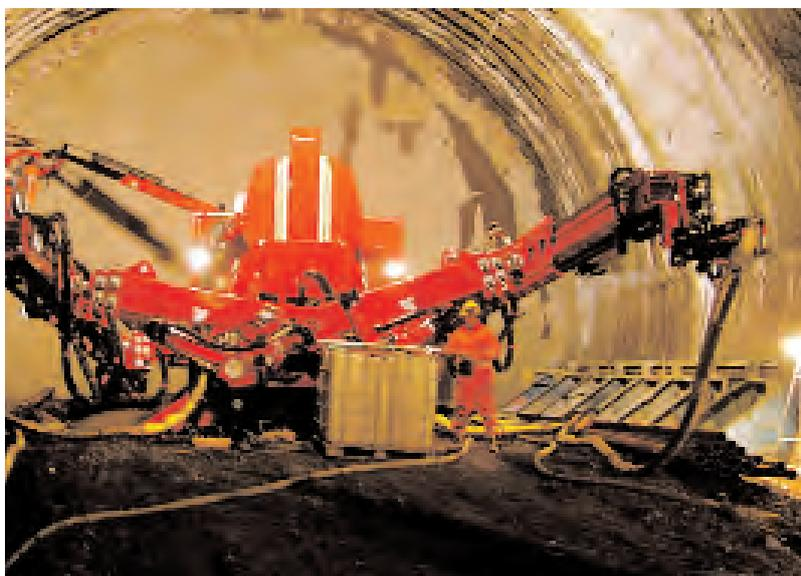
Figura 18. ACTUACIONES DE PRECONFINAMIENTO DEL NUCLEO: EQUIPO DE PERFORACIÓN TIPO EGT TD 8200.
