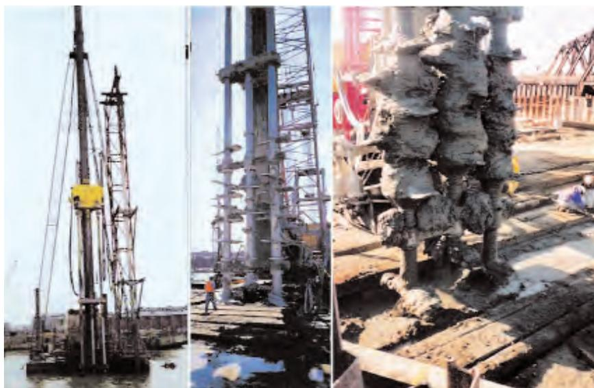
Figura 30. MAQUINARIA DE DEEP-MIXING Y ASPECTO DE LAS BARRENAS MEZCLADORAS.
