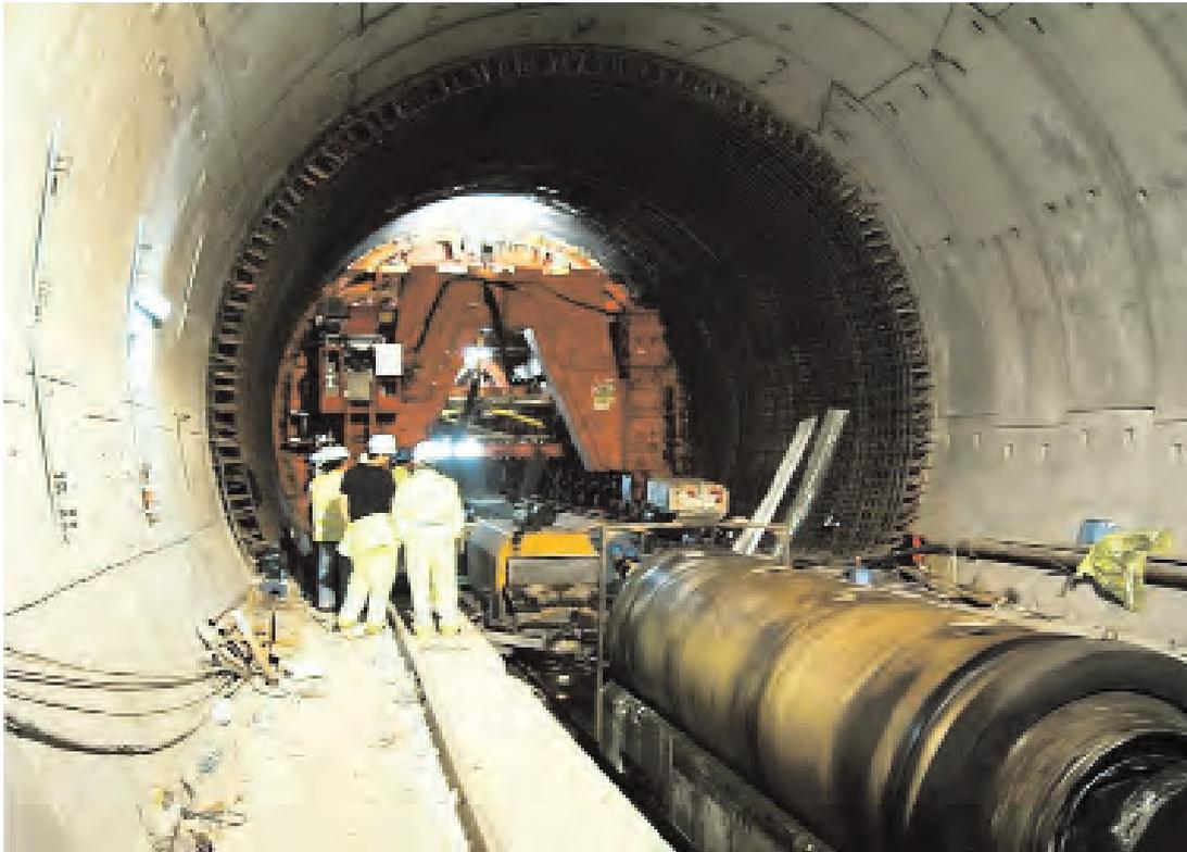
Foto 2. CONSTRUCCIÓN DEL ANILLO DE REFUERZO.
