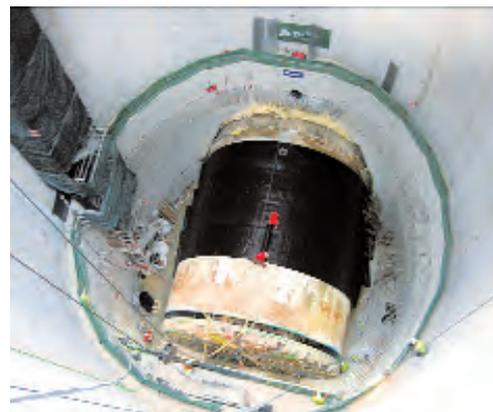
Figura 27. TRABAJOS DE MANTENIMIENTO DE LA TUNELADORA UNA VEZ EJECUTADO EL POZO.
