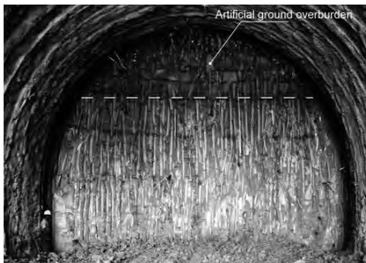
Figure 6. BORGO RINZELLI TUNNEL: THE FACE DURING THE ADVANCE UNDER ARTIFICIAL GROUND OVERBURDEN.
