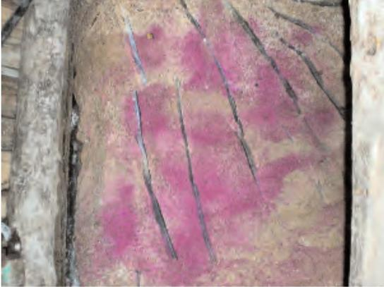
**Figura 8. DISTRIBUCION IRREGULAR DE LA IMPREGNACION CON SILICATOS. (Se ha utilizado un reactivo para colorear las zonas inyectadas.)**
