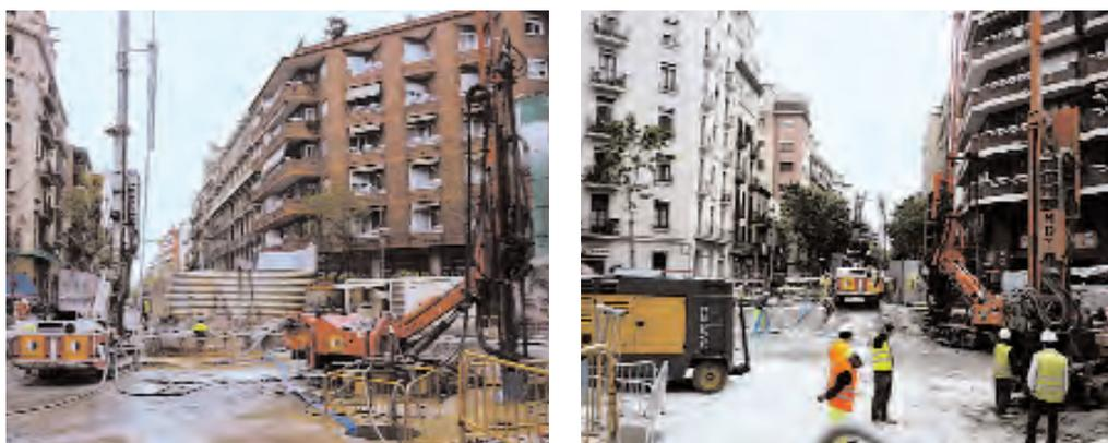
Figuras 21 y 22. EQUIPOS DE PERFORACION Y REALIZACION DE SUPERJET-GROUTING TRABAJANDO SIMULTANEAMENTE.
