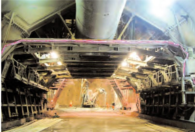
Figura 19. REALIZACION DEL REVESTIMIENTO DEFINITIVO MEDIANTE CAROS DE ENCOFRADO.
