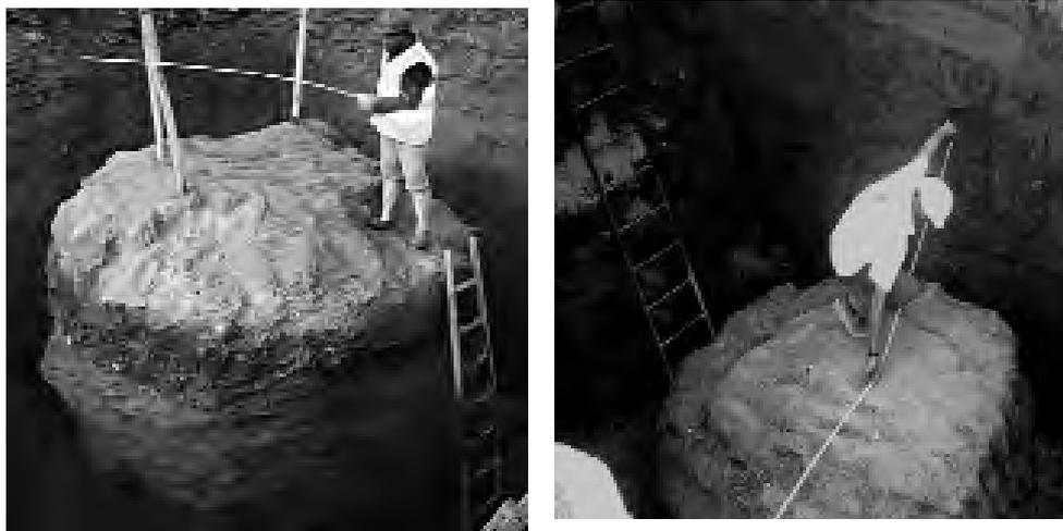
Figura 8. COLUMNAS DE SUPERJET-GROUTING DE DIAMETRO > 3 m: CAMPOS DE PRUEBA DE KELLERTERRA.
