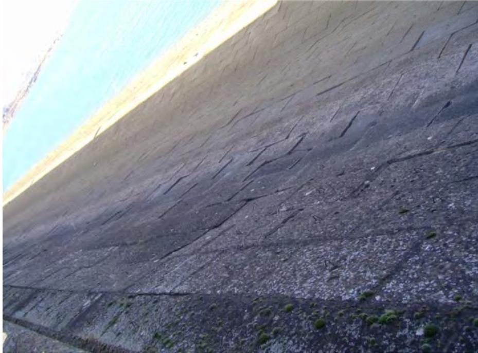
**Figura 9.- Vista del paramento de aguas arriba. Año 2001. “Abombado” en la parte inferior**
