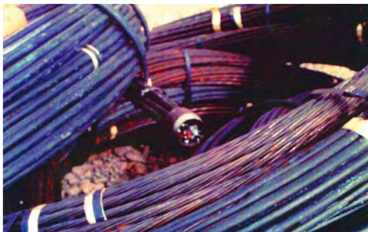
Figura 5. TIRANTES APILADOS ANTES DE LA COLOCACIÓN
