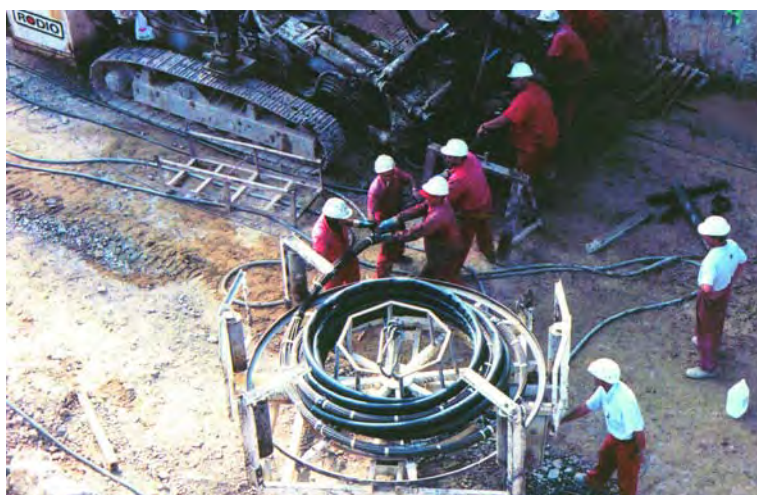
Figura 6. INSTALACIÓN DE LOS TIRANTES
