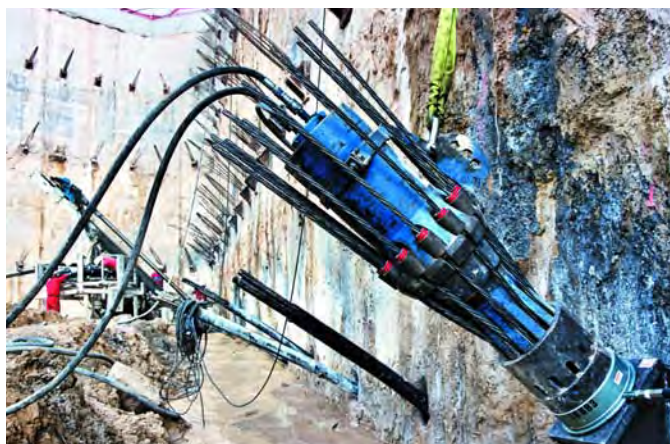
Figura 7. GATO DE TESADO MULTIFILAR
