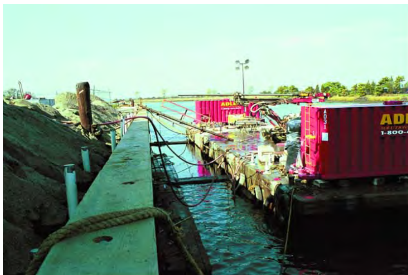
Figura 14. VISTA PONTONA CON TANQUES AUXILIARES PARA LASTRADO
