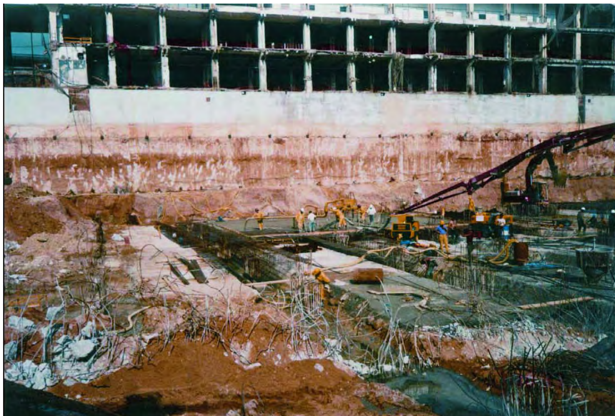
Figura 2. VISTA GENERAL DE UNA PANTALLA CON ANCLAJES PROVISIONALES, CONSTRUIDOS BAJO EL NIVEL FREÁTICO
