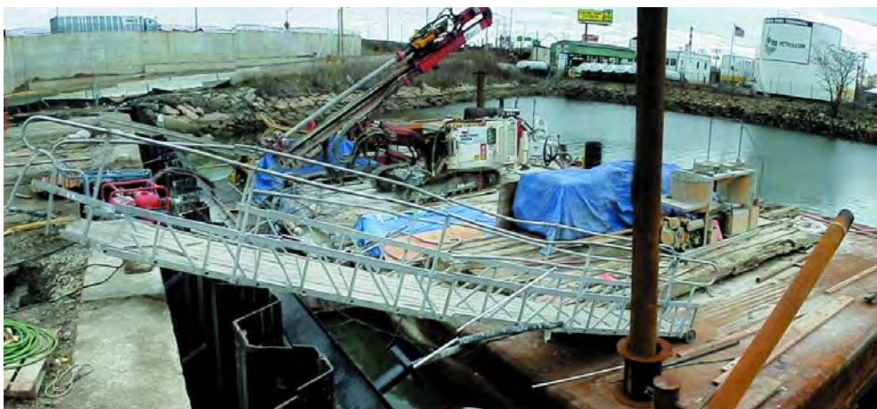
Figura 10. VISTA GENERAL DE LA OBRA (Nótese el sistema de fijación con tubos pasantes en las esquinas)
