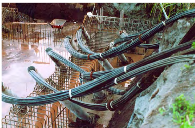
Figura 4. VISTA DE LOS TENDONES DE ANCLAJE COLOCADOS EN LA PERFORACIÓN
