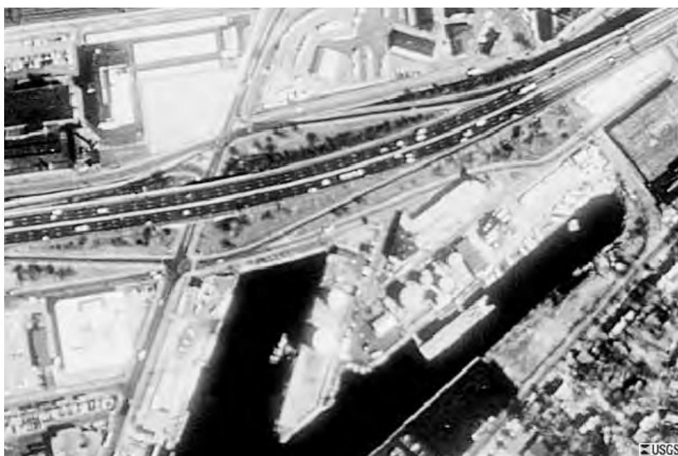
Figura 2. VISTA AÉREA DE LA ZONA DE OBRA
