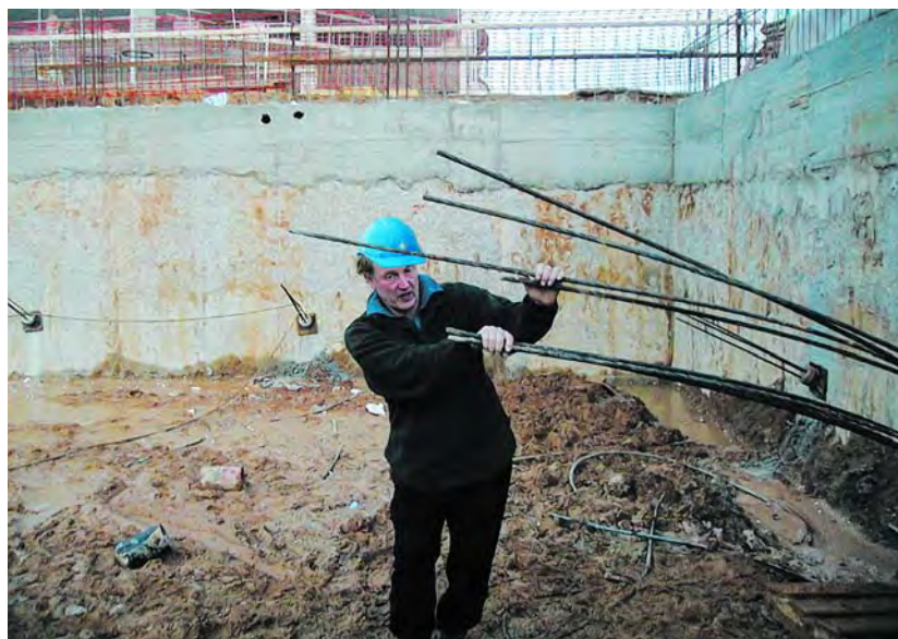
Foto 4. TONY BARLEY SOSTENIENDO LA UNIDAD DE ANCLAJE EXTRAÍBLE RETIRADA PARCIALMENTE
