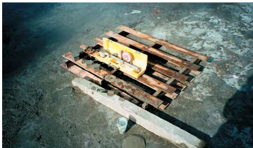
Figura 21. DETALLE DE BALANZA DE LODOS PARA EL CONTROL DE DENSIDAD DE LAS LECHADAS
