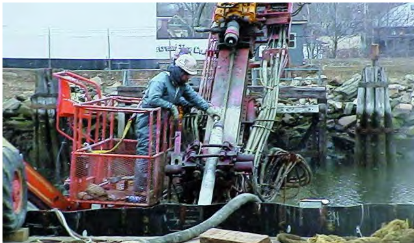
Figura 19. DETALLE TRABAJO DE OPERARIOS CON MONOS Y GUANTES ESPECIALES DE PROTECCIÓN
