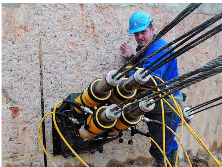
Foto 1. MONTAJE UTILIZADO EN SEVILLA PARA ANCLAJE DE BULBO MÚLTIPLE DE CUATRO UNIDADES
