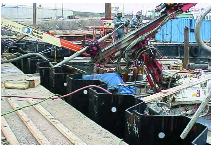
Figura15. TRABAJOS DESDE CESTA CON MAREA BAJA
