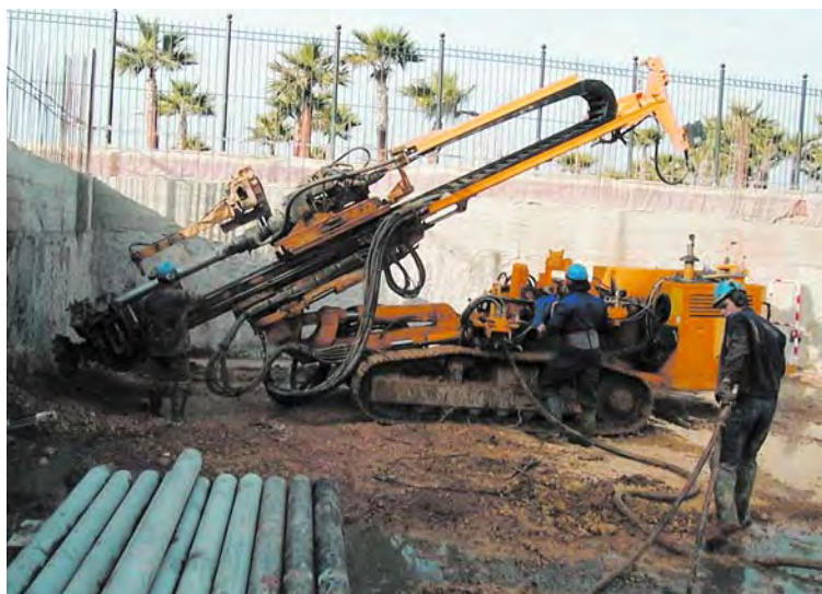
Foto 2 EJECUCIÓN DEL ANCLAJE DE PRUEBA TA1
