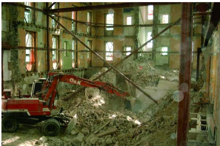
Foto 9. DEMOLICIÓN Y RETIRADA DE ESCOMBROS COEXISTIENDO CON LOS APUNTALAMIENTOS.
