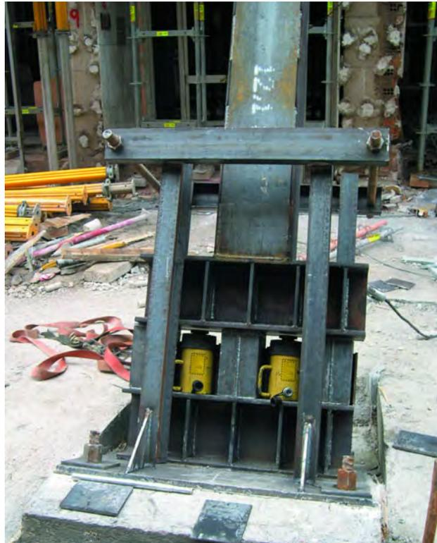
**Figura 27. DETALLE DEL SISTEMA DE GATOS COLOCADOS EN LOS APOYOS DE LOS JABALCONES.**
