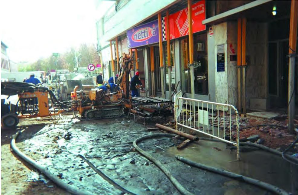
**Figura 24. EJECUCIÓN DE LOS TALADROS DE INYECCIÓN JUNTO A LA FACHADA DEL EDIFICIO.**
