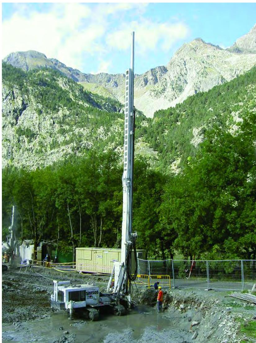
**Foto 22. EQUIPOS DE ALTO RENDIMIENTO QUE MINIMIZAN LOS CAMBIOS DE BARRAS
