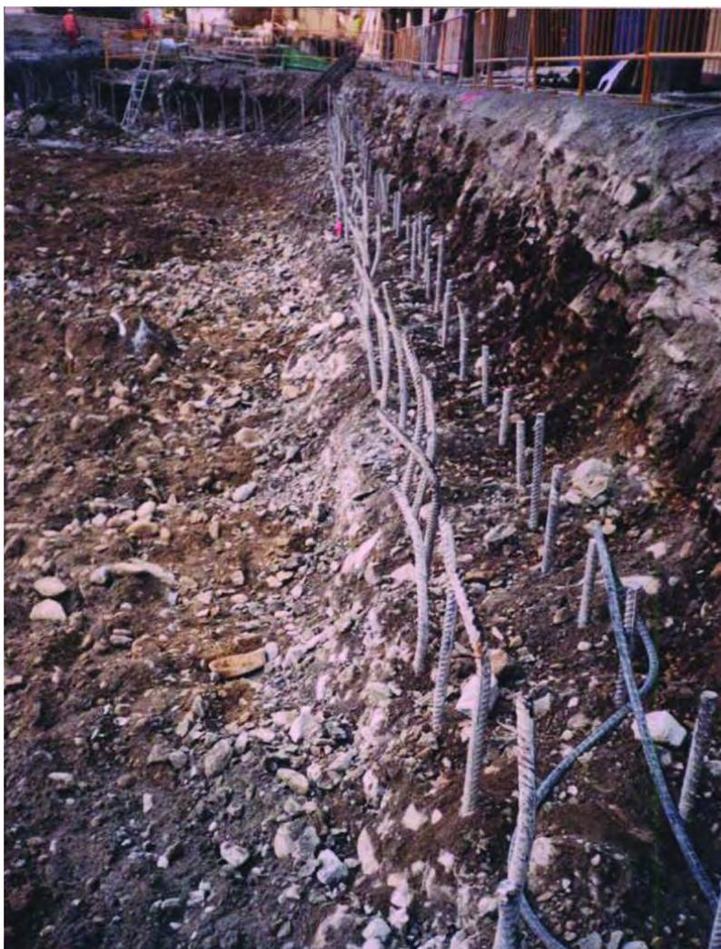
Fotos 24 y 25. VISTA DE LAS ESPERAS PENDIENTES DE LA EJECUCIÓN DE LA VIGA DE ATADO.
