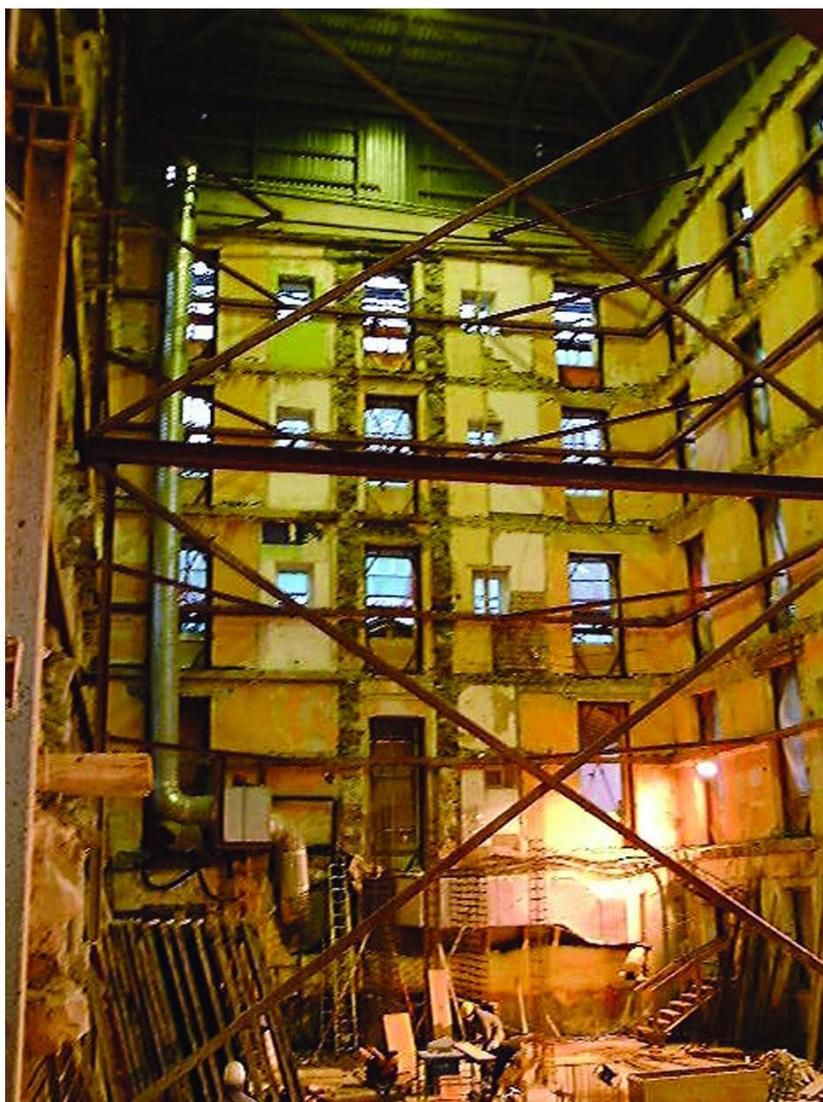
**Foto 11. FINALIZADA LA DEMOLICIÓN Y EL RECRECIDO DE LA NUEVA PLANTA SUPERIOR, CON NUEVA CUBIERTA, SE INICIAN LOS TRABAJOS DE SUBSUELO.**
