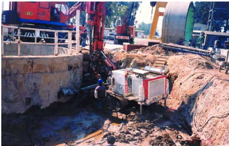
Foto 43. VISTA DE LA EJECUCIÓN DEL TRATAMIENTO DE *BREAK OUT* JUNTO AL POZO.
