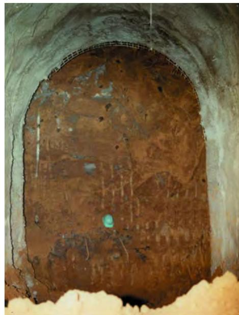
Figura 10. FRENTES DE LA EXCAVACIÓN, DESPUÉS DEL TRATAMIENTO CON MICROSOL.
