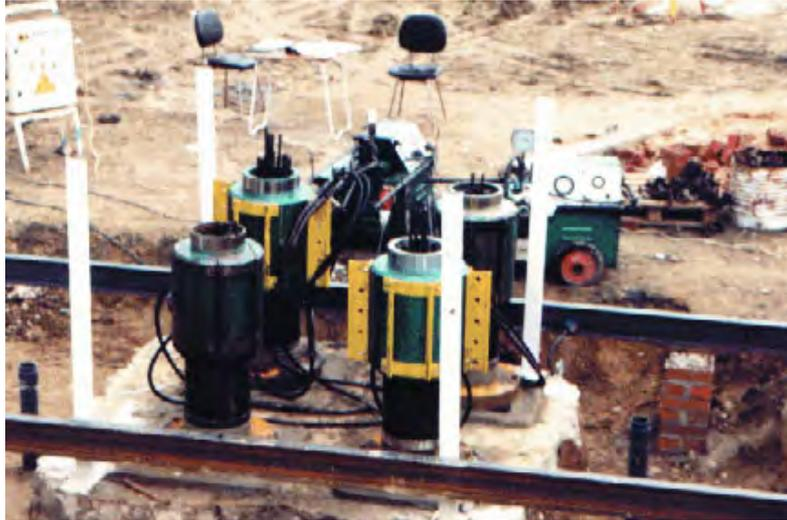
Figura 16. ANCLAJES Y GATOS DE 200T UTILIZADOS EN LAS PRUEBAS DE CARGA SOBRE ZAPATAS.
