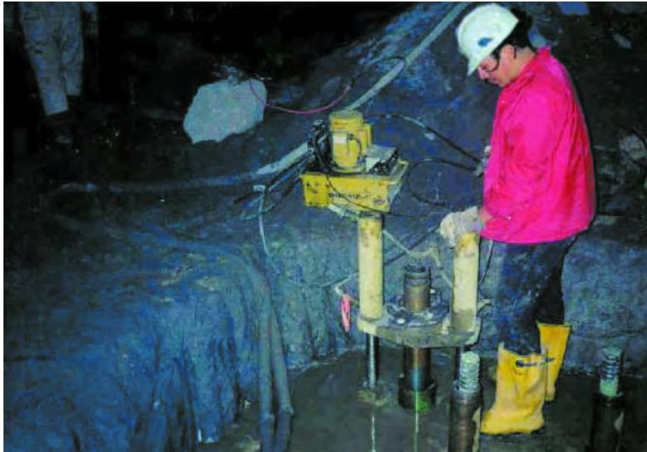
Figura 13. EXTRACCIÓN TUBERÍA DE INYECCIÓN CON GATOS (Armijo,1997).
