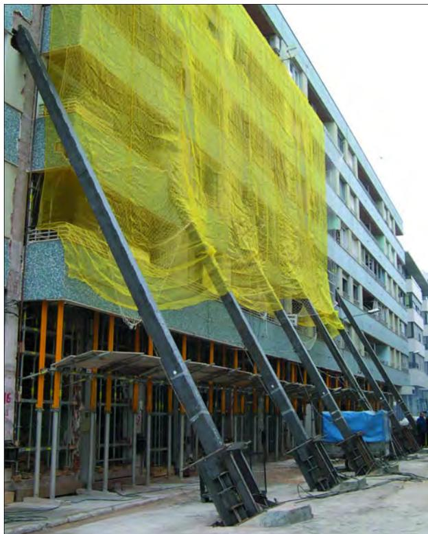
Figura 26. APEO "ACTIVO" INSTALADO EN LA FACHADA DEL EDIFICIO.
