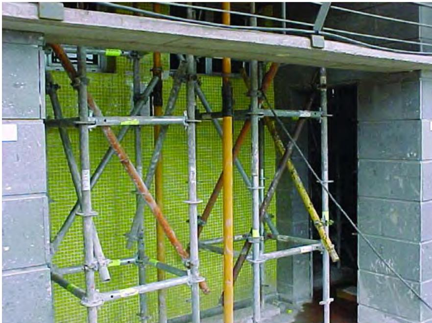
**Foto 31. APUNTALADO INTERIOR ENTRE LA LOSA BASE Y LA DE CUBIERTA.**
