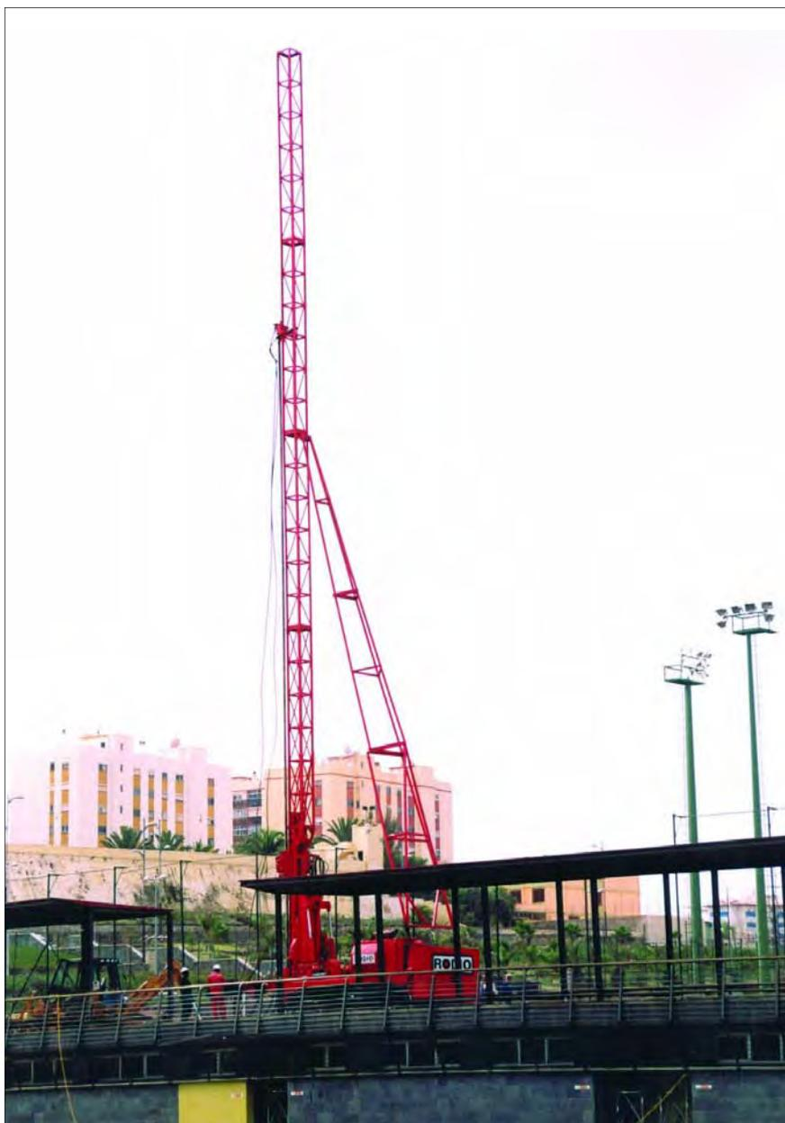
**Foto 32. SONDA CAPAZ DE REALIZAR COLUMNAS DE JET DE 30 m SIN CAMBIO DE BARRAS EMPLAZADA SOBRE LA CUBIERTA APUNTALADA PARA EL RECALCE.**
