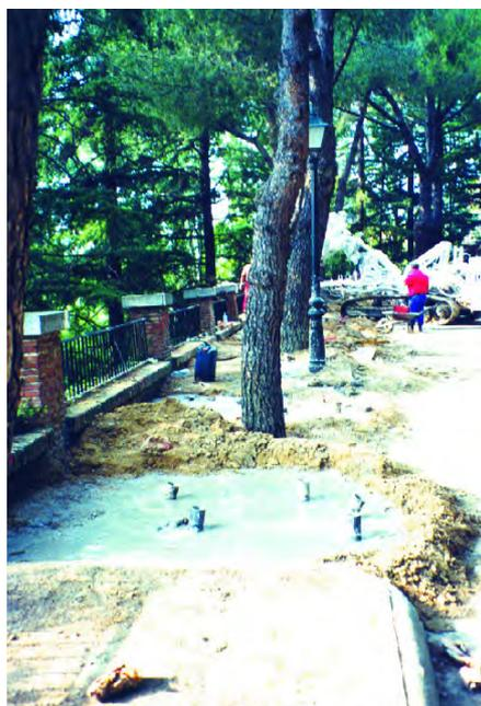
**Figura 19. ESTABILIZACIÓN DE UN MURO DE ACCESO AL PALACIO DE LA MONCLOA (Martínez, 1998a).**
