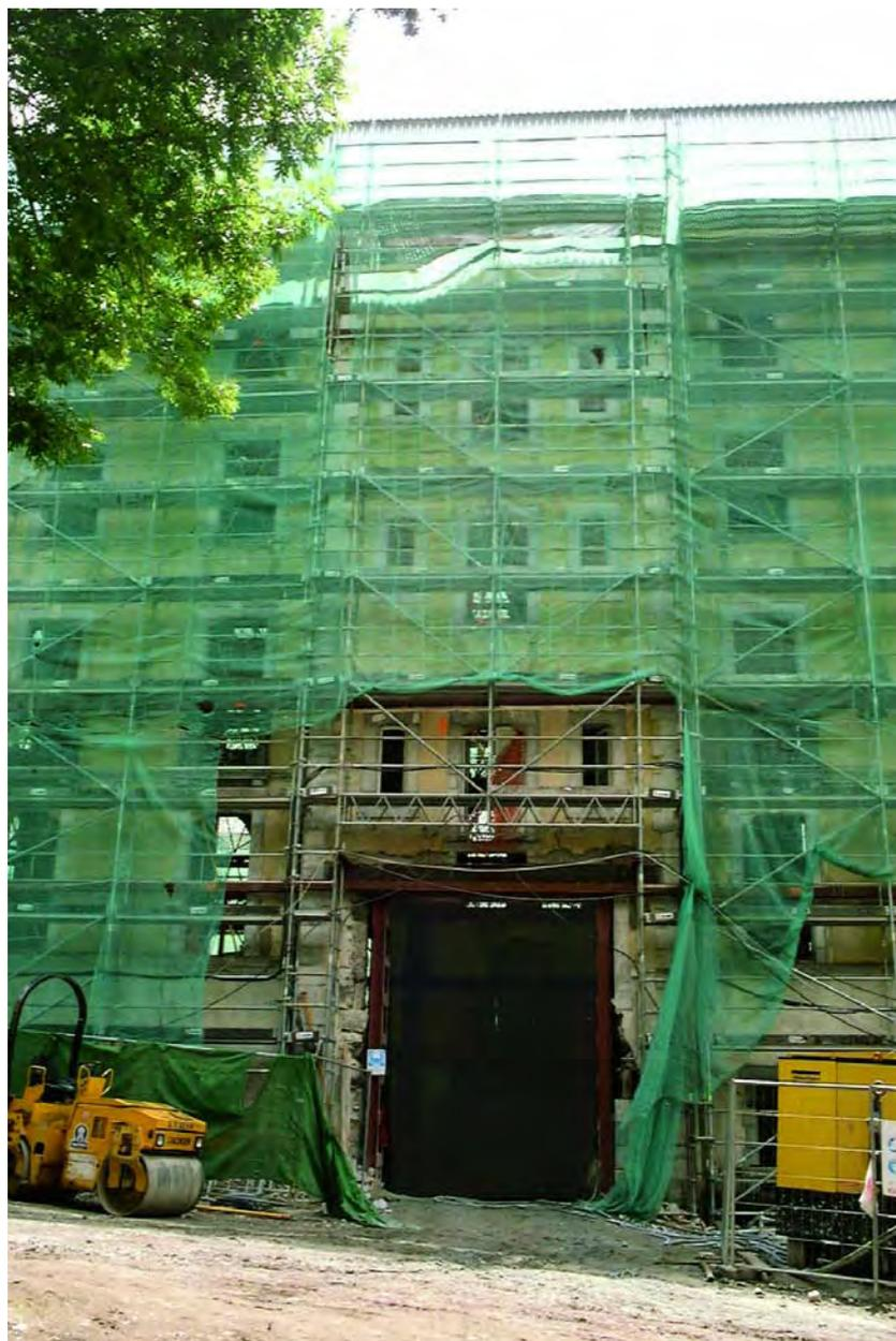
Foto 8. OTRA VISTA DEL EXTERIOR APUNTALADO Y DEL ACCESO AMPLIADO PARA MAQUINARIA PESADA.
