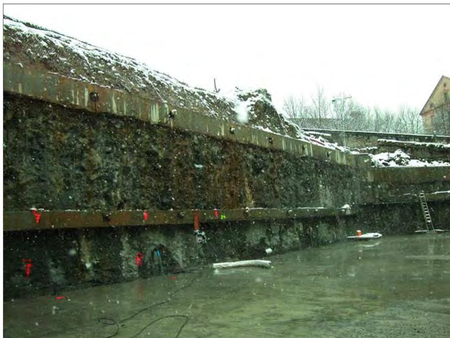
Foto. 45. VISTA DE DETALLE DE LA PANTALLA EN SU MÁXIMA EXCAVACIÓN.
