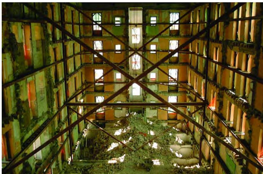
**Foto 12. CONSIDÉRESE LA ELEVADA EFECTIVIDAD DEL APUNTALAMIENTO EXTERIOR E INTERIOR TRABAJANDO CONJUNTAMENTE, NECESARIOS PARA PERMITIR LA POSTERIOR OPERACIÓN DE RECALCE Y EXCAVACIÓN.**
