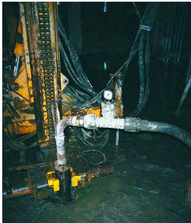
**Figura 25. INYECCIÓN DE MORTERO “SECO” LEVANTANDO LA TUBERÍA POR TRAMOS DE 0.5 m.**
