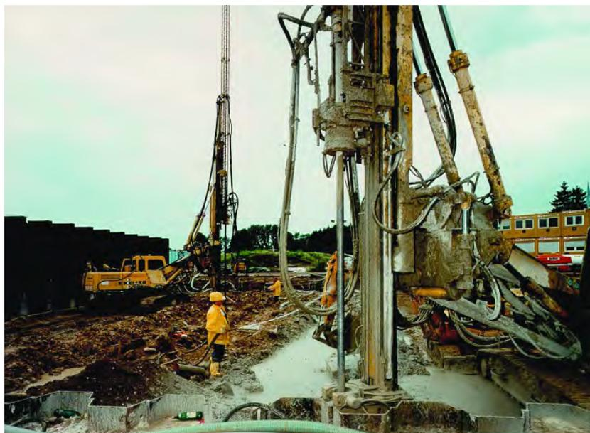
**Foto No. 2. EQUIPOS EJECUTANDO TRABAJOS DE SUPERJET-GROUTING.**
