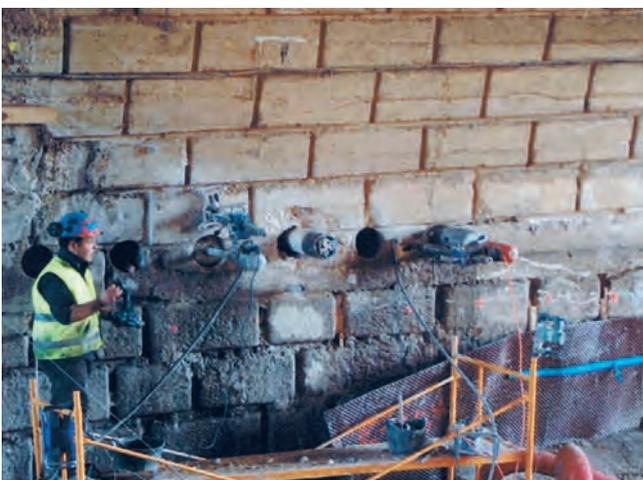
**Foto 11. EMBOQUILLE A ROTACIÓN Y SALIDA DE MANIOBRA.**
