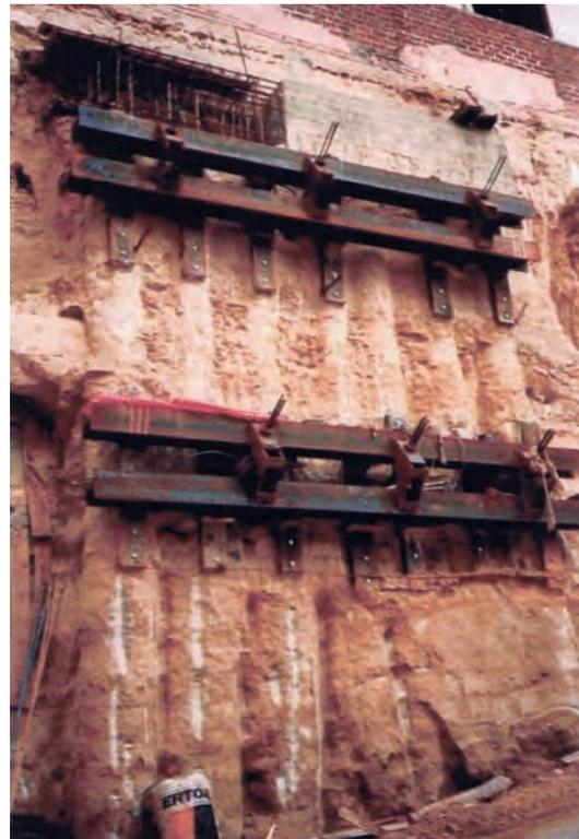
Figura 18. PANTALLA DE PILOTES CON DOS NIVELES DE ANCLAJES PROVISIONALES.
