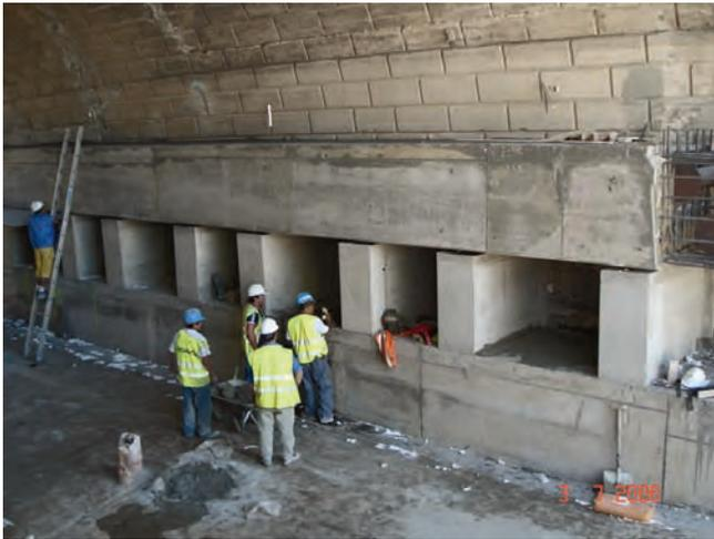
Figura 37. NICHOS PARA GATOS HIDRÁULICOS ENTRE LAS VIGAS QUE ENCEPAN MICROPILOTES HORIZONTALES (superior) Y VERTICALES (inferior) BAJO EL PUENTE DE SEGOVIA.
