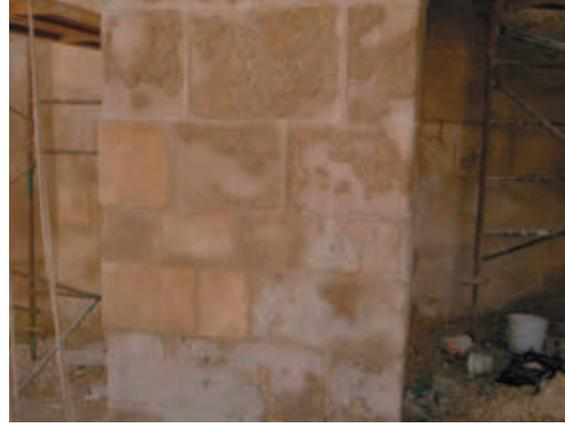
Un material clásico en las construcciones históricas, como es el mortero de cal, es perfecto para realizar «empastes» en un nivel algo rebajado de los sillares deteriorados y erosionados.
