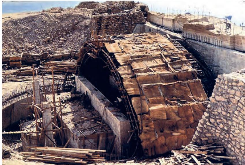
Figura 28. ARCO DE HORMIGÓN ARMADO PARA SOSTENER LA CAVERNA ARTIFICIAL DE LOS ACTUALES TEMPLOS DE ABU-SIMBEL.
