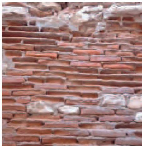
En las fotografías superiores se muestra el efecto que produce sobre una fábrica tradicional de ladrillo con mortero de cal, sometida a un flujo de agua trasero en su contención de tierras: el rejuntado con mortero de cemento mucho más rígido e impermeable provoca que el «material de sacrificio» pase a ser el ladrillo en vez del mortero.
