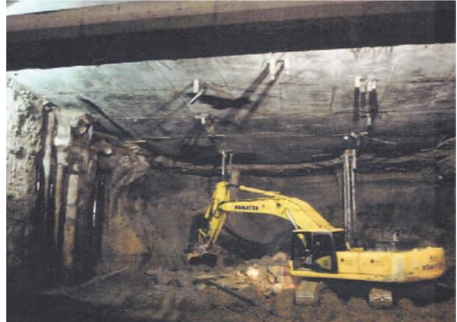
Foto 18. EXCAVACIÓN BAJO LA PILA.
