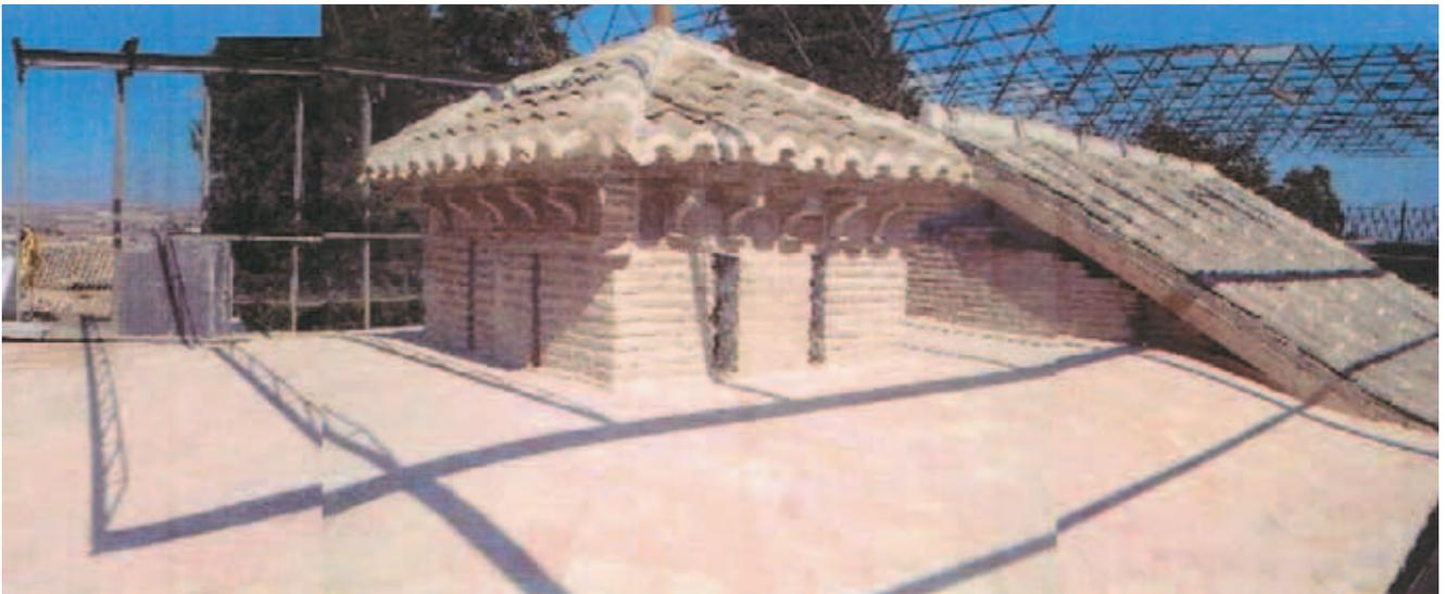
La cubierta recién concluida con la linterna central restaurada. Las cubiertas manifiestan en el corte la ampliación cristiana del ábside mudéjar adosado dos siglos después de la construcción de la mezquita.
