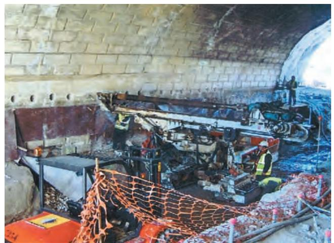
**Foto 12. PERFORACIÓN DE MICROPILOTES HORIZONTALES.**
