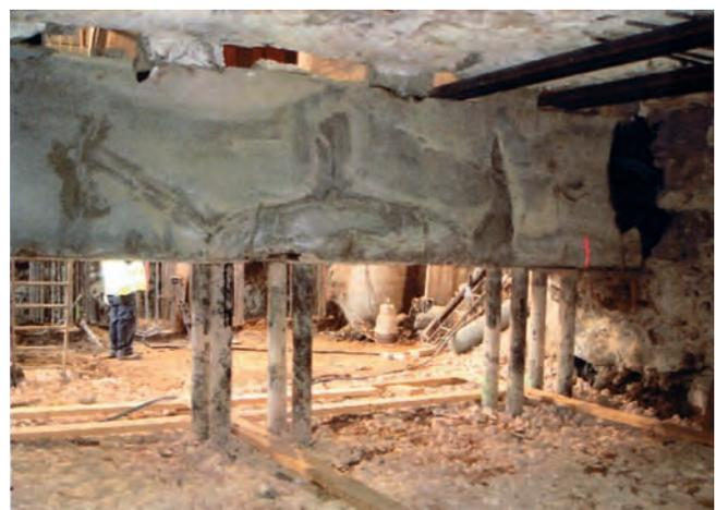
Foto 16. EXCAVACIÓN DE LAS GALERÍAS TRANSVERSALES.
