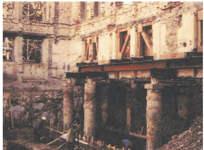
Figura 11. PROLONGACIÓN DE MURO MEDIANTE APEO CON PILOTES Y VIGAS-AGUJA PASANTES.
