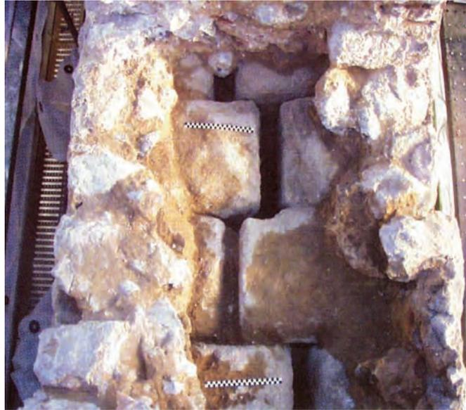
Figura 31. AL LEVANTAR LA CACERA SUPERIOR SE PUEDE APRECIAR LA TENDENCIA A ABRIRSE EN DOS HOJAS DE LOS ARCOS SUPERIORES. (Esta grieta de 10 cm data casi del siglo XV.) (Tomado de F. Jurado, *Revista de O.P. Ing. y Territorio*, núm. 57, 2001.)
