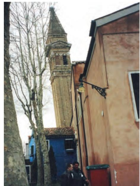
Figura 11. TORRE INCLINADA POR ASIENTOS EN MURANO (Italia).
