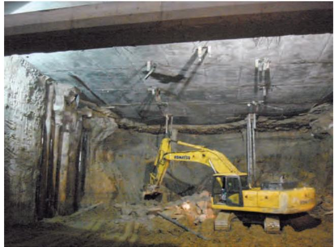
Figura 38. EXCAVACIÓN BAJO PILA DEL PUENTE DE SEGOVIA, CON CORTE DE MICROPILOTES.
