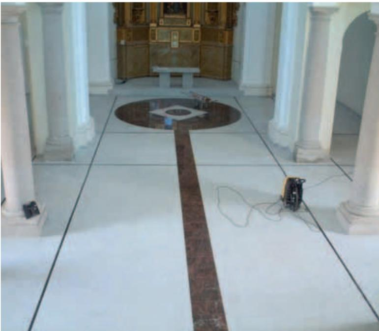
En la rehabilitación del interior se proyecta un nuevo pavimento de granito colocado sobre una solera de hormigón con calefacción mediante tubos de agua para suelo radiante.
