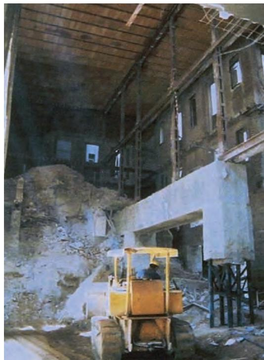
Figuras 24 y 25. DESCARNADO DE MICROPILOTES Y SU INCLUSIÓN EN LOS PILARES DEFINITIVOS, Y PROGRESO DE LA CONSTRUCCIÓN DE LOS SÓTANOS.
