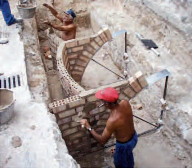
El ladrillo permite, además de su manejabilidad, que las bóvedas verticales sean permeables al paso del agua que presione el trasdós.
