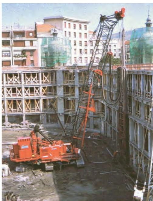
**Figura 12. PERFORACIÓN CON HIDROFRESA.**
