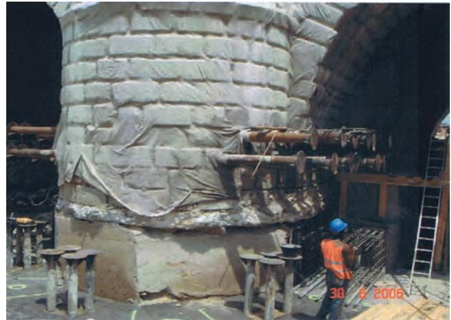
Foto 14. PREPARACIÓN DE LAS VIGAS CORREDERAS SUPERIOR E INFERIOR.
