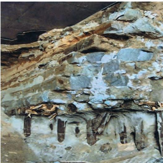
Foto 20. PERFORACIÓN A TRAVÉS DEL ENCEPADO DEL PUENTE.
