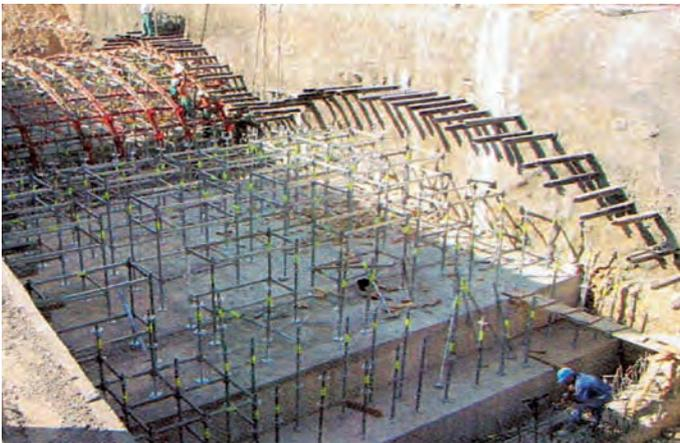
Foto 8. PLATAFORMA DE HORMIGÓN DE SOPORTE DE CIMBRADO.
