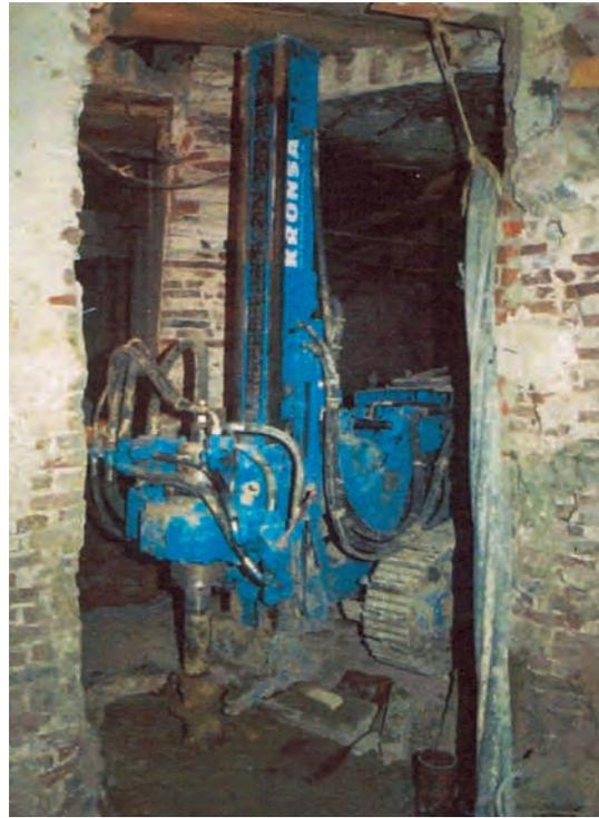
Figura 23. EQUIPO DE EJECUCIÓN DE MICROPILOTES.
