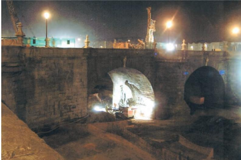
Foto 22. EJECUCIÓN DE CORTINAS DE MICROPILOTES DESDE TABLERO Y BAJO GÁLIBO.
