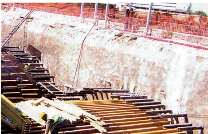
**Foto 4. COSIDO DE BULONES Y GUNITADO DE PARAMENTOS.**
