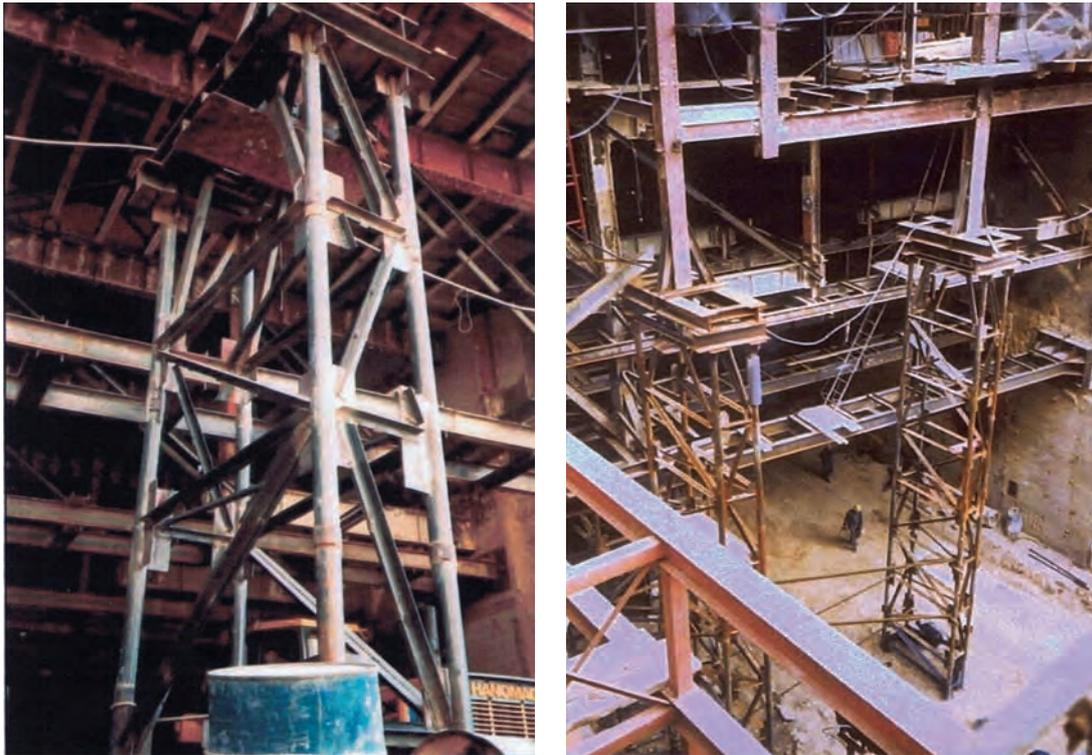
**Figuras 19 y 20. DOS ASPECTOS DEL RECALCE DE PILARES MEDIANTE GRUPOS DE CUATRO PILOTES.**
