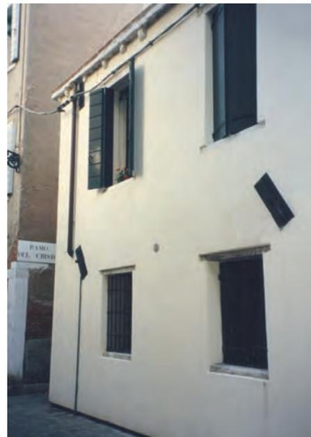
Figura 13. LLAVES DE FUNDICIÓN EN EDIFICIO CON Poca RIGIDEZ HORIZONTAL.
