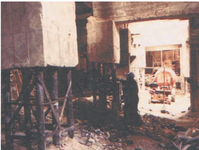
Figura 10. PILARES DESCENDENTES ENGLOBANDO LOS MICROPILOTES DE PROLONGACIÓN DE LA ESTRUCTURA (Paseo de la Castellana, 6. Madrid).
