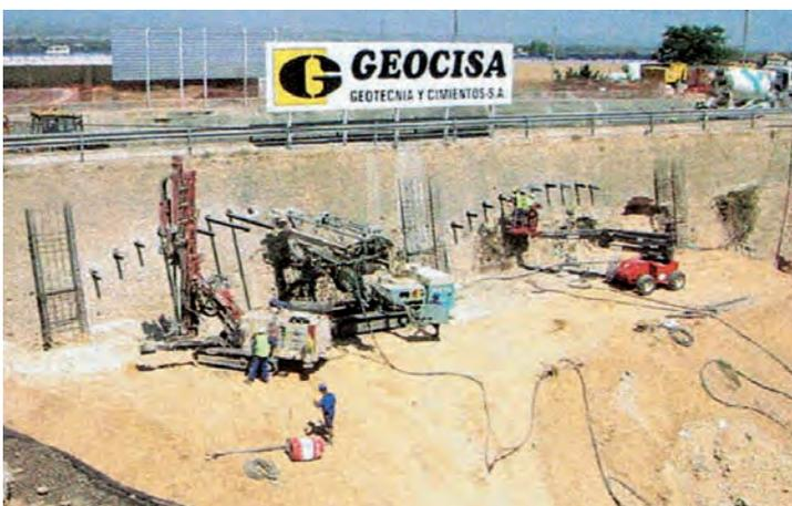
Foto 6. EJECUCIÓN DE PARAGUAS MICROPILOTES.
