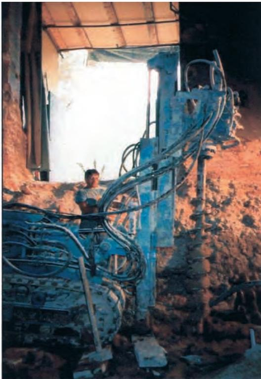
Figura 17. EJECUCIÓN DE MICROPILOTES EN EL INTERIOR DEL EDIFICIO.
