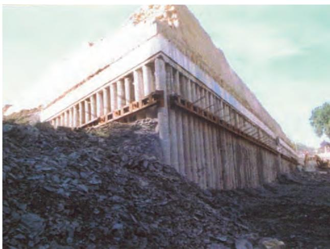
Figura 5. PRIMER PLANO DE LA PANTALLA CON ANCLAJES PROVISIONALES, EN LA ZONA DEL BALUARTE.
