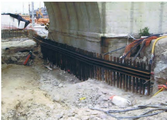
Foto 24. SUPLEMENTO DE ARMADURA POR ENCIMA DE LA PLATAFORMA Y CONEXIÓN A LOSA.
