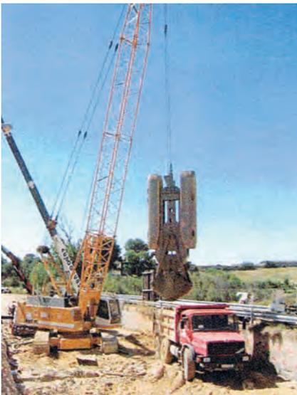
Foto. 2. EJECUCIÓN DE MUROS-PANTALLA.
