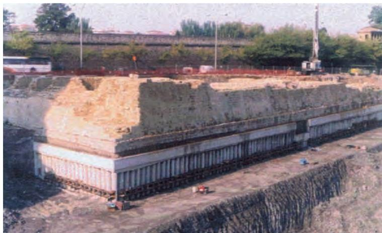
Figura 4. PANTALLAS DE PILOTES EN LA ZONA DEL BALUARTE.
