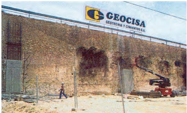
Foto 5. CONSTRUCCIÓN DE LAS PILAS DEL MARCO.
