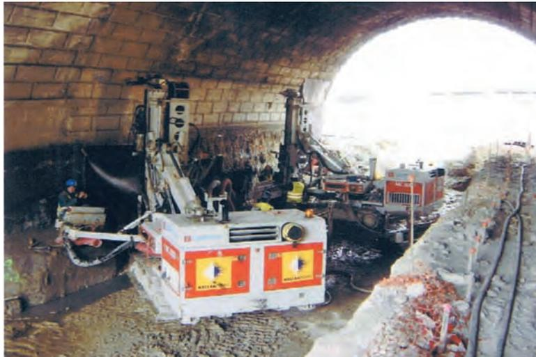
Foto 9. EJECUCIÓN DE MICROPILOTES VERTICALES.
