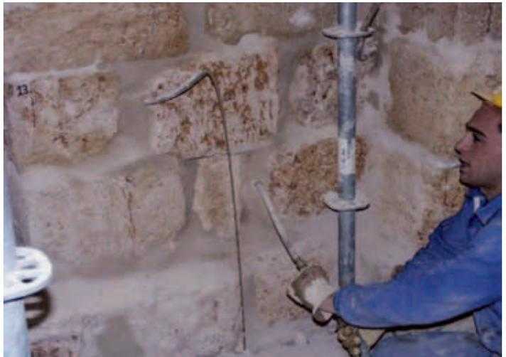
A medida que la cal llegaba a las zonas disgregadas, los movimientos monitorizados se reducían hasta la total estabilización (ver gráficos inferiores).
