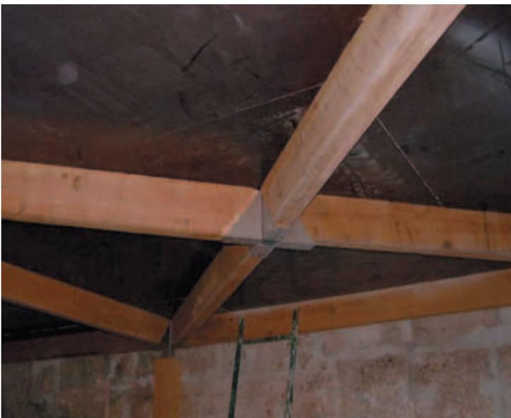
Nervios de madera reproduciendo la proyección de las bóvedas góticas inferiores, formando la estructura portante junto con tableros fenólicos. Sobre ellos, directamente un pavimento de ladrillo en seco.
