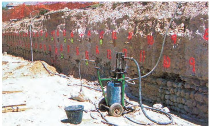
**Foto 3. CONSOLIDACIÓN DE MUROS.**
