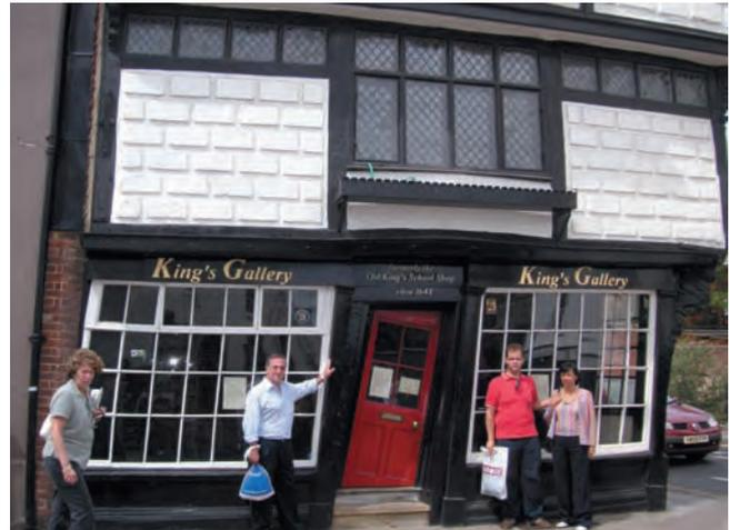
Figura 9. ASIENTOS Y DEFORMACIONES TANGENCIALES EN UN EDIFICIO TUDOR EN CANTERBURY (U.K.).
