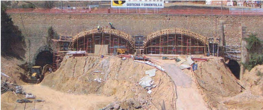
Foto 7. CIMBRADO Y ARMADO DE LA BÓVEDA DEL MARCO EXTERIOR.
