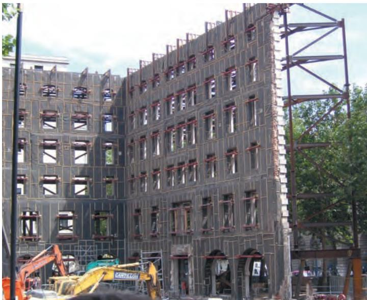
Figura 32. REHABILITACIÓN DE UN EDIFICIO DEL SIGLO XIX EN LONDRES, CONSERVANDO FACHADAS.
