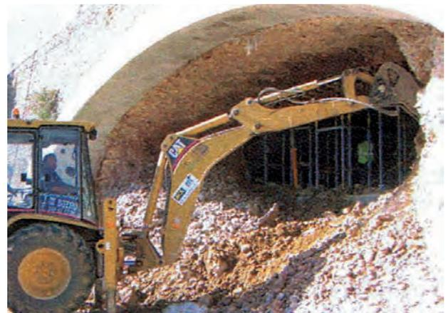
Foto 11. EXCAVACIÓN BAJO BÓVEDAS.
