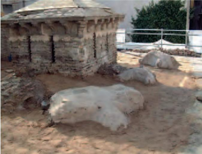
Reparación con yeso de las bóvedas partidas y relleno con arcilla y cal hasta conseguir de nuevo el perfil original de la cubierta.
