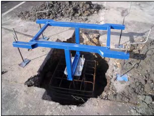
Figura 33.- Colocación de la mesa centradora
