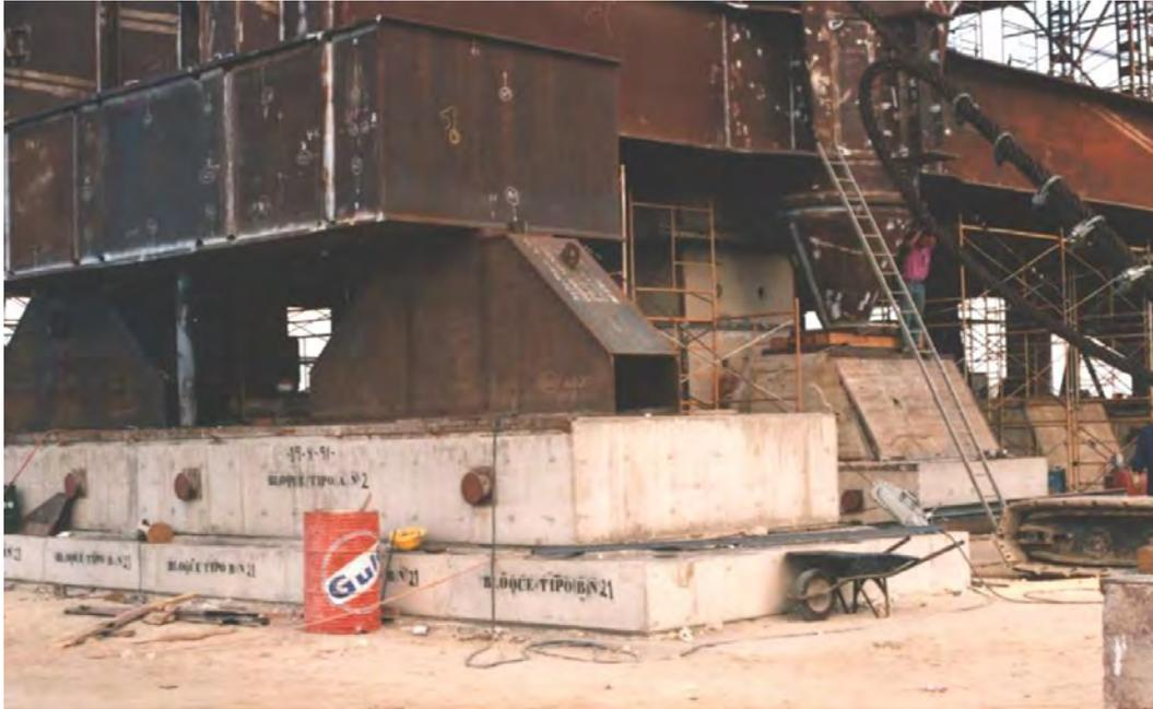
Figura 8. Detalle cimentación con bloques de hormigón
