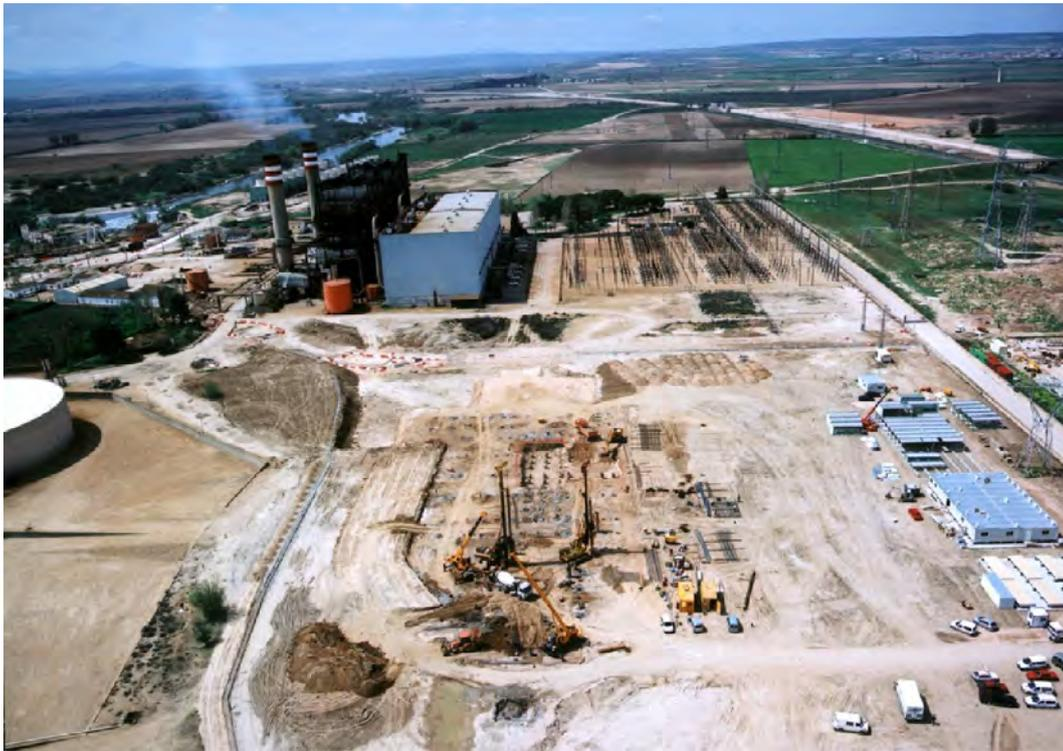
Figura 2.- Construcción de la cimentación de central de ciclo combinado junto a otra existente previamente en Villaseca (Toledo).
