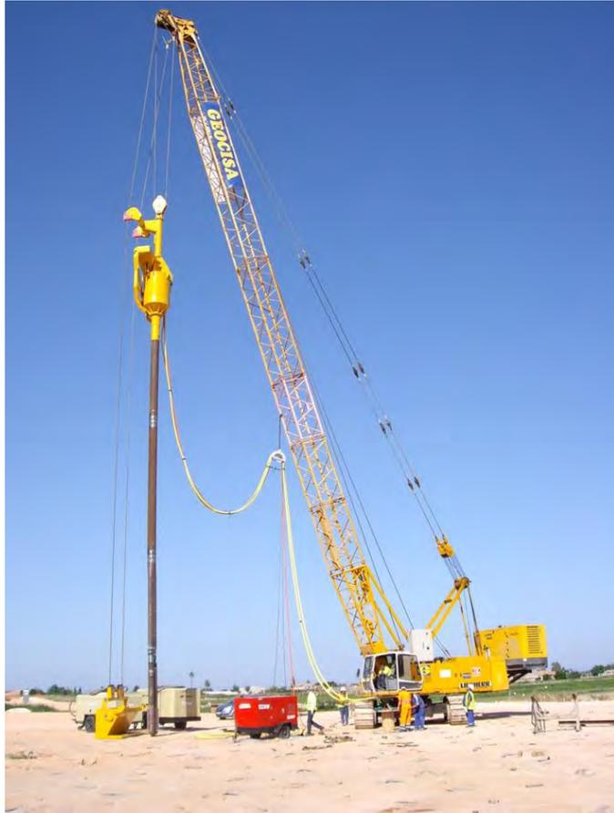
Figura 17. Ejecución de columnas de grava por vía “seca”, con alimentación por el fondo
