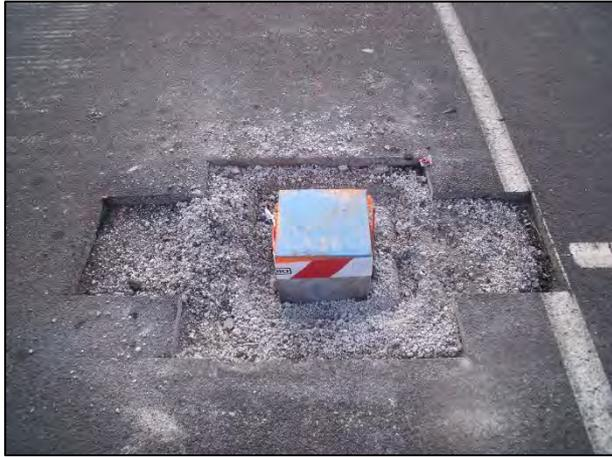
Figura 31.- Pilote hincado y listo para descabezar
