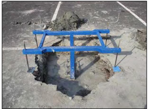
Figura 34.- Encepado hormigonado y con pernos
