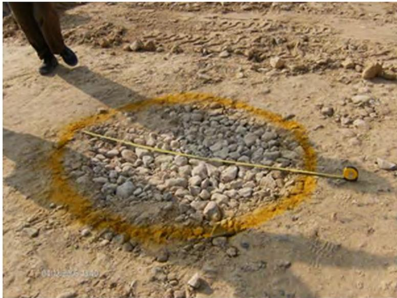
Figura 22. Control del diámetro de una columna de grava
