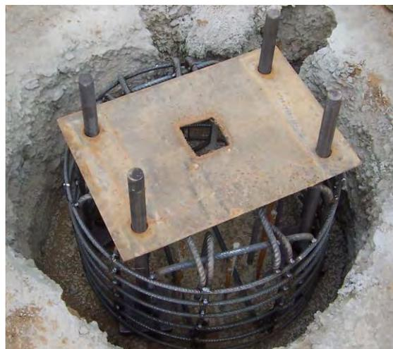
**Figura n° 29: Plantilla de las ejecuciones iniciales de campos solares**
