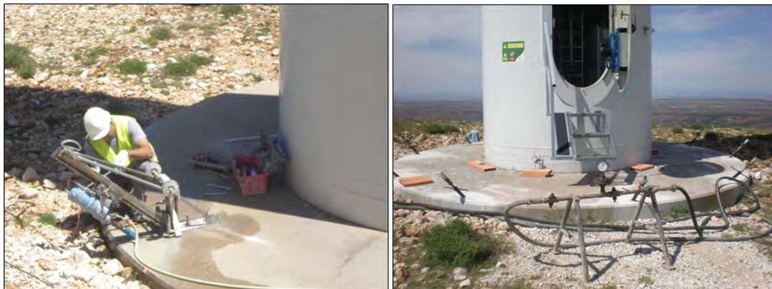
Figura 16. RECALCE Y REPARACIÓN DE CIMENTACIÓN DE AEROGENERADOR. PARQUE EÓLICO GRADO, SORIA – ESPAÑA (2004).
