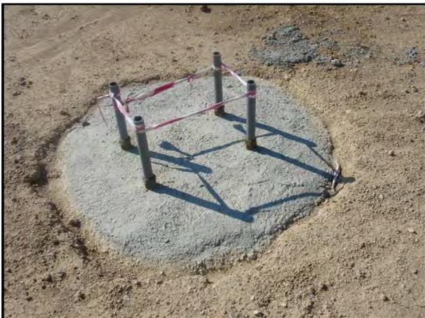
Figura 18.- Los pernos, después de retirada la mesa
