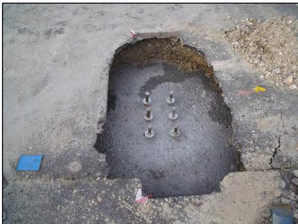
Figura 35.- Detalle de los pernos colocados
