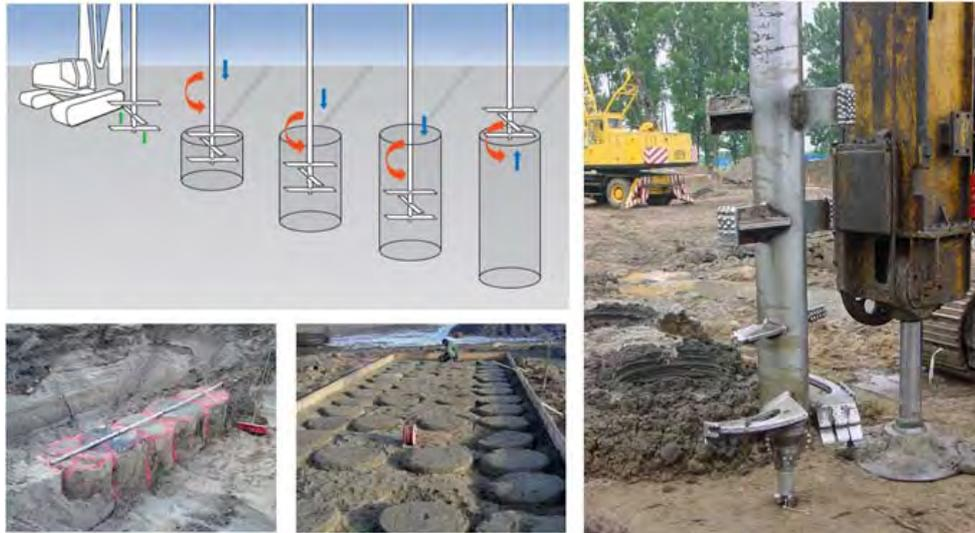
Figura 25: EFECTOS DE LAS TÉCNICAS DE INYECCIÓN EN EL SUELO.
