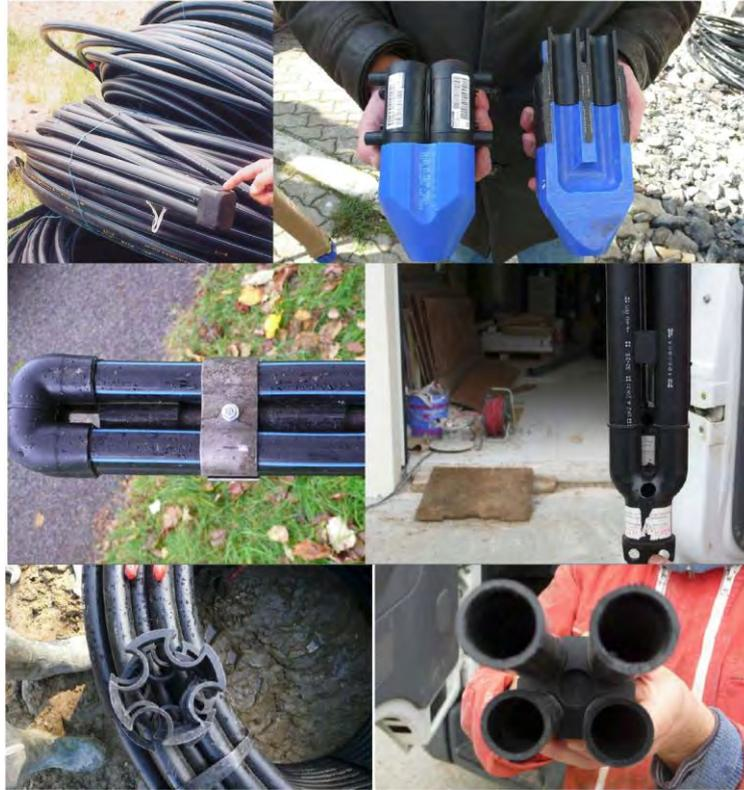
**Foto 6. Pies de sondas geotérmicas y espaciadores. (Fuente: BRGM).**
