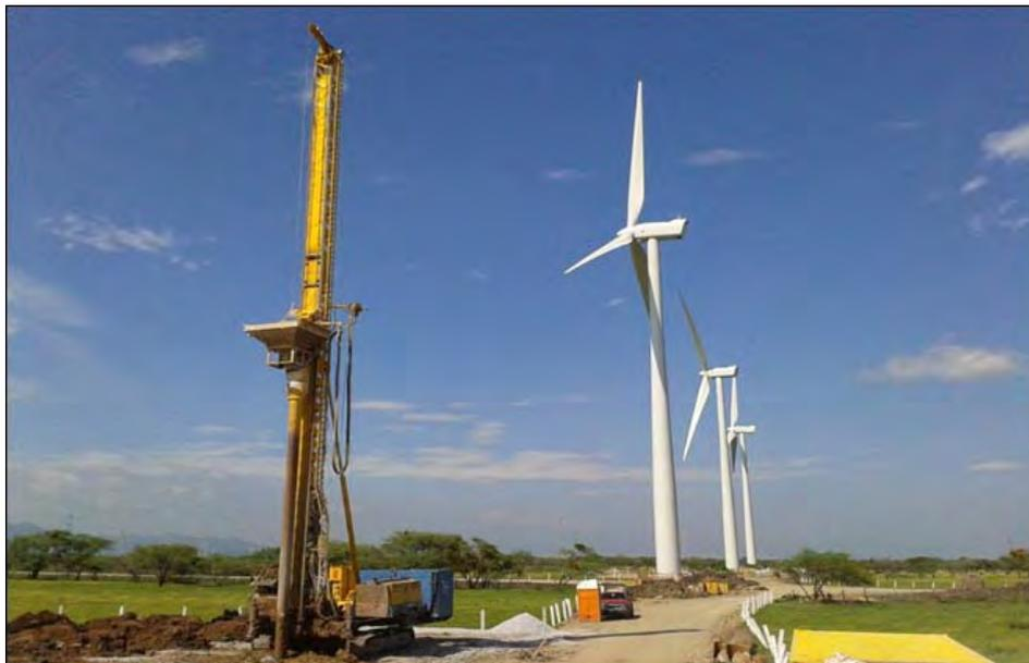
Figura 23: DESARROLLO DE LOS TRABAJOS DE MEJORA – EQUIPOS VIBROCAT DE FABRICACIÓN DE KELLER.
