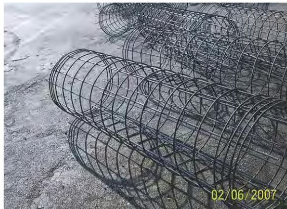
Figura nº 17: Armaduras simples de pilote
