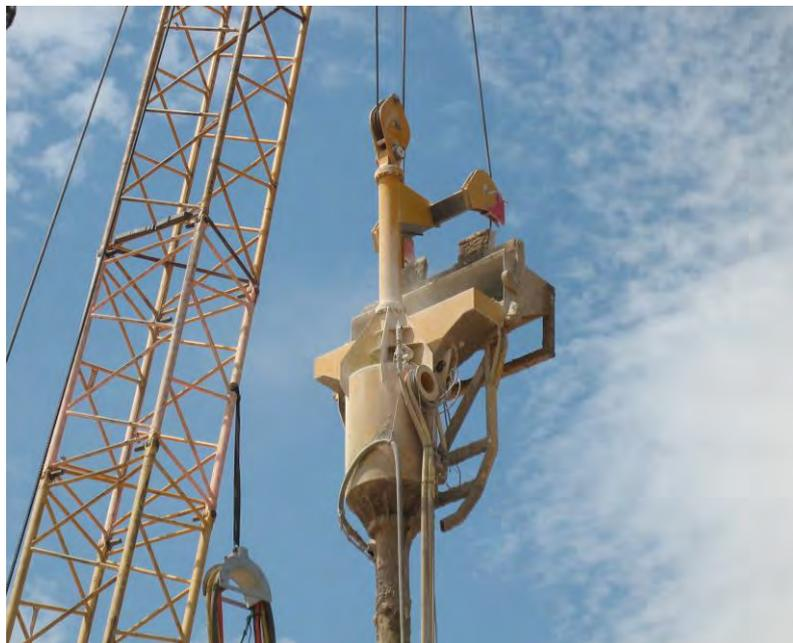
Figura 18. Detalle de la tolva llenando de grava el tanque superior, en una obra de columnas de grava por vía “seca”, con alimentación por el fondo
