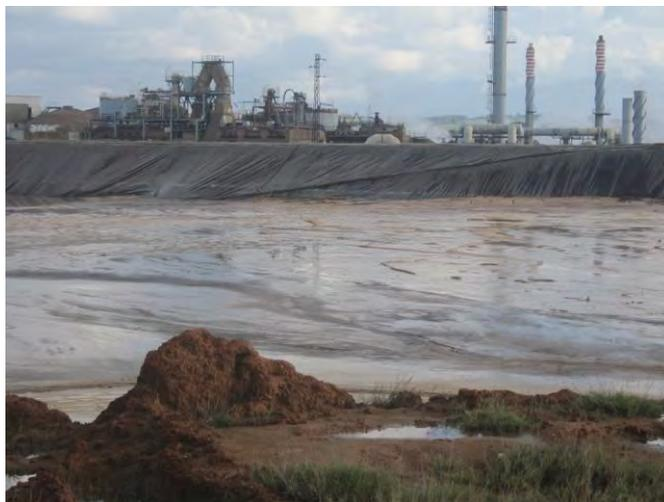
Figura 4-1. Balsa de almacenamiento de lodos industriales
