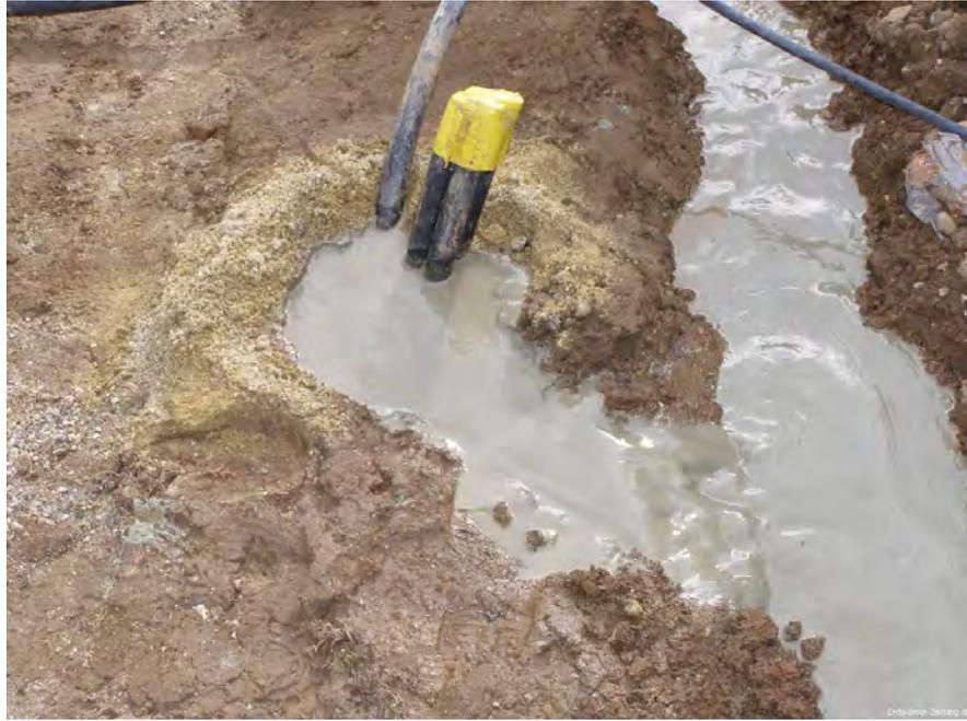
**Foto 8. Cementación de un sondeo geotérmico.**
