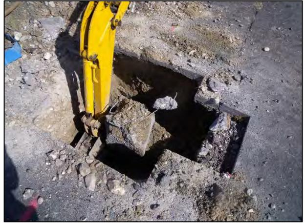
Figura 32.- Descabezado y excavación
