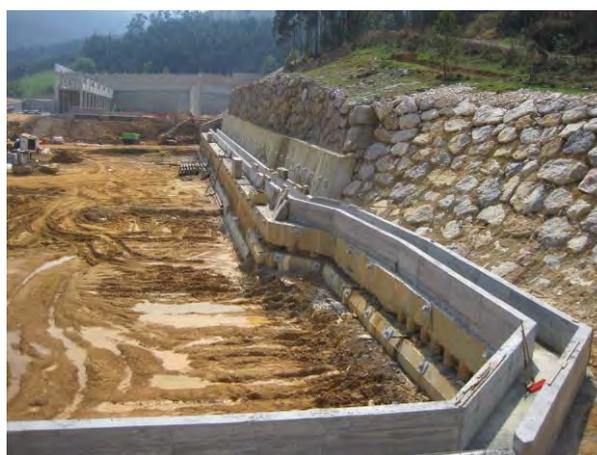
Figura 2-2. Parcela en margen de polígono industrial. Excavación en ladera inestable
