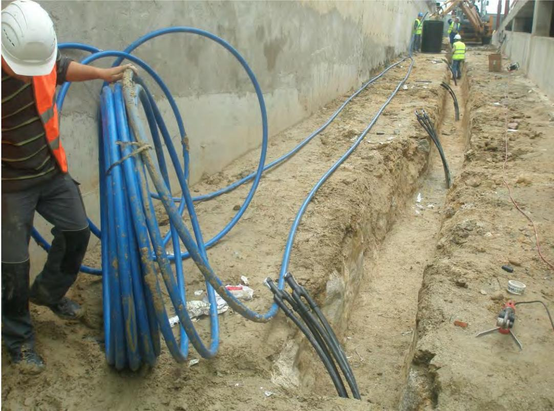
**Foto 2. Tendido de colectores para conectar siete sondas geotérmicas dobles en una nave industrial en Colmenar Viejo (Madrid). (Fuente: Geoter).**
