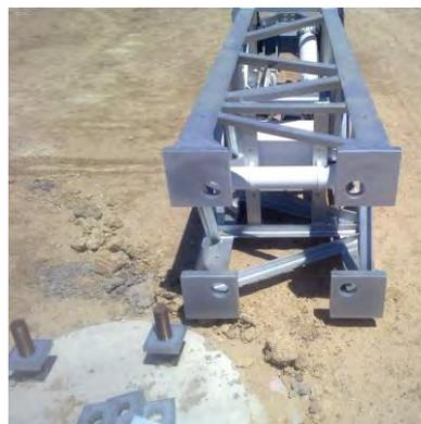
*Figura nº1: Detalles del pilote, pernos para fijación del fuste metálico y de la base del mismo*
