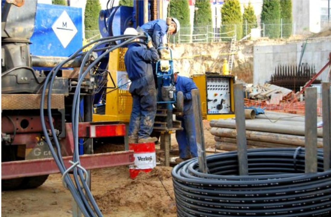
**Foto 7. Introducción de una sonda geotérmica doble con un slangman. (Fuente: EDASU).**
