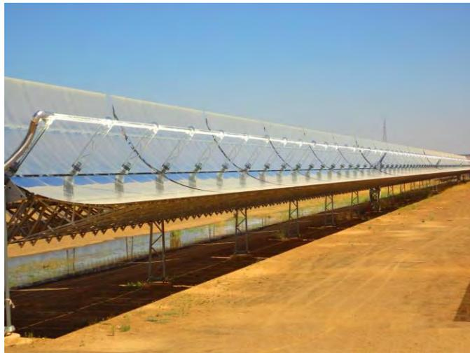
Figura nº 32: Detalle de los espejos colocados sobre fustes metálicos cimentados
