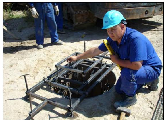
Figura 6.- Colocación de pernos
