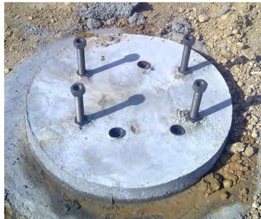
**Figura nº 7:** Inclinómetro en el pilote
