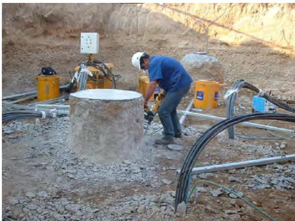
Figura 4.- Preparación de la prueba de carga.
