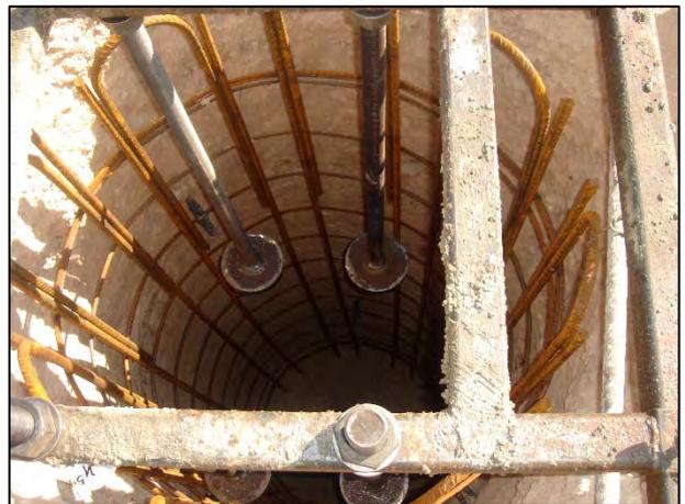
Figura 17.- Armadura y pernos colocados
