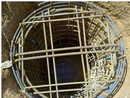
Figura nº 23: Detalle de armadura de pilote y de encofrado
