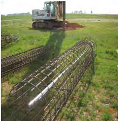
**Figura nº 6:** Colocación del inclinómetro en toda la longitud armadura del pilote
