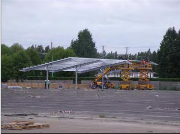
Figura 37.- Montaje de la superestructura
