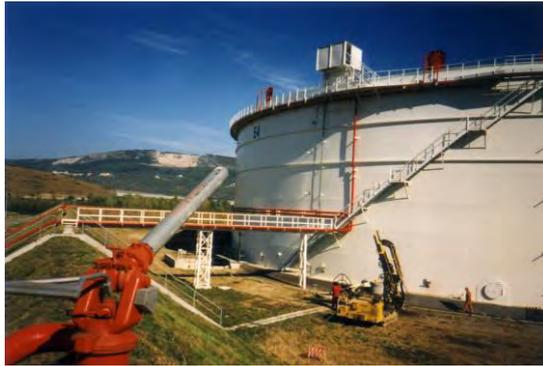
Figura 3-5. Tanque de almacenamiento de GNL. Inyecciones de compensación (Kummerer, 2003)
