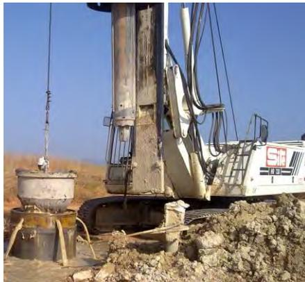
Figura nº 27: Hormigonado a través de embudo y tubo tremie por dentro del revestimiento
