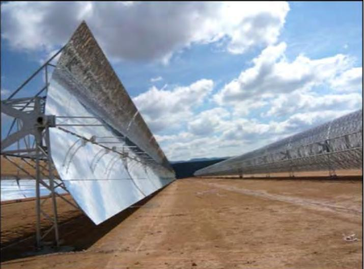
Figura 2.- Colectores cilíndrico-parabólicos colocados
