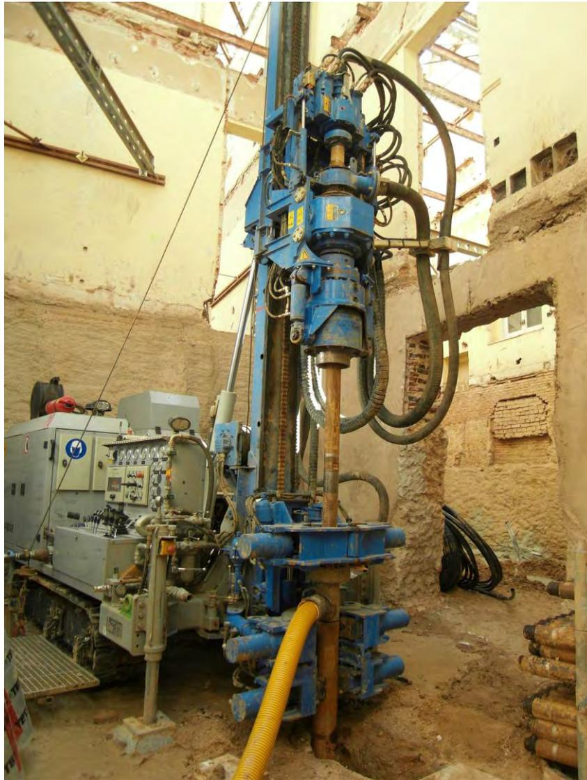
**Foto 3. Perforación a rotación con circulación directa de lodos en un edificio en rehabilitación en Madrid. (Fuente: Eneres).**
