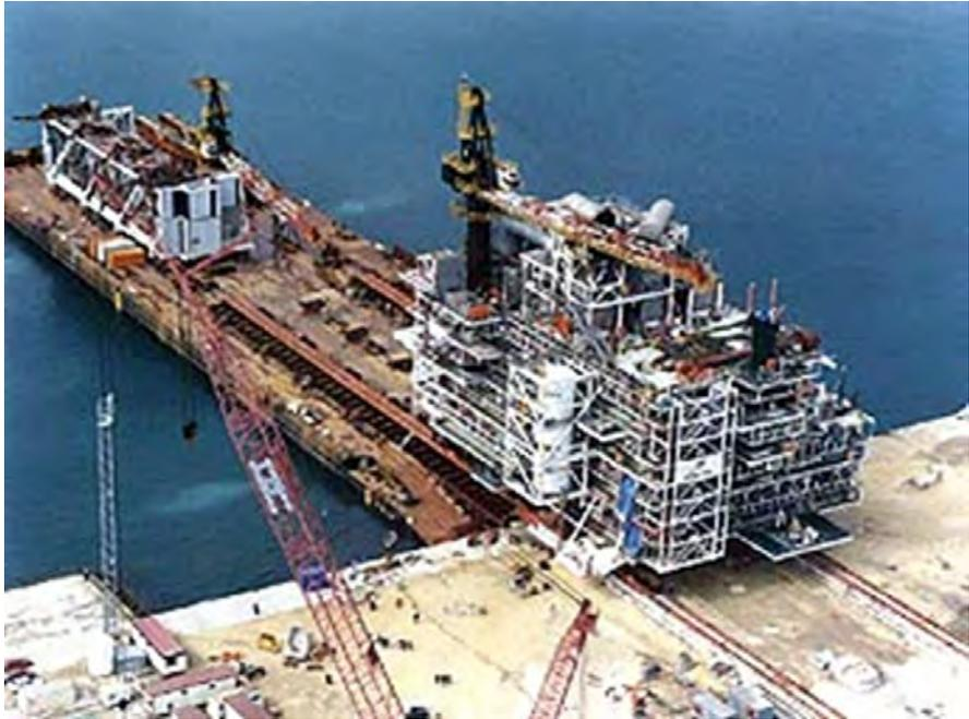
Figura 1. Deck “Amerada” durante el “load-out”
