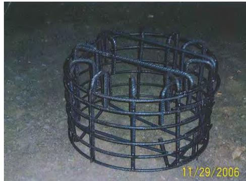
Figura n° 18: Armaduras de encepado
