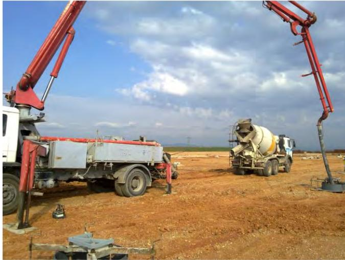
Figura nº 25: Hormigonado con bomba
