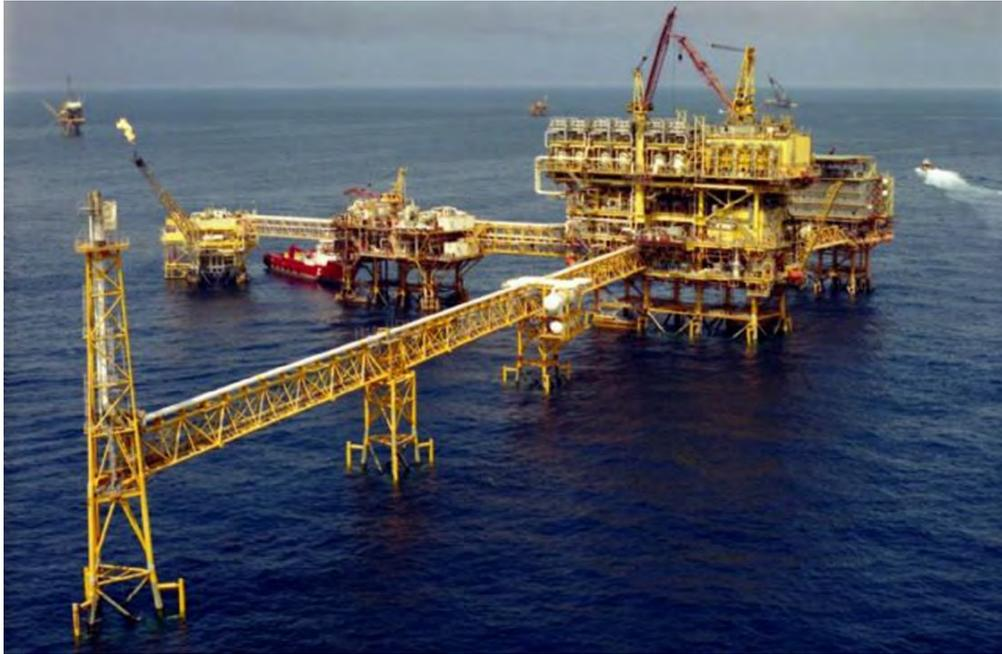
Figure 3: Plataforma fija “Gaviota” (Deck sobre jacket y estructuras auxiliares)
