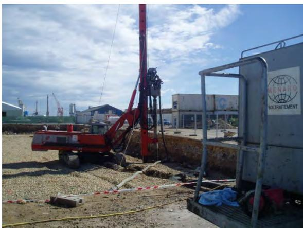
*Figura 28. Ejecución Columnas de Modulo Controlado*
