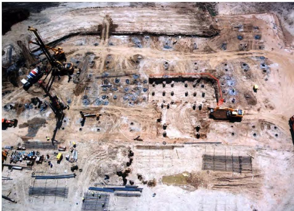
Figura 3.- Ejecución de pilotes in situ para la cimentación de diferentes elementos de la central.
