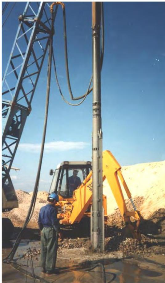
Figura 16. Ejecución de columnas de grava por vía “húmeda”, con alimentación por arriba, para el deck “Amerada”
