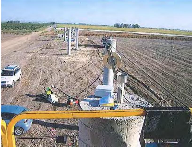
*Figura n°5: Inclinómetro en conjunto de pilote-fuste*
