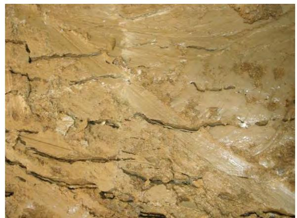
Figura 3-13. Demolición de solera levantada por congelación. Pared vertical de una calicata; se aprecian capas subhorizontales de hielo. Cortesía L. Huete (ARTICA+i)
