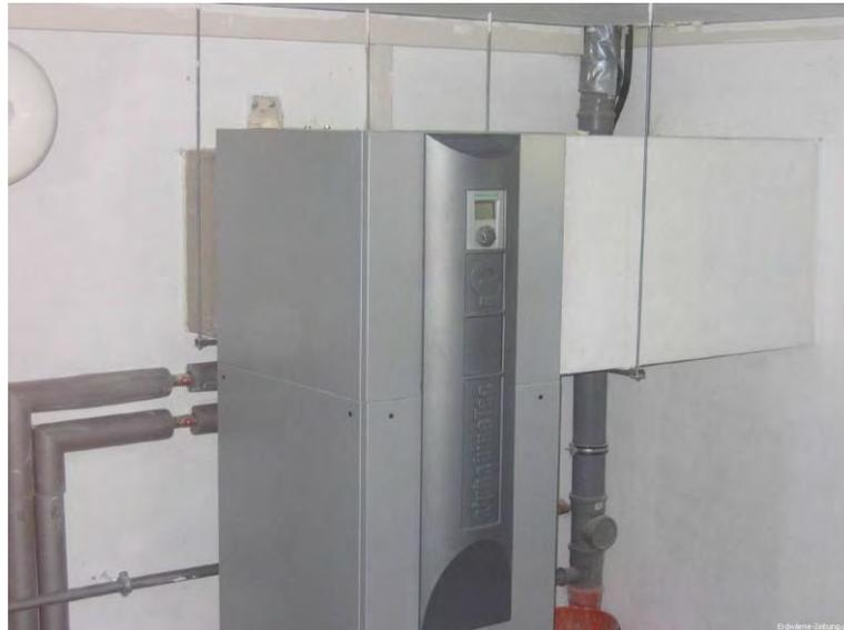
**Foto 1. Bomba de calor geotérmica instalada en un edificio para su climatización.**
