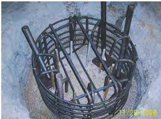
Figura n° 19: Armado del encepado y colocación de pernos
