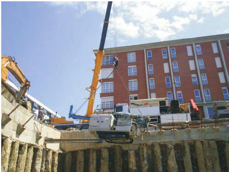
**Foto 4. Descenso de una perforadora a una excavación. Fuente: Termoterra.**
