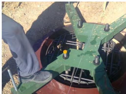
Figura nº 24: Colocación del encofrado, plantilla y pernos
