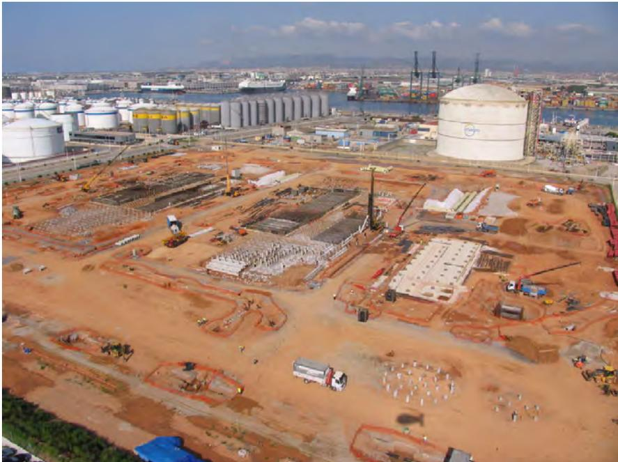
Figura 15.- Vista general de la obra durante la ejecución de la cimentación mediante pilotes prefabricados
