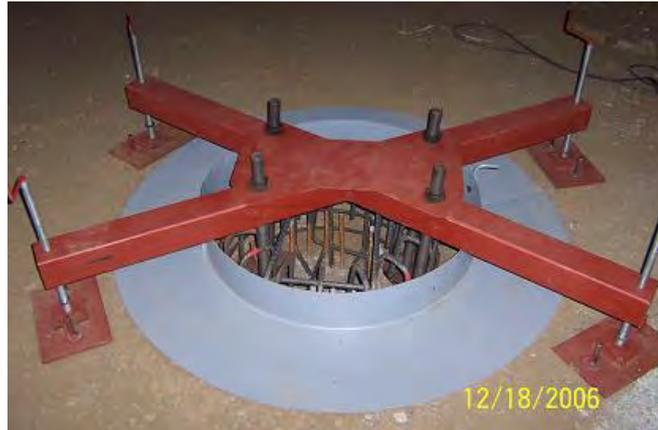
***Figura n°30: Encofrado circular (‘sombbrero’) y plantilla para ejecución independiente de pilote y encepado.***
