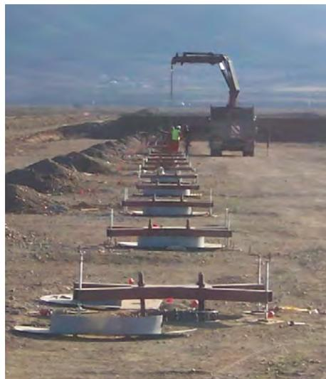
Figura n° 21: Colocación del encofrado para el encepado
