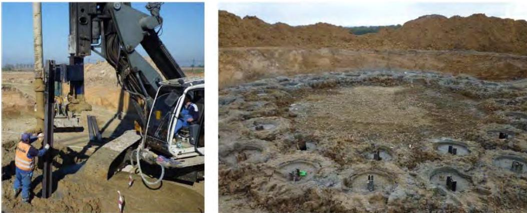
Figura 30: EFECTOS DE LAS TÉCNICAS DE INYECCIÓN EN EL SUELO.
