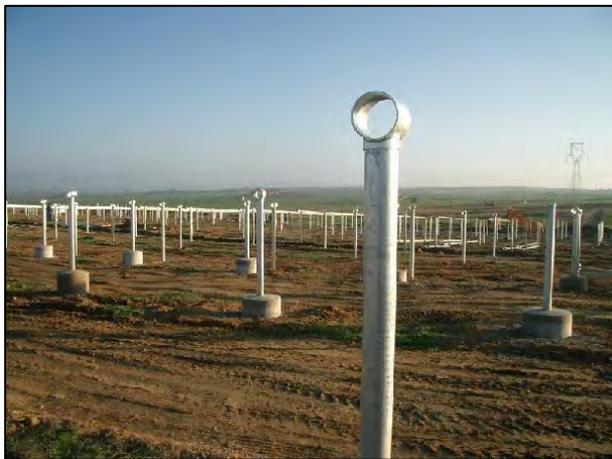
Figura 20.- Los tubos-poste colocados
