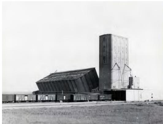
Figura 3-8. Hundimiento del silo de Transcona, en 1913
