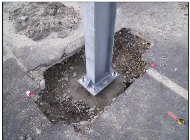
Figura 36.- El pilar atornillado en posición
