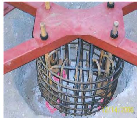
Figura n° 20: Colocación de "plantilla" para fijación de pernos
