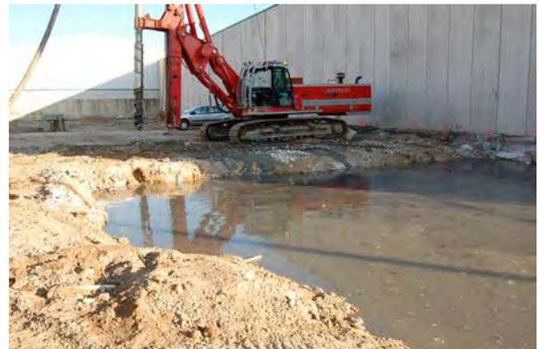
*Figura 24. Plano implantación Columnas de Módulo Controlado bajo la cimentación con losa. Fotografía ejecución*
