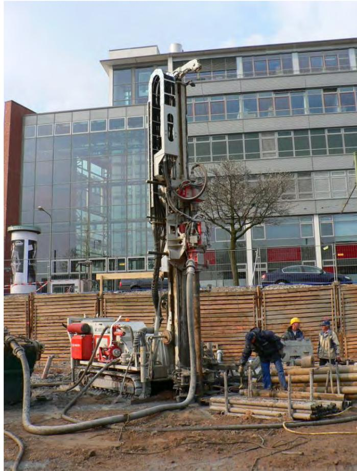
**Foto 5. Perforadora con doble unidad de rotación y manguera para descarga de detritos en un contenedor. (Fuente: Comacchio).**
