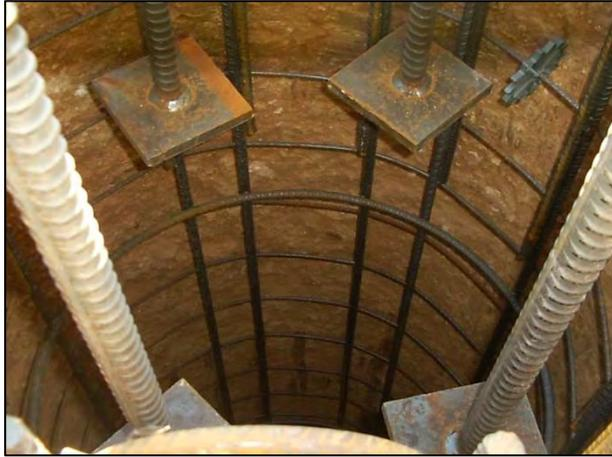
Figura 11.- Armaduras, pernos y placas soldadas
