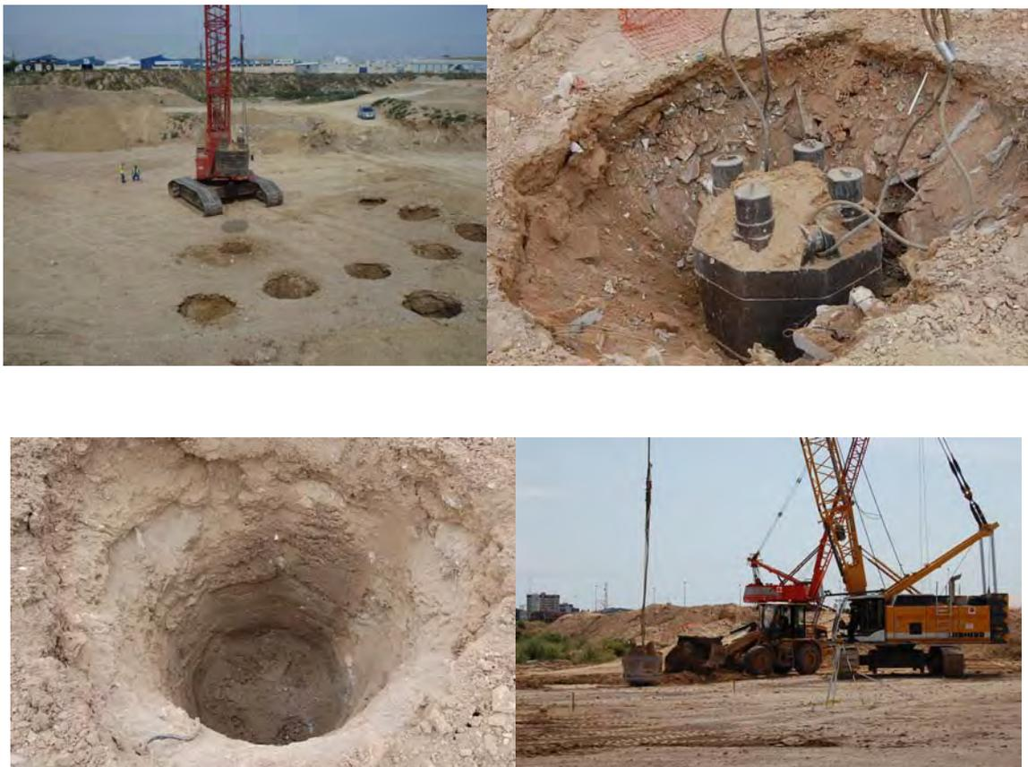
**Figura 14. Malla aplicada y huellas obtenidas.**
