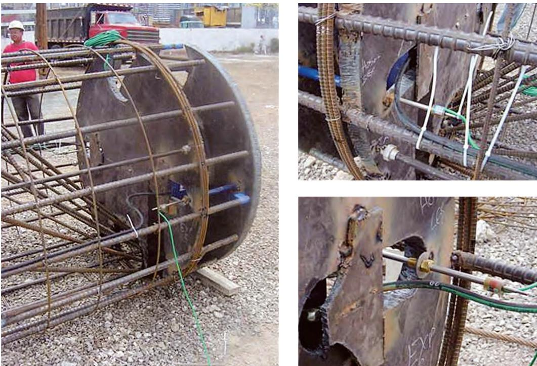
Figura 62. COLOCACIÓN DE LOS EXTENSÓMETROS DE CUERDA VIBRANTE PARA MEDIR LA APERTURA DE LA CÉLULA OSTERBERG.
