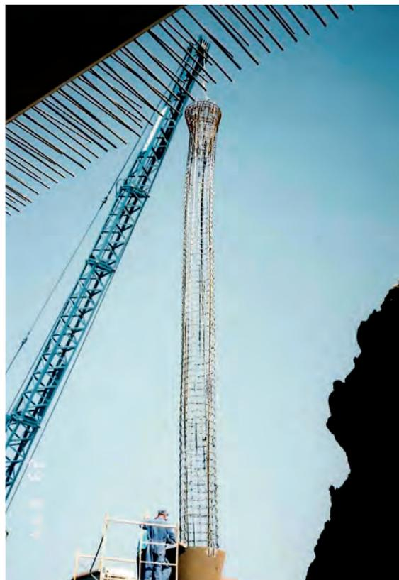
Foto 3. COLOCACIÓN DE LA ARMADURA EN UNA DE LAS PILAS CON CAPITEL.
