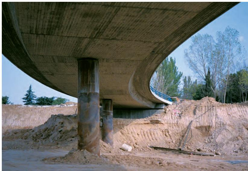
Foto 8. PILAS-PILOTE SIN CAPITEL ANTES DE LA LIMPIEZA Y PINTURA FINAL.
