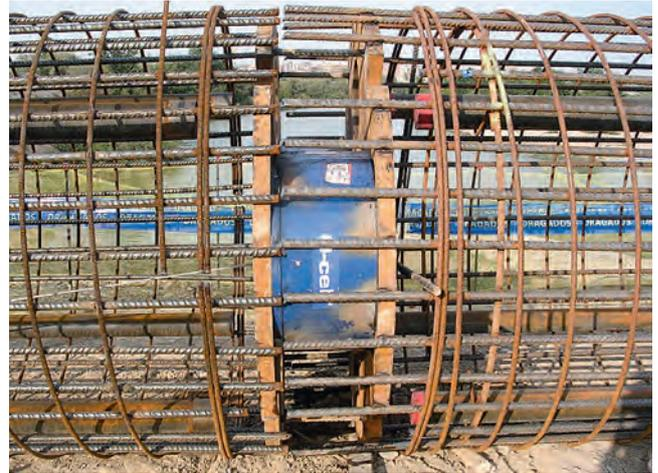
Figura 30 y 31. COLOCACIÓN DE LAS CÉLULAS OSTERBERG EN LA ARMADURA.
