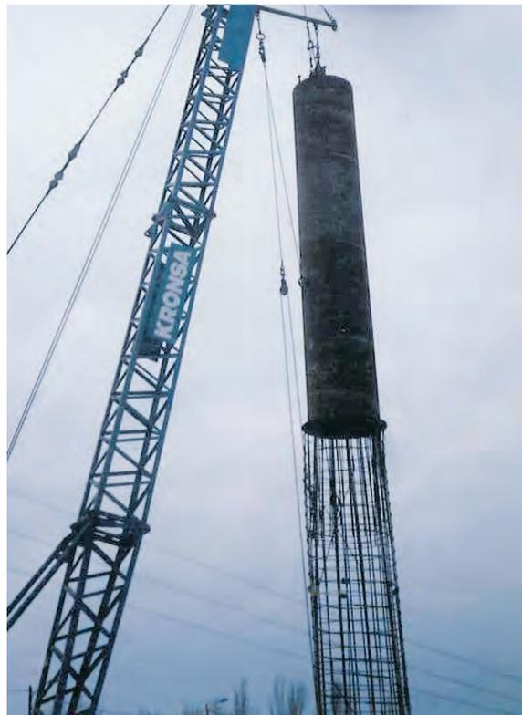
**Foto 5. COLOCACIÓN DE LA ARMADURA EN UNA DE LAS PILAS SIN CAPITEL.**
