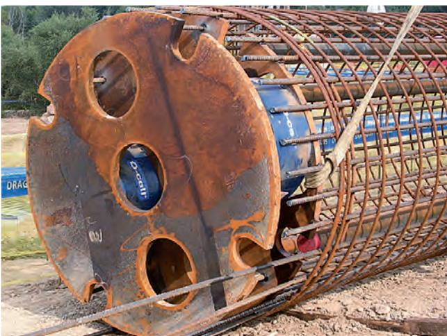
Figura 33. DETALLE DEL PLATO METÁLICO.
