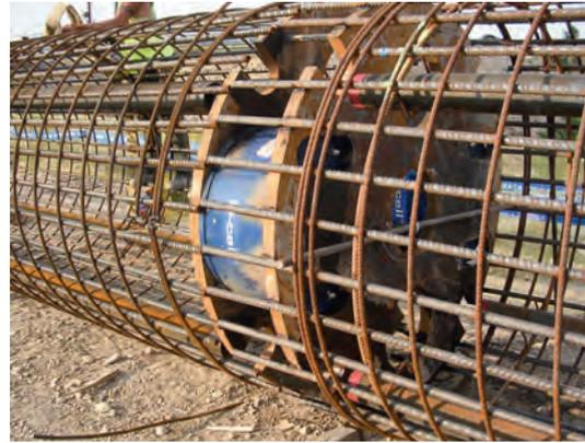
Figura 18. CÉLULAS INSTALADAS EN EL PILOTE.
