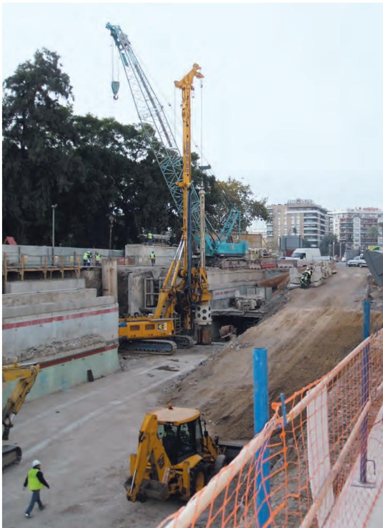
Figura 10. MÁQUINAS TRABAJANDO ENTRE LOS RESTOS DEL APARCAMIENTO SUBTERRÁNEO DEMOLIDO PARA CONSTRUIR LA FUTURA ESTACIÓN PUERTA DE JEREZ.
