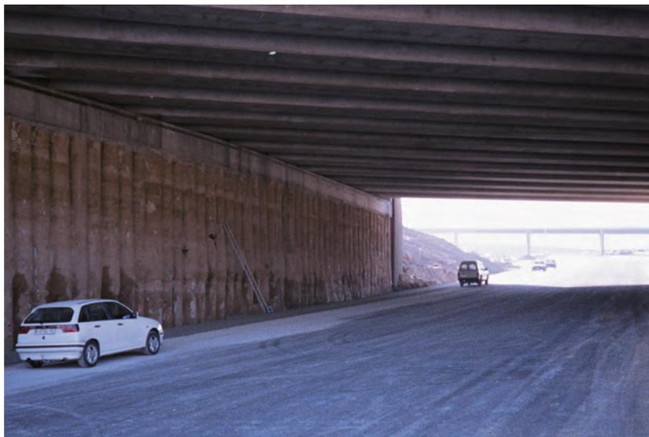
Foto 1. PANTALLAS DE PILOTES EN UN ESTRIBO.
