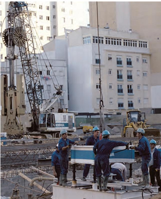
Foto 16. POSICIONAMIENTO DEL PILAR METÁLICO.
