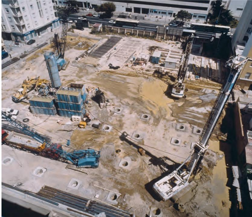
Foto 9. VISTA GENERAL DE LA OBRA, EN LA QUE SE APRECIAN LOS EQUIPOS DE PERFORACIÓN DE PANTALLAS Y PILOTES Y LOS ANTEPOZOS DE HORMIGÓN DE ÉSTOS.
