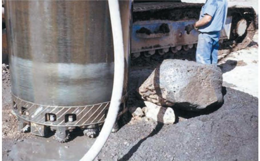
Figura 20. FRAGMENTO DE BASALTO EXTRAÍDO EN EL AUDITORIO DE TENERIFE (Gentileza de Terratest).
