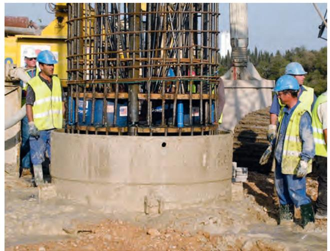
Figuras 41, 42, 43 y 44. COLOCACIÓN DEL PRIMER TRAMO DE ARMADURA.
