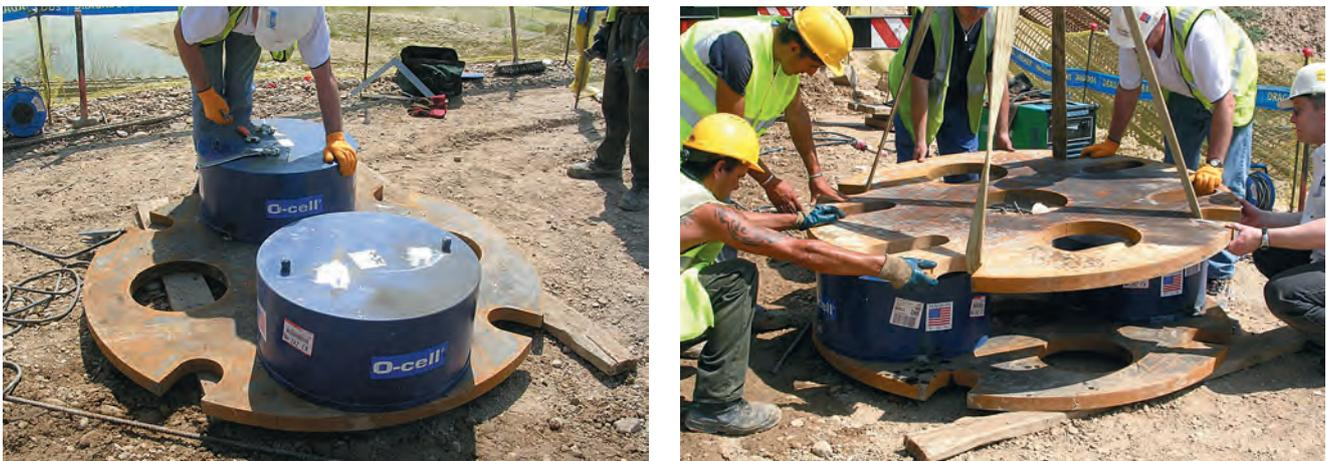
Figura 27 y 28. COLOCACIÓN DE DOS CÉLULAS OSTERBERG.
