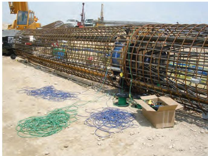
**Figura 40. CABLEADO DE LOS INSTRUMENTOS DE AUSCULTACIÓN.**
