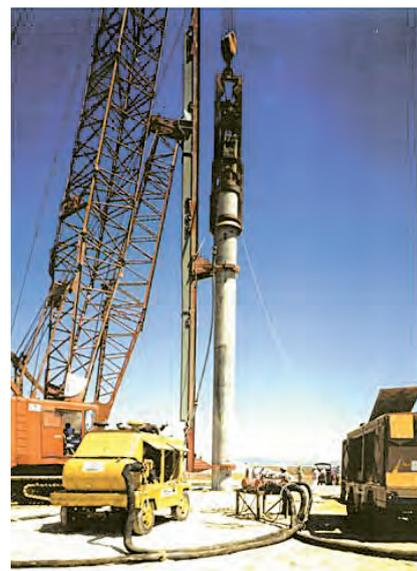
Figura 37. HINCA DE UN PILOTE RAYMOND Ø 66" EN LOS PUENTES DE LA VARIANTE DE PUERTO REAL Y EL PUERTO DE SANTA MARÍA (Gentileza de Dragados).
