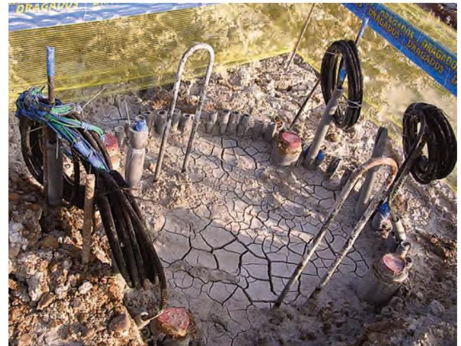
Figura 46. PILOTE HORMIGONADO.
