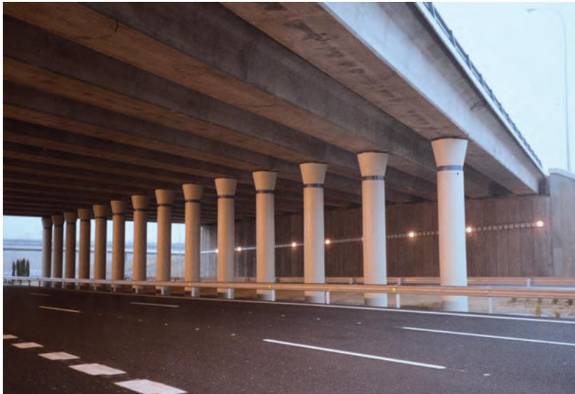
Fotos 6 y 7. VISTA DE LAS PILAS-PILOTE CON CAPITEL DE LA ESTRUCTURA NÚMERO 1
