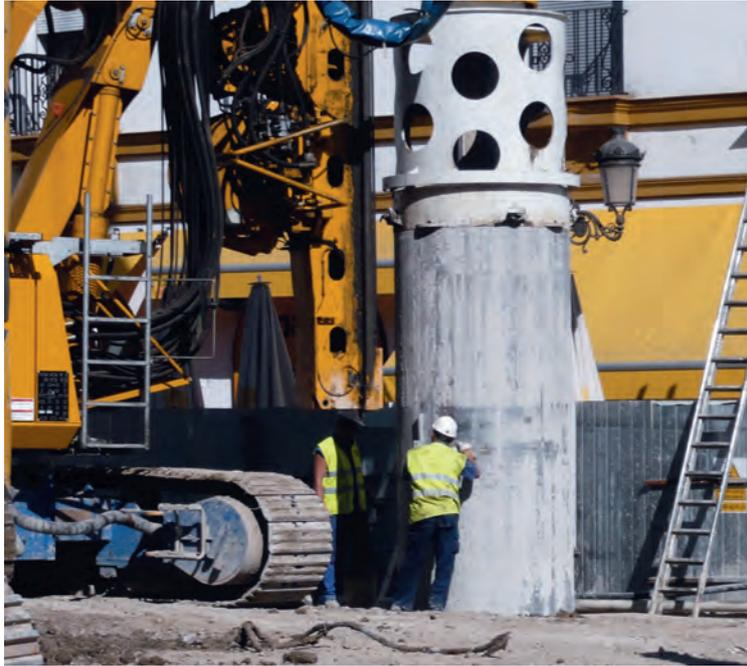
Figura 9. CONTROL DE VERTICALIDAD DURANTE LA COLOCACIÓN DE UN TRAMO DE ENTUBACIÓN RECUPERABLE.
