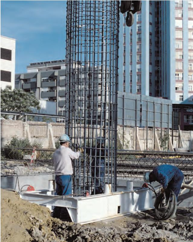
Foto 14. COLOCACIÓN DE LA ARMADURA DEL PILOTE.
