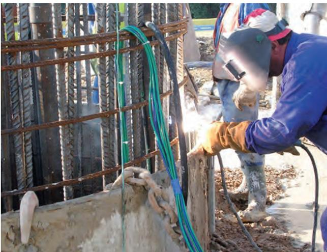
Figura 45. CONEXIÓN ENTRE TRAMOS DE ARMADURA.
