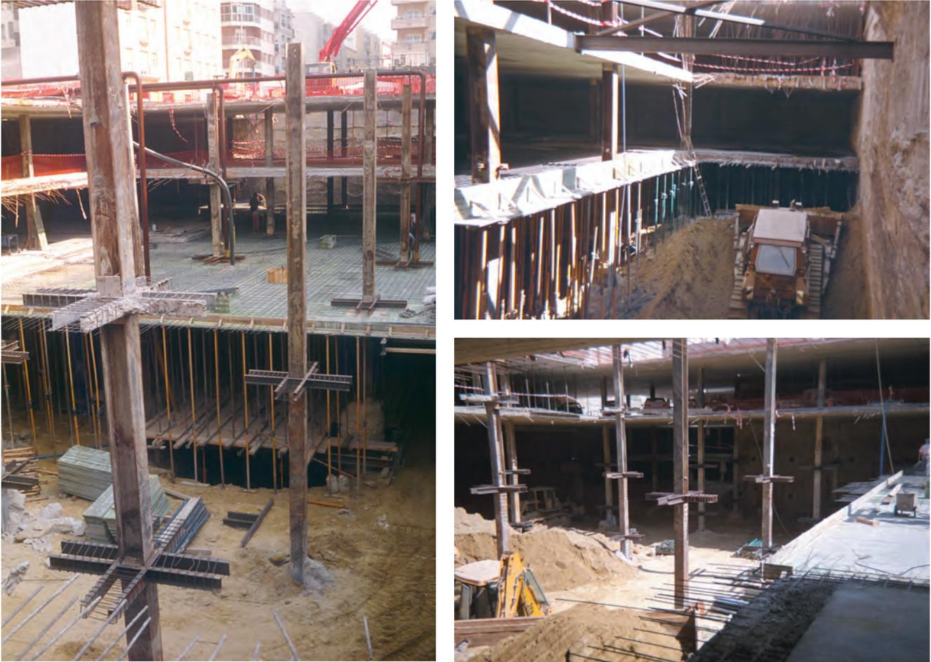
Fotos 18, 19 y 20. VARIAS FASES DE LA EXCAVACIÓN DEL RECINTO.
