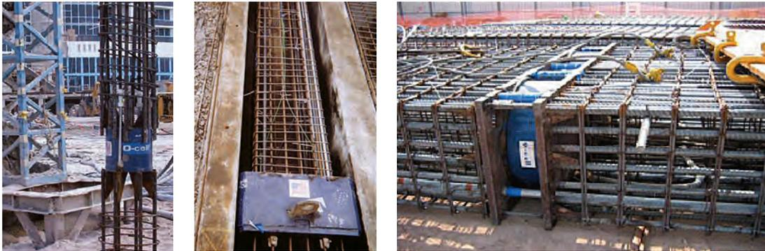
Figura 21. EJEMPLOS DE UTILIZACIÓN DE CÉLULAS OSTERBERG EN PILOTES CON BARRENA CONTINUA, PILOTES PREFABRICADOS Y «BARRETES» O ELEMENTOS DE MURO PANTALLA (England, M., et al., 2006).
