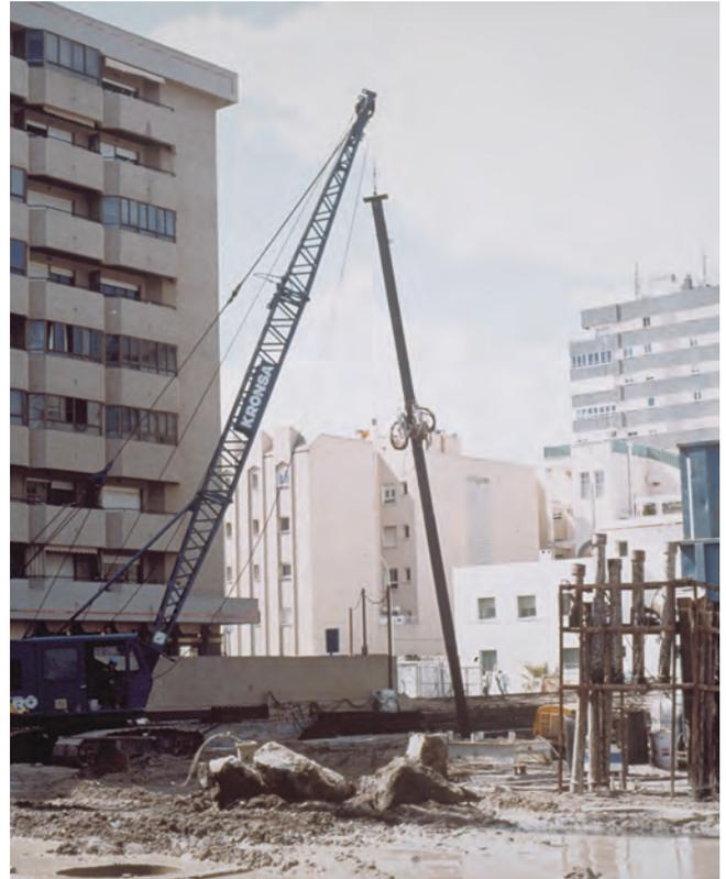
Foto 15. IZADO DEL PILAR METÁLICO.
