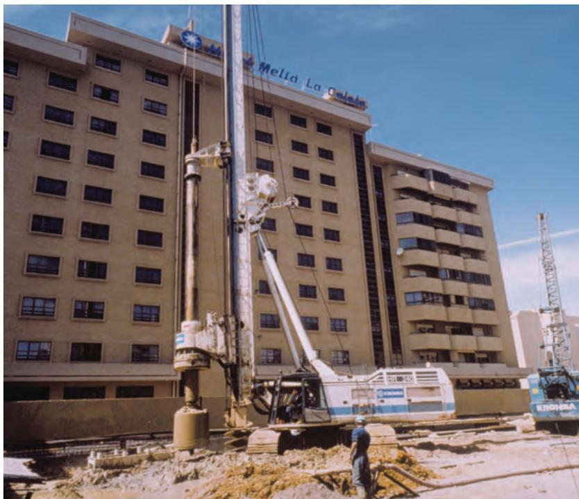
Foto 10. EQUIPO DE PERFORACIÓN DE PILOTES.
