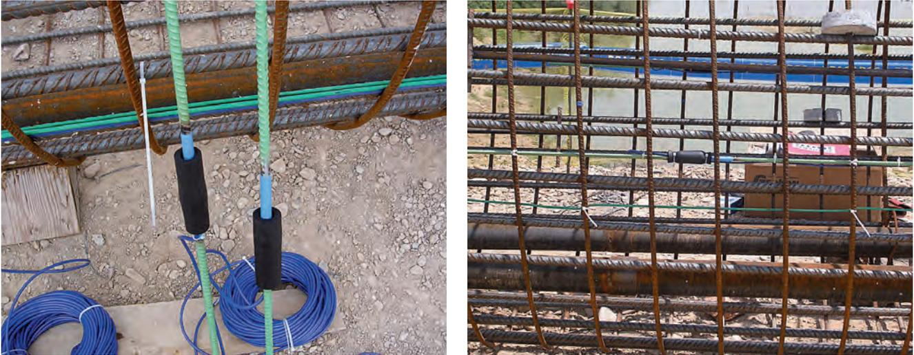
**Figuras 38 y 39. TRANSDUCTORES DE DEFORMACIÓN DE CUERDA VIBRANTE.**
