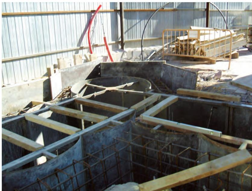
Figura 7. FOTOGRAFÍA DE LOS ENCOFRADOS CILÍNDRICOS A UNA CARA PARA LOS MURETES-GUÍA.
