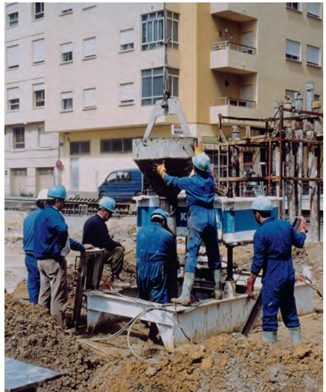
Foto 17. HORMIGONADO DEL PILOTE.
