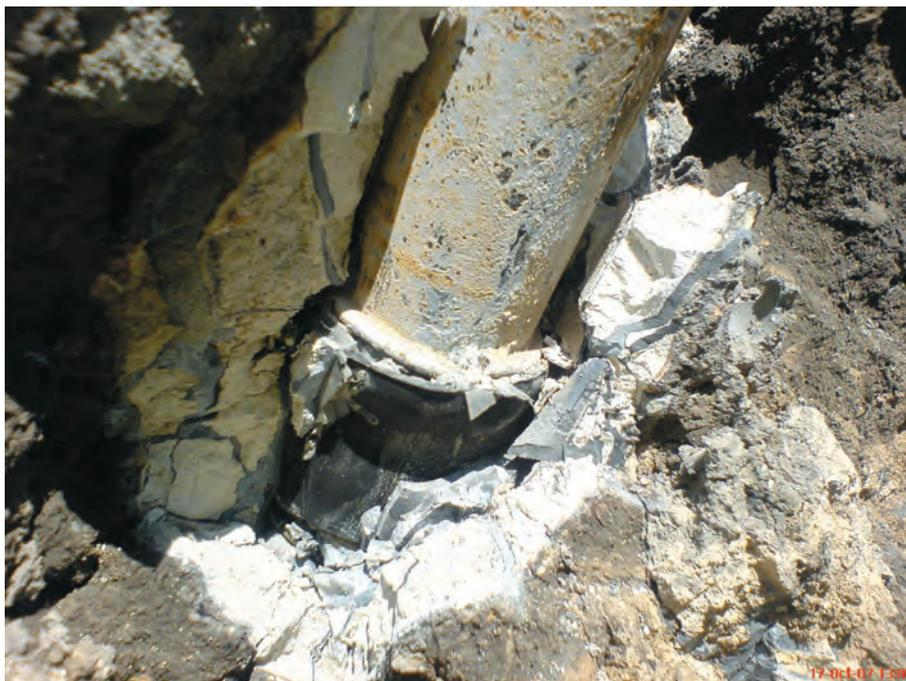
Figura 3. TUBO METÁLICO EMBEBIDO EN EL TERRENO CORRESPONDIENTE A LAS INYECCIONES ARMADAS DEL APARCAMIENTO SUBTERRÁNEO EXISTENTE.
