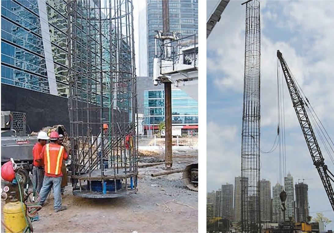
Figuras 63 y 64. POSICIÓN DE LA CÉLULA OSTERBERG Y COLOCACIÓN DE LA ARMADURA.
