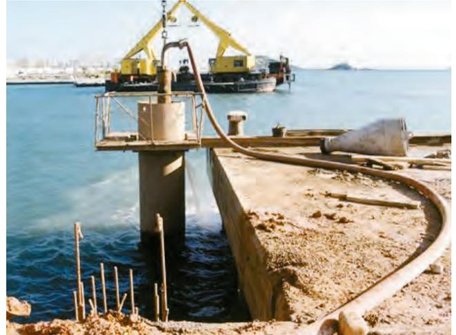
ducir el hormigón el pilote, y mediante la ayuda de la bomba con la que se extrae el agua mezclada con partículas de suelo de fondo. Esta operación se mantiene hasta conseguir que el agua extraída no contenga partículas de suelo (Fotos 9 y 10).
