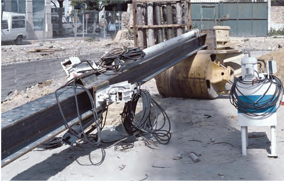
Foto 12. PILAR METÁLICO: DETALLE DE LOS GATOS PLANOS.
