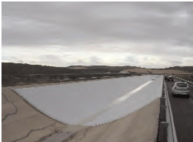
Figuras 29. COLOCACION DE LAMINA DE PVC.
