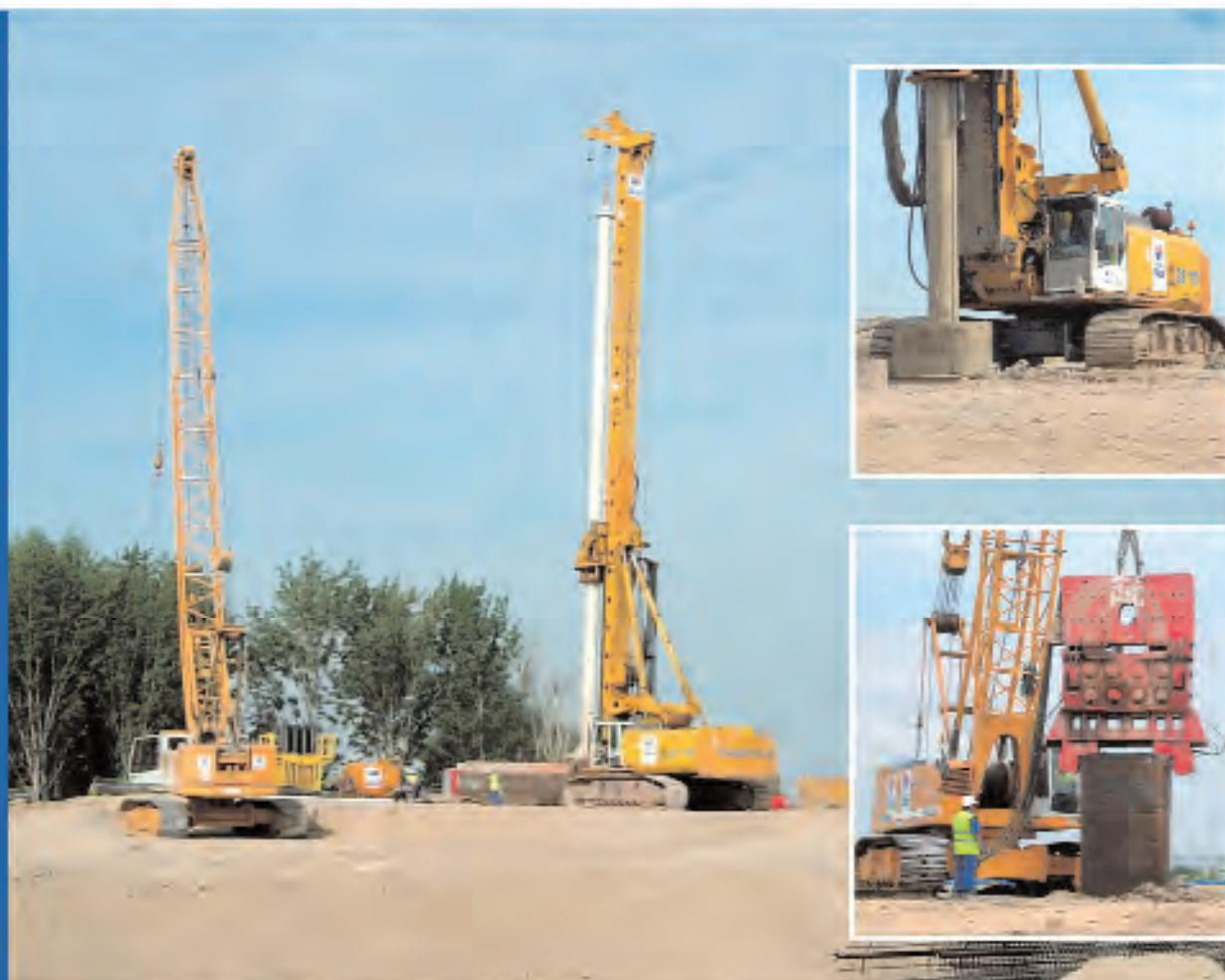
Pilotes de diámetro 1.500 y 2.000 mm. Profundidad máxima de perforación 73 metros
