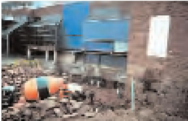
Figura 9. EJECUCION DE HORMIGON PROYECTADO.
