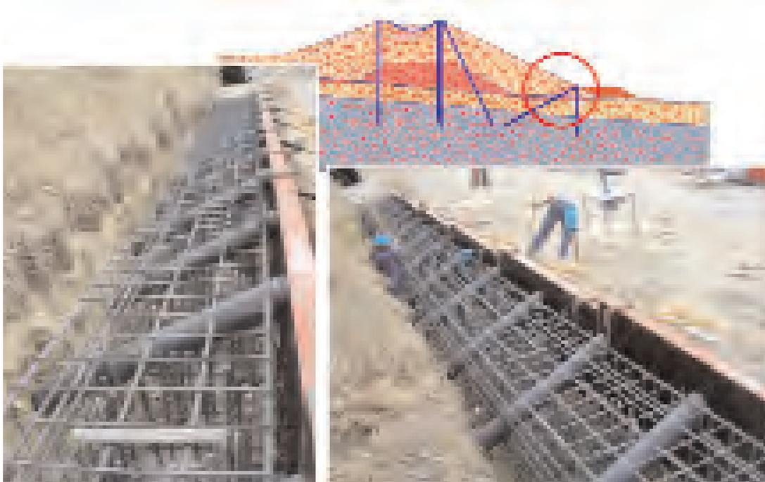
Figura 28. VIGA DE ATADO DE PILOTES Y MICROPILOTES.
