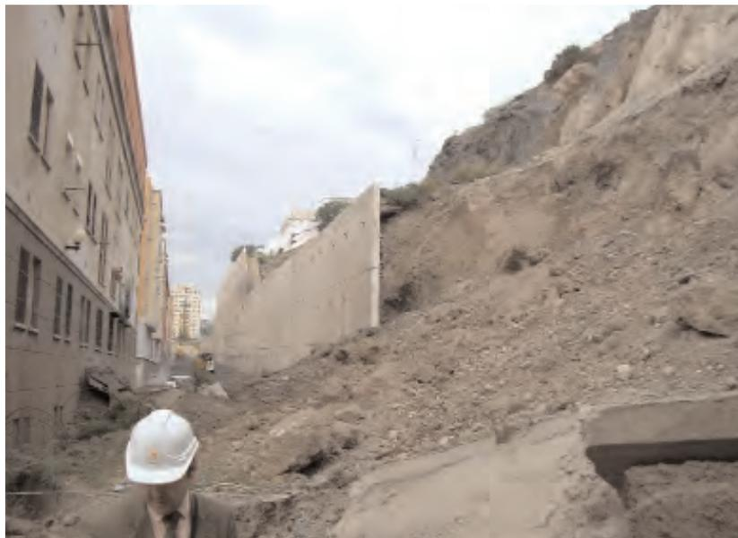
**Fotografía 1. MURO DERRUIDO.**
