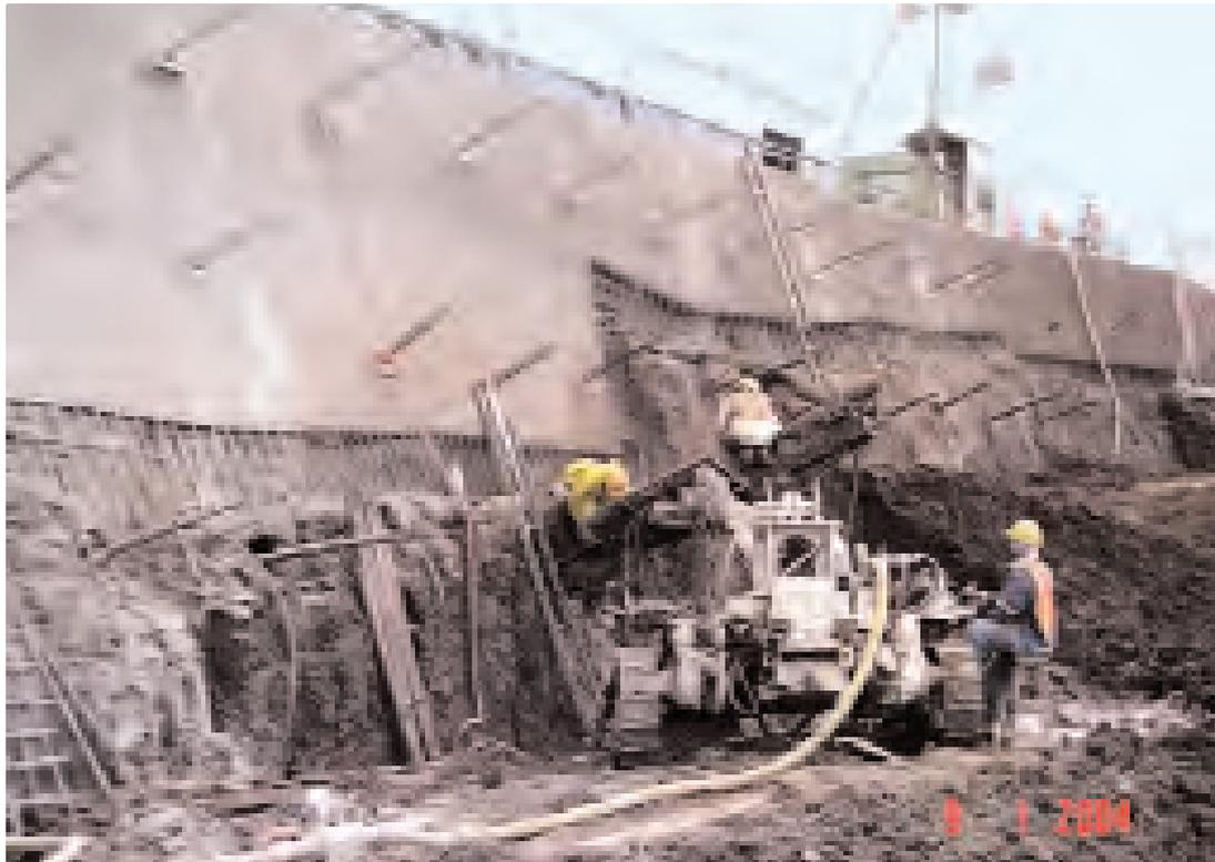
Figura 20. PERFORACION DE ANCLAJES (3ª fila, parte central).
