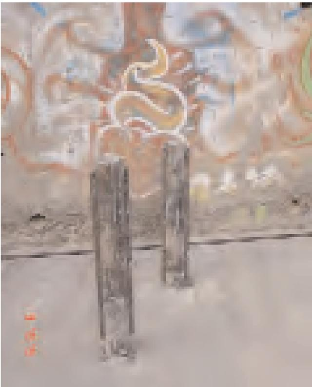
Fotografía 16. CONECTORES DE CONEXION. MICROPILOTES.
