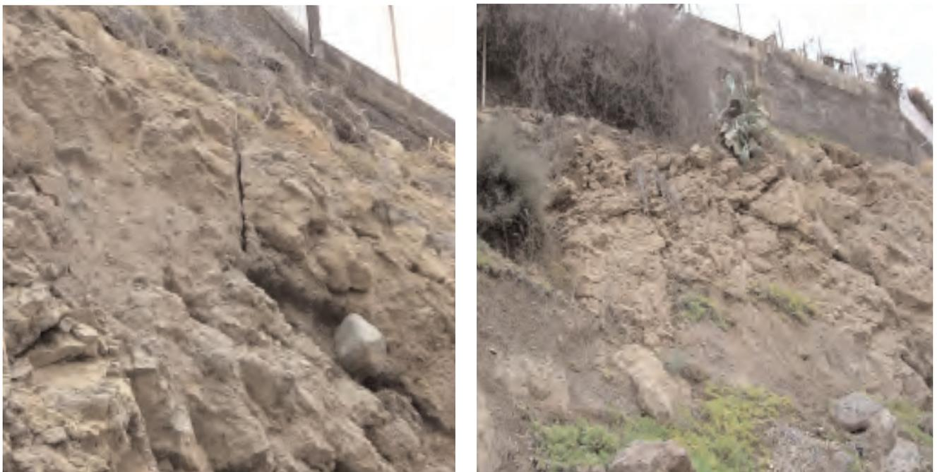
Fotografía 10. FISURAS Y GRIETAS EN TALUDES NATURALES.
