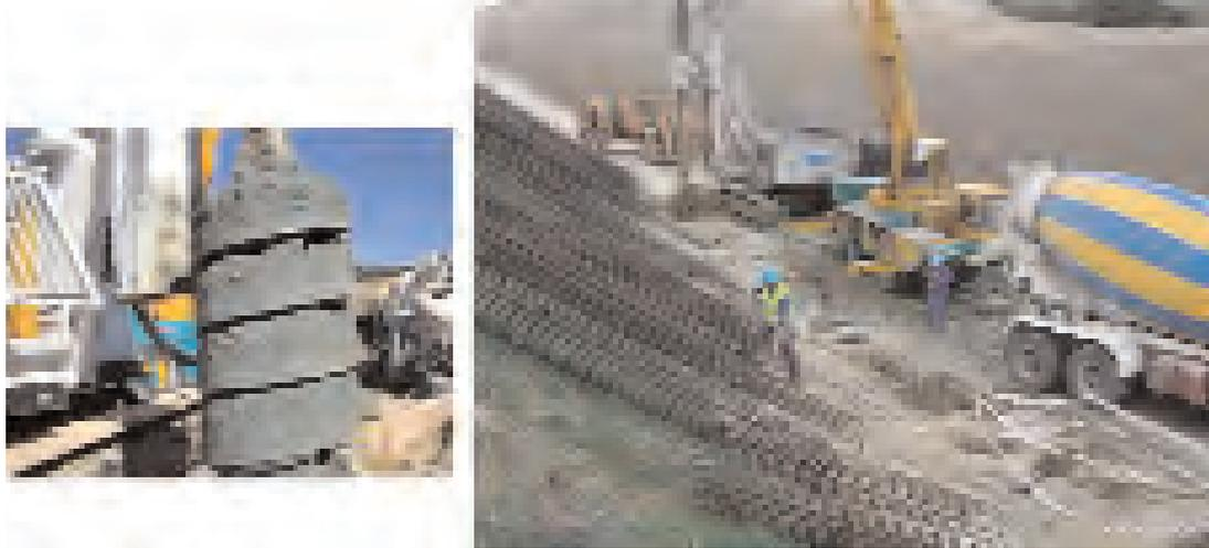
Figura 16. EJECUCION DE LA PANTALLA DE PILOTES.
