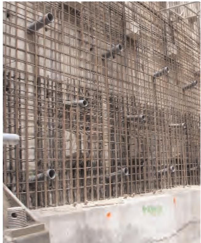
Fotografía 17. DETALLE DEL ARMADO DEL MURO CON LOS PASATUBOS EMBEBIDOS.
