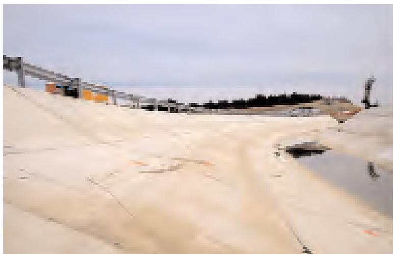
Figura 12. ROTURA DE LAS LOSAS DEL CANAL EN MARGEN IZQUIERDA.
