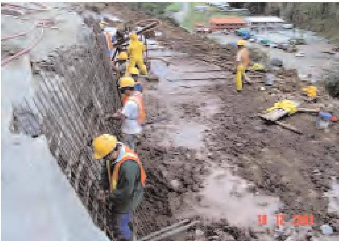
Figura 19. COLOCACION DEL ACERO DEL MURO (1ª fila).
