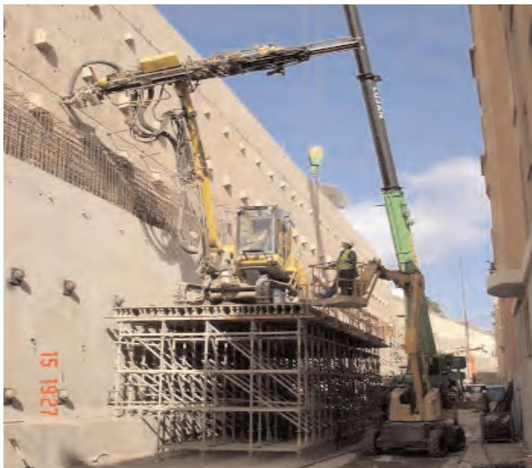
Fotografía 22. EJECUCION DE ANCLAJES PASIVOS A COTA +12,75.
