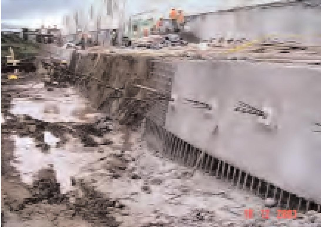
Figura 18. SANEAMIENTO Y EJECUCION DE ANCLAJES (1ª fila).
