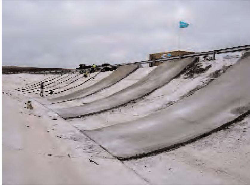
Figura 21. RECONSTRUCCION DE LOSAS Y RECUPERACION DE COTA.
