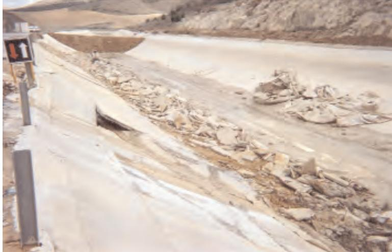
Figura 8. ROTURA DEL REVESTIMIENTO DEL CIMIENTO.
