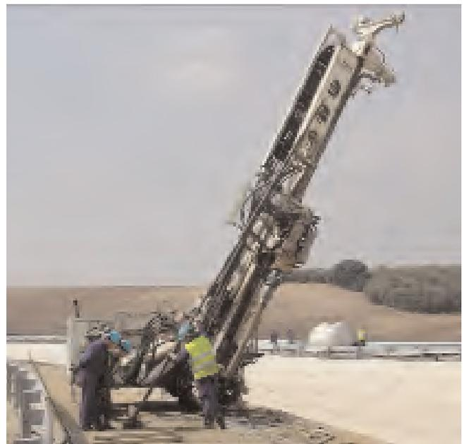
Figuras 19 y 20. PERFORACION PARA INSTALACION DE TUBOS-MANGUITO PARA INYECCIONES ARMADAS (VERTICALES + INCLINADAS 25°).
