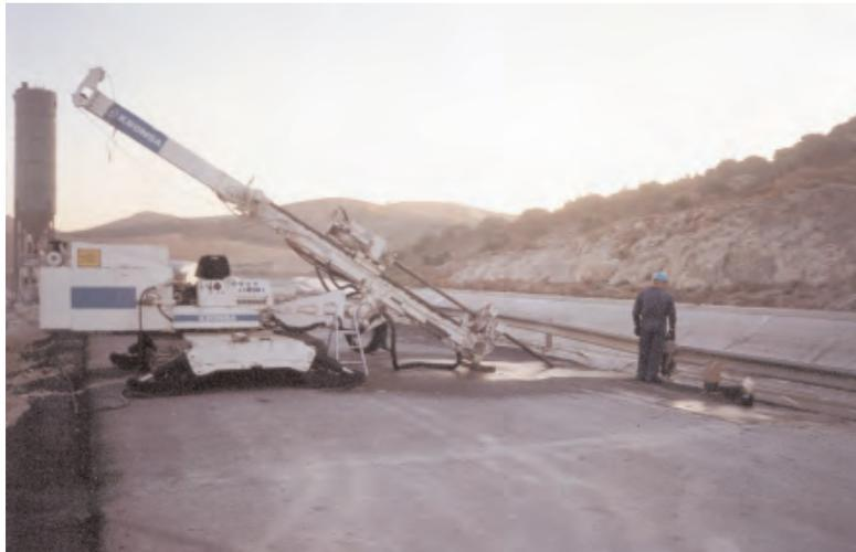
Figura 10. TALADROS PARA INYECCIONES DE RELLENO.
