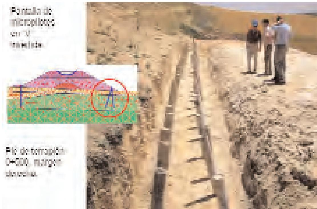
Figura 18. PANTALLA DE MICROPILOTES EN "V" INVERTIDA.
