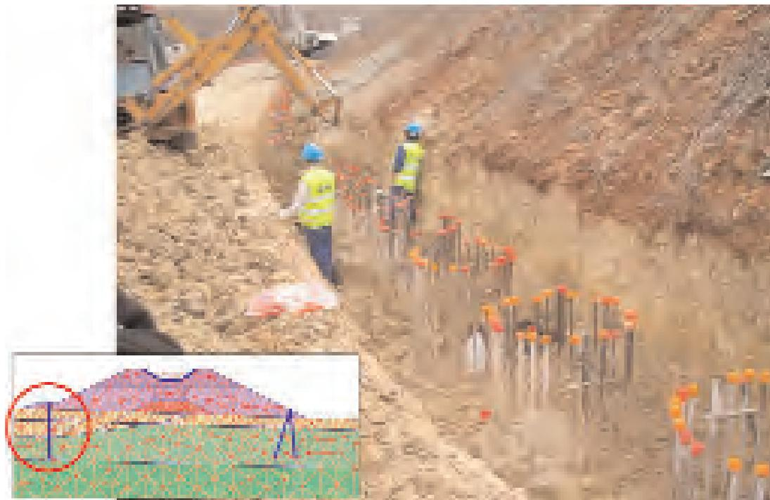
Figura 17. PANTALLA DE PILOTES: DESCABEZADO.
