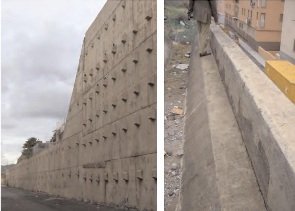
Fotografía 6. DESPLOMES EN EL MURO Y CUNETETA.
