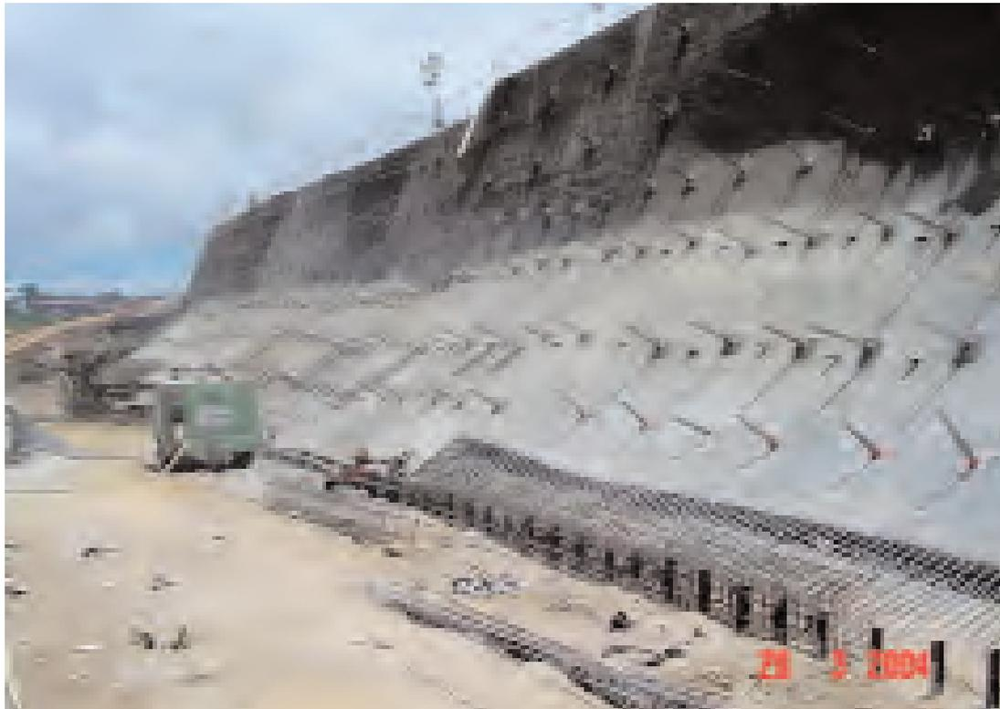
Figura 24. VISTA DEL MURO LADO ESTE CON LOS MICROPILOTES EN EL PIE DEL TALUD.
