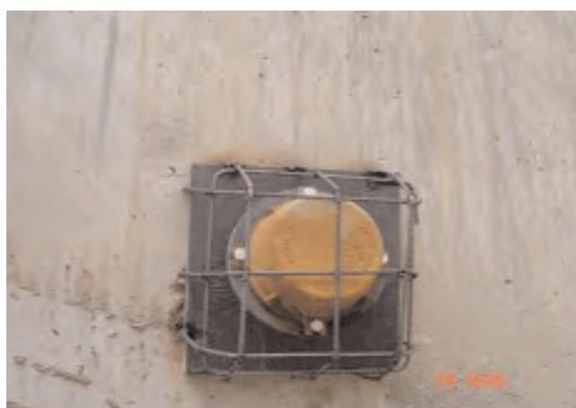
Fotografía 19. TESADO DE ANCLAJES Y DETALLE DE CAPERUZA METALICA.
