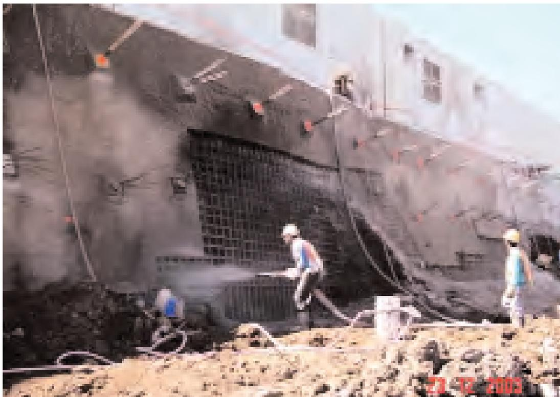
Figura 21. LANZADO DE HORMIGON.
