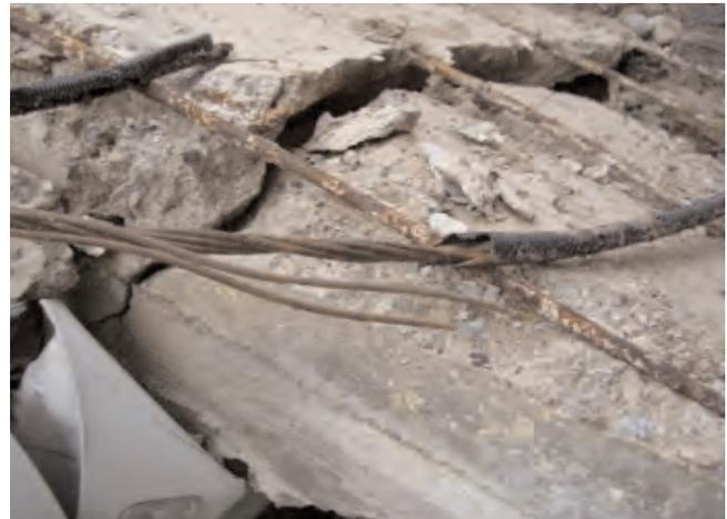
Fotografía 5. PROTECCION CONTRA LA CORROSION DEFICIENTE EN ANCLAJES.
