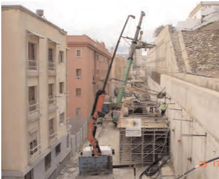
**Fotografía 20. EJECUCION DE LOS ANCLAJES DEL SEGUNDO Y TERCER NIVEL DESDE ESTRUCTURA METALICA.**
