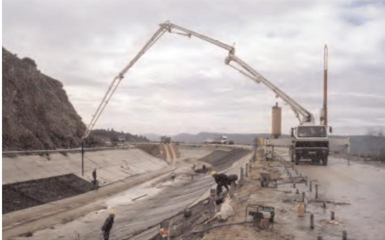
Figura 11. HORMIGONADO DE LAS LOSAS REGENERADAS DEL CANAL Y TUBOS-MANGUITO DE LAS INYECCIONES ARMADAS VERTICALES.
