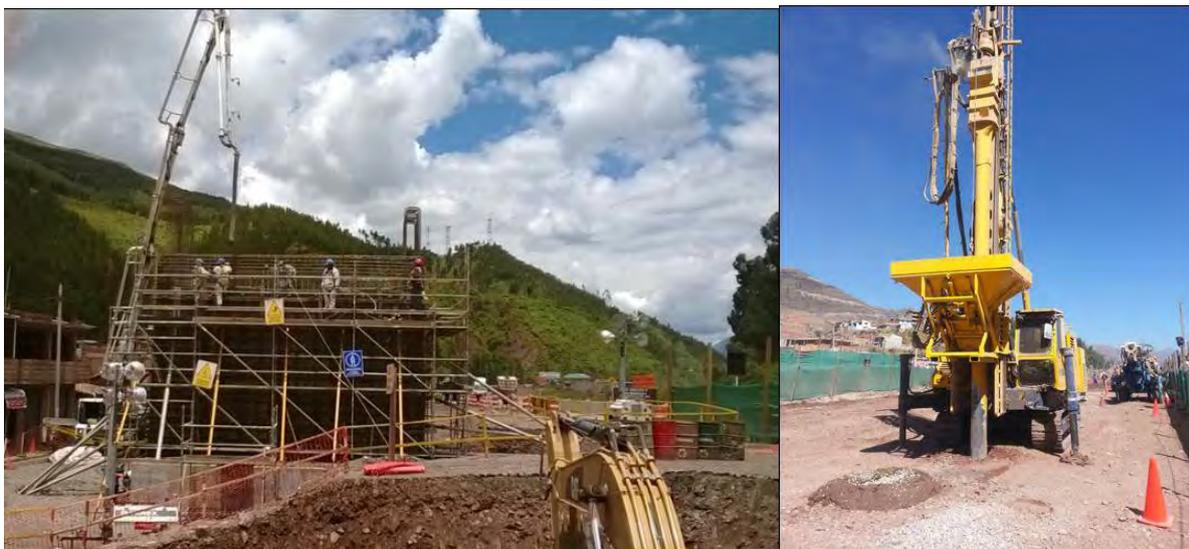
Figura 2.7. VISTA DE UNO DE LOS ESTRIBOS EN CONSTRUCCIÓN Y EL EQUIPO DE EJECUCIÓN DE LAS COLUMNAS DE GRAVA.
