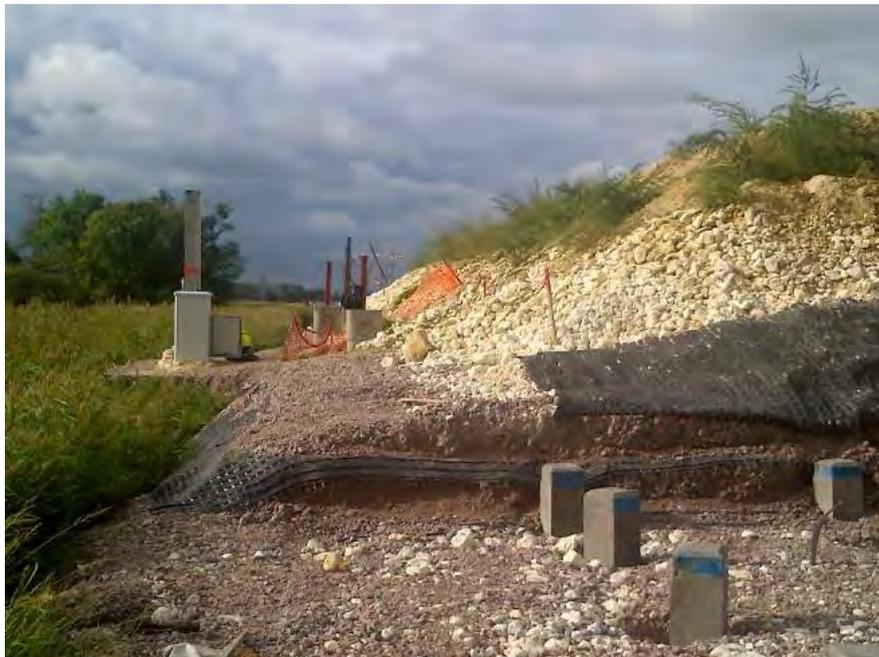
Foto 6. Centrales de adquisición de datos y detalle de colocación de geomallas.
