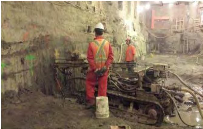
*Figura 39: Carros neumáticos tipo Ingersoll Rand LM 100*
