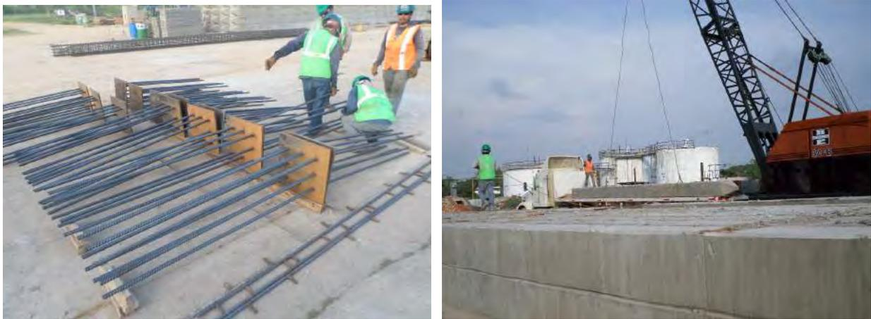
Figura 3.8. PREPARACIÓN DE PERNOS EN LAS PLACAS DE UNIÓN E IZADO DE PILOTES.
