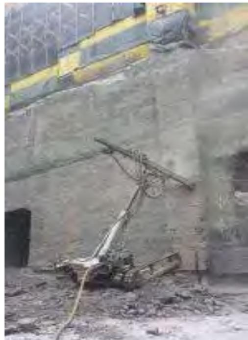
*Figura 46: Carro neumático tipo ECM en pared gunitada*
