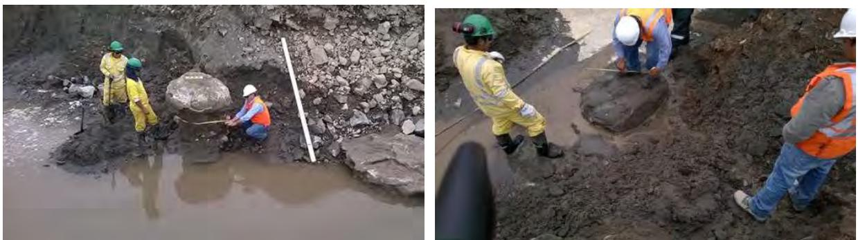
Figura 4.8. COMPROBACIÓN DE COLUMNAS DE JETGROUTING EXCAVADAS.
