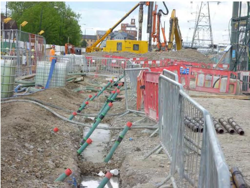
Figura 24. Malla de TAM inclinados instalados bajo la barrera de micropilotes de protección de los servicios de la calle Victoria Dock Road.
