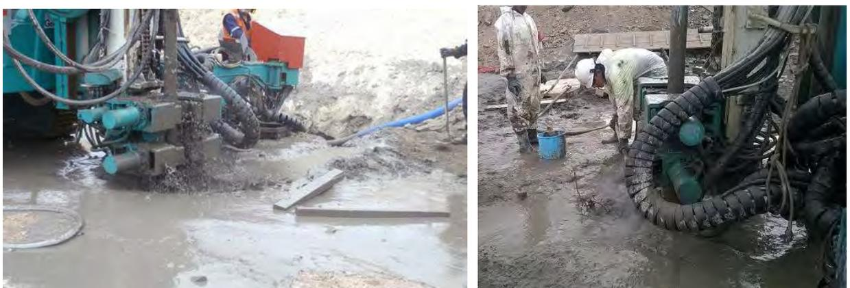
Figura 4.9. SALIDA Y TOMA DE MUESTRA DE RESURGENCIA DURANTE EJECUCIÓN DEL JETGROUTING.
