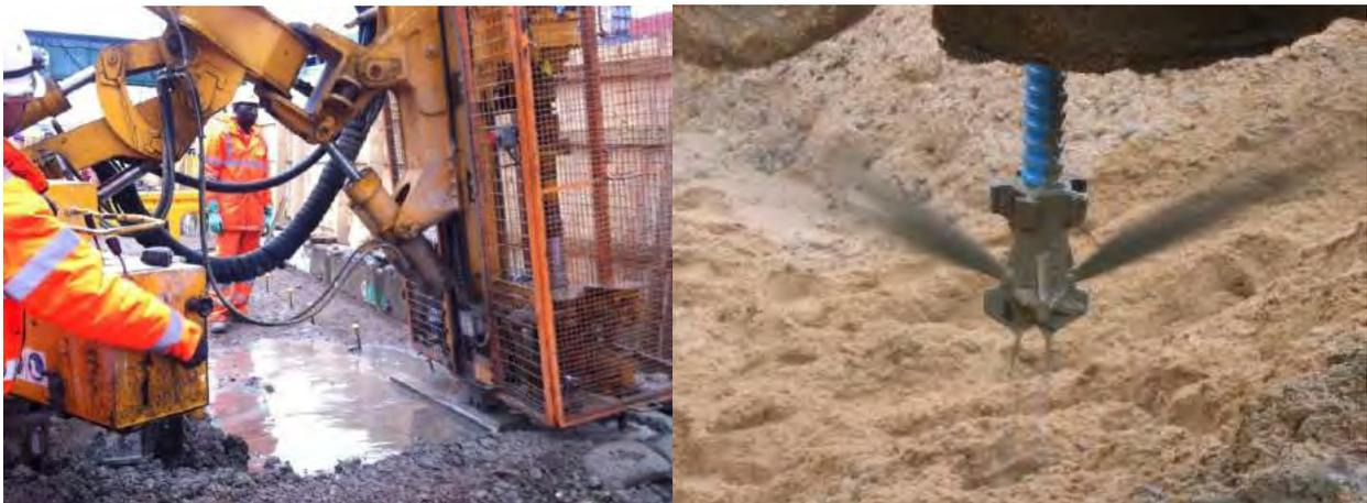
Figura 21. Instalación de un micropilote autopercutor (izqda.) y detalle de la broca y armadura del micropilote (dcha.)
