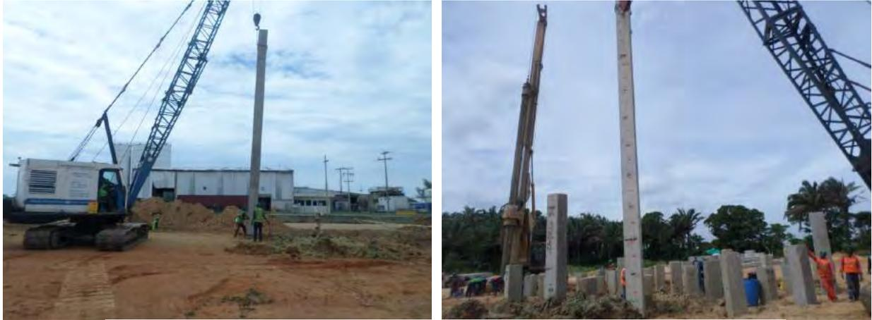
Figura 3.10. IZADO Y POSICIONAMIENTO DE PILOTES PARA LA HINCA.
