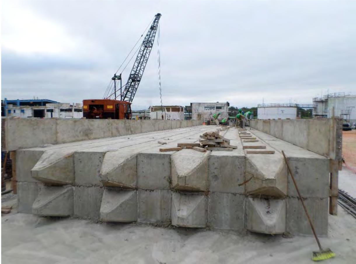
Figura 3.8. FABRICACIÓN DE LOS PILOTES.
