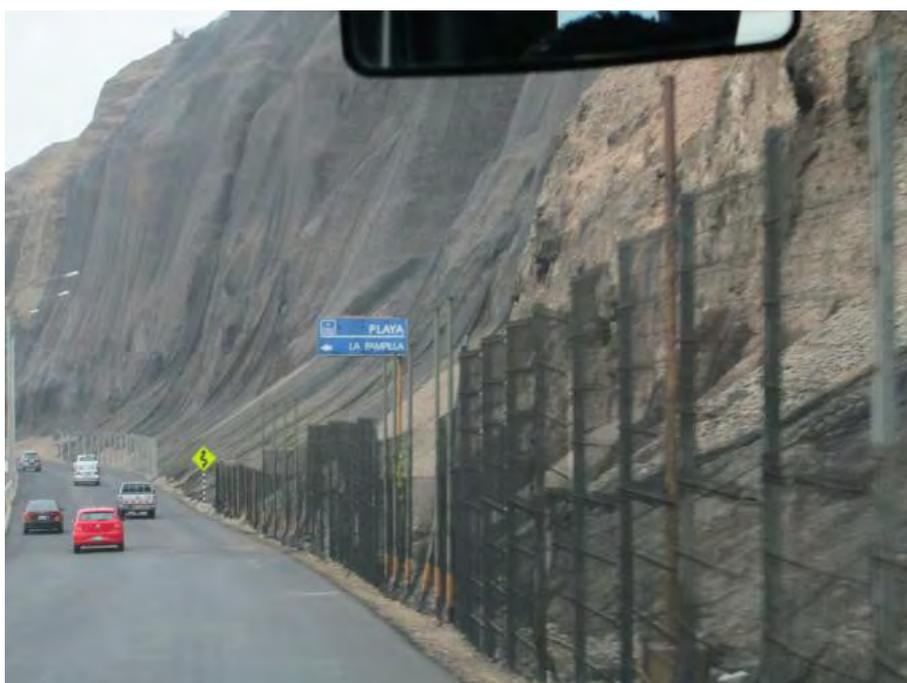
**Foto 5.2. Gravas cementadas en la costanera, con protecciones contra la caída de material suelto, por falta de cementación o acción ambiental. Foto del autor**
