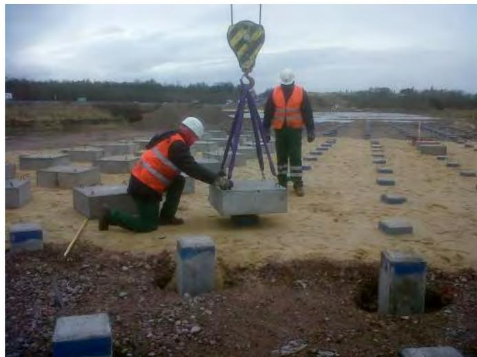
Foto 5. Colocación de los capiteles en la sección 1 del área de ensayo
