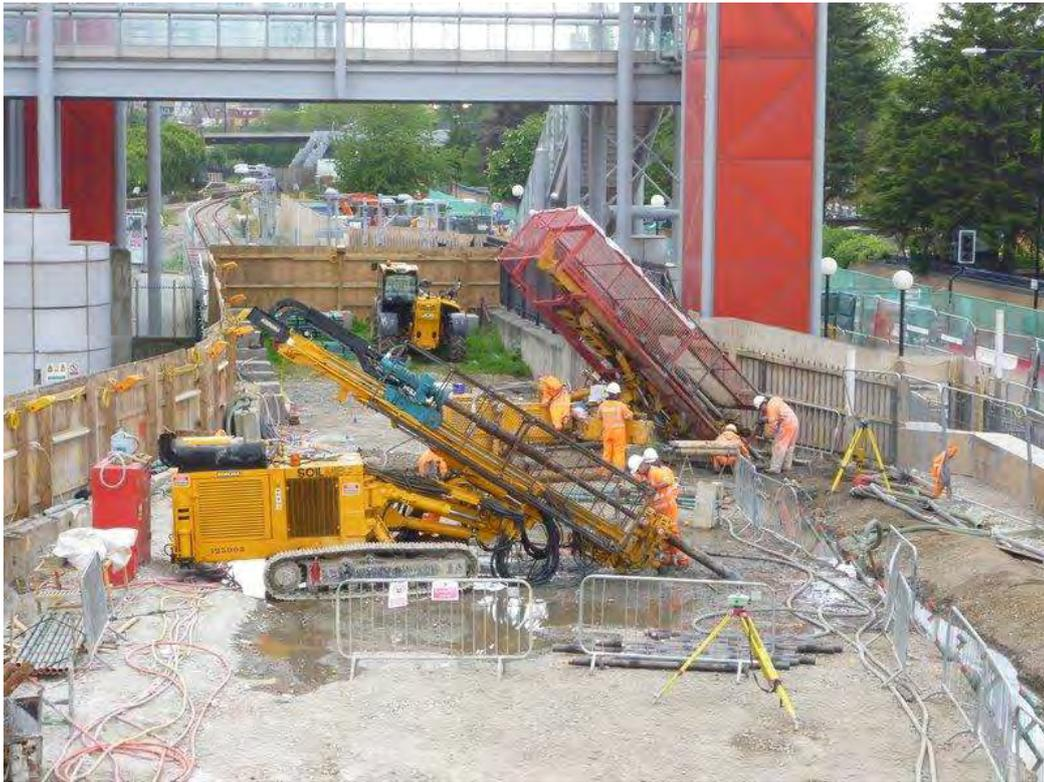
Figura 22. Trabajos de instalación de la barrera inclinada de micropilotes
