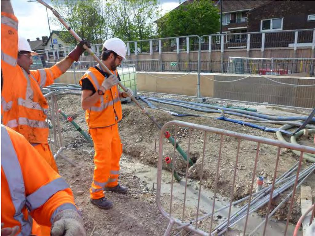
Figura 32. Introducción de la sonda HDAD-1 en uno de los taladros
