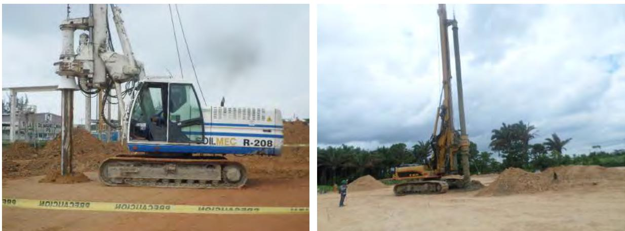
Figura 3.9. EQUIPOS DE PRE-PERFORACIÓN.
