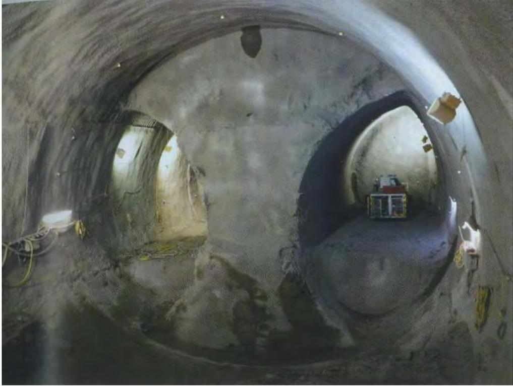
**Foto 6.2. Excavación en tres fases (Double Side Drift) (NAVARRO, y otros, 2014)**
