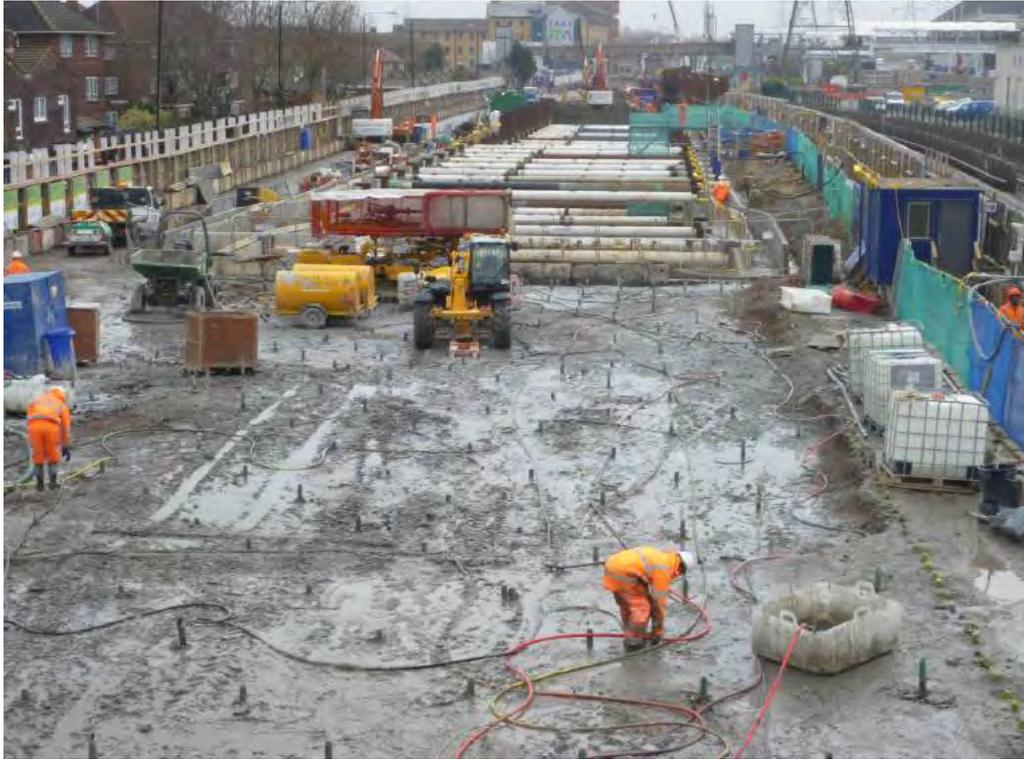
Figura 23. Malla de TAM verticales instalados en la zona a tratar al norte de la barrera de micropilotes autopercutores de protección del DLR.
