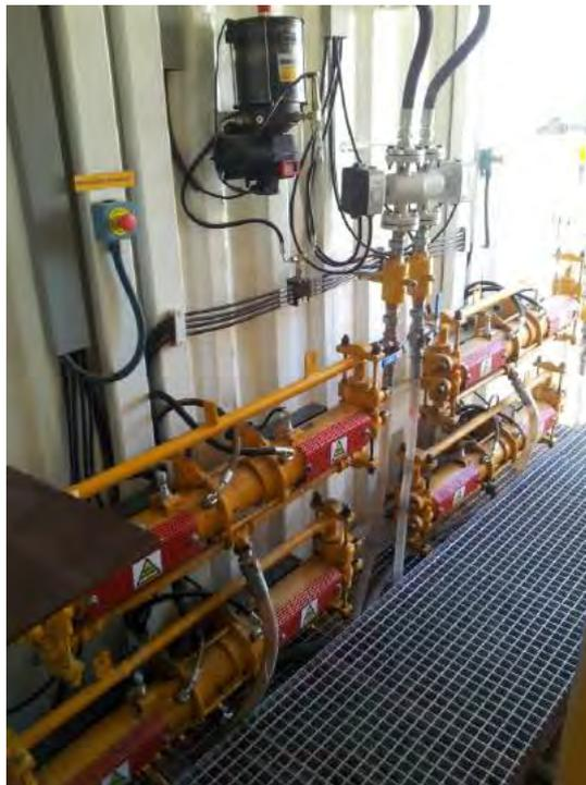
Figura 33. Contenedor con planta de inyección
