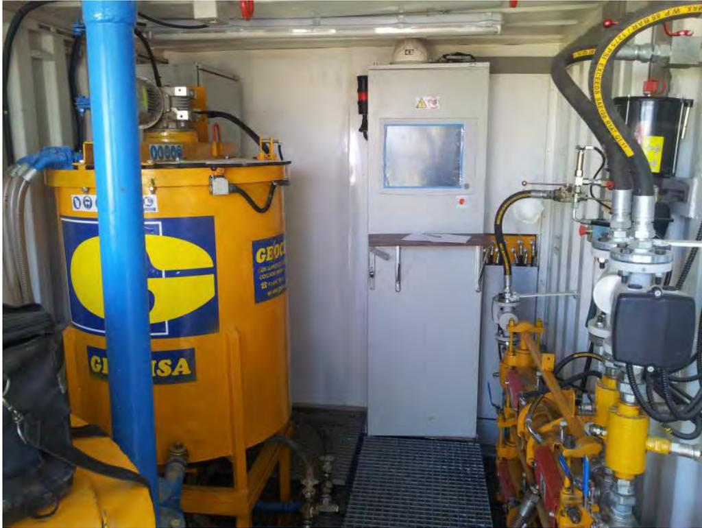
Figura 34. Contenedor con planta de inyección
