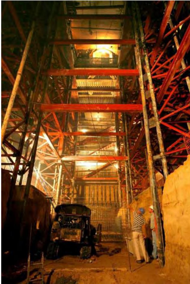
*Figura 55: Sistema de recalce por micropilotes*
