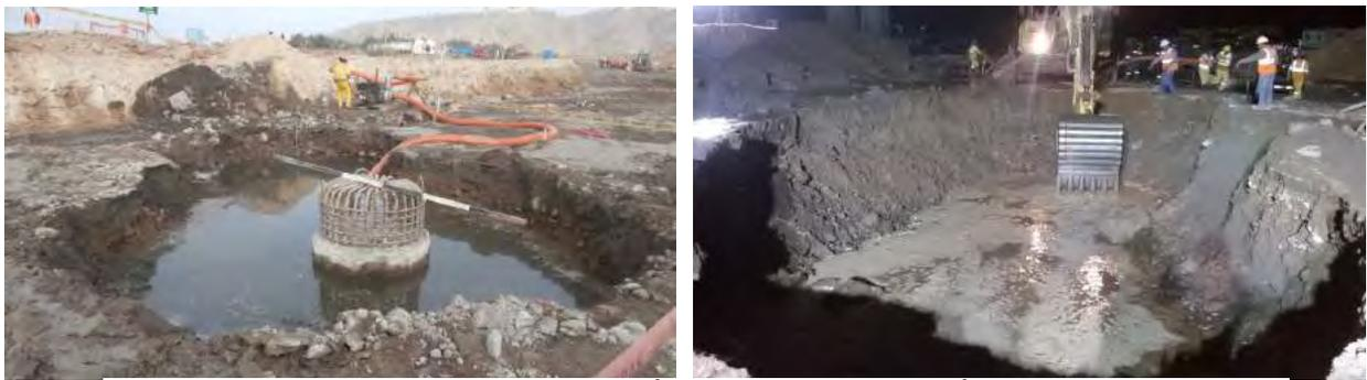
Figura 4.7. ACHIQUE DEL NIVEL FREÁTICO Y EXCAVACIÓN DE JETGROUTING.
