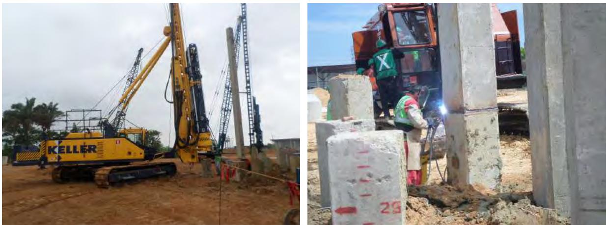
Figura 3.11. HINCA DE PILOTES Y SOLDADURA DE PLACAS DE UNIÓN.
