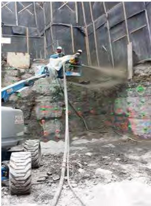
*Figura 45: Gunitado vía húmeda.*
