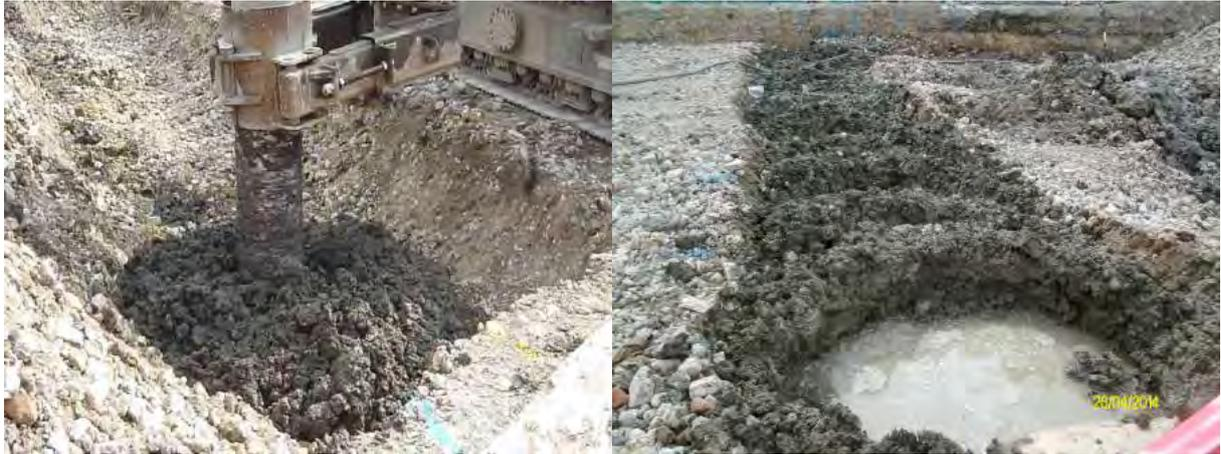
Figura 28. Ejecución de una columna de soil mixing (izqda.) y malla de columnas (dcha.)
