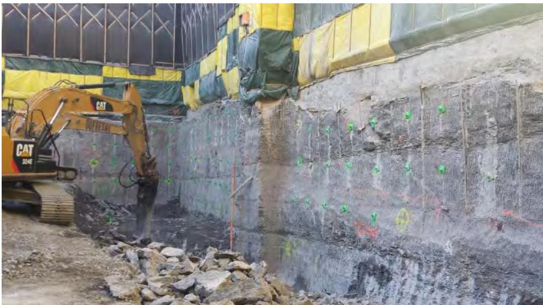
*Figura 16: Excavación de zanja perimetral, anterior a la voladura*
