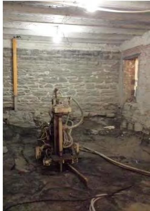
*Figura 44: Carro hidráulico TES 20*
