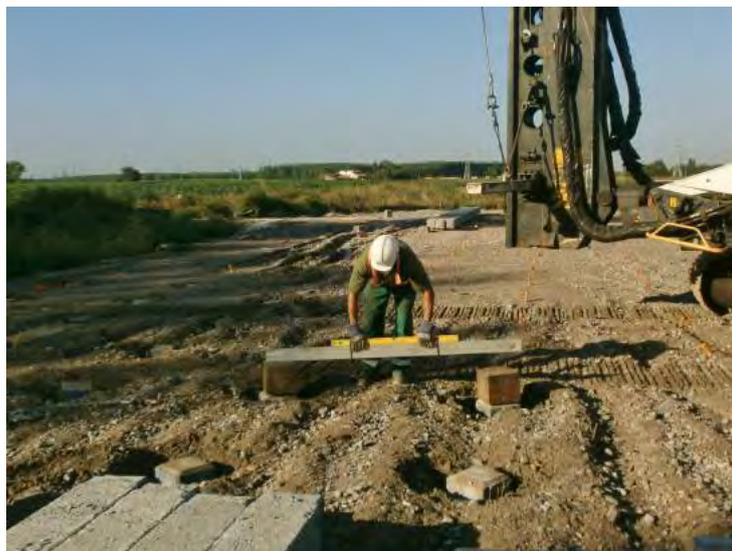
Foto 10. Comprobación de la cota final de los pilotes.
