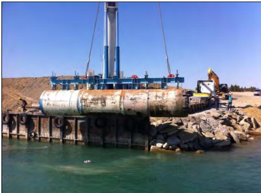
Fotografía 15. Izado de la TBM a superficie.
