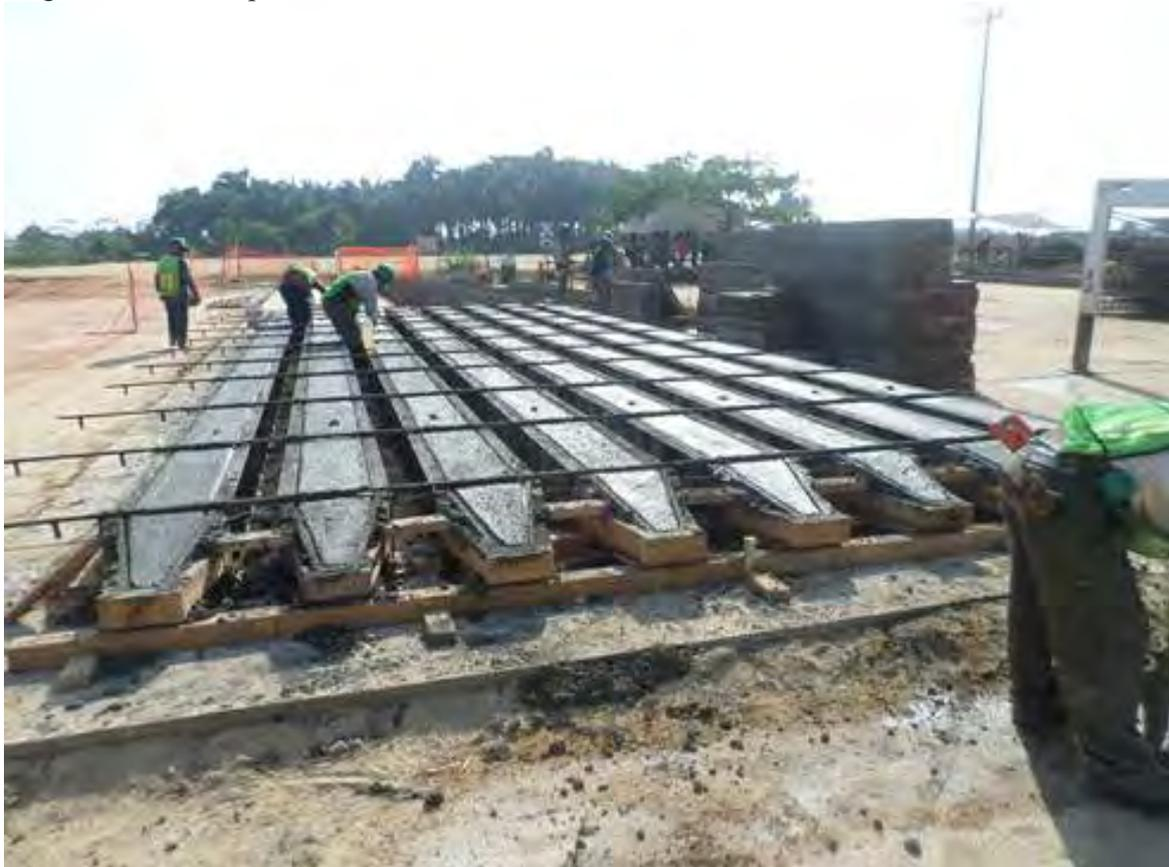
Figura 3.7. FABRICACIÓN DE LOS PILOTES.
