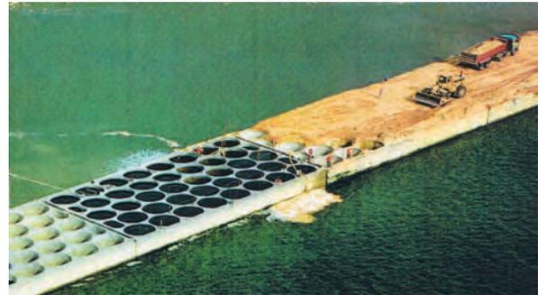
Figura 6. FONDEO DEL CAJÓN SOBRE LA BANQUETA.
