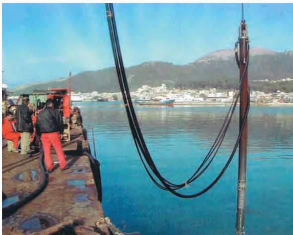
Figura 14. VISTA GENERAL DE LA EJECUCIÓN DE COLUMNAS DE GRAVA DESDE PONTONA EN IGOUMENITZA (Grecia).
