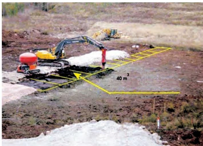
Figura 6. VISTA GENERAL DE UNA OBRA DE ESTABILIZACIÓN EN MASA.
