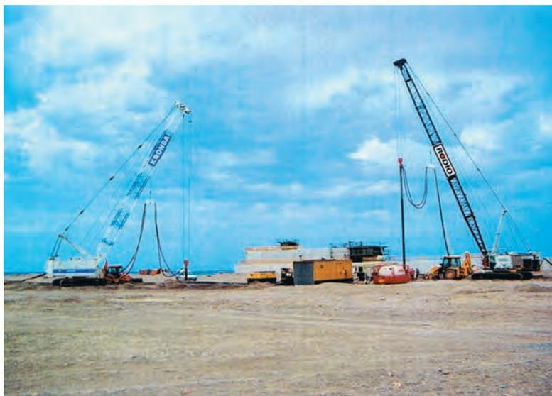
Foto 3. EQUIPOS DE VIBROCOMPACTACIÓN DE RODIO Y KRONSA EN SAGUNTO.
