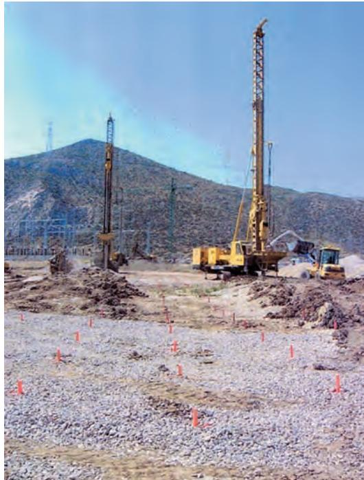
Figura 21. COLUMNAS DE GRAVA EN CENTRAL DE CICLO COMBINADO EN ESCOMBRERAS (Murcia) (Kellerterra, 2004).
