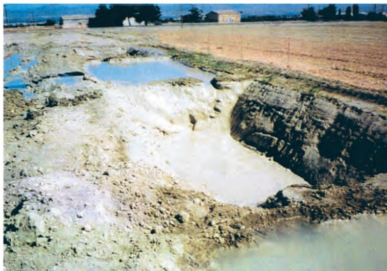
Figura 5. BALSAS DE DECANTACIÓN PARA COLUMNAS DE GRAVA EN VÍA HÚMEDA (Keller Group, 2000).
