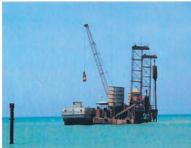
Figura 17. VISTA GENERAL DE EJECUCIÓN DE COLUMNAS DE GRAVA DESDE PONTONA EN PATRÁS (Grecia).
