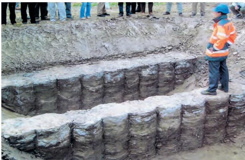
Foto 2. DISTRIBUCIÓN DE COLUMNAS DE CAL-CEMENTO EN FILA O PANEL.
