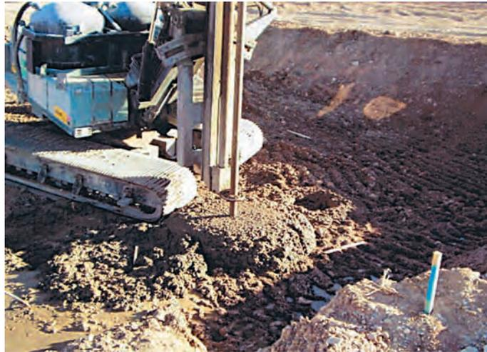
Foto 8. EQUIPO DE TERRATEST EJECUTANDO COLUMNAS DE PRUEBA.
