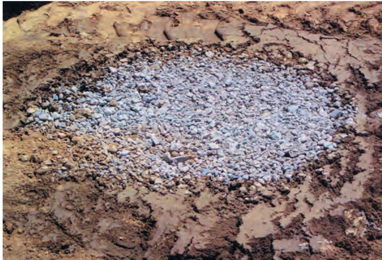
Figura 10. COLUMNA DE GRAVA EJECUTADA EN VÍA SECA (Kellerterra, 2005).
