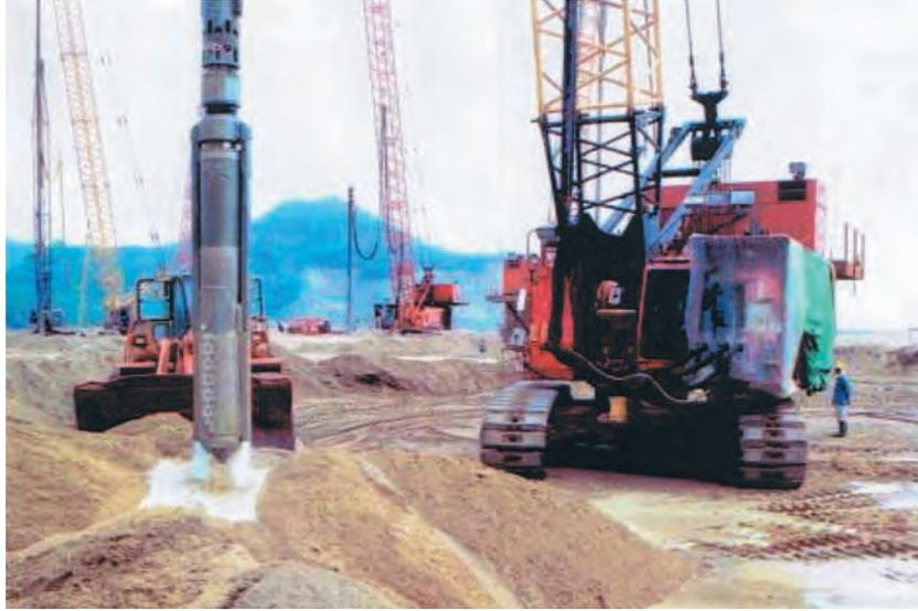
Foto 4. EQUIPOS DE VIBROCOMPACTACIÓN.
