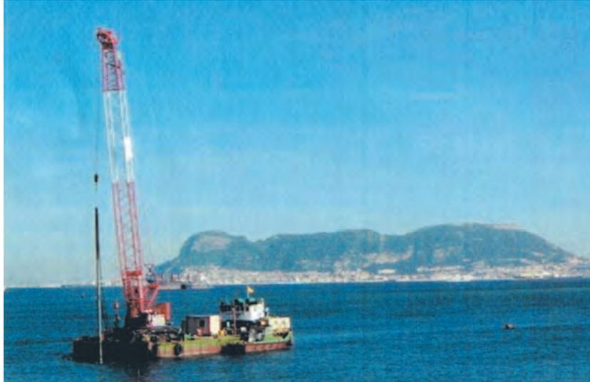
Figura 19. VISTA GENERAL DE EJECUCIÓN DE COLUMNAS DE GRAVA DESDE PONTONA EN EL PUERTO DE ALGECIRAS.
