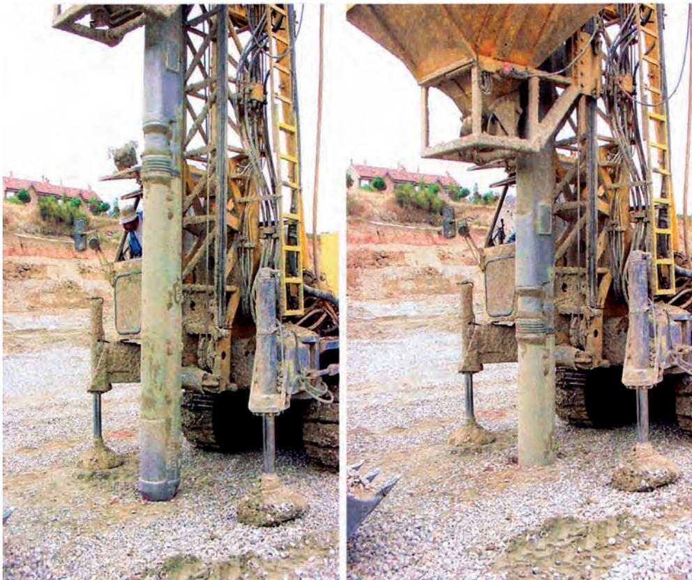
Figura 8. INICIO DE LA EJECUCIÓN DE UNA COLUMNA DE GRAVA EN VÍA SECA EN BOADILLA (Madrid) (Kellerterra, 2003).
