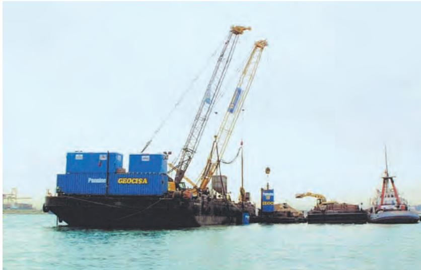
Figura 21. VISTA GENERAL DE EJECUCIÓN DE COLUMNAS DE GRAVA DESDE PONTONA EN EL PUERTO DE VALENCIA.
