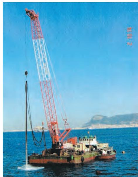
Figura 7. MÉTODO DE LA BANQUETA DE GRAVA.
