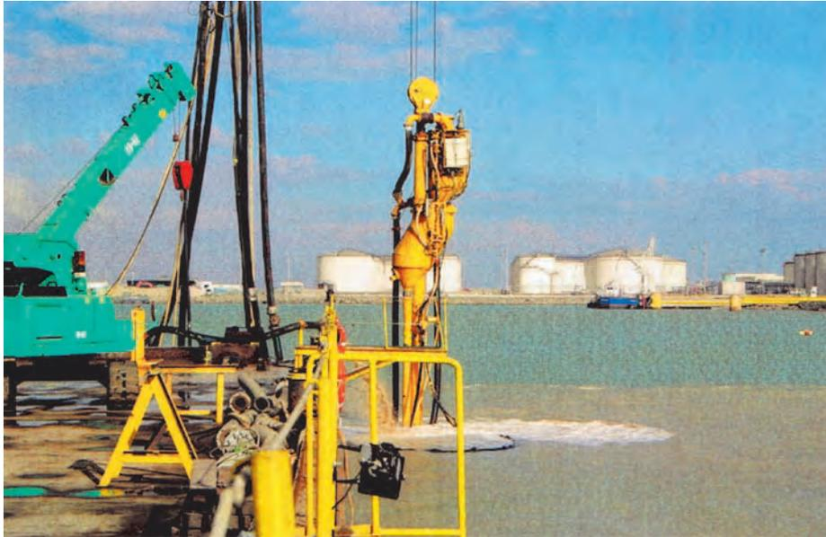
Figura 17. COLUMNAS DE GRAVA «OFF-SHORE» CON EL SISTEMA S-ALPHA DE KELLER EN EL PUERTO DE VALENCIA (Kellerterra, 2006).
