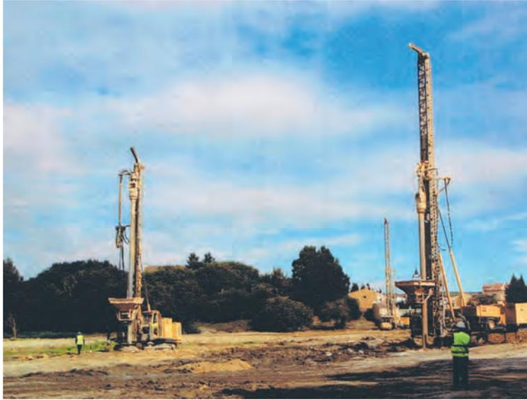
**Figura 19. COLUMNAS DE GRAVA EN VÍA SECA PARA 250 VIVIENDAS EN LOS BARRIOS (Cádiz) (Kellerterra, 2005).**
