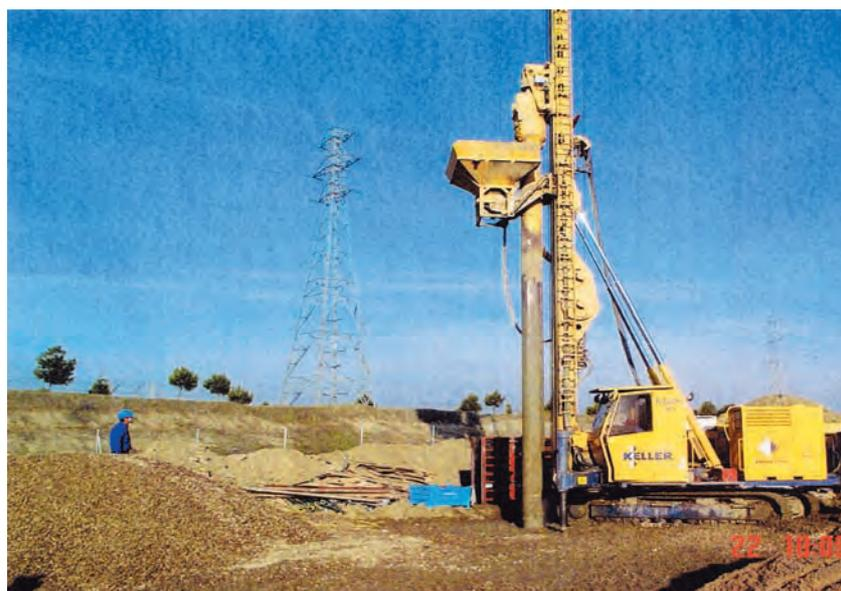
Figura 9. EQUIPO DE EJECUCIÓN DE COLUMNAS DE GRAVA EN VÍA SECA EN GETAFE (Madrid) (Kellerterra, 2004).
