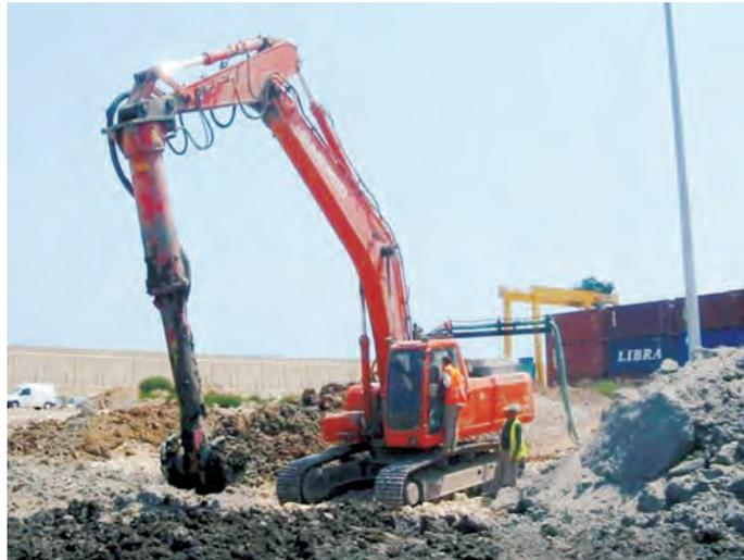
Figura 3. RETROEXCAVADORA CON EL MEZCLADOR DISPUESTO EN EL EXTREMO DE SU BRAZO.
