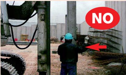
Al cortar la armadura de los pilotes en el descabezado, el trabajador se sitúa bajo el descabezador.
