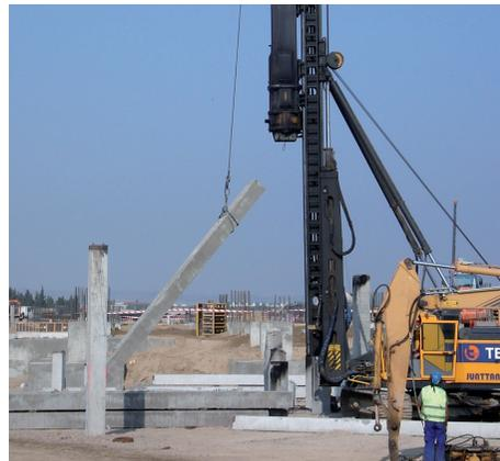
Izado del pilote con cadena de seguridad.
