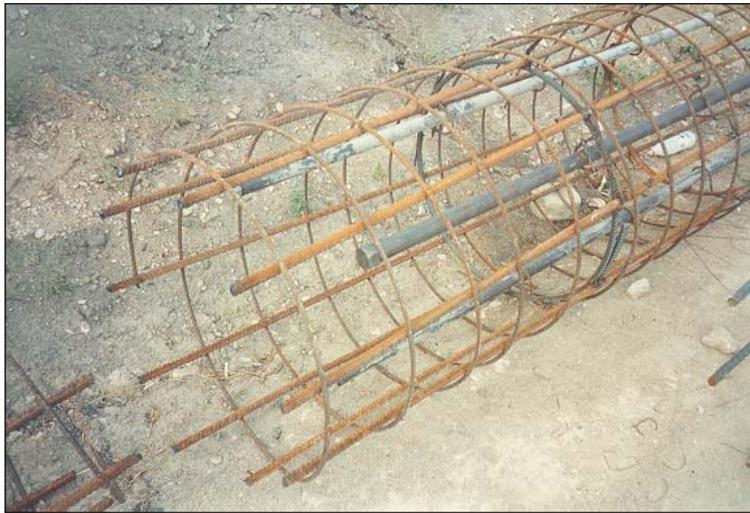
FIG. 2.23.- MALA INSTALACIÓN DE LOS TUBOS EN PUNTA
