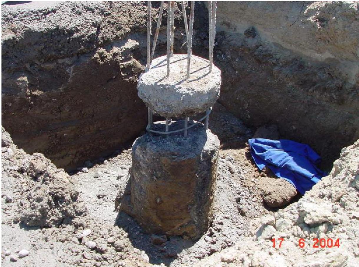
FIG. 3.22.- PILOTE CORTADO EN CABEZA
