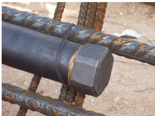
FIG. 2.15 TAPÓN METÁLICO EN EL FONDO DEL TUBO
