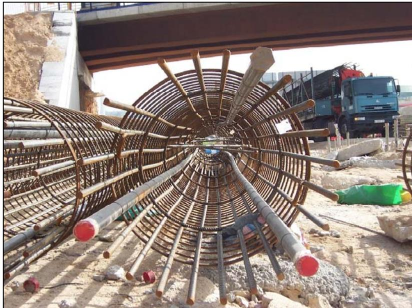
FIG. 2.21 TUBOS COLOCADOS ANTES DE DESCENDER LA ARMADURA
