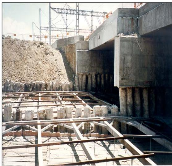
FIG. 3.42.- PANTALLA DE PILOTES CONVIGA DE ATADO EN CABEZA
