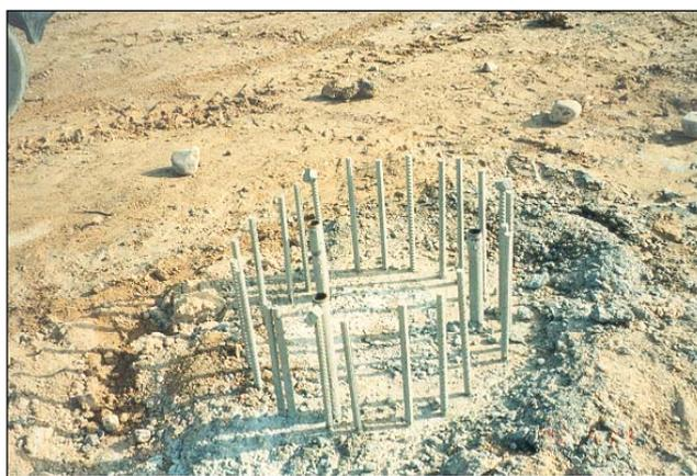
FIG. 2.17.- INSTALACIÓN DE 3 TUBOS EN PILOTE
