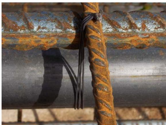
FIG. 2.20.- FIJACIÓN DEL TUBO DE AUSCULTACIÓN
