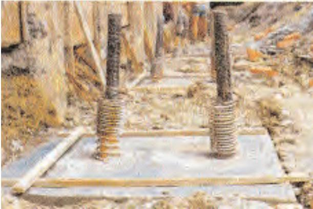
*Armaduras formadas por barras roscadas que mejoran la adherencia y en las que se puede colocar una tuerca*
