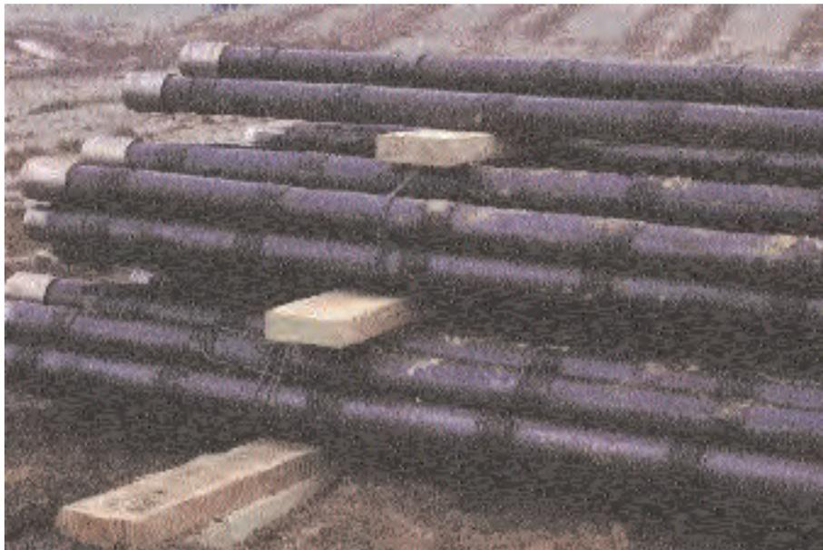
Fig.1b - Armaduras de micropilotes: tubo de Ø114 mm. Viaducto de Ath, Bélgica, 1992.
