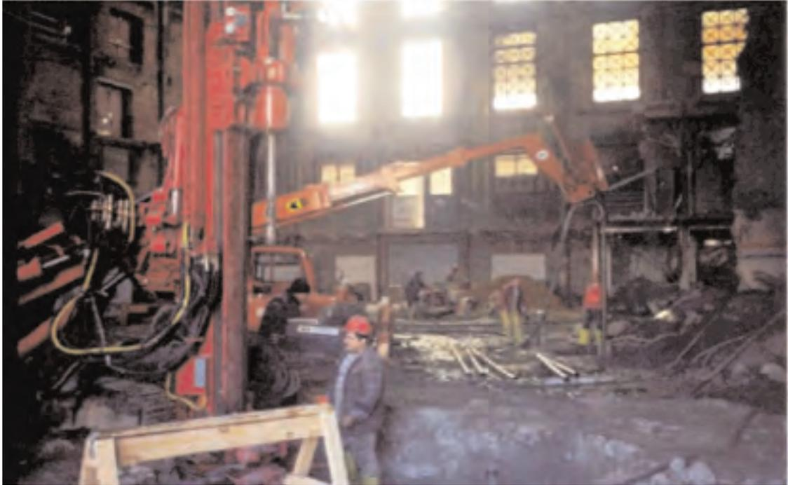
*Fig. 9: Ejecución perforación e inyección separadas*
