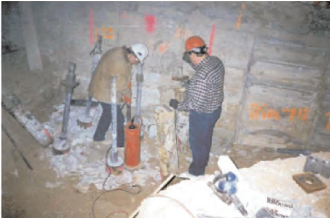
*Fig. 12: Colocación placas de anclaje con tuerca y contra tuerca*
