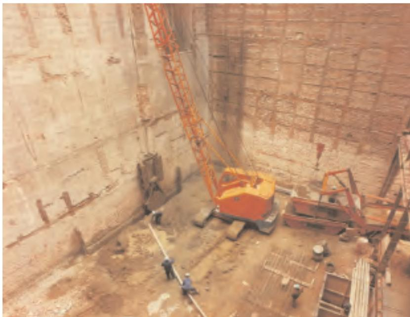
Fig.: 1.11 Equipo de pantallas trabajando junto a una medianería
