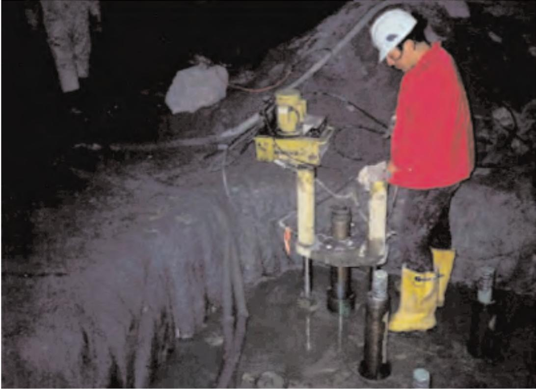
*Fig. 11: Extracción tubería de inyección con gatos*
