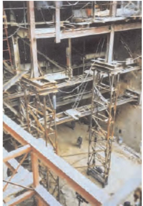
Figura 1.18: Grupos de 4 micropilotes arriostrados entre sí, para soporte de pilares.
