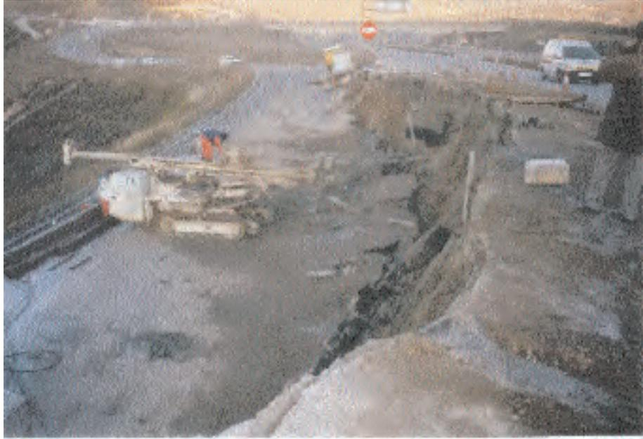
Este deslizamiento afecta a la calzada principal de la autovía, y deja al descubierto los micropilotes de la pantalla en ejecución, procediendo a restringir el tráfico en el carril derecho de la autovía por precaución. A la vista de esta situación se toman las siguientes medidas:
