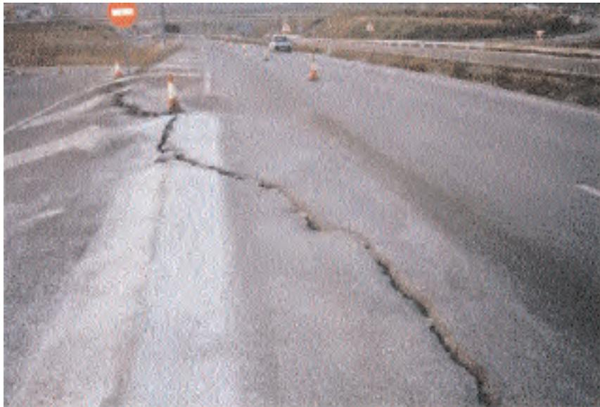
Paralelamente se decide construir una pantalla de micropilotes en la plataforma de la autovía, protegiendo los dos carriles de la calzada principal para evitar el corte del tráfico.
