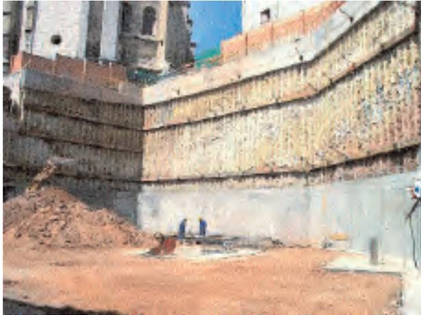
FOTO 13: Vaciado completado y primera fase de muro-forro ejecutado (Zona 1 y 1').
