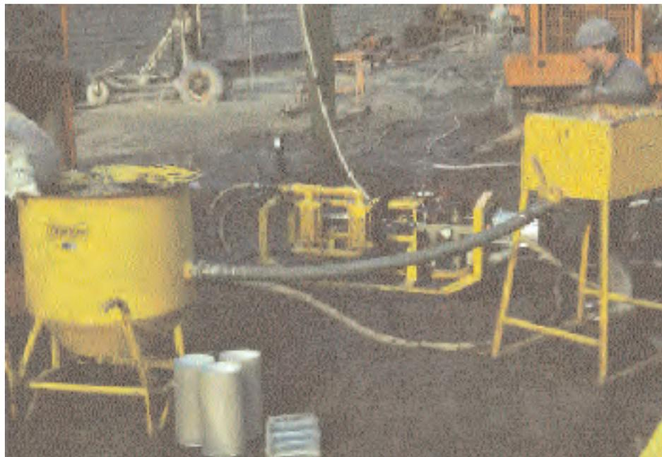
*Fig.9b – Equipo ligero de fabricación de lechada y de inyección. Verdun, 1983.*
