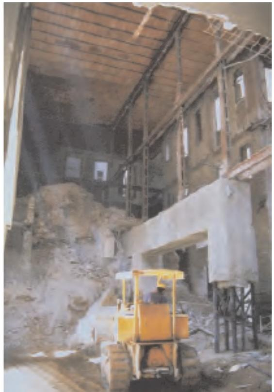
Figura 1.21: Construcción de los pilares definitivos, englobando las armaduras de los micropilotes.
