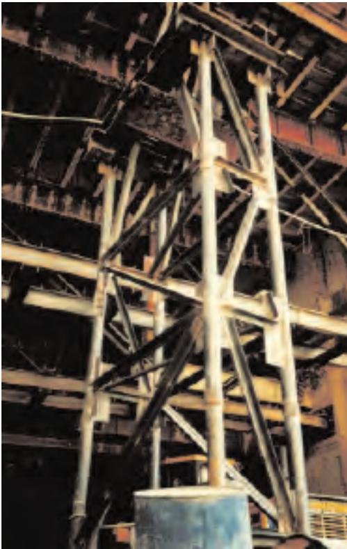
Figura 1.17: Soporte de pilares mediante grupos de 4 micropilotes arriostrados entre sí, tras descarnar su armadura.
