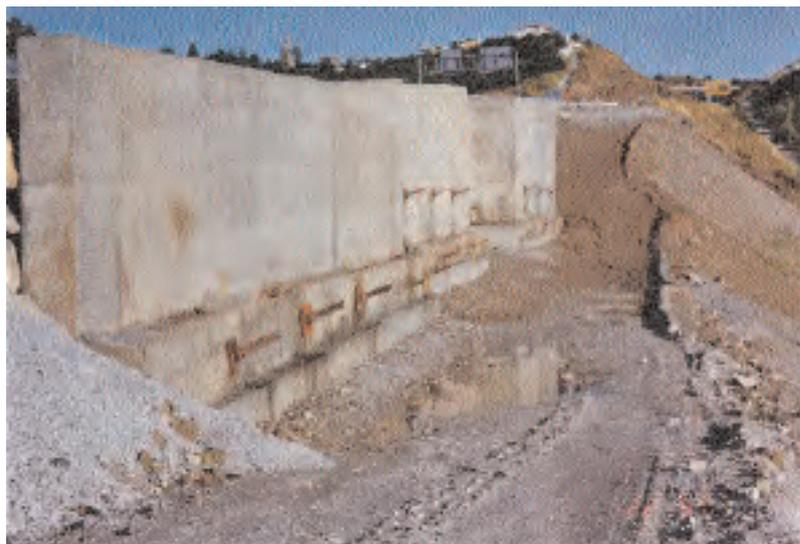
Como se puede apreciar en la anterior fotografía, el muro de recrado bajo las pantallas es de más de 0,50 m, movimiento que hubiera impedido la restitución del tráfico hasta completar las medidas de estabilización del pie del terraplén de no haber sido por la ejecución de las pantallas de micropilotes de la parte superior.
