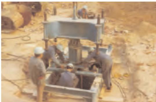
*Fig. 1.5: Aplomado de pilares metálicos en pilotes.*
