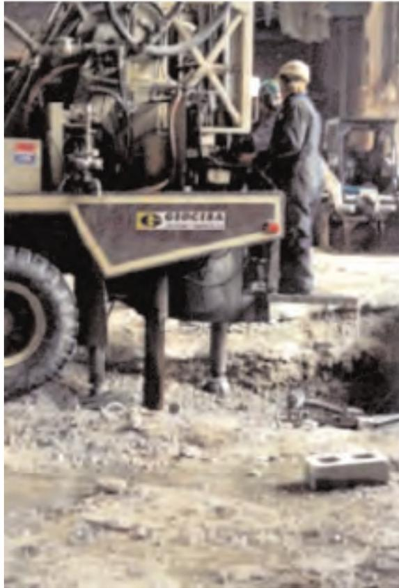
*Fig. 13: Perforación a rotapercusión relleno ( $\varnothing = 8''$ ) y colocación revestimiento perdido ( $\varnothing = 6''$ )*
