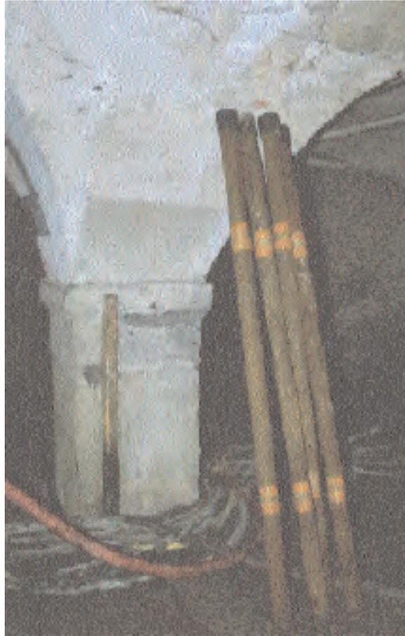
*Fig.5 – Vista de tubos de  $\varnothing 127$  mm con sus manguitos. Recalce de un sótano del siglo XVI, Lure 1992.*
