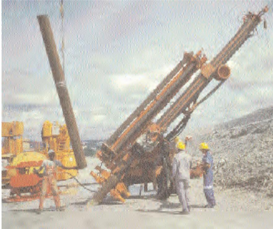
Fig.7b - Equipo pesado de perforación. Ejecución de los micropilotes para el terminal de Pointe des Grives, Martinica, 1999.
