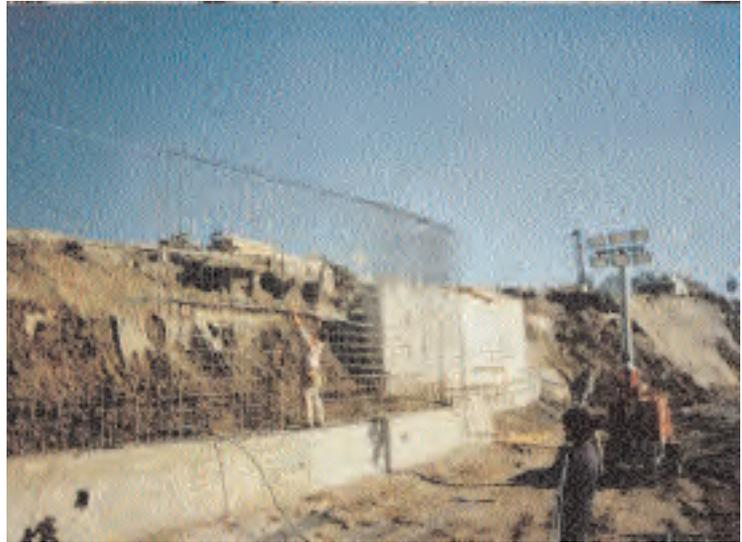
Estos sistemas se pueden entender como una pantalla de contención en la vertical del punto de unión de los pilotes constituida por los micropilotes verticales y una zona que recibe los empujes de las tierras formadas por los micropilotes inclinados. Debido a la inyección del terreno la mejora del suelo contenido entre los dos elementos es difícil de evaluar, constituyendo en realidad un muro de gravedad en el que las líneas de extensión las definen los micropilotes.
