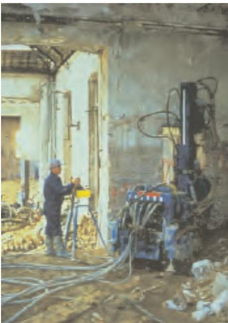
*Figura 2.10: Equipo de ejecución de micropilotes trabajando en el interior del Edificio de Caballerizas.*
