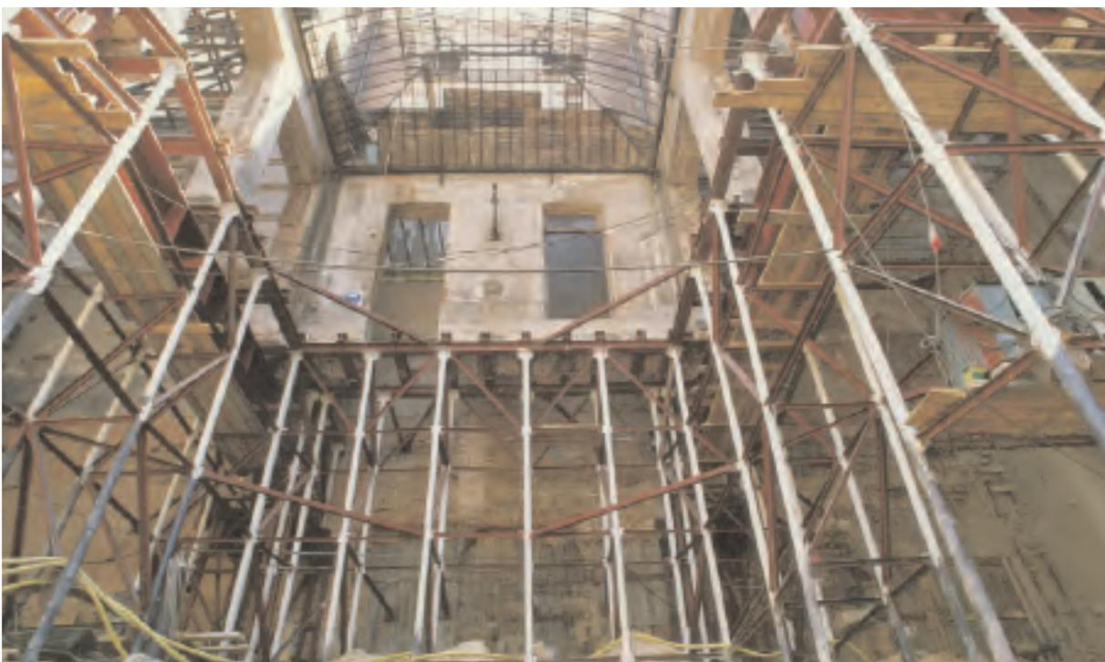
*Figura 2.11: Los micropilotes, una vez arriostrados y soportando los muros del edificio.*
