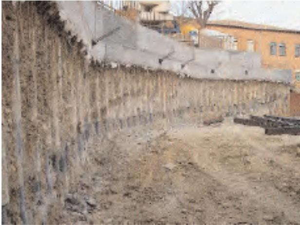
*FOTO 8: Nivel de anclajes en viga de coronación.
