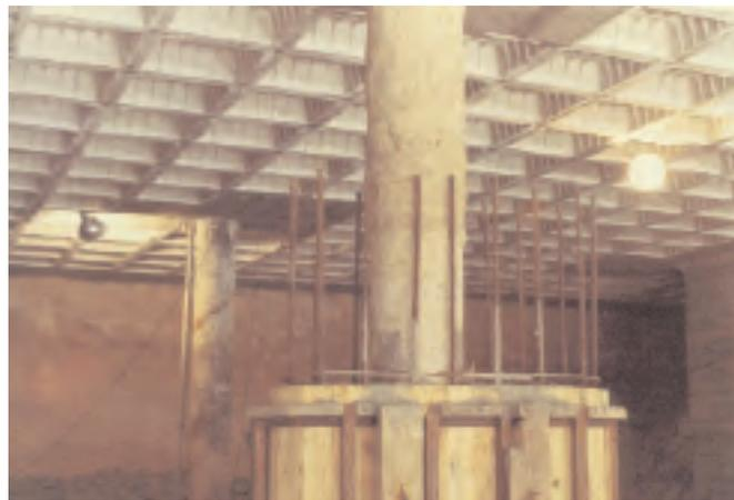
*Fig. 1.8: Recricado de los pilotes después de excavados los sótanos.*
