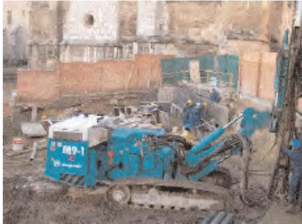
FOTO 6, 7: Perforación de los micropilotes
