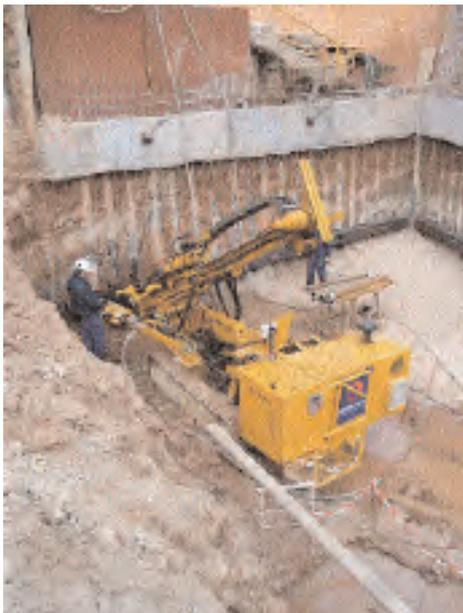
*FOTO 9: Perforación de anclaje del segundo nivel
