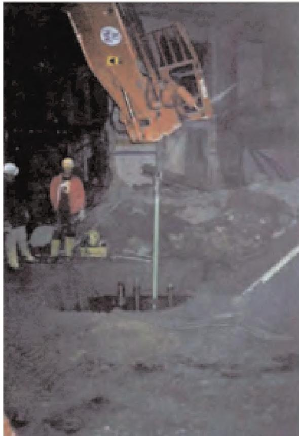
*Fig. 10: Colocación armadura ( $\varnothing = 2.5''$ ,  $f_{yk} = 5.600 \text{ kg/cm}^2$ ,  $L = 15 \text{ m}$ )*
