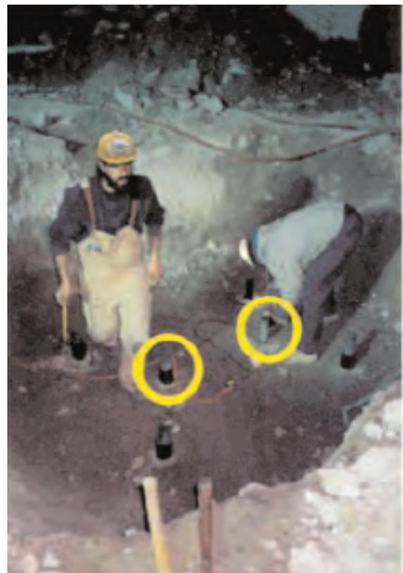
Fig. 7: Micropilote central relocalizado por obstrucción
