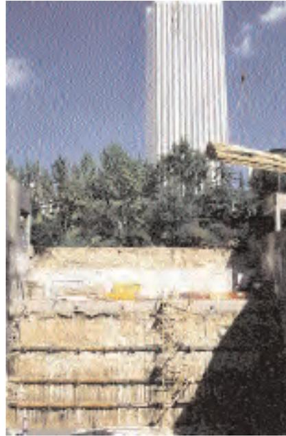
*Construcción de viga de coronación en pantallas de micropilotes*
