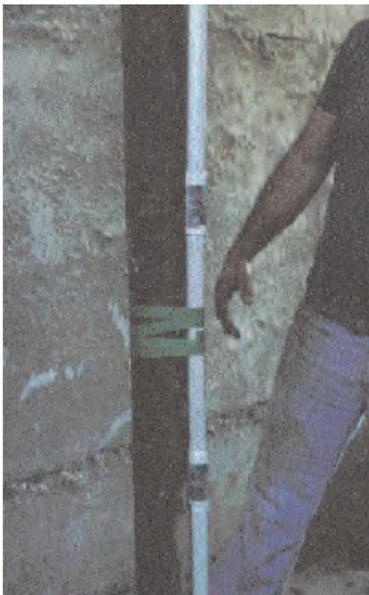
Fig.3b - Tubo-manguito lateral con su armadura constituida por un tubo de  $\varnothing 178/152$  mm. Recalce del puente de Mandelieu, 1982.
