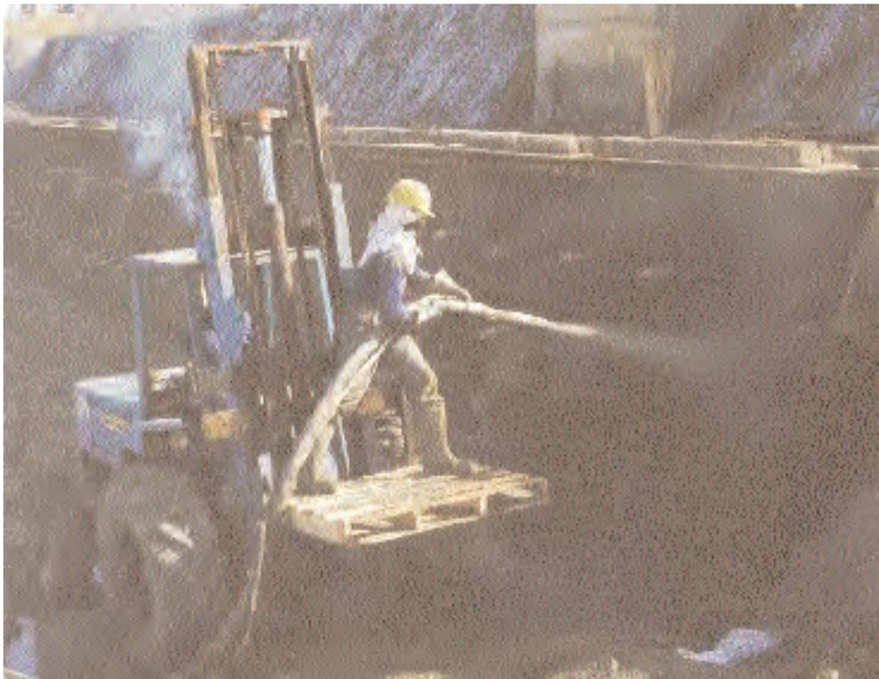
*Fig.19b - Construcción de uno de los muros de contención, fundado sobre micropilote. Notar el empleo de gunita para mejorar la estabilidad de los terrenos durante la fase intermedia de realización.*
