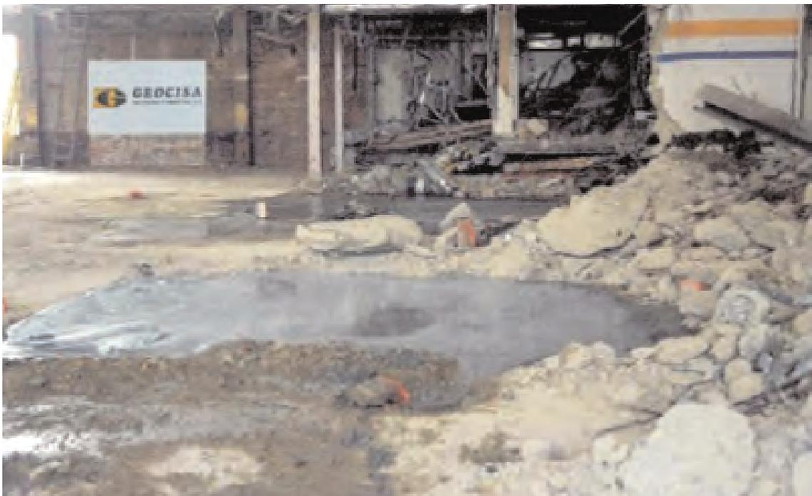
*Fig. 14: Relleno de "pre-agujeros" con mortero de baja resistencia*
