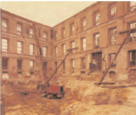
Fig. 1.13 Vista interior, con las fachadas arriostradas.
