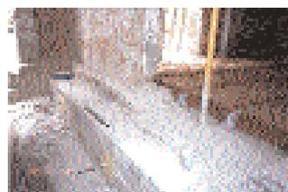
*Ejecución de micropilotes / vigas paralelas / pasadores de unión*
