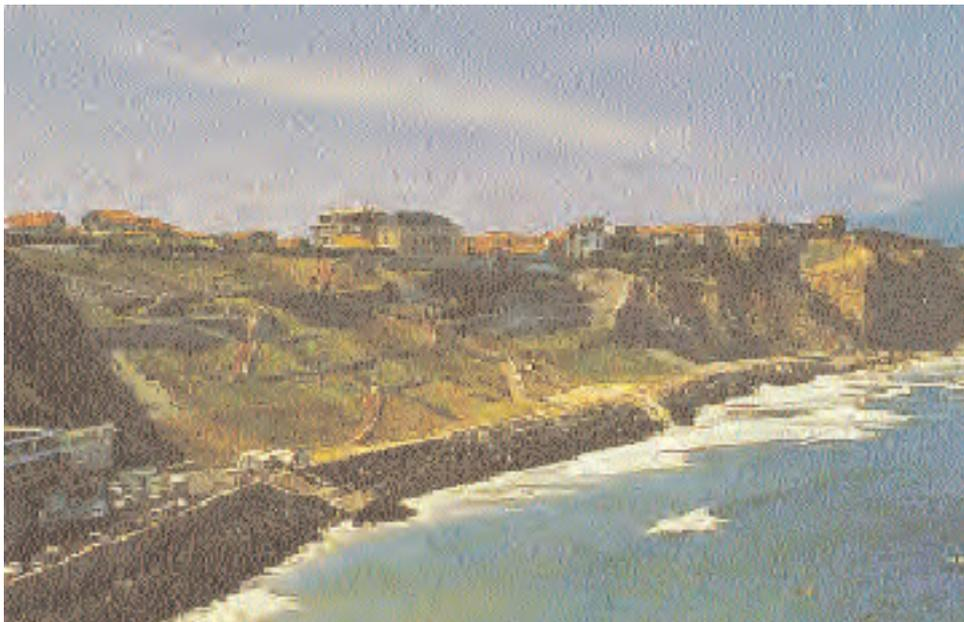
*Fig.20 – Biarritz. Estado final del acantilado hoy día, después de su reperfilado y estabilización. A la derecha se observa la parte del acantilado aún no estabilizada.*
