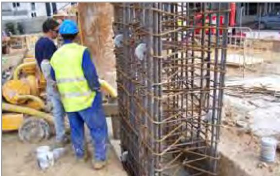
Figura 33. Colocación de separadores
