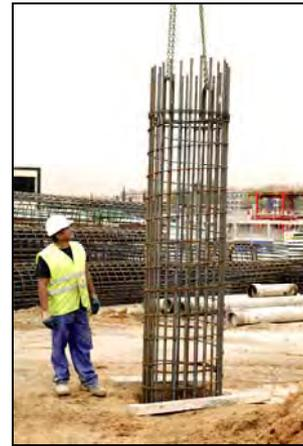
**Figura 5** Colocación de armadura
