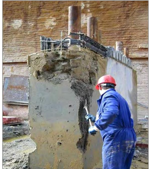
Figura 39. Detalle de zonas sin hormigón
