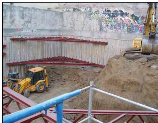
**Figura 9** *Ejemplo de sostenimiento de pantallas de pilotes secantes (arriostramientos)*
