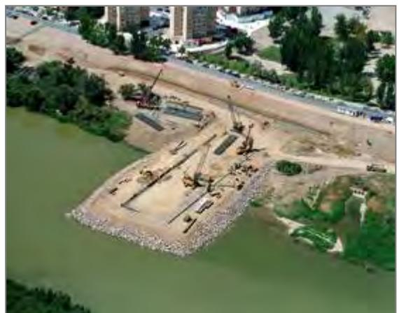
Figura 1. Construcción de una península artificial para formar la plataforma de trabajo
