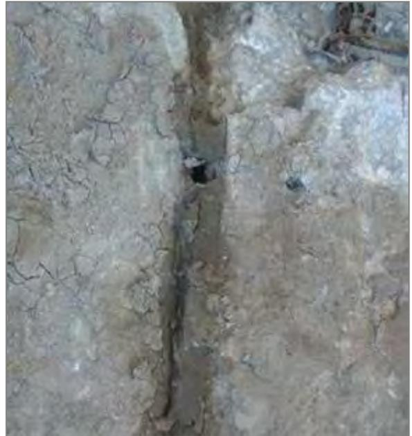
Figura 21. Juntas en mal estado por trabajo con lodos de alta densidad y viscosidad
