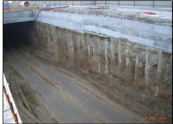
**Figura 7** *Detalle de viga de coronación ejecutada para pantalla discontinua de pilotes*
