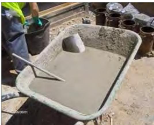
Figura 44. Hormigón segregado
