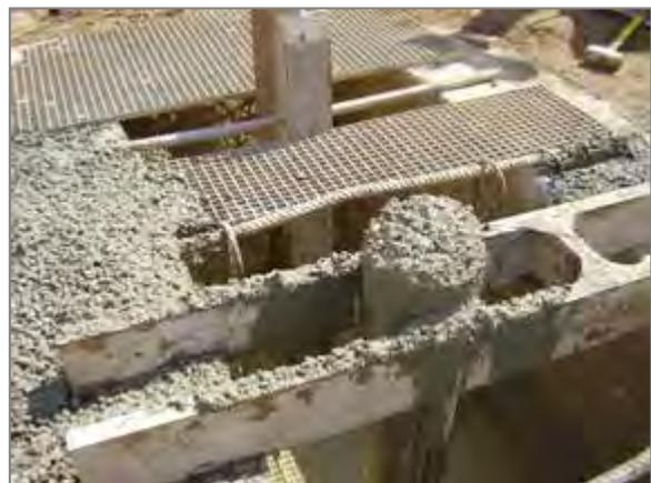
Figura 45. Atascos en tubería Tremie por mala dosificación de hormigón
