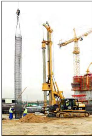
**Figura 4** Izado y centrado de la armadura
