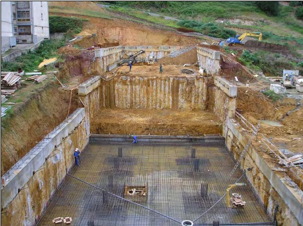
**Figura 10** Panorámica de obra ejecutada con pantallas de pilotes secantes a distintos niveles
