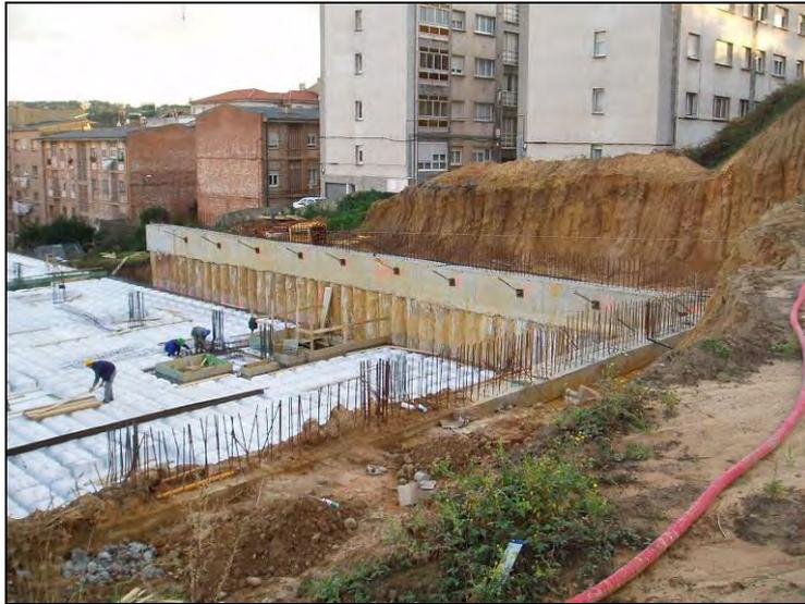
**Figura 1** Aspecto general de pantalla de pilotes secantes con anclajes en viga de coronación
