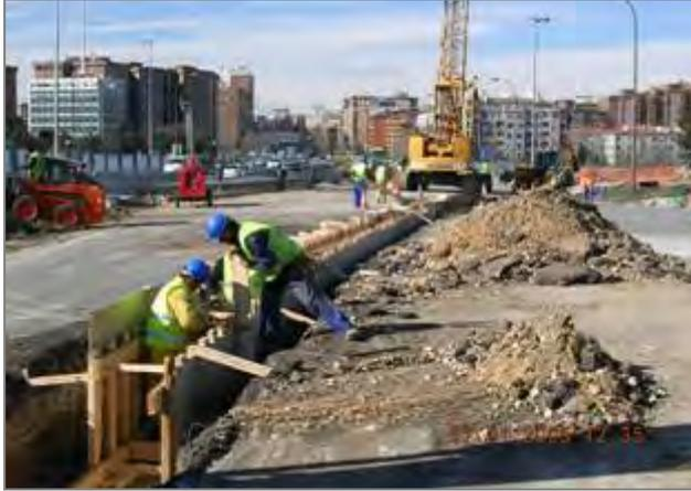
Figura 8. Encofrado a una cara del murete guía
