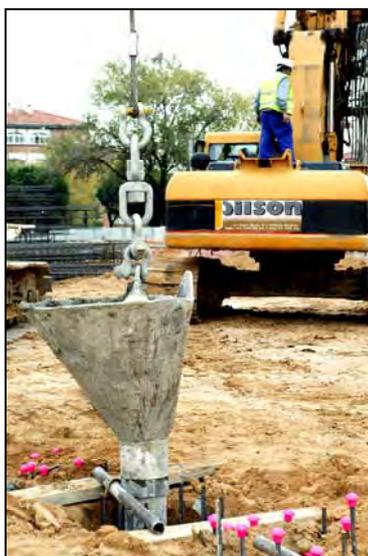
**Figura 6** Colocación del tubo tremie para el hormigonado del pilote
