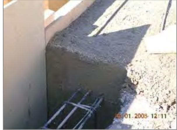
Figura 9. Esperas de conexión entre tramos del murete
