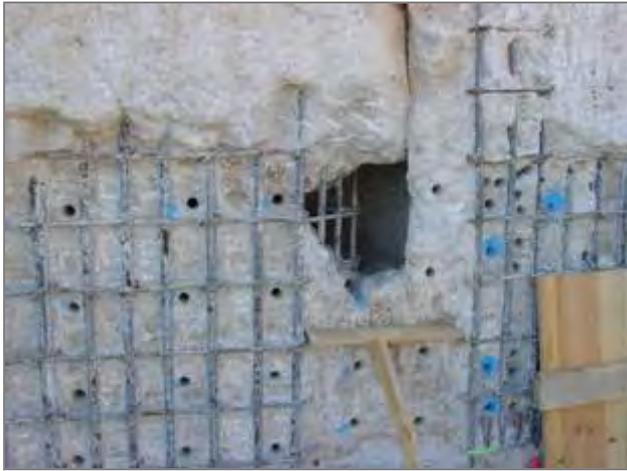
Figura 20. Bolsa de arena sin hormigón debido a un contenido elevado de arena
