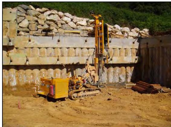
**Figura 8** *Ejemplo de sostenimiento de pantallas de pilotes secantes (anclajes)*
