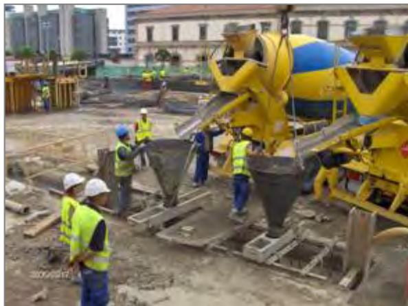
Figura 7. Soporte de jaulas y elementos de hormigonado
