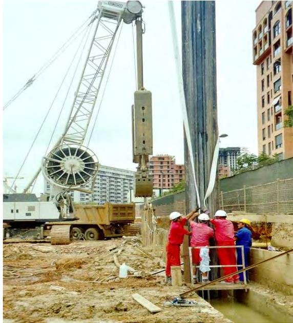
**COLOCACION DE DOBLE JUNTA WATER - STOP**
