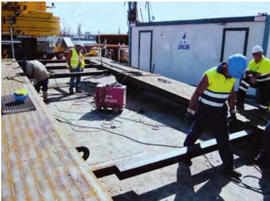
Figura 17. CONSTRUCCIÓN DE LA PLATAFORMA SUPLEMENTARIA DE TRABAJO.
