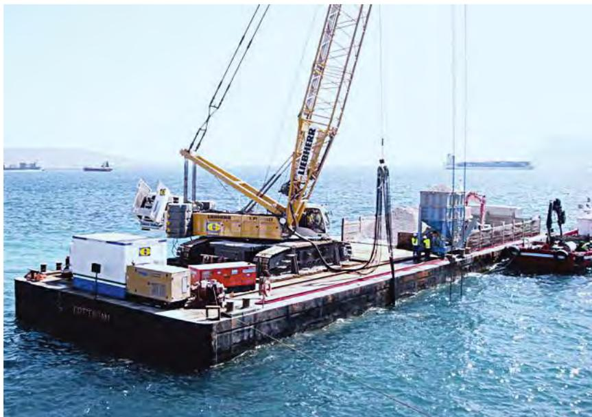
Figura 4.2. MÉTODO CON TANQUE SUPERIOR DE GRAVA Y ALIMENTACIÓN POR EL FONDO (Vista general).
