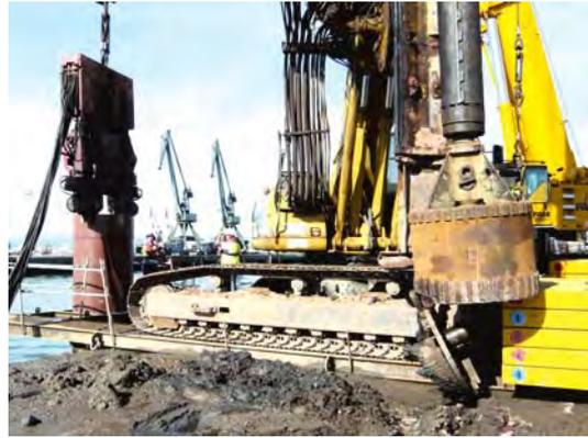
Figura 25. ALIGERAMIENTO DEL TERRENO INTERIOR CON EL EQUIPO DE PILOTES.
