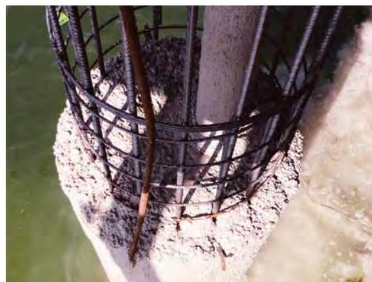
Figuras 32 y 33. HORMIGONADO DEL PILOTE.
