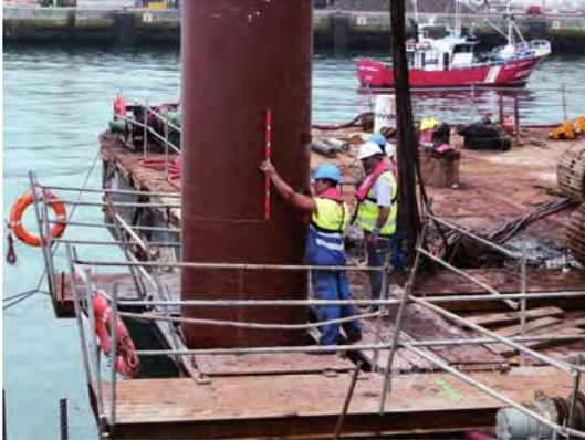
**Figura 41. COMPROBACIÓN DE LA VERTICALIDAD DE LA ENTUBACIÓN.**
