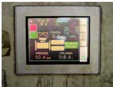
**Figura 26. SISTEMA AUTOMATIZADO DE ADQUISICIÓN DE DATOS (Incorporado a la bomba de inyección).**
