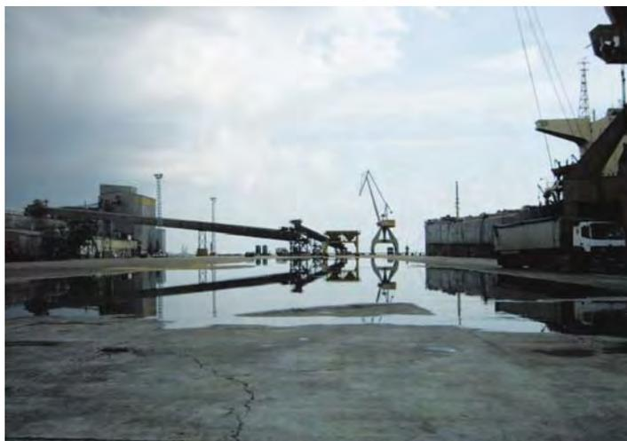
Figura 8. VISTA GENERAL DEL MUELLE (Se aprecian los asientos en la explanada).
