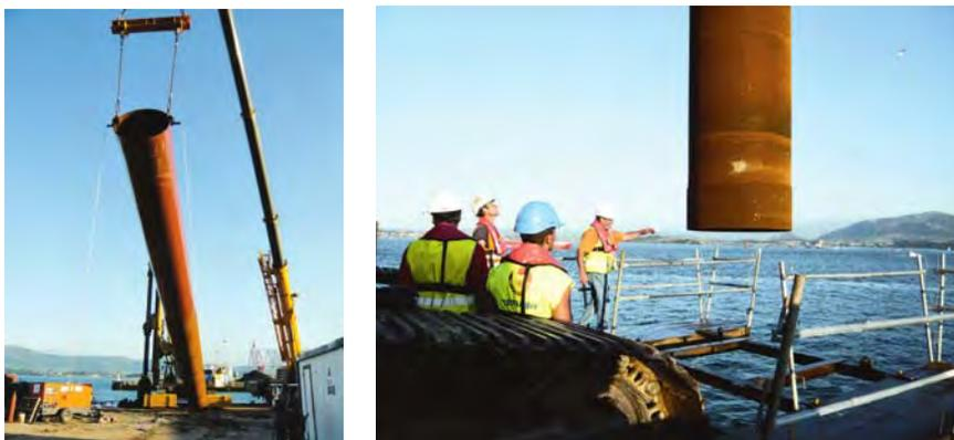
**Figuras 21 y 22. IZADO Y COLOCACIÓN DE LA CAMISA PERDIDA EN EL INTERIOR DEL MARCO-GUÍA.**
