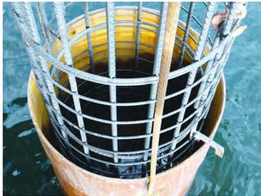
Figura 29. ARMADURA SUSPENDIDA DE LA CAMISA PERDIDA EN SU POSICIÓN DEFINITIVA.
