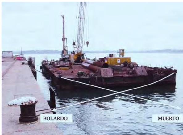
**Figura 38. CABRESTANTES TRASEROS PARA EL POSICIONAMIENTO Y SUJECCIÓN DE LA PONTONA.**
