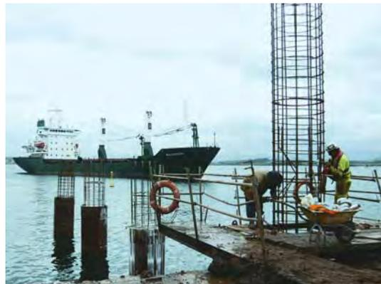
**Figura 44. INSTALACIÓN DE LA ARMADURA.**
