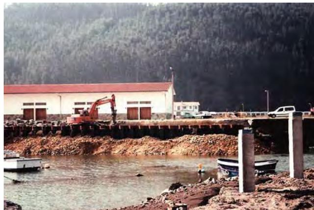
Figura 29. PILOTES HINCADOS (Al fondo: la pantalla de tablestacas junto al almacén).
