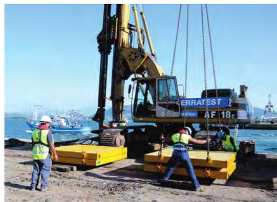
Figura 20. COLOCACIÓN DE CONTRAPESOS EN LA PARTE POSTERIOR DE LA PLATAFORMA.
