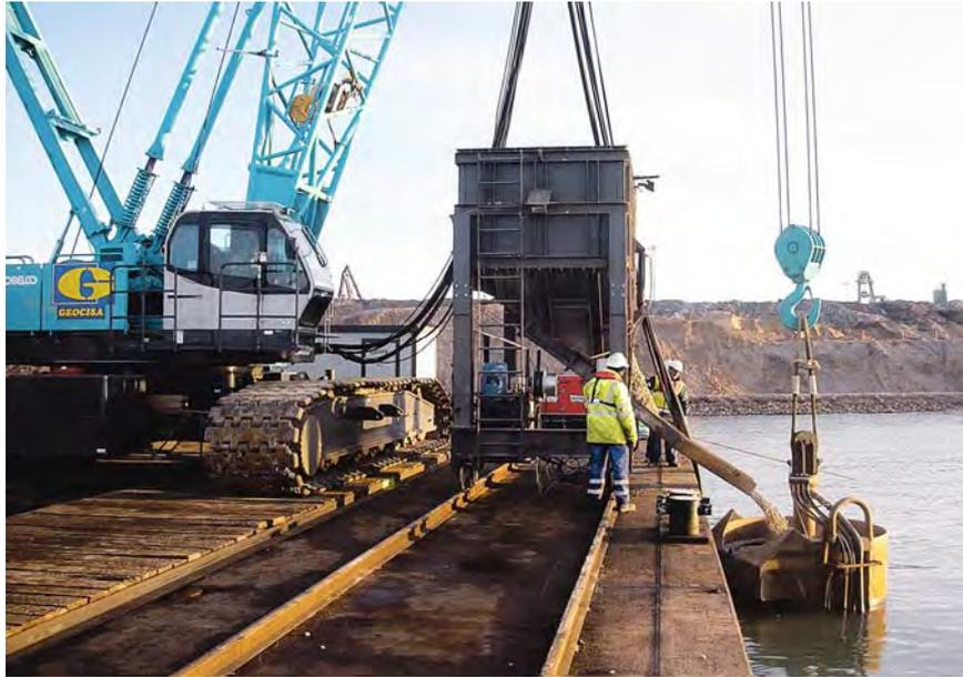
Figura 4.1. MÉTODO CON TANQUE SUPERIOR DE GRAVA Y ALIMENTACIÓN POR EL FONDO (Detalle).
