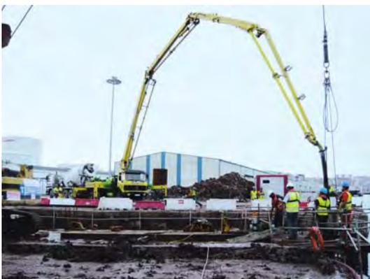
**Figura 45. HORMIGONADO DEL PILOTE CON BOMBA SITUADA EN EL MUELLE.**
