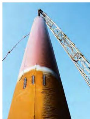
Figura 5 (izda.). ACOPIO DE CAMISAS PERDIDAS DE ACERO.
