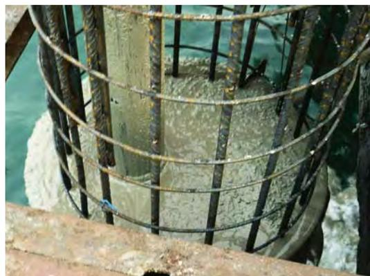
**Figura 46. LLEGADA DEL HORMIGÓN A SUPERFICIE.**
