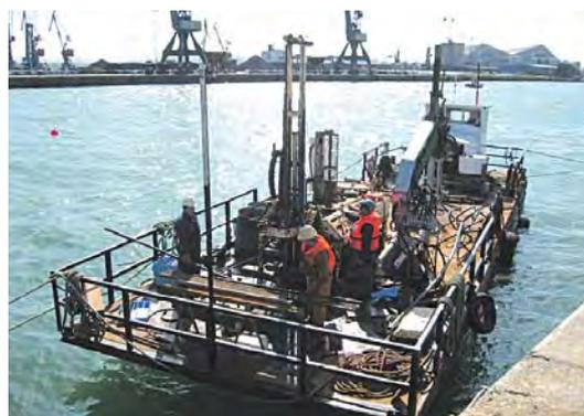
Figuras 1 y 2. REALIZACIÓN DE SONDEOS DESDE PLATAFORMA FLOTANTE.
