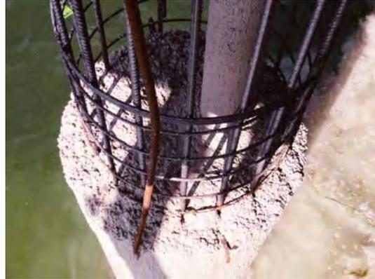
**Figura 42. PRIMERA FASE DE VIBRACIÓN DE LA CAMISA PERDIDA.**
