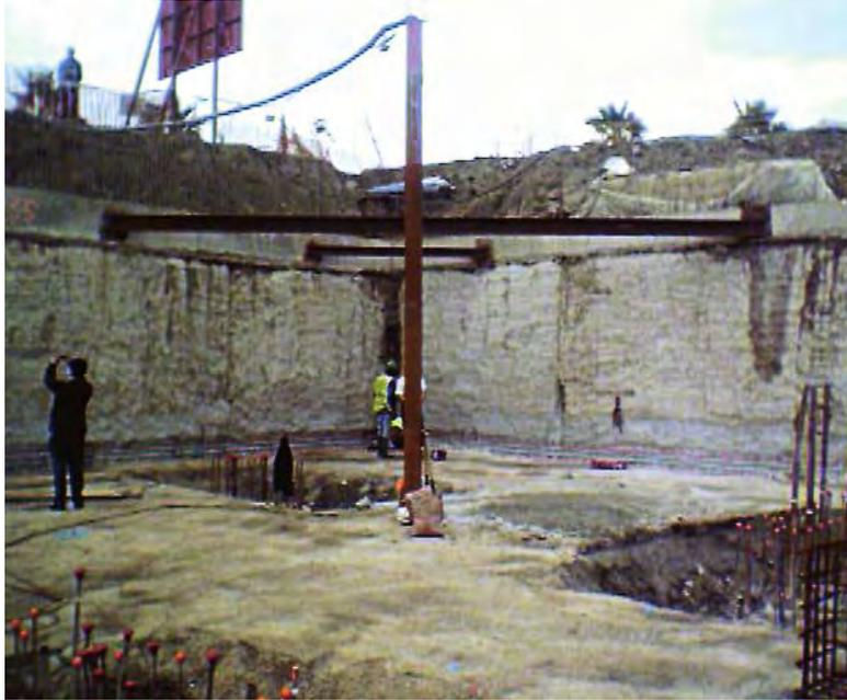
**Figura 10. FASE DE MÁXIMO VACIADO ANTES DE LA CONSTRUCCIÓN DE LA LOSA DE FONDO**
