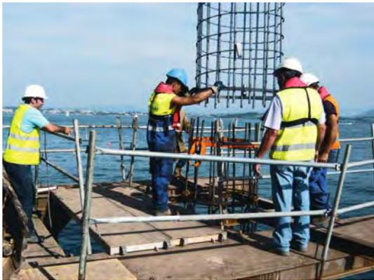
Figura 28. SOLAPE DE TRAMOS DE ARMADURA.
