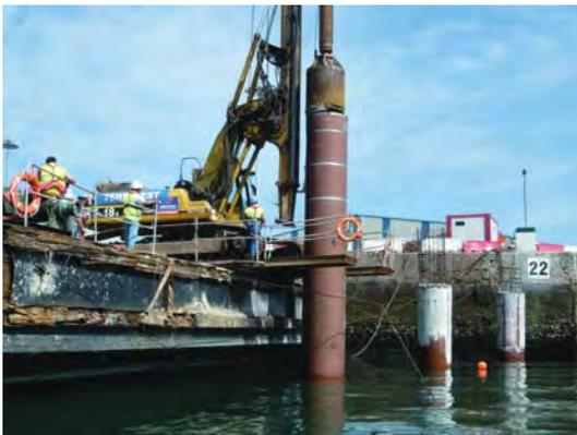
**Figura 43. ALIGERAMIENTO DEL TERRENO CON EQUIPO DE PILOTES.**
