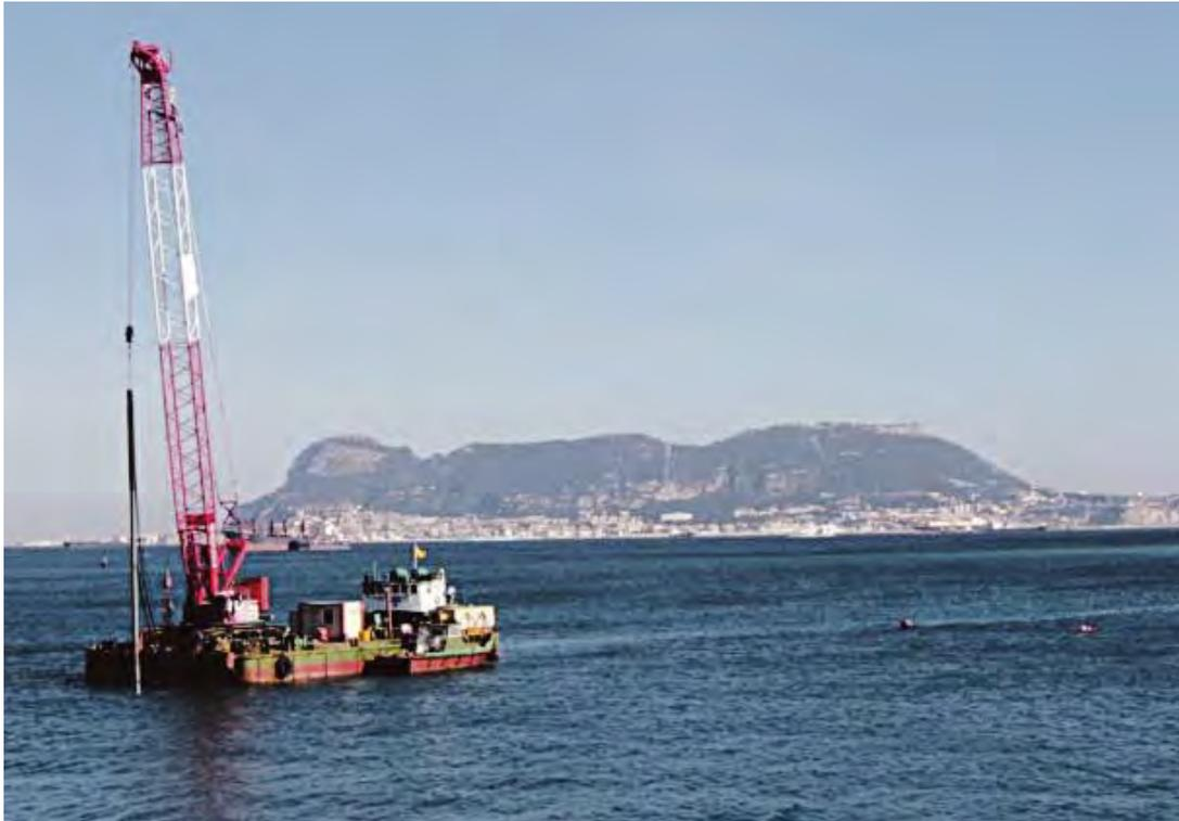
Figura 1. EJECUCIÓN DE COLUMNAS DE GRAVA DESDE PONTONA EN EL PUERTO DE ALGECIRAS (Vista general).
