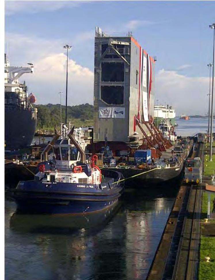
TRANSPORTE DE LAS COMPUERTAS: PASO DEL CANAL
