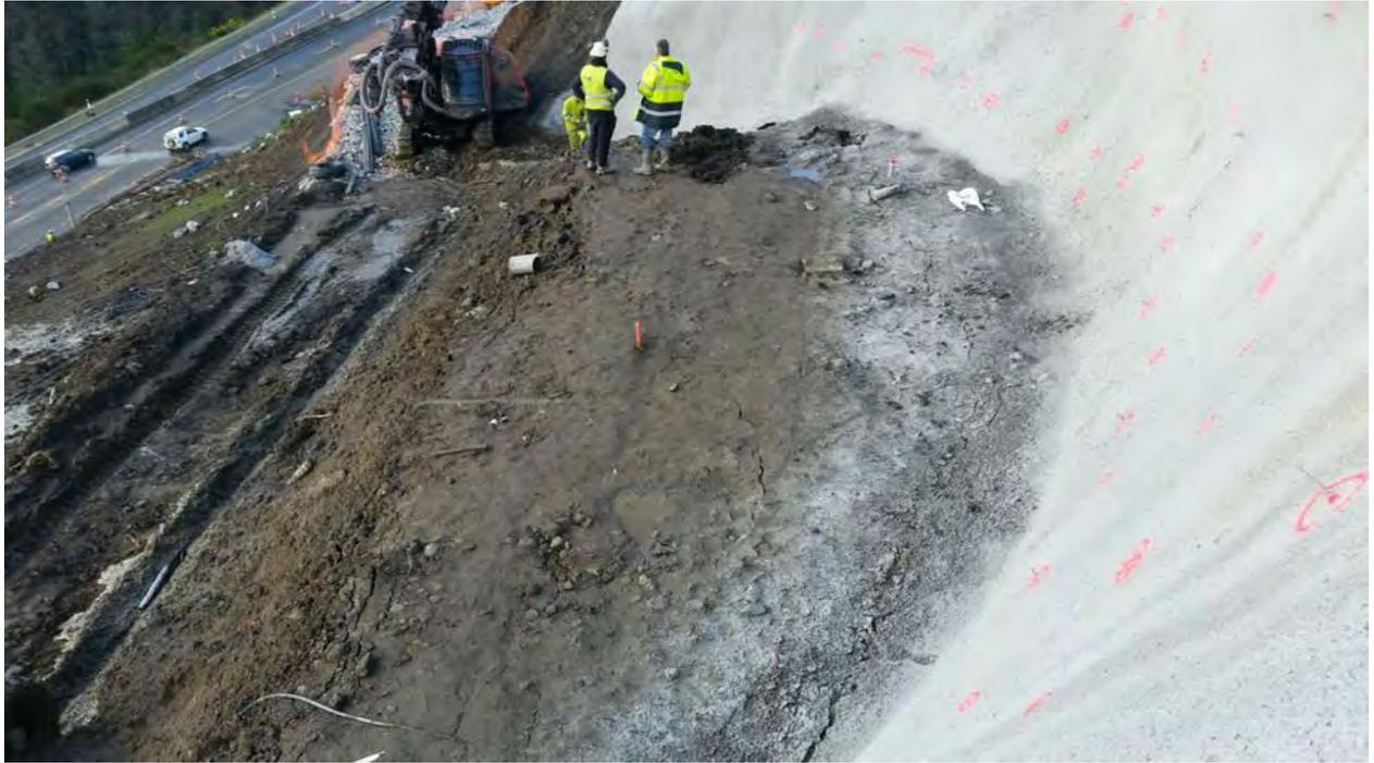
*Figura 49: Soil-nailing de refuerzo bajo pantalla intermedia sobre el contorno deslizado.*
