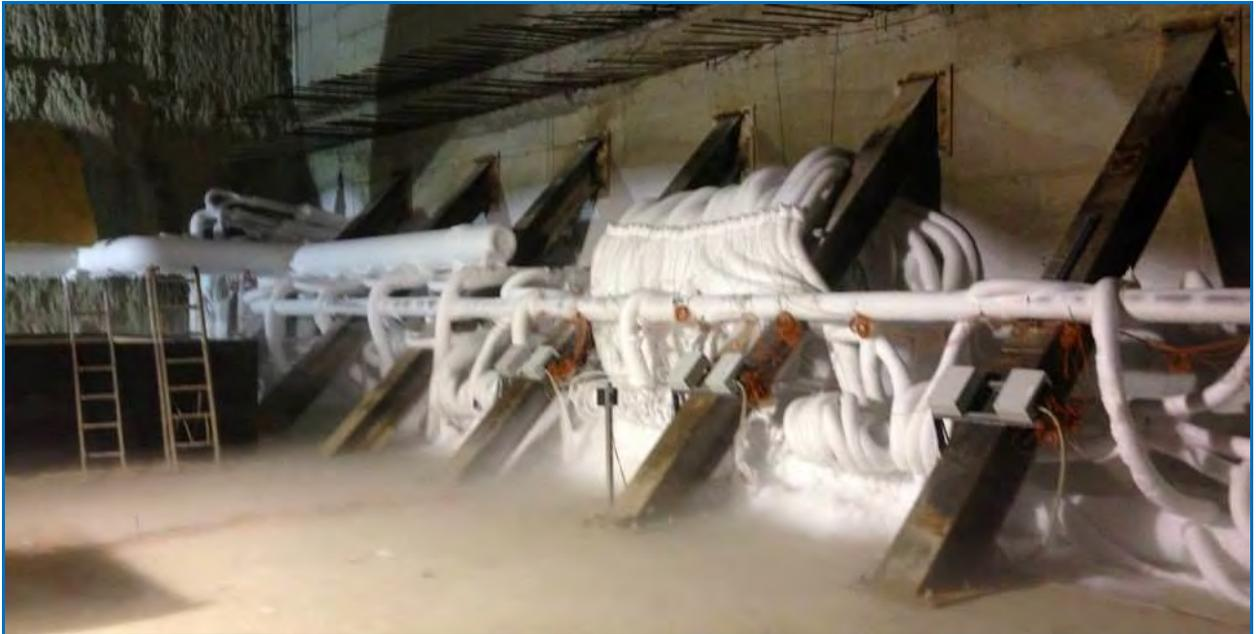
Figura 13. Circuito de nitrógeno líquido en el interior de la estación
