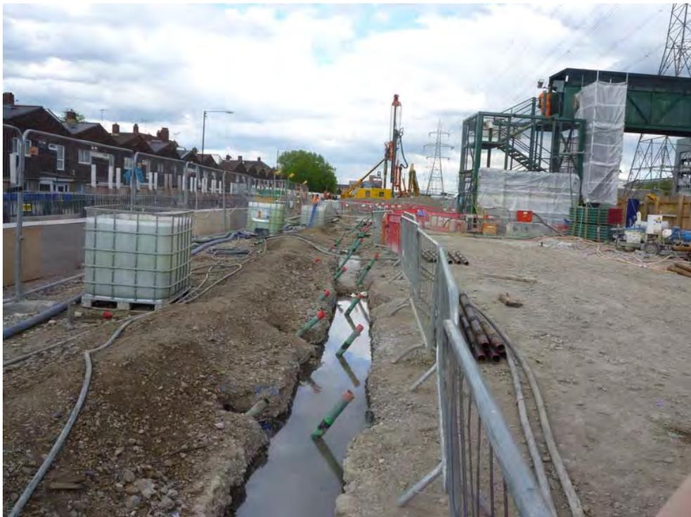
Figura 14. Malla de TAM inclinados instalados bajo la barrera de micropilotes de protección de los servicios de la calle Victoria Dock Road.
