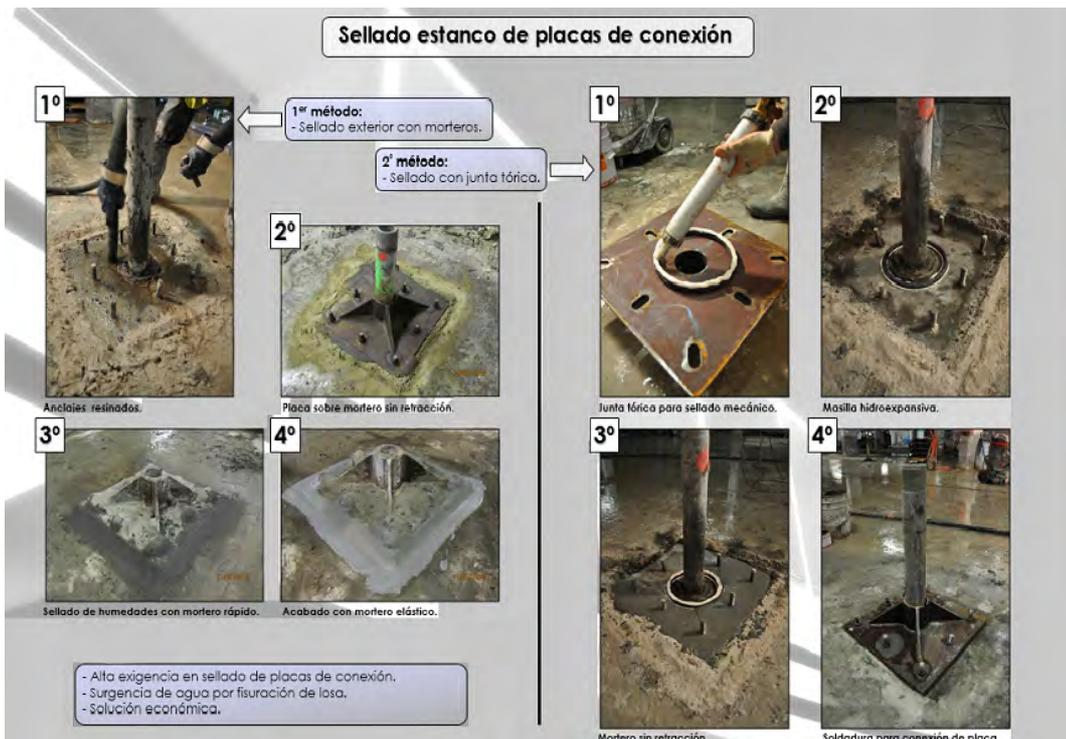
Fig. 13 Pasos de sellado de conexión micropilote-losa
