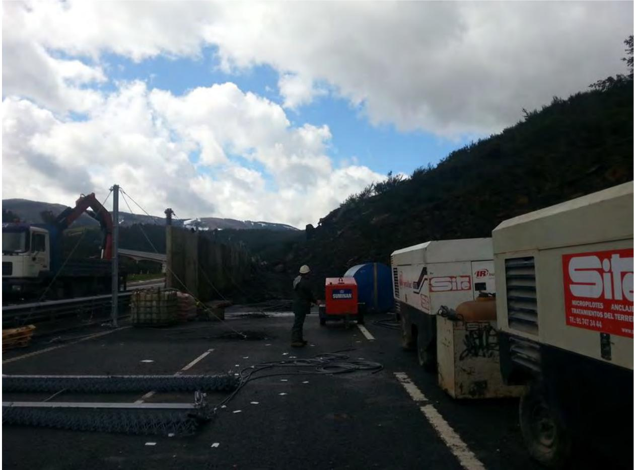
Figura 11: Instalación de barrera dinámica por Tesinsa.
