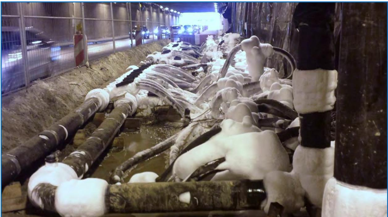
Figura 14. Circuito de salmuera en el interior del túnel Wisłostrada
