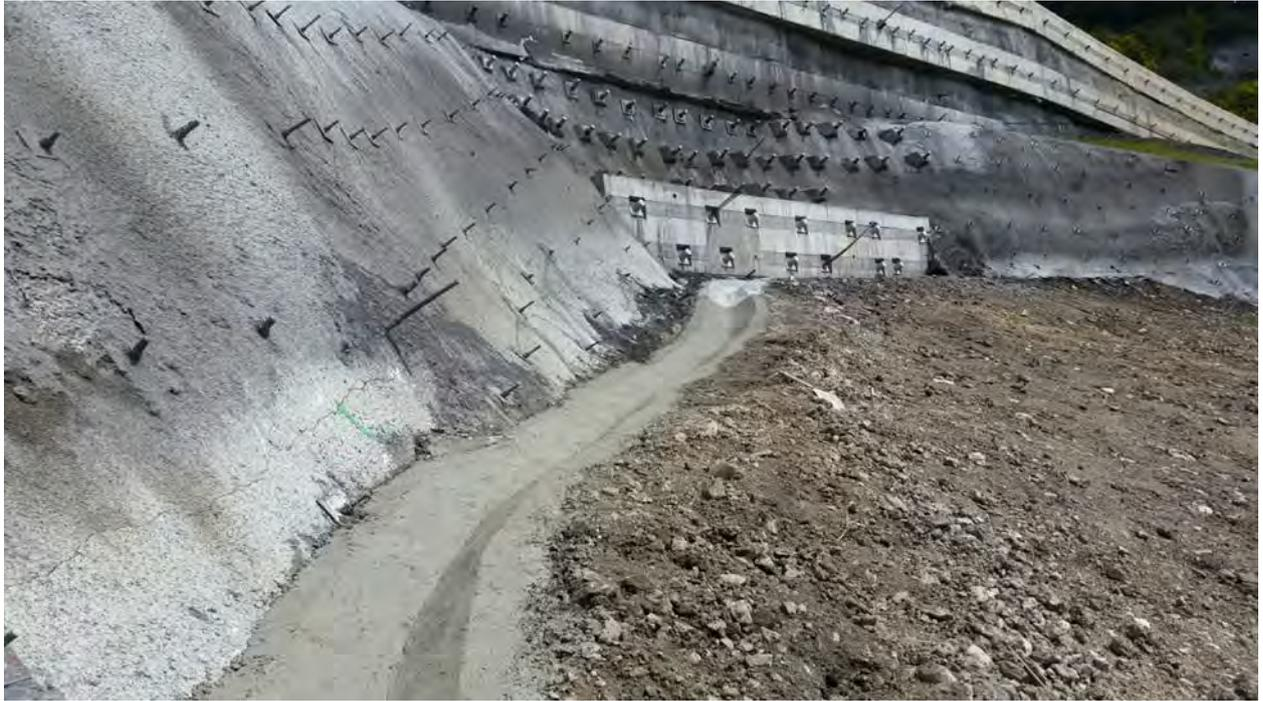
*Figura 53: Vista del refuerzo de la pantalla intermedia terminado.*
