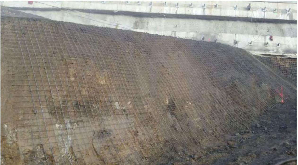
*Figura 46: Soil-nailing de refuerzo bajo pantalla intermedia sobre el contorno deslizado.*
