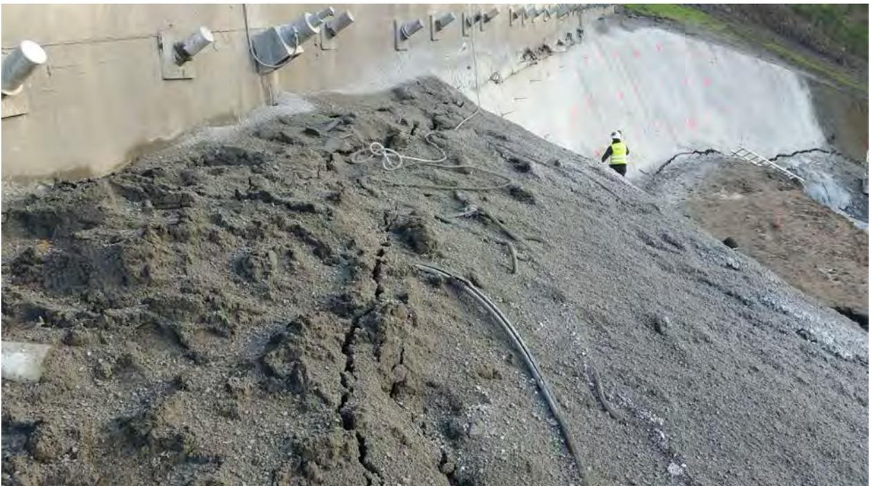
*Figura 48: Soil-nailing de refuerzo bajo pantalla intermedia sobre el contorno deslizado.*
