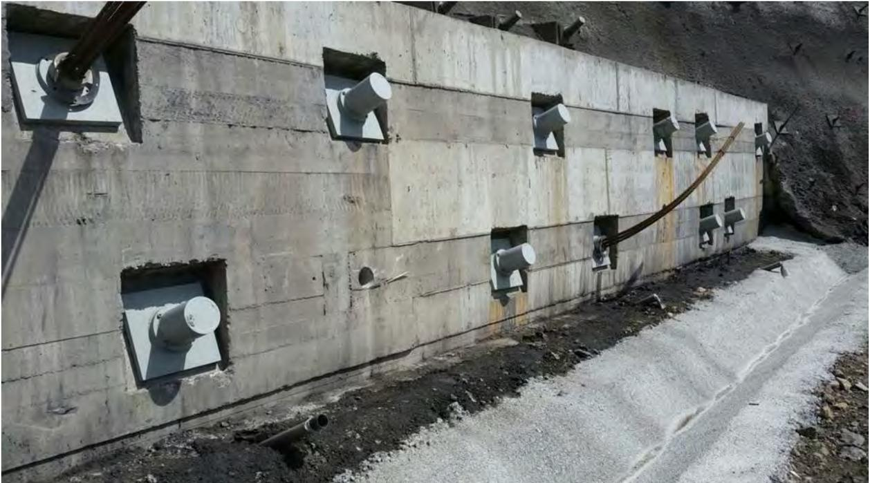
*Figura 52: Muro anclado bajo pantalla intermedia. Anclajes  $7\phi 0,6''$ .*
