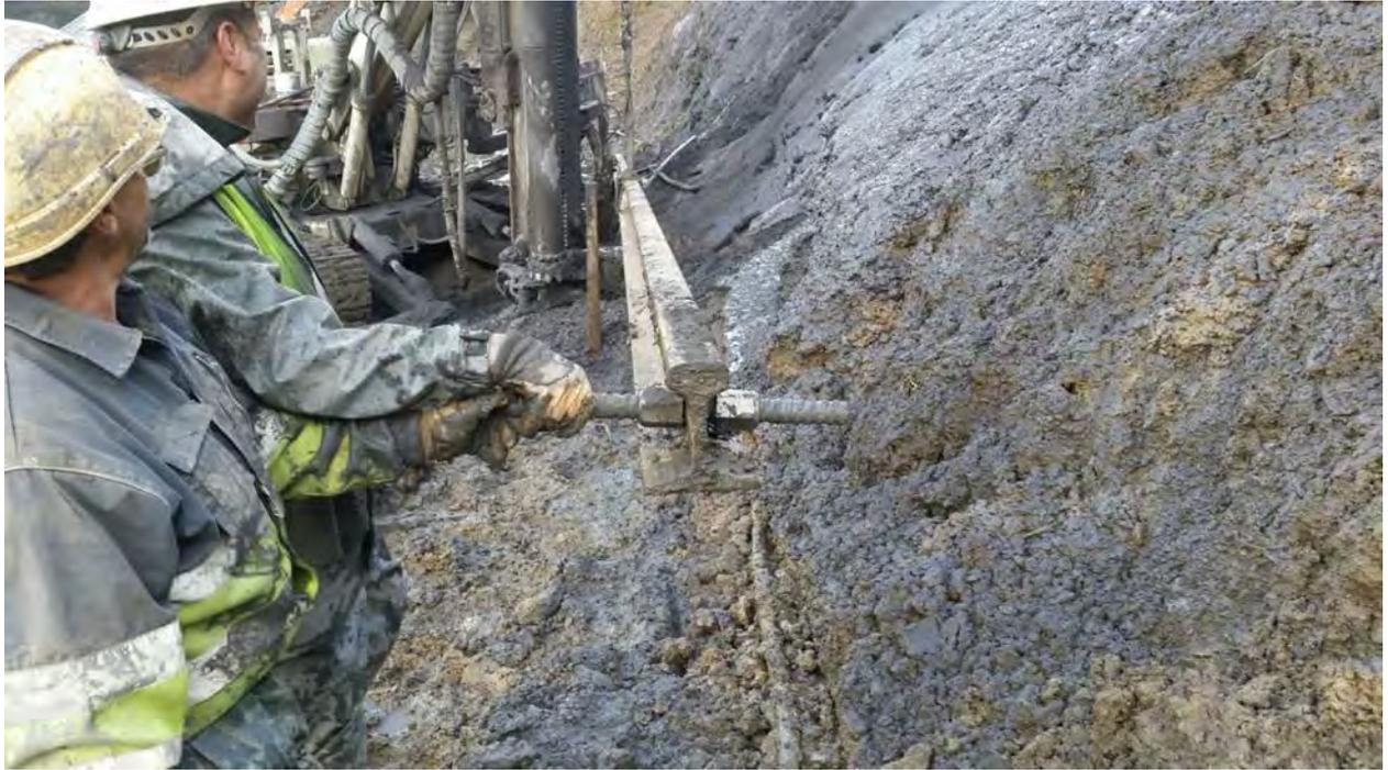
*Figura 57: Instalación de un carril en la perforación.*
