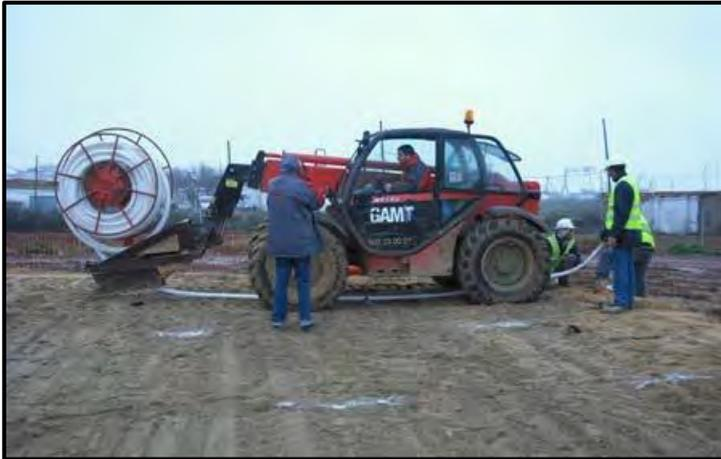
Figura 29: Manitou especialmente adaptada.
