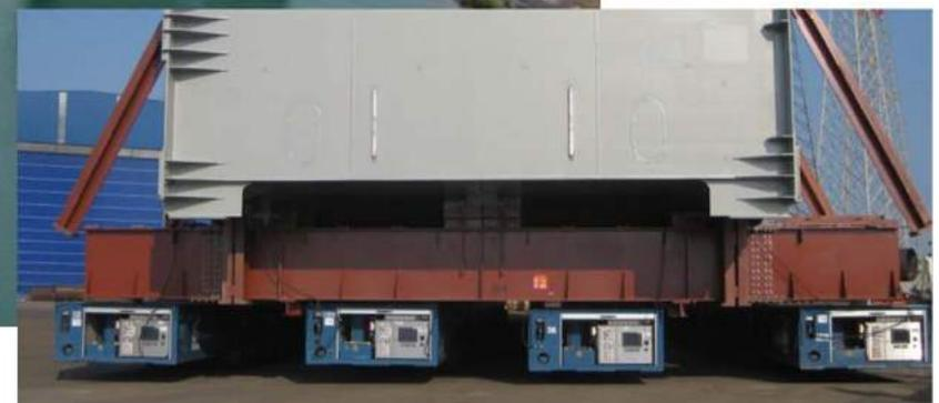
Descarga de las cuatro primeras compuertas en el muelle provisional – Atlántico e imagen de carros autopropulsados (SPMT) para la descarga
