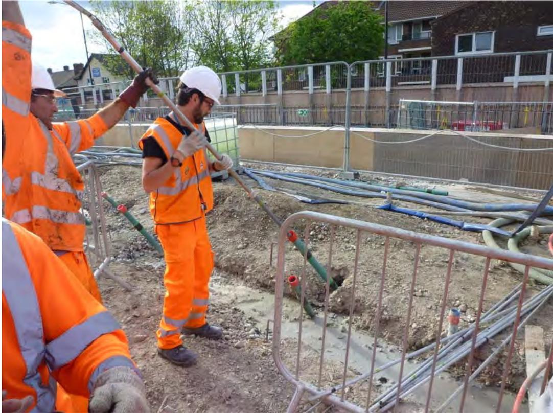
Figura 20. Introducción de la sonda HDAD-1 en uno de los taladros
