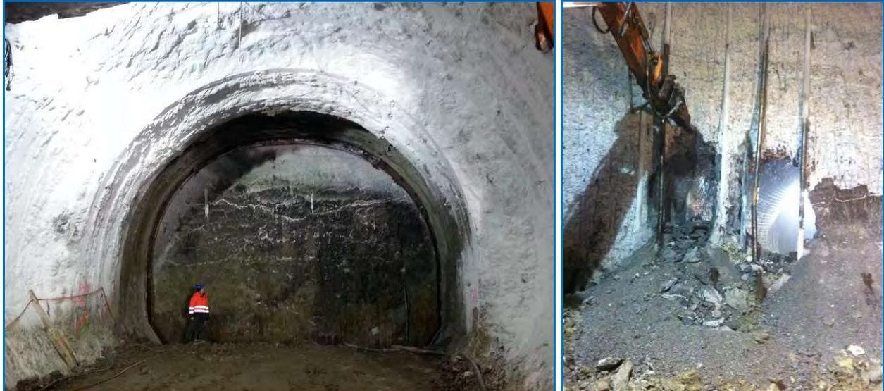
Figura 20. Muro pantalla central del túnel Wisłostrada antes y durante el calado
