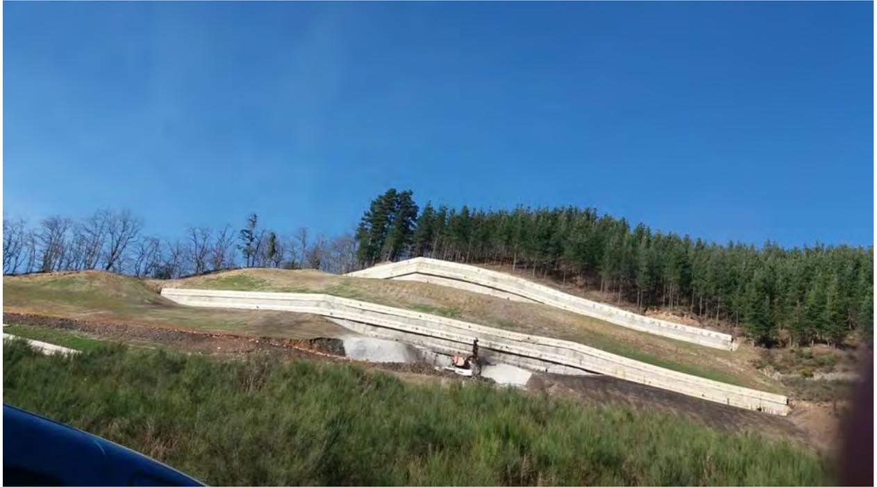
*Figura 51: Ejecución de anclajes de refuerzo en pantalla intermedia.*
