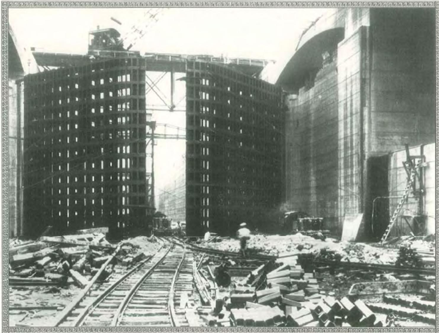
Esclusas de Miraflores, vista general de la construcción de las compuertas inferiores, cámara este. 1913 Miraflores Locks, general view of the construction of lower gates, east chamber.
