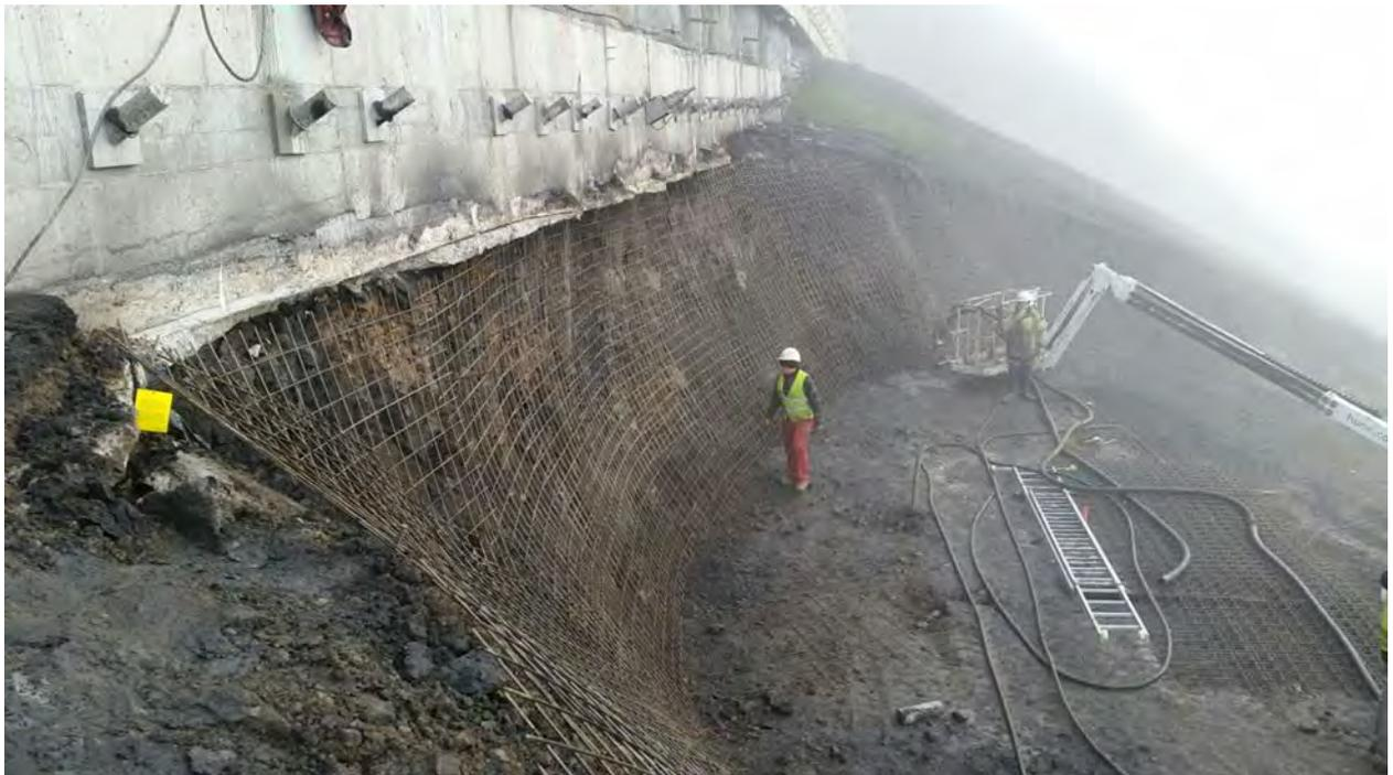
*Figura 42: Soil-nailing en la zona central de la pantalla intermedia.*
