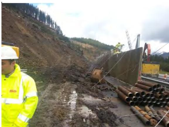
*Figura 9: Instalación de barrera dinámica por Tesinsa.*
