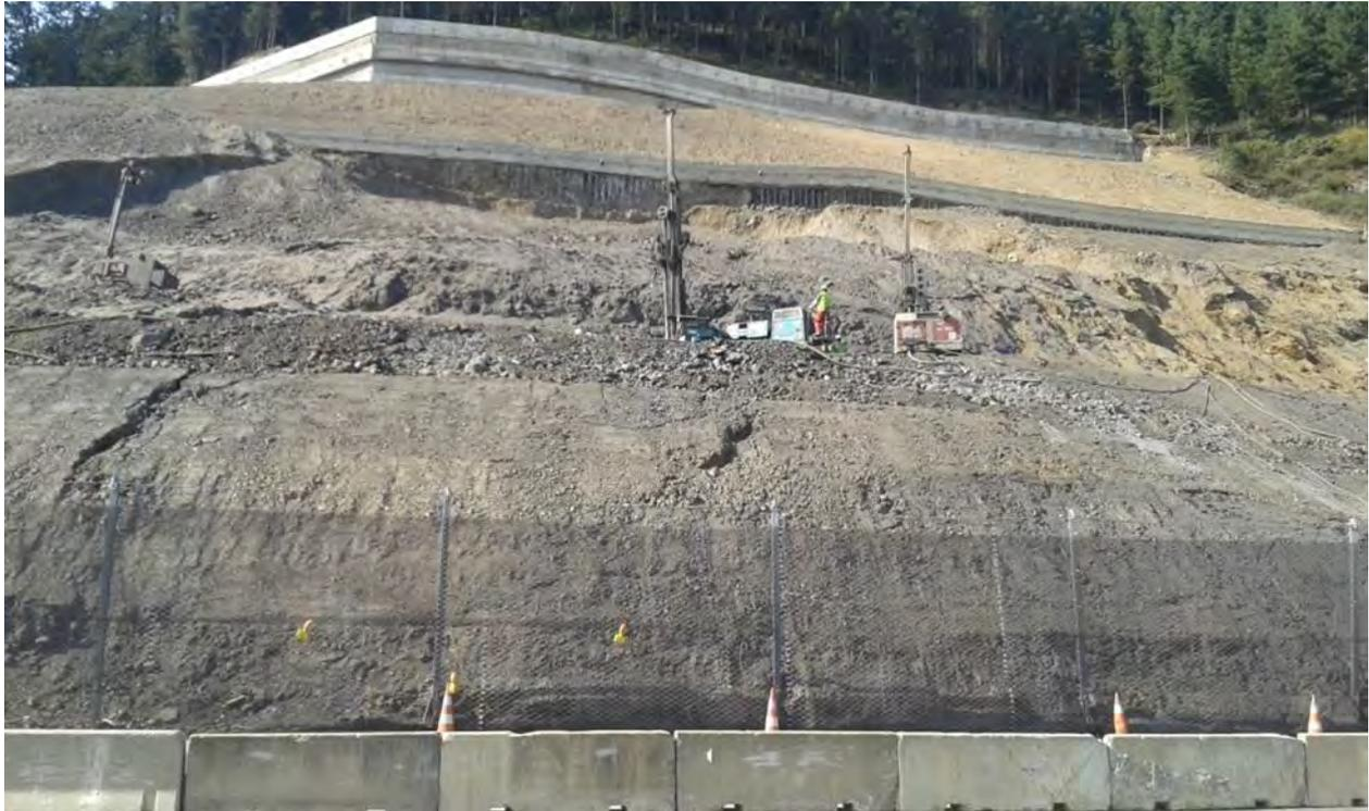
*Figura 21: Ejecución de micropilotes en la pantalla inferior.*
