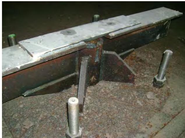
**Fig. 8. Detalle de conexión micropilote-losa**
