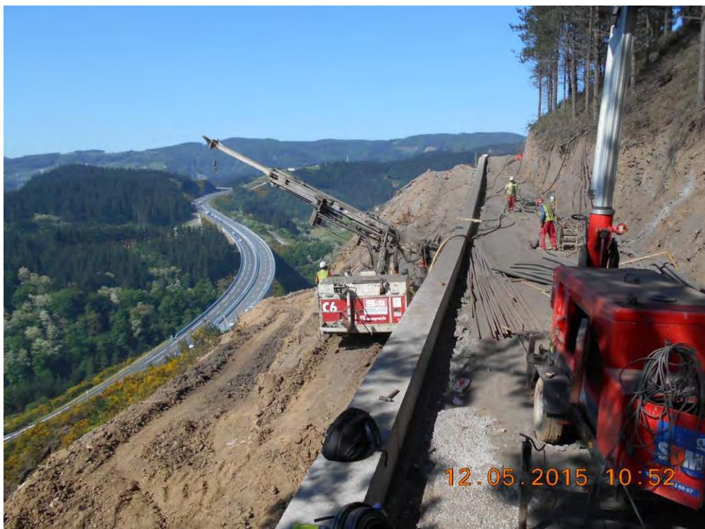
Figura 18: Ejecución de primera viga de anclaje en pantalla superior. Cortesía Diputación Foral de Gipuzkoa.
