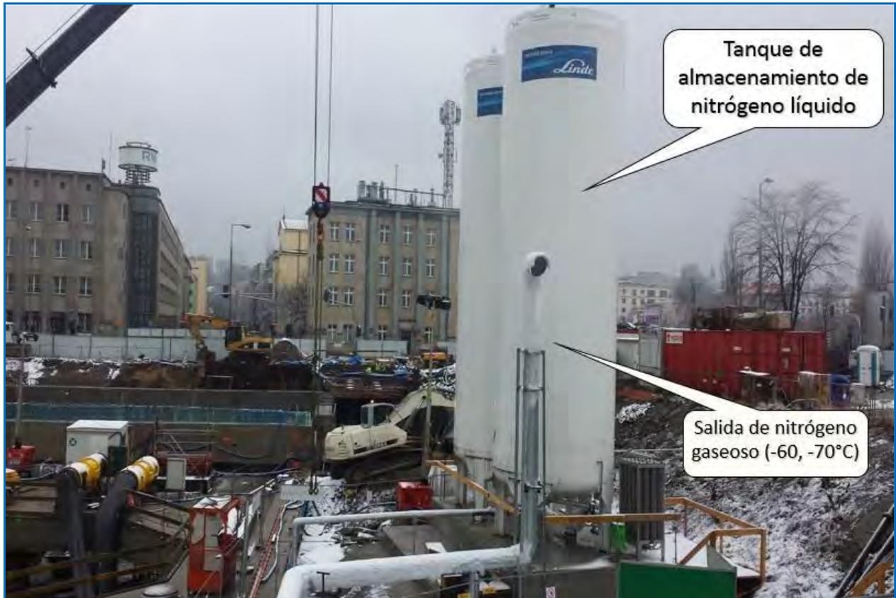
Figura 2. Tanques de nitrógeno líquido y salida de nitrógeno gas a la atmósfera
