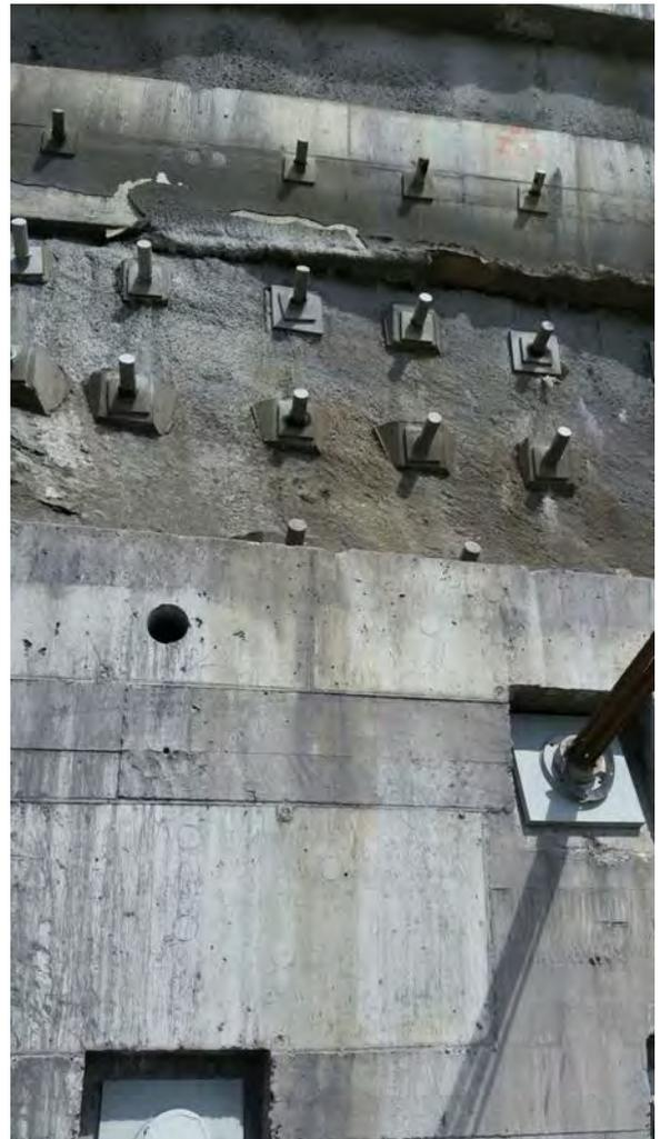
*Figura 55: Anclajes  $\phi 40$  mm y  $7\phi 0,6''$ .*
