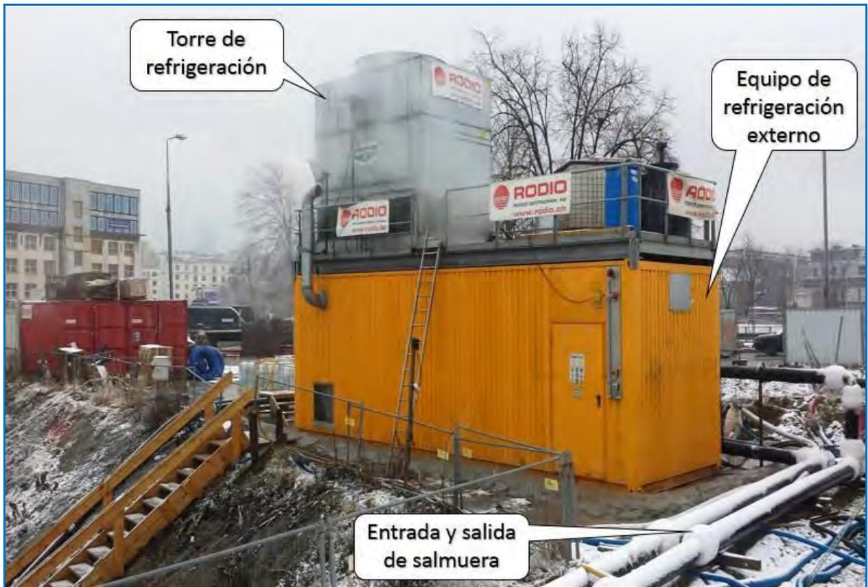
Figura 3. Unidad de refrigeración primaria
