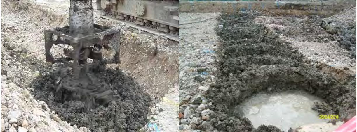
Figura 16. Ejecución de una columna de soil mixing (izqda.) y fila de columnas solapadas (dcha.)
