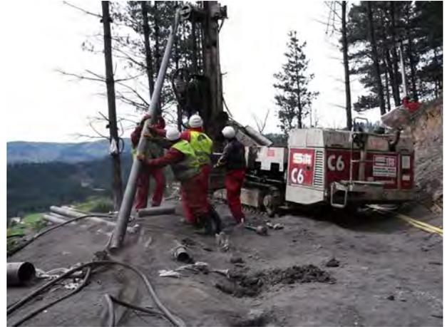
Figura 17: Comienzo de micropilotaje en pantalla superior.
