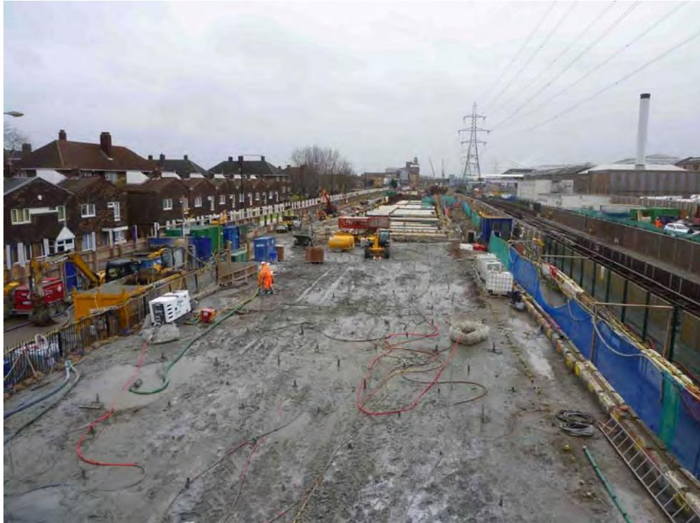
Figura 13. Malla de TAM verticales instalados en la zona a tratar al norte de la barrera de micropilotes autopercutores de protección del DLR.
