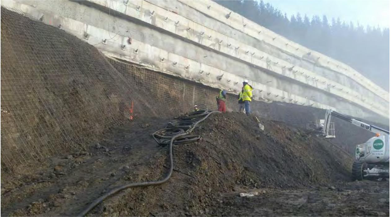
*Figura 43: Soil-nailing de refuerzo bajo pantalla intermedia sobre el contorno deslizado.*
