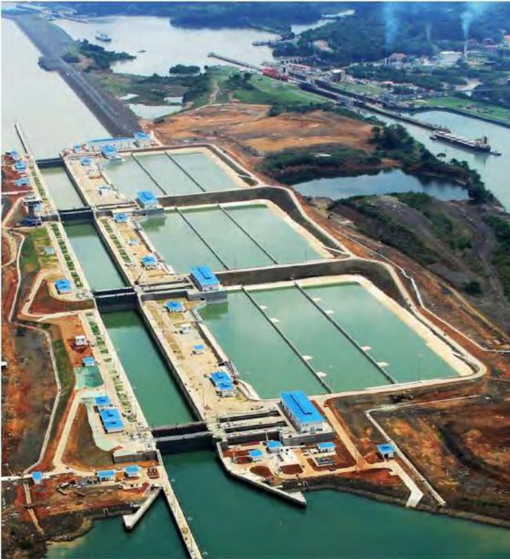
Presas Borinquen de materiales sueltos con núcleo de arcilla. Lado Pacífico
