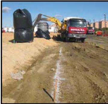
Figura 23: replanteo del eje de la pantalla.
