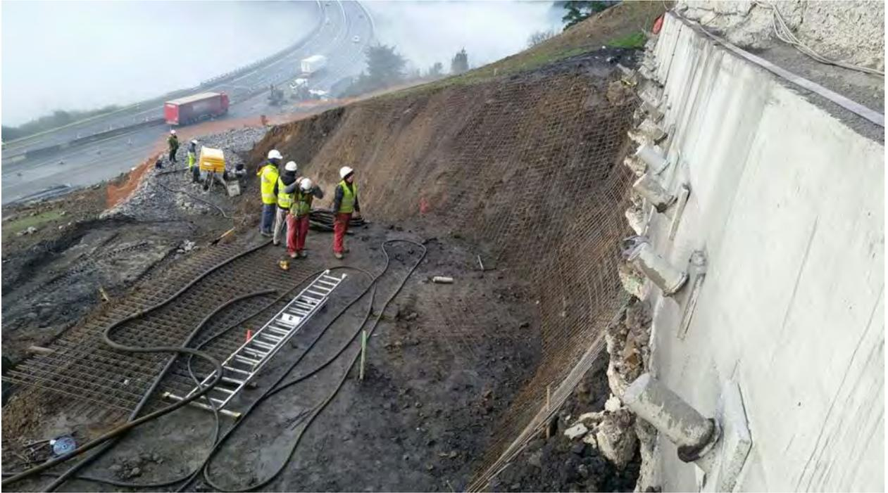
*Figura 47: Soil-nailing de refuerzo bajo pantalla intermedia sobre el contorno deslizado.*
