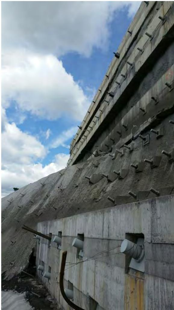
*Figura 54: Vista del refuerzo de la pantalla intermedia.*
