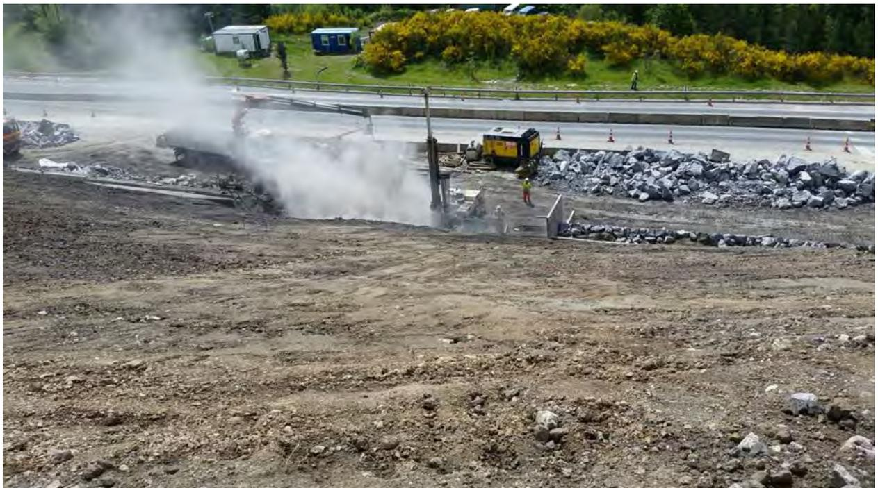
*Figura 56: Perforación para pantalla de carriles.*
