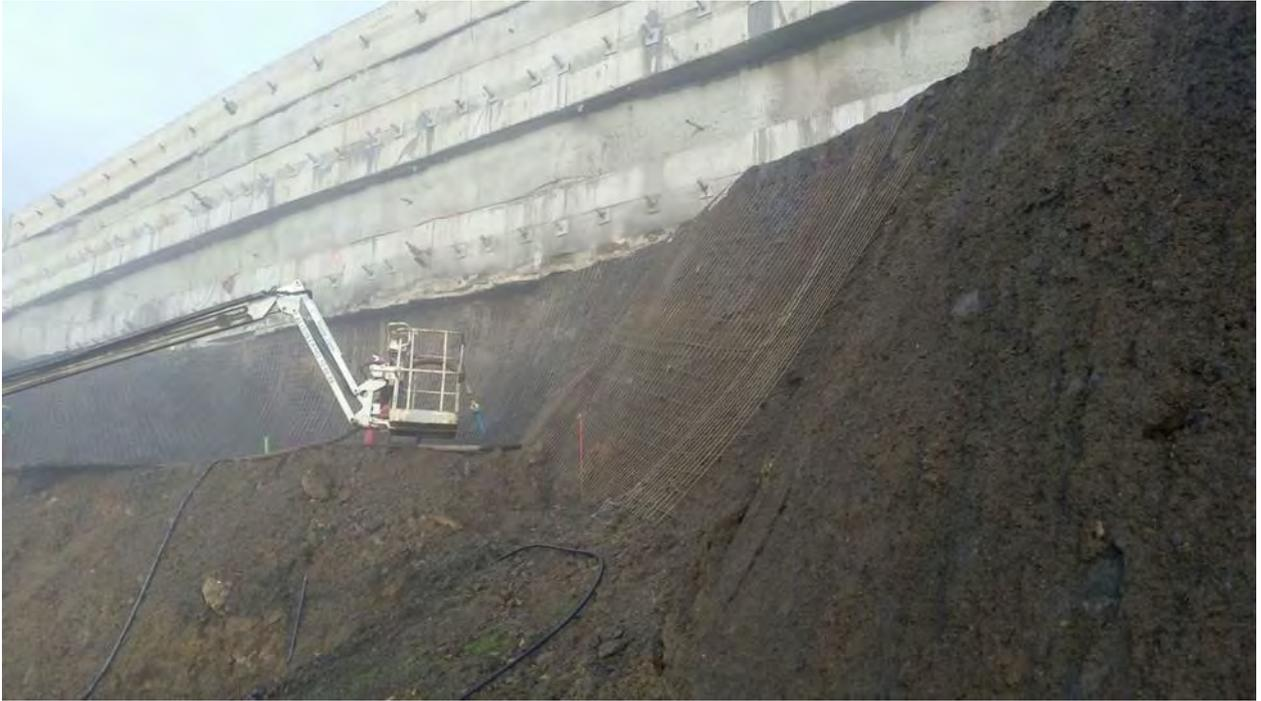
*Figura 45: Soil-nailing de refuerzo bajo pantalla intermedia sobre el contorno deslizado.*
