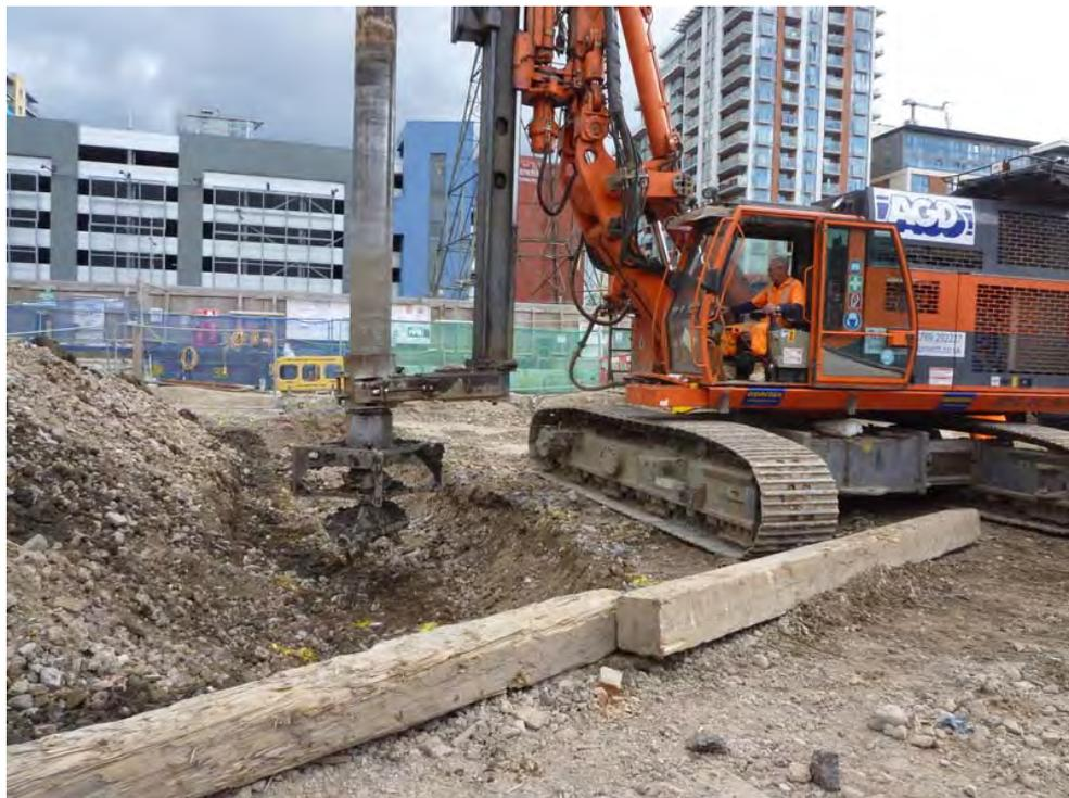
Figura 15. Detalle del útil de mezclado del equipo de soil mixing, con doble hélice.
