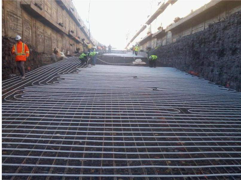
Figura 3: Ejecución de losa calefactada en rampa del Metro Ligero de Ottawa
