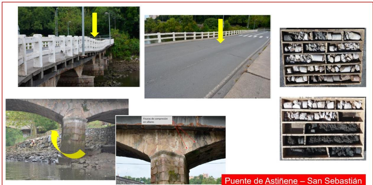
Figura 15. Patologías del puente antiguo y testigos de uno de los sondeos.
