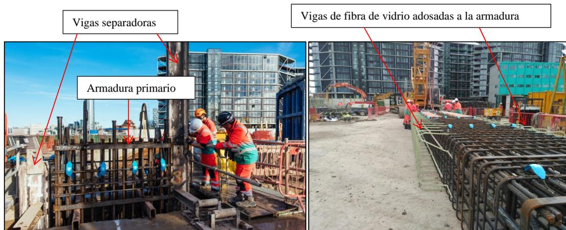
Figura 20: colocación de vigas separadoras
