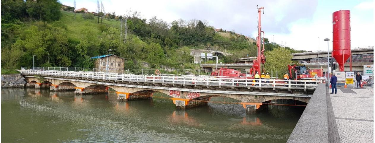
Figura 16. Equipo Hi`Drill trabajando en una de las pilas del puente.
