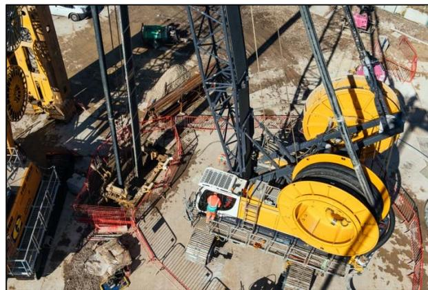
Figura 6 Vista aérea de la hidrofresa excavando un panel.
