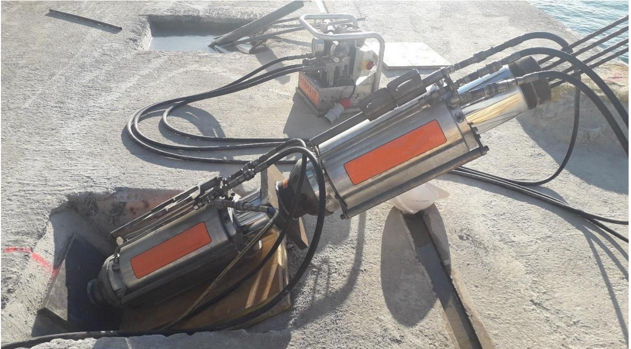
Figura 13. Tesado del anclaje – ensayo de idoneidad, con uso de dos gatos en serie.
