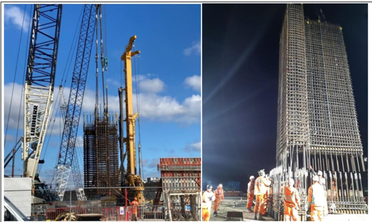
**Fotografías n°2 y 3.-Colocacion de armado de contrafuertes**
