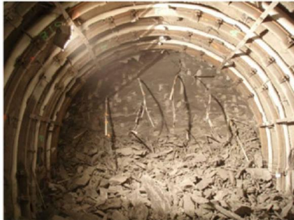
Figura 12. Sección e imagen del sostenimiento de la galería GED
