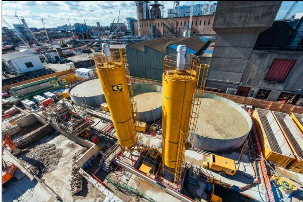
Figura 16: Planta de tratamiento de lodos
