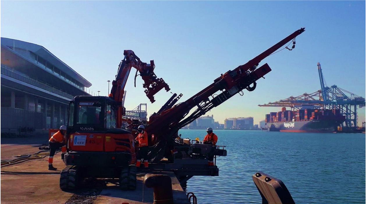
Figura 12. Fotografía del equipo de perforación en posición de trabajo, parcialmente sobre plataforma volada.
