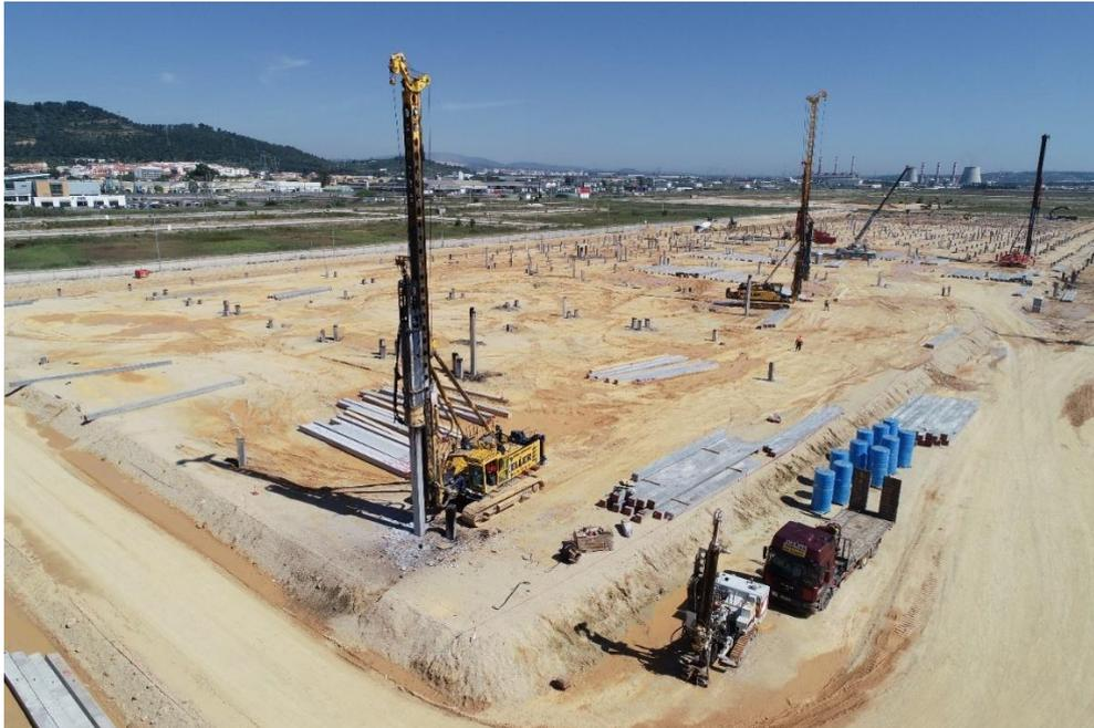
**Figura 9.** Equipos utilizados en la ejecución de los pilotes prefabricados.
