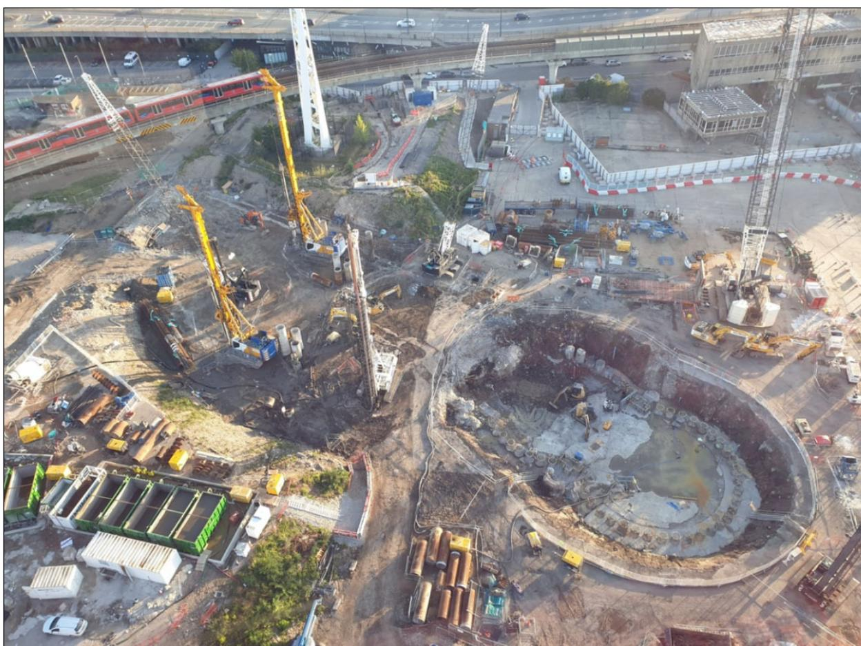
**Fotografía n°4.-Excavacion del primer y segundo pozos para ejecucion de la viga de coronacion**
