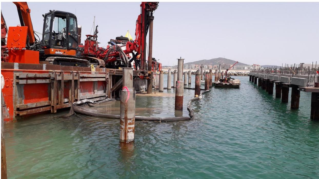
Figura 21. Equipo Hi'Drill trabajando desde la pontona y vista de los micropilotes ya ejecutados y avance de la construcción de la losa.
