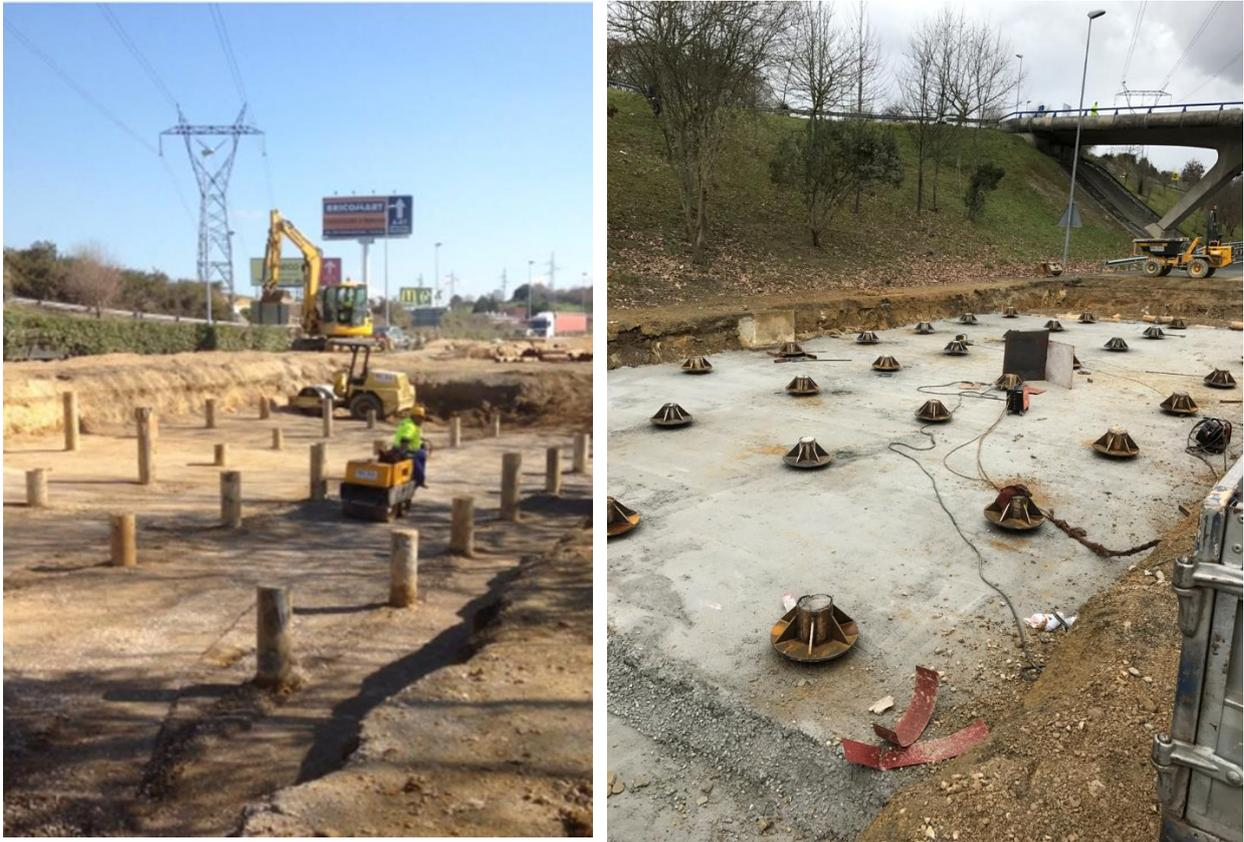
*Figuras 10 y 11: Ejemplos de tratamientos mallados de la plataforma mediante inyecciones armadas*
