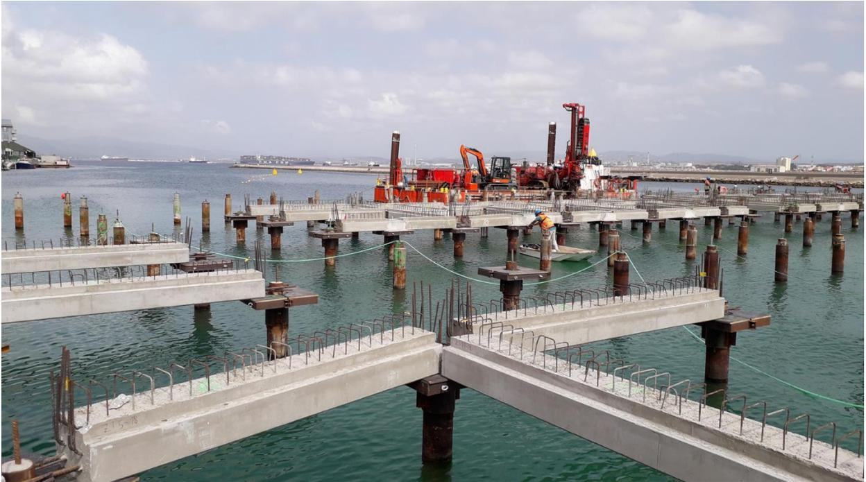
Figura 22. Avance de la construcción de capiteles y vigas de la losa sobre los micropilotes.
