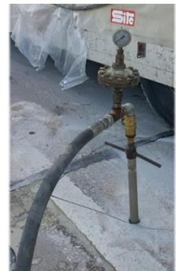
Figura 8: Obturación para inyectar
