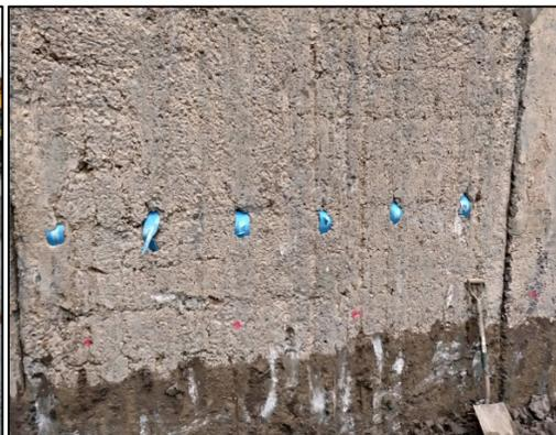
Figura 25: Separadores tras excavación del pozo
