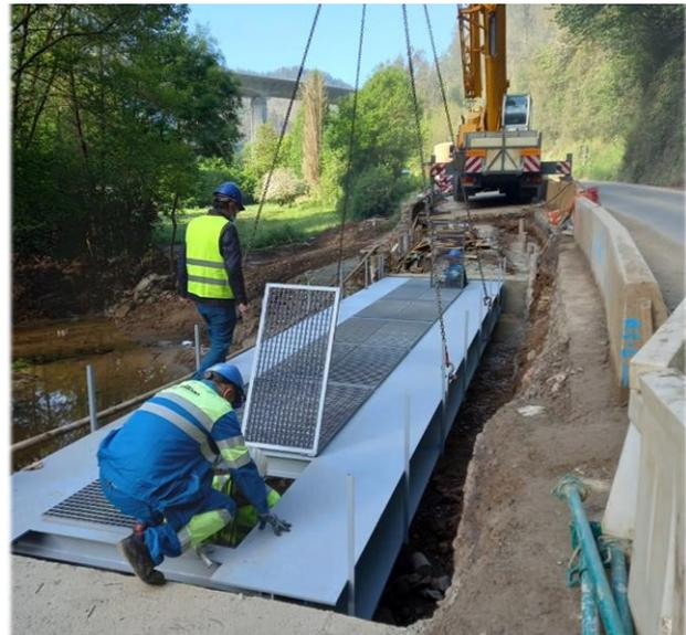
Figura 16: Colocación de plataforma auxiliar
