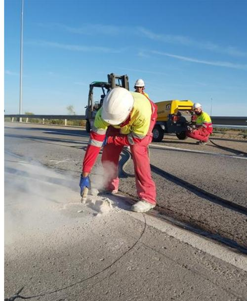
Figura 7: Limpieza con aire a presión
