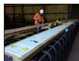
Figura 14: protección conectores con “Box-out “
