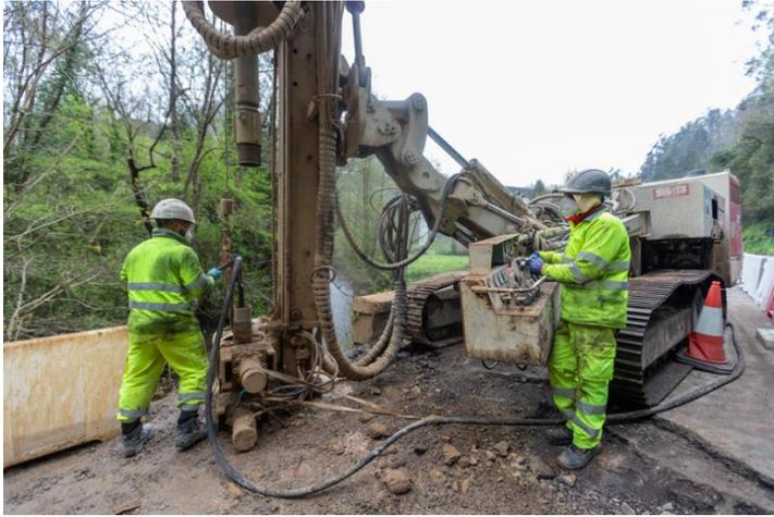
Figura 17: Ejecución pantalla de micropilotes desde carril
