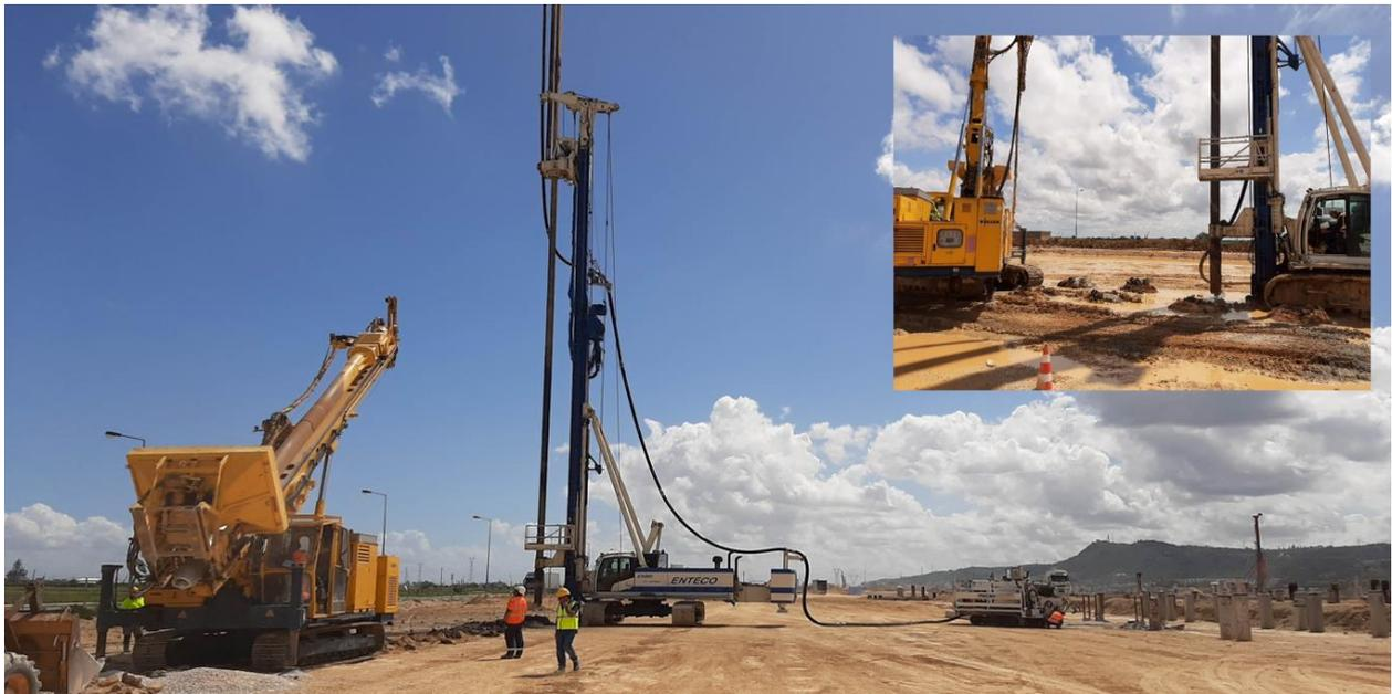
Figura 19. Equipos utilizados en la ejecución de columnas de módulo mixto.
